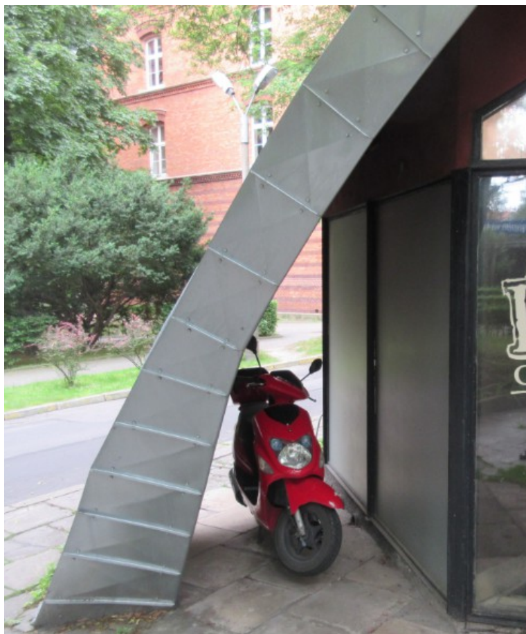
FOT. 14 - WYKOŃCZENIE OBRÓBKĄ BLACHARSKĄ
