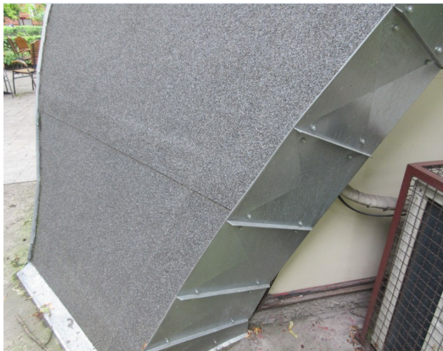
FOT. 13 - WYKOŃCZENIE OBRÓBKĄ BLACHARSKĄ NA STYKU KONSTRUKCJI Z GRUNTEM
