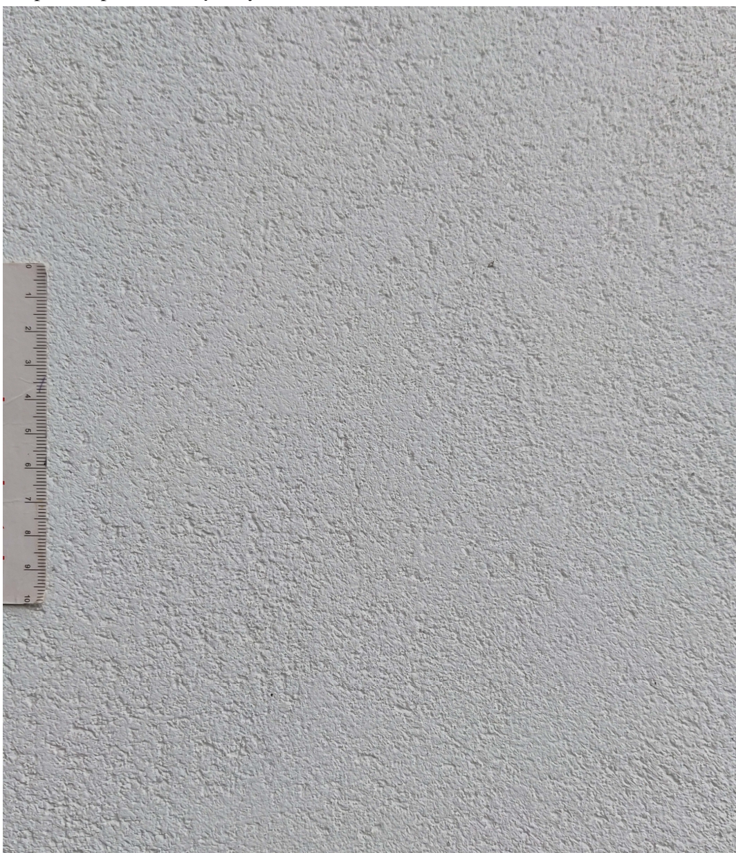
Fot. 6. Tynk mineralny cienkowarstwowy na bazie białego cementu, zacierany tradycyjnie
