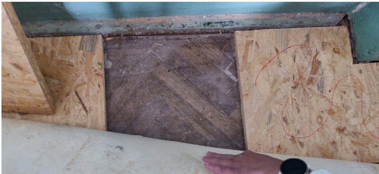
Fot. 5. Podłoga – pod wtórną wykładziną i warstwą z płyt wiórowych odkryto dość zniszczony parkiet (prawdopodobnie dębowy)
