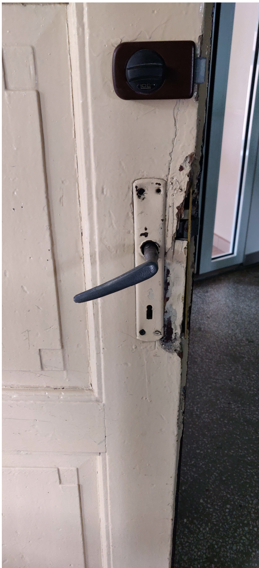
Fot. 3. Drzwi do klasy z korytarza – liczne ubytki i znaczne uszkodzenia w wielu miejscach skrzydła i ościeżnicy oraz zniszczenia okuć
