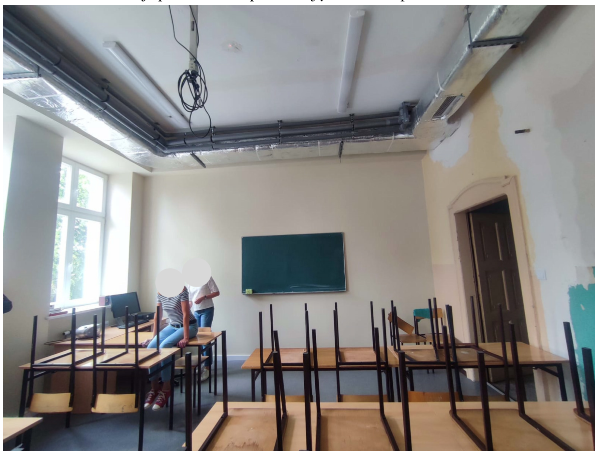
Fot. 2. Wnętrze klasy, widok w kierunku północnym – ściany zewnętrzne po termomodernizacji, liczne wtórne instalacje pod sufitem wprowadzające nieład w pomieszczeniu
