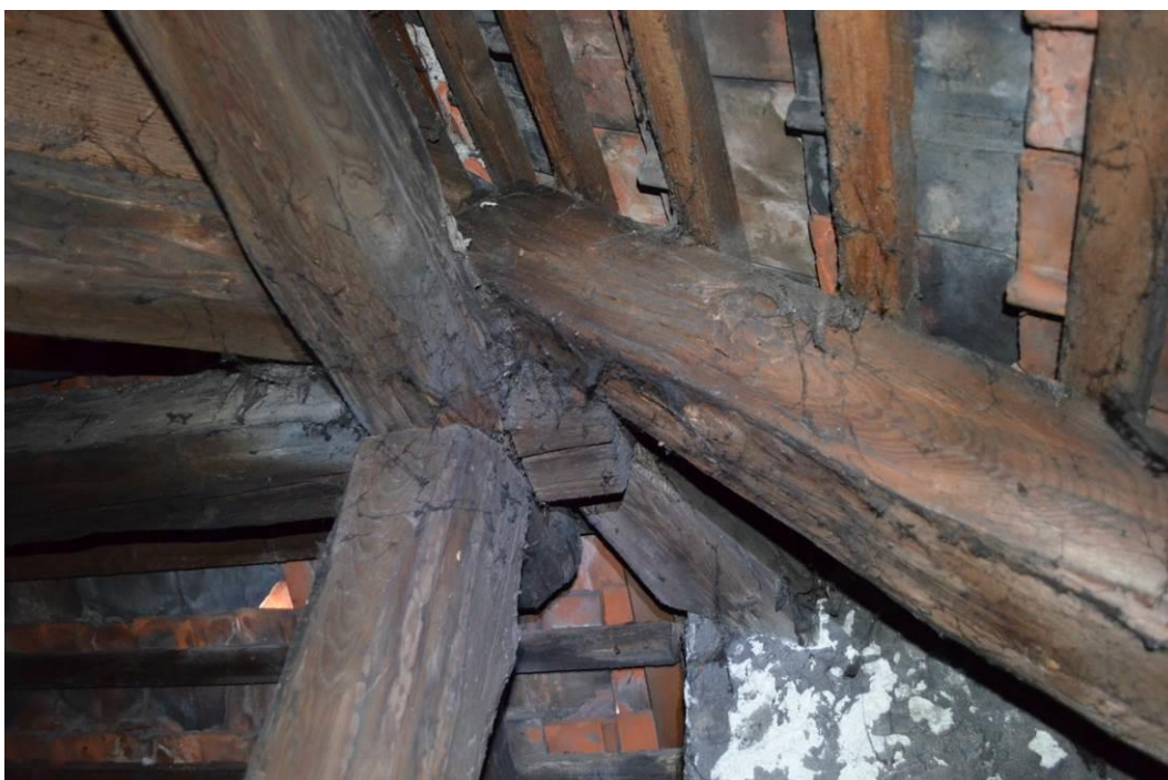
fot.2.30. Korozja elementów drewnianych przy kominie
