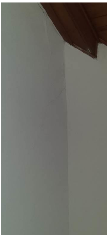
fot.3.16. Zarysowanie ściany w górnej strefie pod sufitem nad schodami
