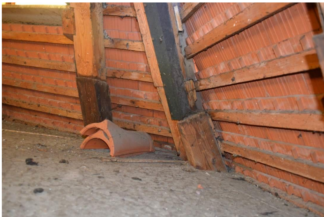
fot.2.4. Połączenie elementów pierwotnych krokwi z wymienianymi
