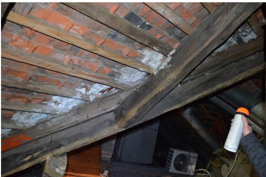
fot.2.20. Korozja krokwi koszowej
