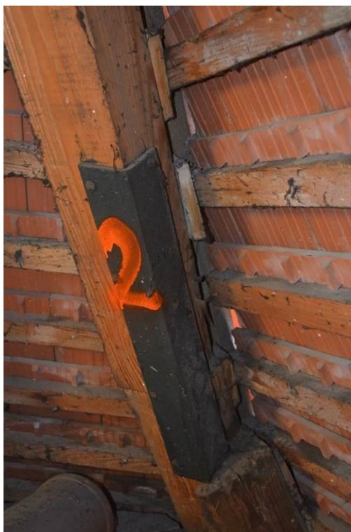
fot.2.5. Połączenie elementów pierwotnych krokwi z wymienianymi
