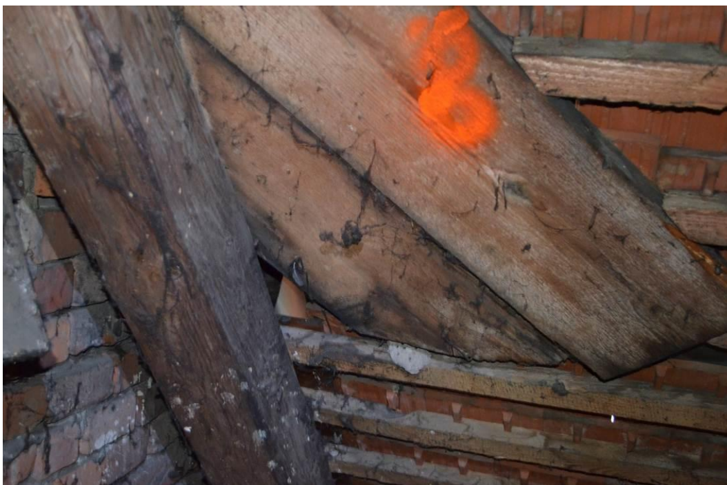
fot.2.13. Korozja krokwi i elementów deskowania kosza przy wieżyczce
