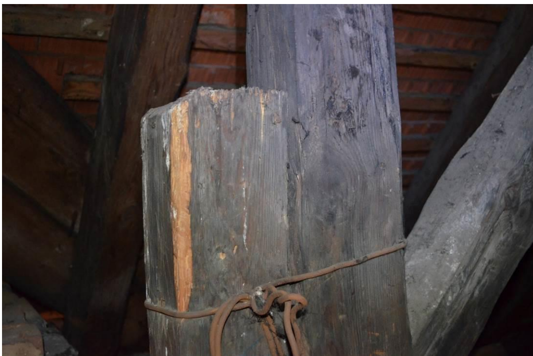
fot.2.10. Wadliwe wzmocnienie jednego ze słupów
