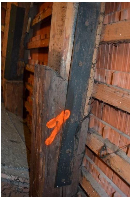
fot.2.6. Połączenie elementów pierwotnych krokwi z wymienianymi
