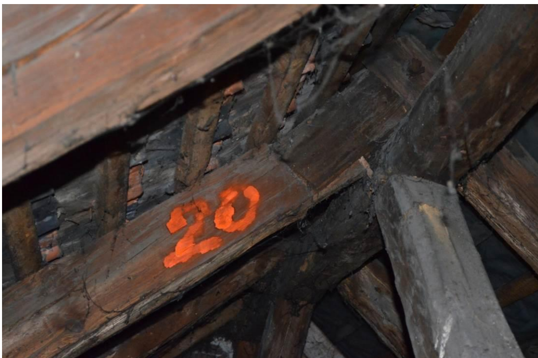
fot.2.25. Korozja węzła w kalenicy
