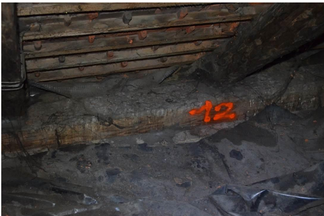
fot.2.17. Korozja płatwi pośredniej w poziomie sufitu
