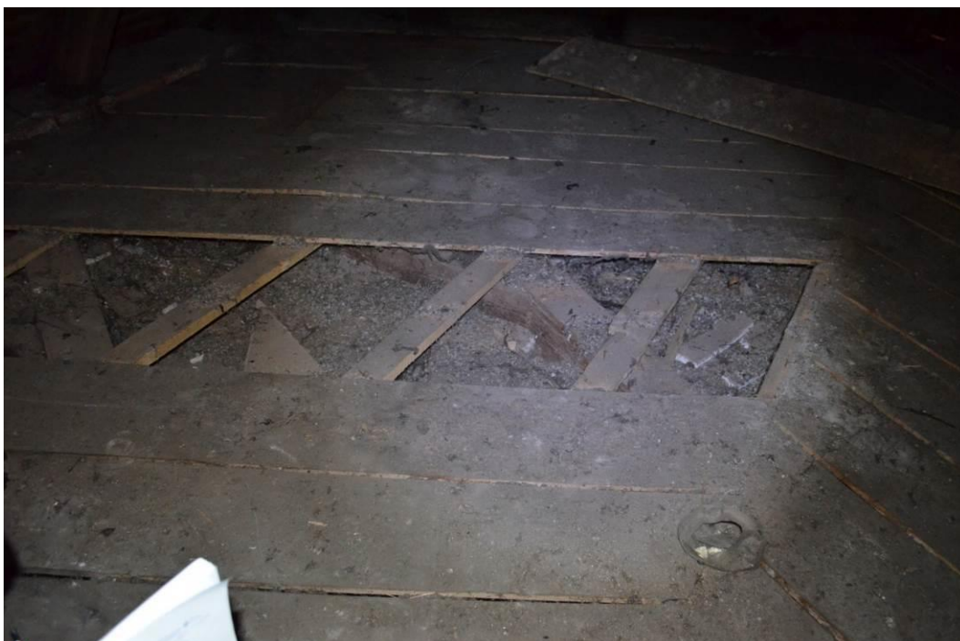
fot.2.11. Odkrywka stropu strychowego wieżyczki
