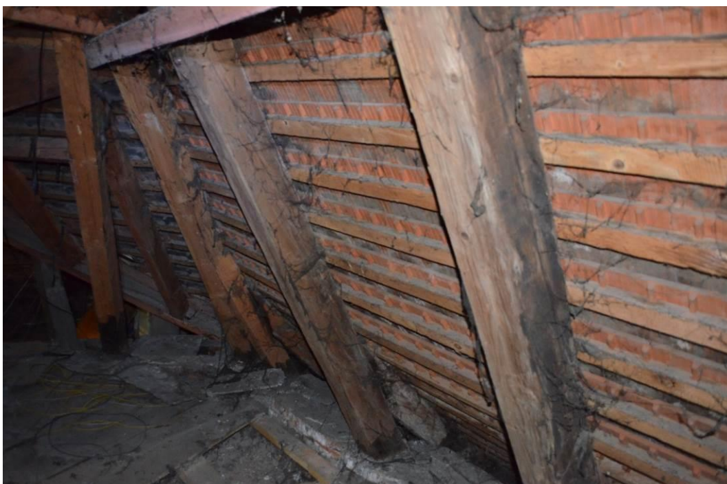
fot.2.2. Korozja krokwi wieżyczki
