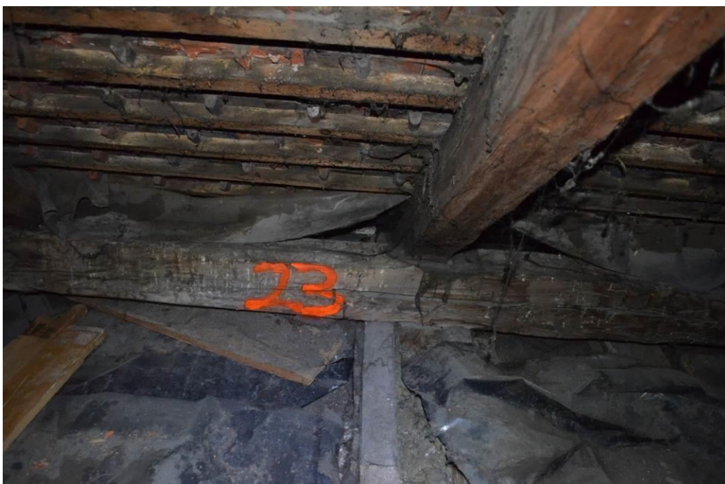
fot.2.28. Korozja płatwi pośredniej. Nieszczelności pokrycia
