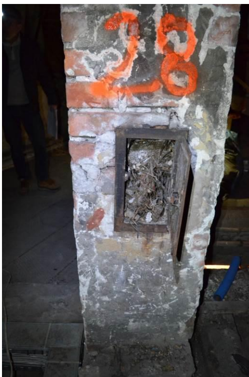
fot.2.32. Uszkodzenia spoin komina murowanego. Zatkany przewód wentylacyjny
