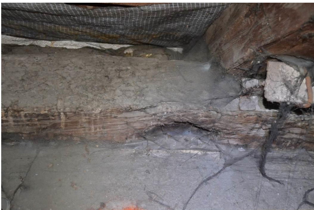
fot.2.14. Korozja płatwi pośredniej w poziomie sufitu
