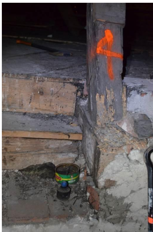
fot.2.8. Korozja krokwi i belki stropowej
