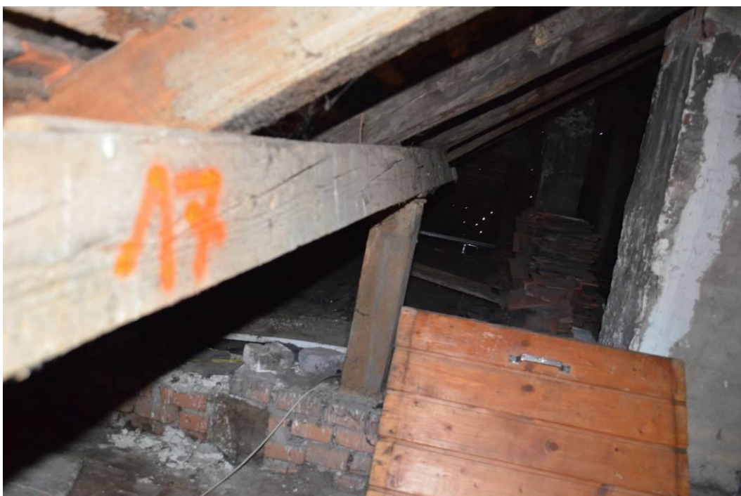
fot.2.22. Skręcenie płatwi pośredniej na słupie
