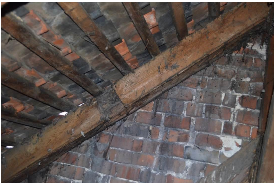
fot.2.26. Wadliwe wzmocnienie krokwi przy ścianie szczytowej
