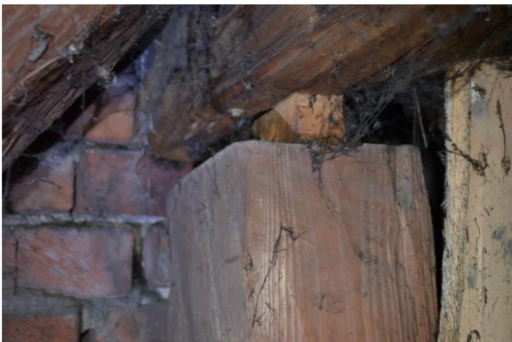
fot.2.16. Rozszczelnienie połączenia słup - platew
