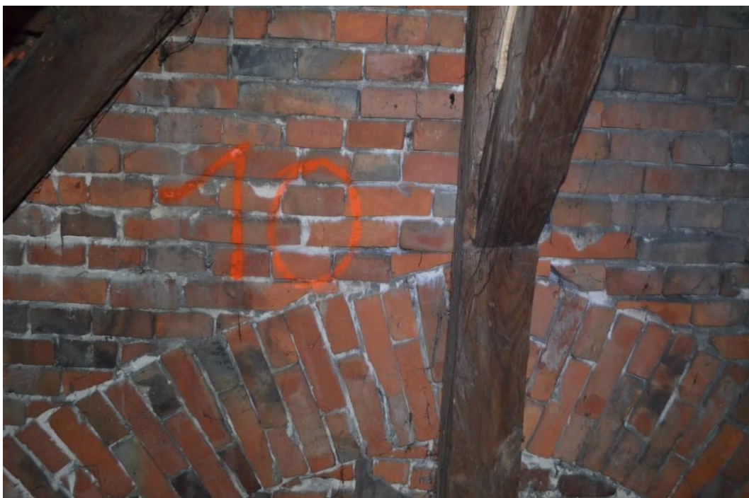
fot.2.15. Ścianka szczytowa z cegły pełnej
