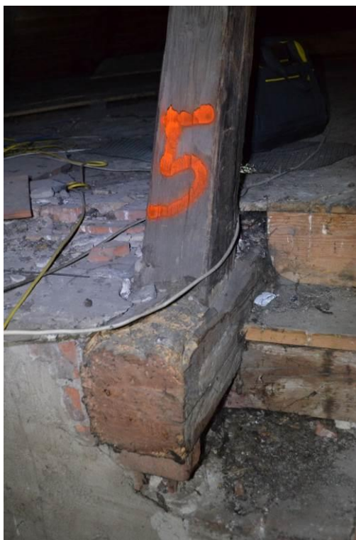
fot.2.9. Korozja krokwi i belki stropowej
