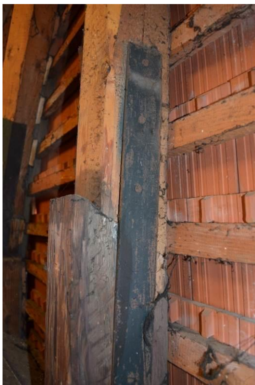
fot.2.3. Połączenie elementów pierwotnych krokwi z wymienianymi
