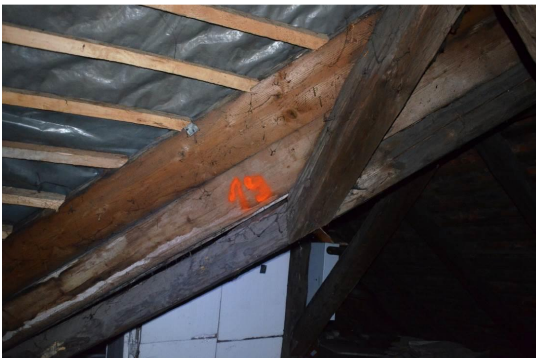
fot.2.24. Nieszczelność obróbek blacharskich w koszu. Korozja krokwi koszowej
