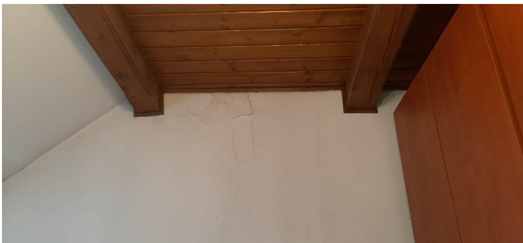
fot.3.4. Zacieki na suficie i ścianie w pomieszczeniu nr 2.3. Widoczne objawy przemarzania
