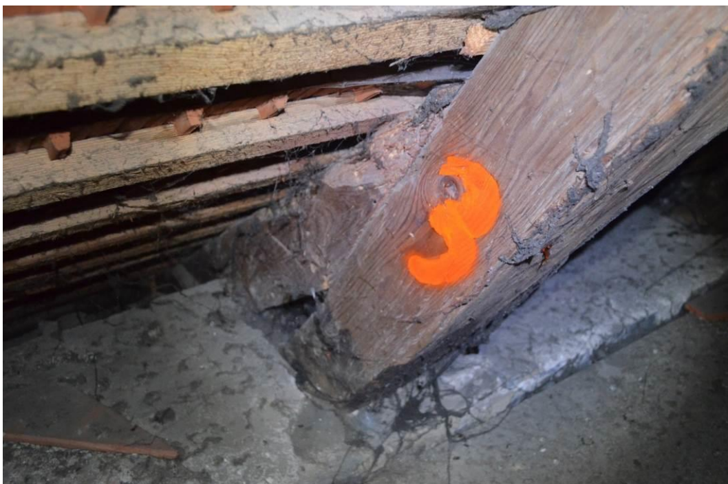
fot.2.7. Korozja przypustnic
