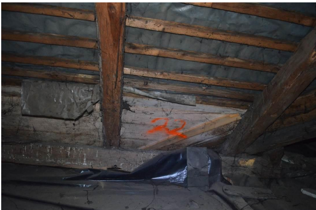
fot.2.27. Korozja płatwi pośredniej. Nieszczelności pokrycia
