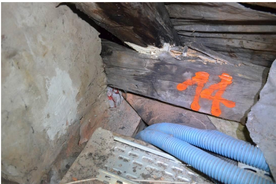
fot.2.19. Korozja płatwi pośredniej w poziomie sufitu
