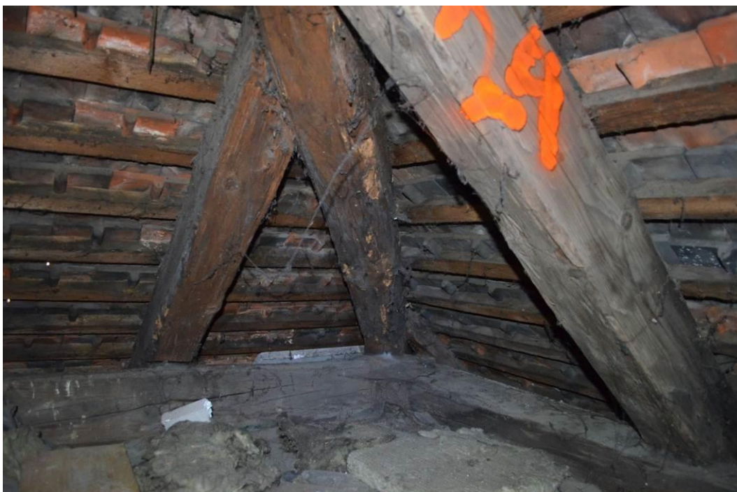
fot.2.29. Korozja krokwi narożnej. Nieszczelności pokrycia
