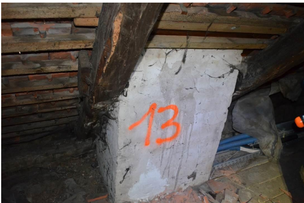
fot.2.18. Korozja krokwi przy kominie. Widoczne ślady przecieków obróbek blacharskich
