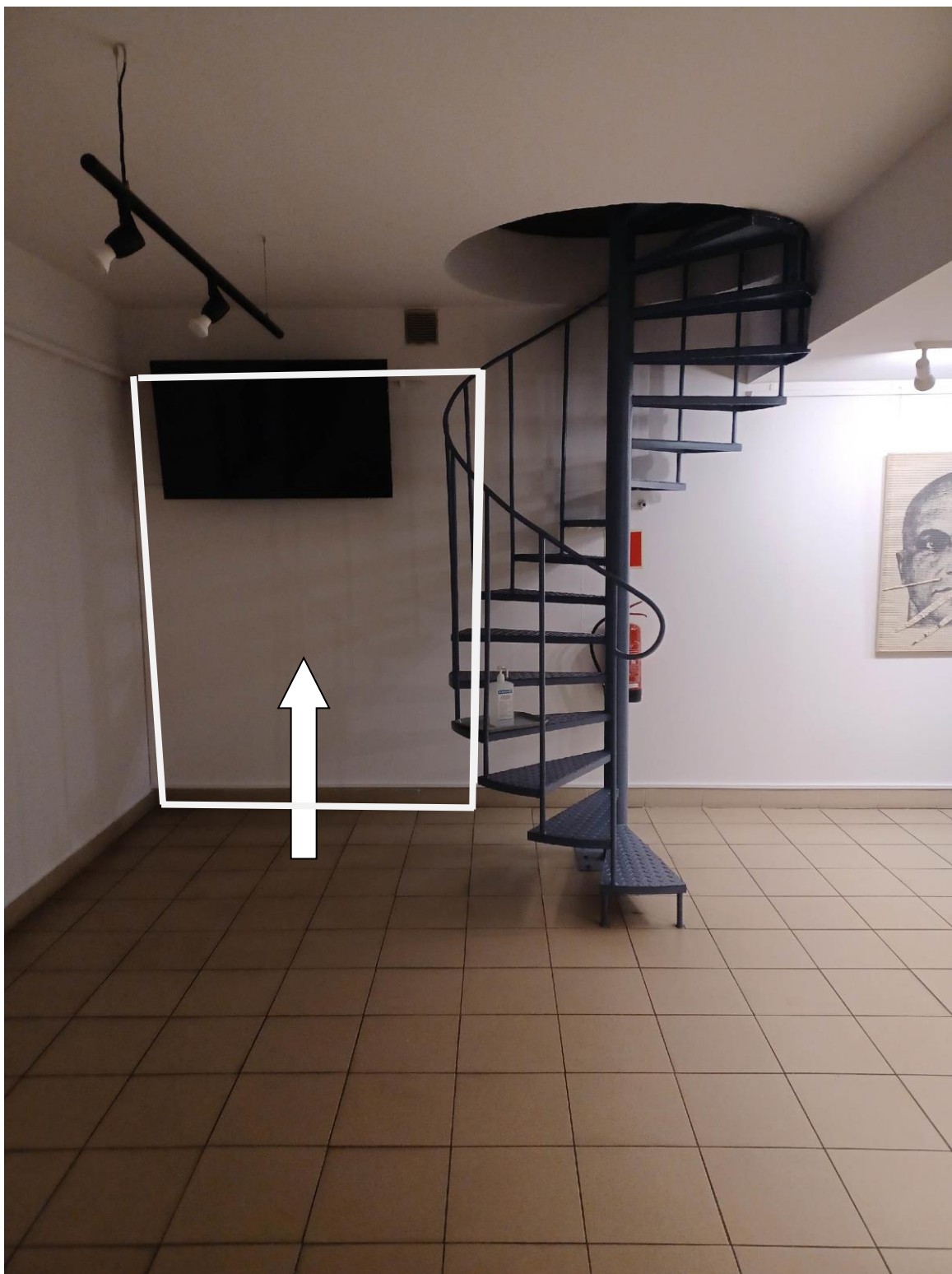
Planowany otwór w ścianie na poziomie piwnicy do nowobudowanej klatki schodowej.
