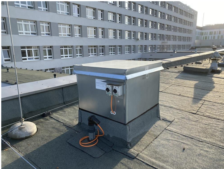
Fot. II.26. Dach budynku diagnostycznego B- Brak zasilania wentylatora oddymiającego.
