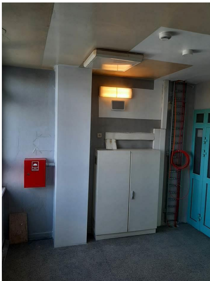
Fot. III.297. System oddymiania. Klatka a. Niedokończona instalacja.
