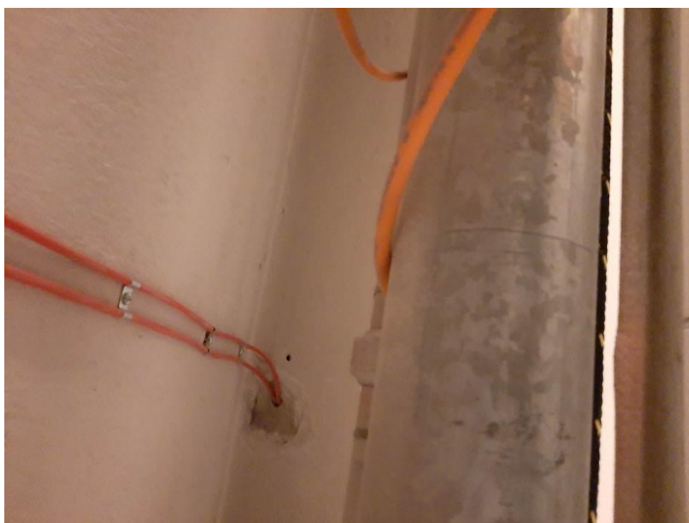
Fot. III.170. Stan techniczny instalacji systemów przeciwpożarowych piwnicy budynku „C” Nieprawidłowe prowadzenie kabli – brak uchwytów. Brak odpowiedniego przepustu kablowego.
