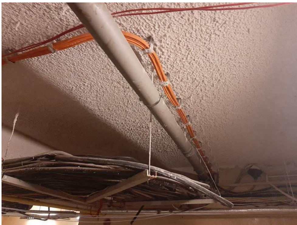
Fot. III.85. Stan techniczny instalacji systemów przeciwpożarowych piwnicy budynku „C” Nieprawidłowe prowadzenie kabli sygnalizacyjnych (czerwone) – brak uchwytów.
