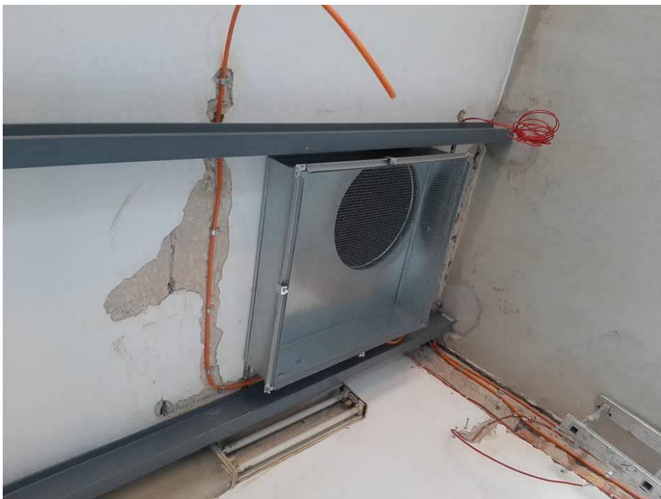
Fot. III.256. System oddymiania. Klatka h. Niedokończona instalacja. Brak urządzeń końcowych.
