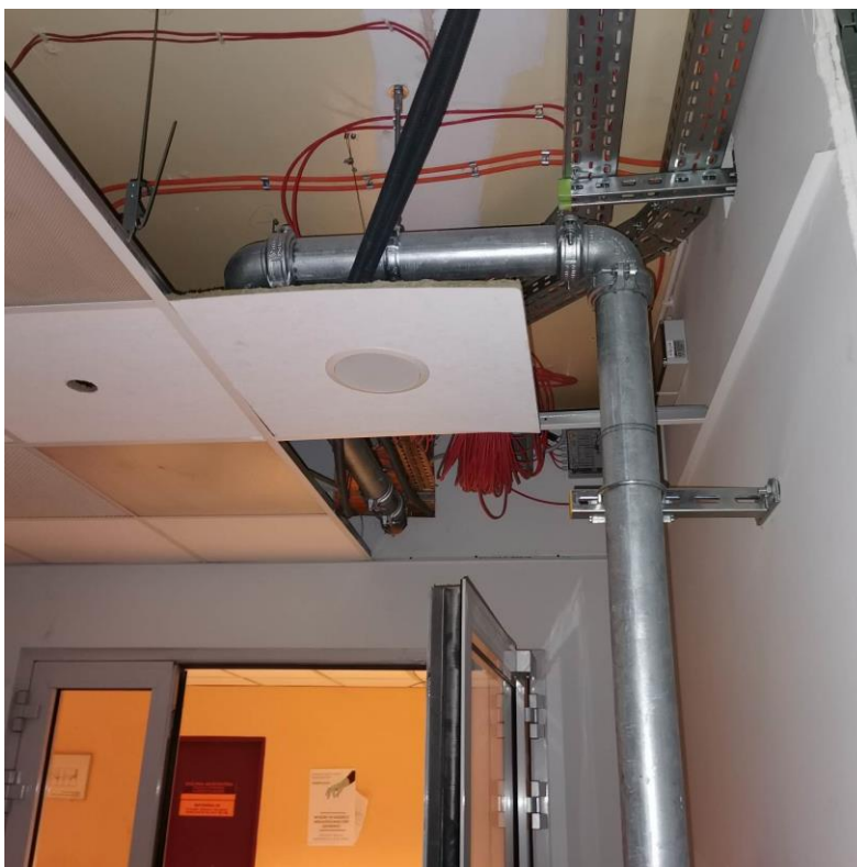
Fot. nr I.119. Ubytki sufitu powodujące swobodną migrację zanieczyszczonego powietrza pomiędzy pomieszczeniami. Brak zabudowy instalacji hydrantowej. BUD.C.
