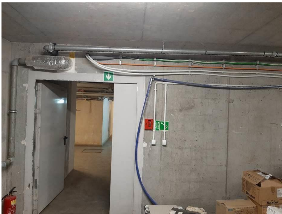
Fot. III.252. Montaż liniowego detektora wycieku na instalacji hydrantowej. Instalacja wykonana prawidłowo.
