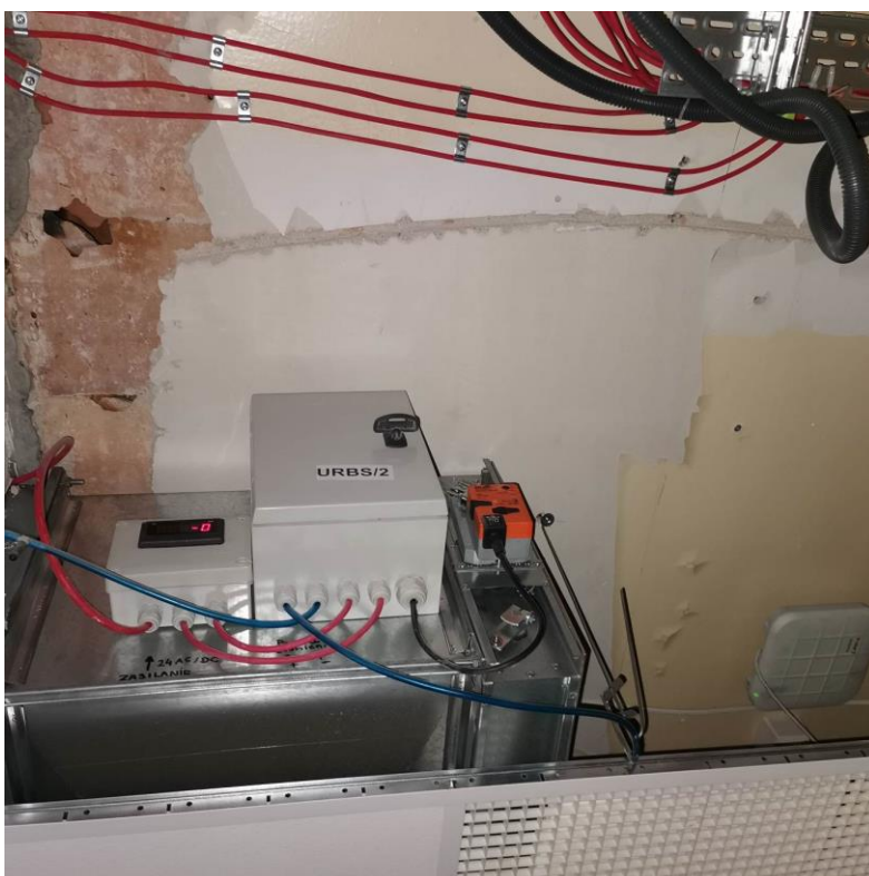
Fot. nr I.120. Ubytki sufitu powodujące swobodną migrację zanieczyszczonego powietrza pomiędzy pomieszczeniami. BUD.C.
