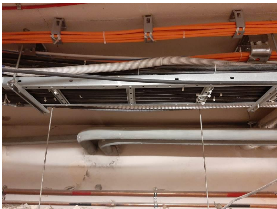
Fot.III.190. Stan techniczny instalacji systemów przeciwpożarowych piwnicy budynku „C” Prawidłowe prowadzenie instalacji.
