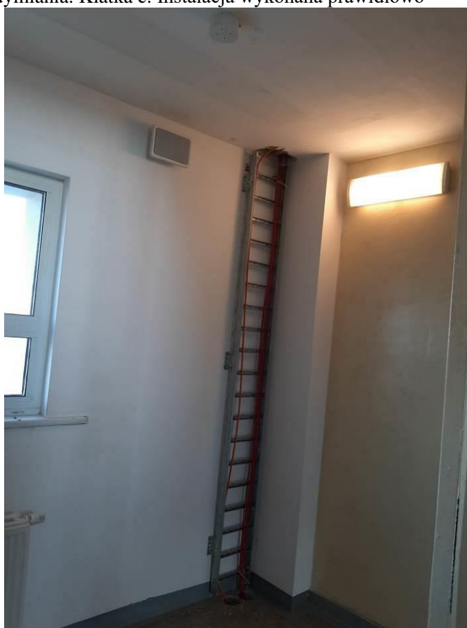
Fot. III.318. System oddymiania. Klatka c. Niedokończona instalacja. Brak odpowiednich przepustów kablowych.
