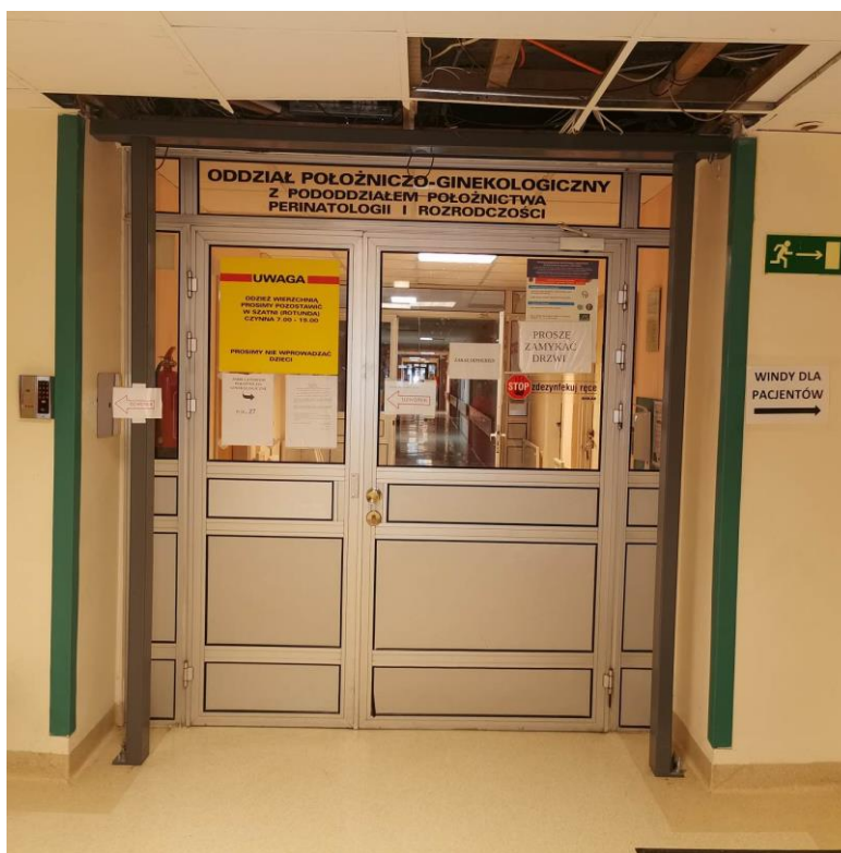
Fot. nr I.90. Ubytki sufitu powodujące swobodną migrację zanieczyszczonego powietrza pomiędzy pomieszczeniami. Brak zamontowanej stolarki drzwiowej -elementu ochrony przeciwpożarowej. BUD.B.
