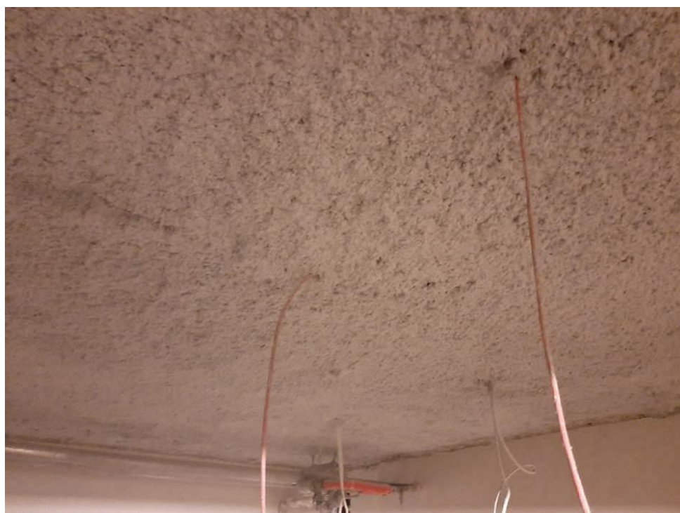
Fot. III.182. Stan techniczny instalacji systemów przeciwpożarowych piwnicy budynku „C” Nieprawidłowe prowadzenie kabli – brak uchwytów.
