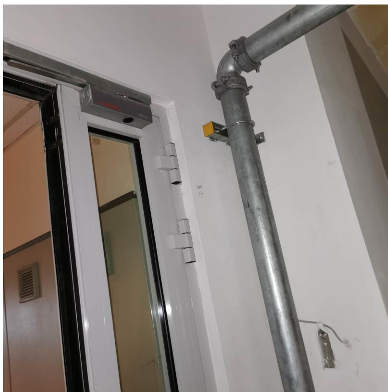
Fot. nr I.68. Brak zabudowy instalacji hydrantowej powoduje trudności w utrzymaniu warunków higienicznych. BUD.C.
