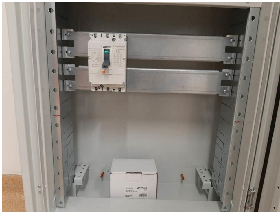
Fot. III.398. Pomieszczenie techniczne. Szafa rozdzielnicowa elektryczna. Brak okablowania szafy.
