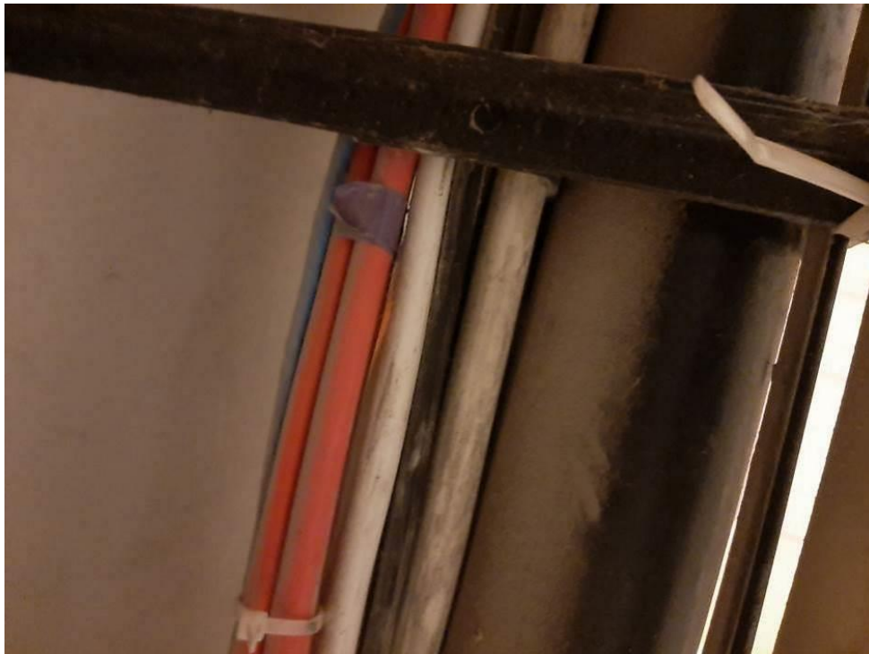
Fot. III.151. Stan techniczny instalacji systemów przeciwpożarowych piwnicy budynku „C” Nieprawidłowe prowadzenie kabli – razem z innymi instalacjami.
