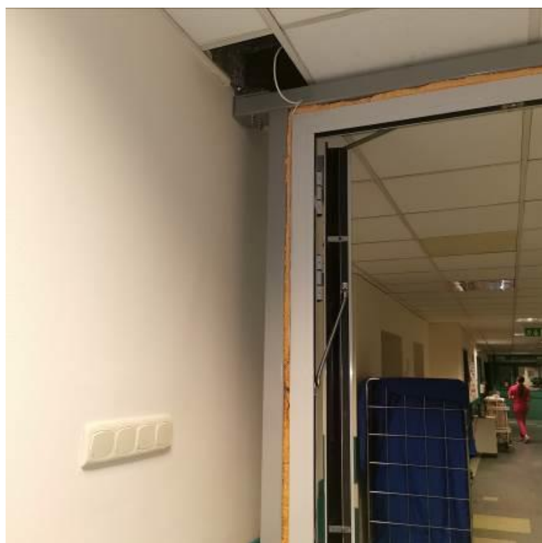
Fot. nr I.24. Wbudowane drzwi pożarowe. Brak realizowania robót wykończeniowych. BUD.C.
