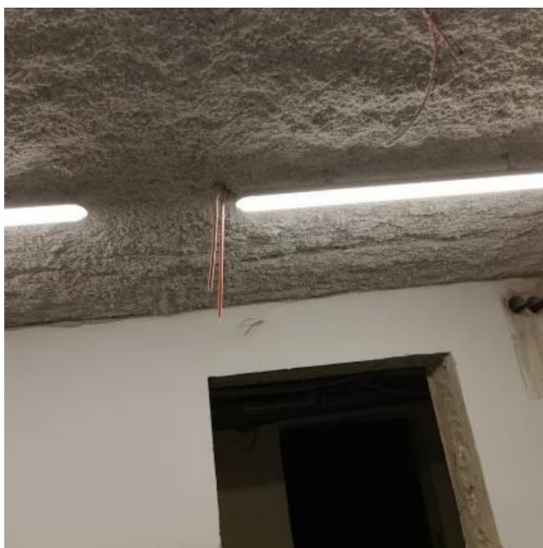
Fot. nr I.8. Widok izolacji natryskowej poprawiającej odporność ogniową stropu nad piwnicą. BUD.D
