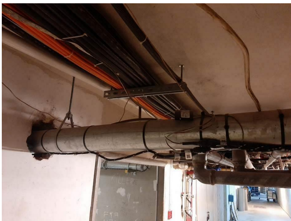
Fot. III.116. Stan techniczny instalacji systemów przeciwpożarowych piwnicy budynku „C” Nieprawidłowy montaż instalacji detektora wycieku instalacji hydrantowej.
