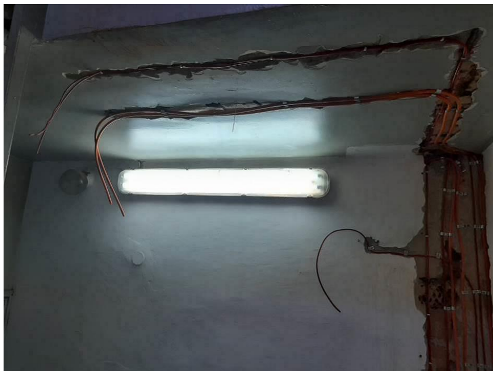
Fot.III.261. System oddymiania. Klatka h. Niedokończona instalacja. Brak urządzeń końcowych.
