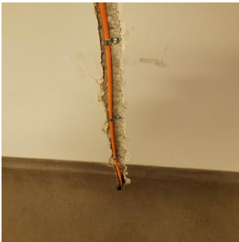
Fot. nr I.106. Brak uzupełnienia tynku ochronnego instalacji pożarowych. BUD.C.
