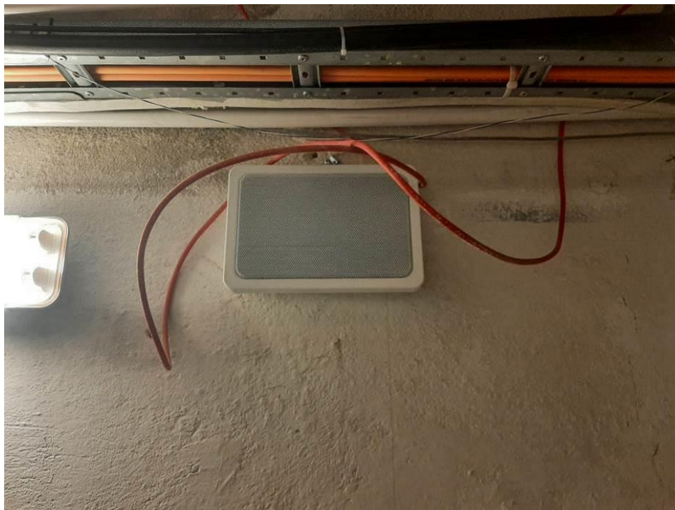
Fot. III.18. Stan techniczny instalacji systemów przeciwpożarowych piwnicy budynku „B” Nieprawidłowe prowadzenie kabli sygnalizacyjnych (czerwone) – brak uchwytów. Niepodłączony głośnik systemu DSO.
