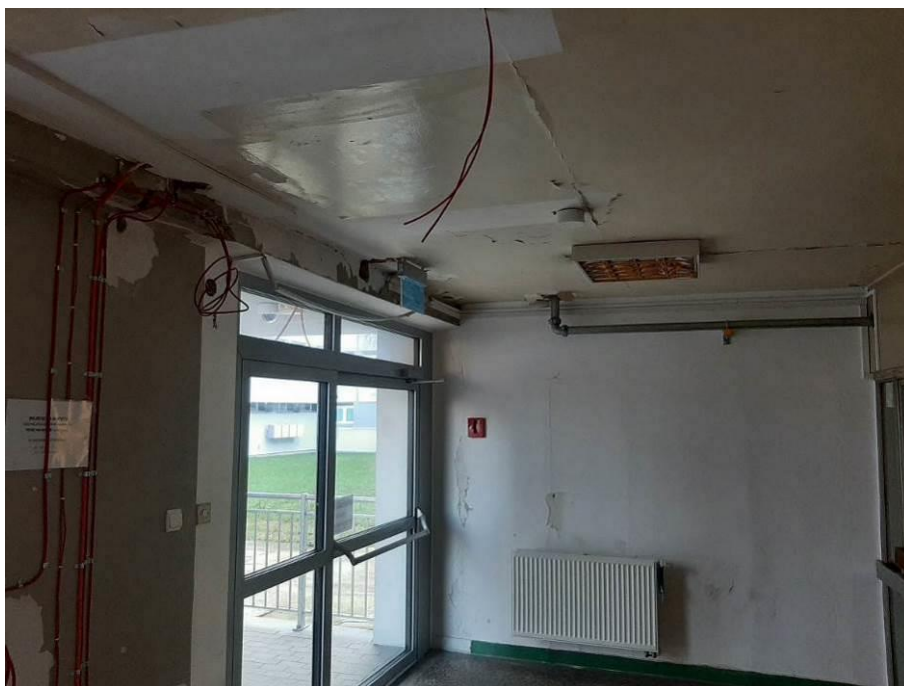
Fot. III.286. System oddymiania. Klatka g. Niedokończona instalacja. Brak urządzeń końcowych. Brak odpowiednich przepustów kablowych.
