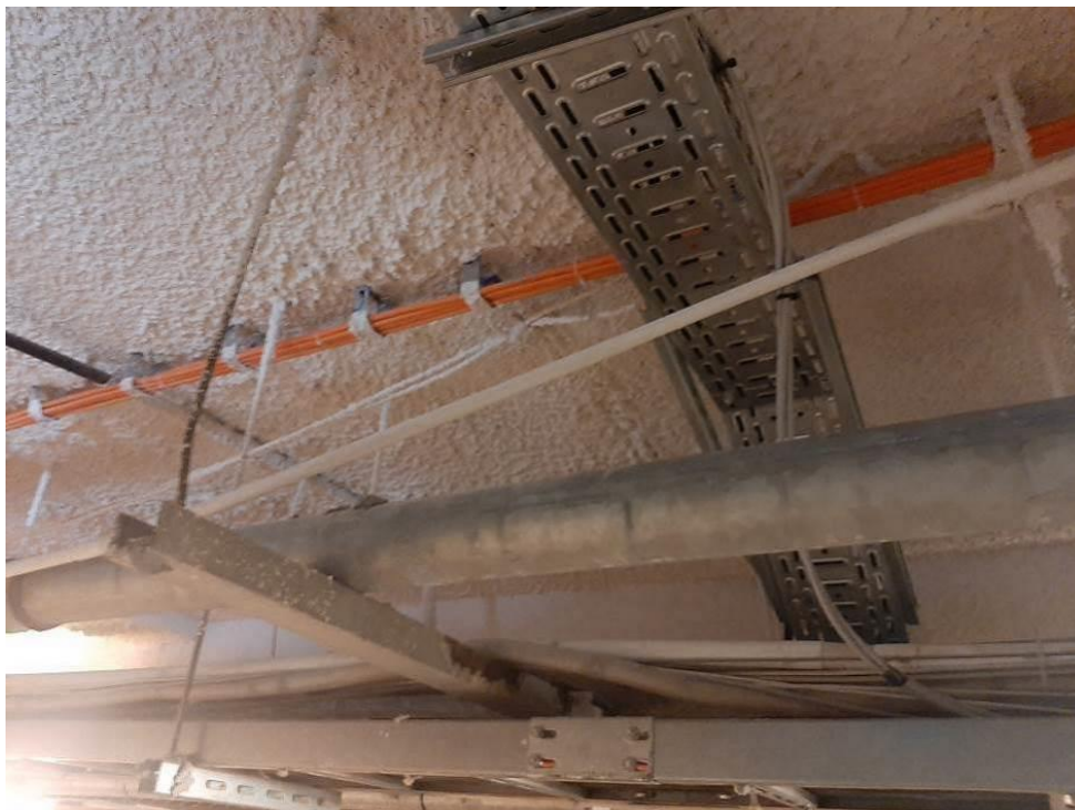
Fot. III.69. Stan techniczny instalacji systemów przeciwpożarowych piwnicy budynku „C” Nieprawidłowe prowadzenie kabli sygnalizacyjnych (czerwone) – brak uchwytów.
