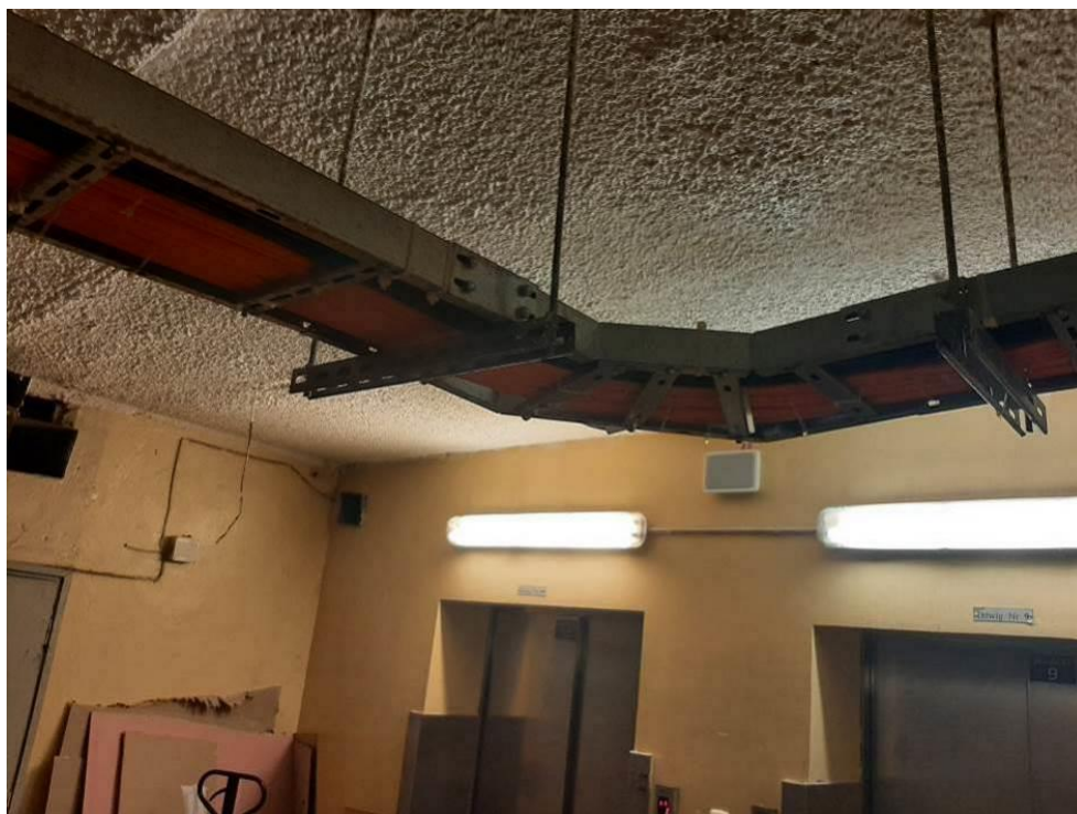
Fot.III.92. Stan techniczny instalacji systemów przeciwpożarowych piwnicy budynku „C” Nieprawidłowe prowadzenie kabli zasilających (pomarańczowe) – razem z innymi instalacjami.
