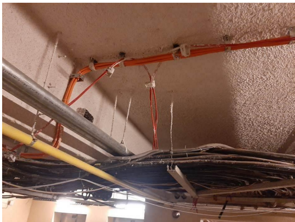
Fot. III.84. Stan techniczny instalacji systemów przeciwpożarowych piwnicy budynku „C” Nieprawidłowe prowadzenie kabli sygnalizacyjnych (czerwone) – nieprzykręcone uchwyty.
