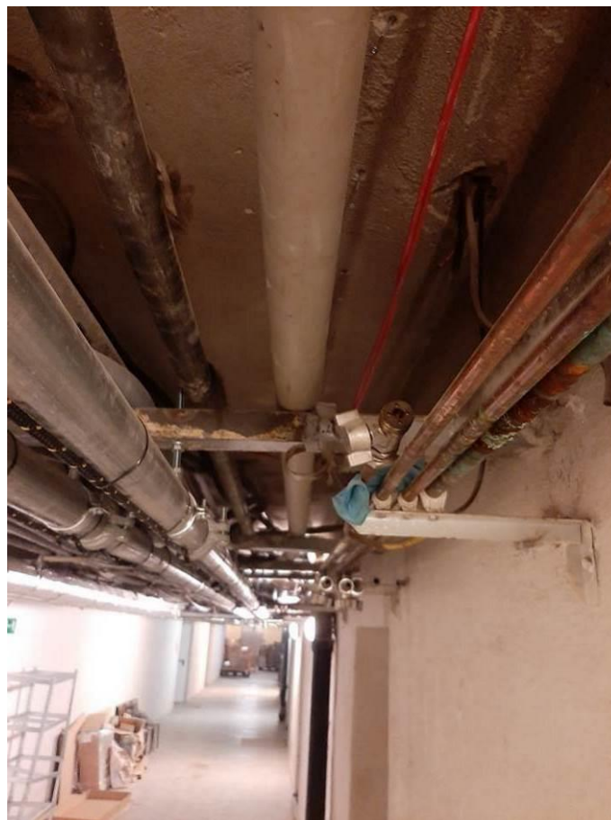
Fot.III.56. Stan techniczny instalacji systemów przeciwpożarowych piwnicy łącznika „IV” Nieprawidłowe prowadzenie kabli zasilających (pomarańczowe) – brak uchwytów.
