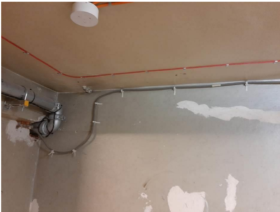
Fot.III.121. Stan techniczny instalacji systemów przeciwpożarowych piwnicy budynku „C” Prawidłowe prowadzenie instalacji sygnalizacyjnej. Nieprawidłowy montaż liniowej czujki ciepła – niezamocowane uchwyty. Brak odpowiedniego przepustu kablowego.
