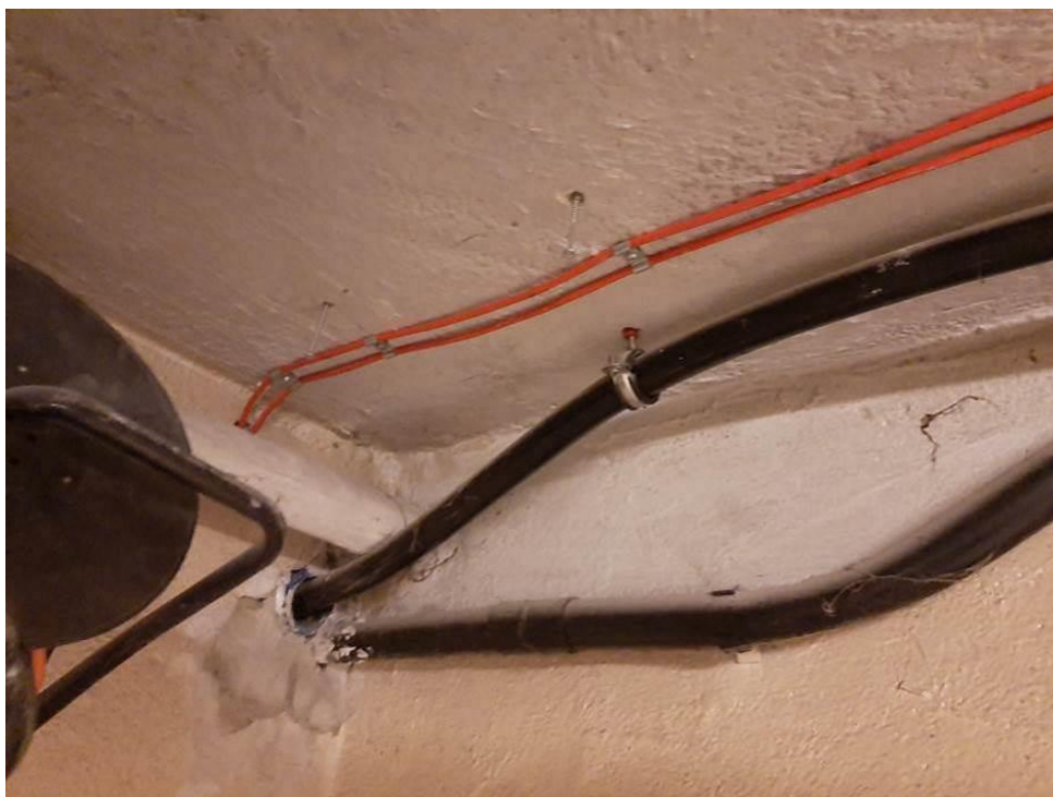
Fot. III.97. Stan techniczny instalacji systemów przeciwpożarowych piwnicy budynku „C” Nieprawidłowe prowadzenie kabli sygnalizacyjnych (czerwone) – brak odpowiedniego przepustu kablowego.
