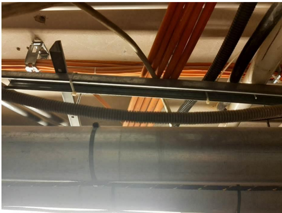
Fot. III.123. Stan techniczny instalacji systemów przeciwpożarowych piwnicy budynku „C” Nieprawidłowe prowadzenie kabli – skrzyżowanie z inną instalacją.
