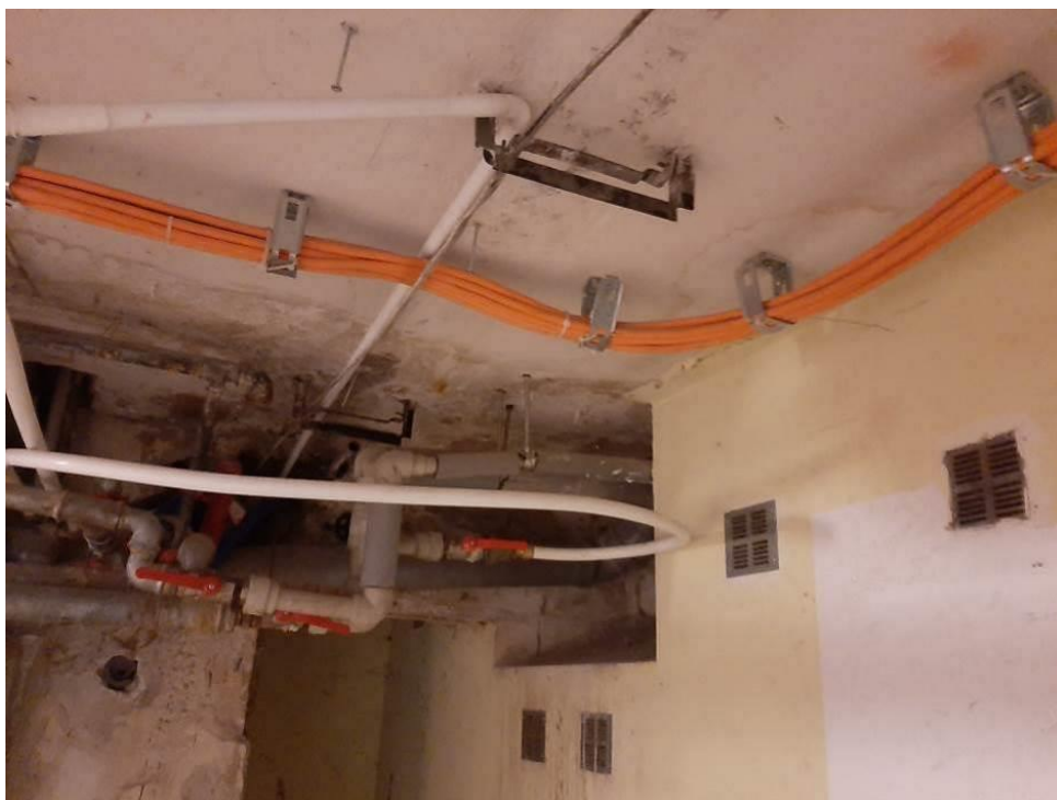
Fot. III.115. Stan techniczny instalacji systemów przeciwpożarowych piwnicy budynku „C” Nieprawidłowe skrzyżowanie instalacji zasilających.
