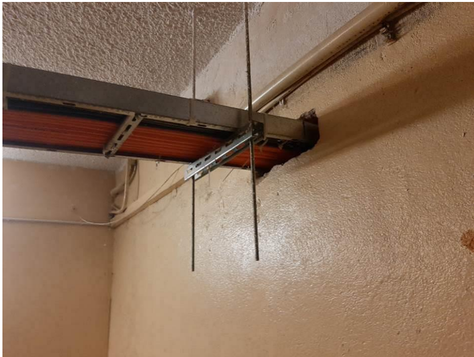
Fot. III.91. Stan techniczny instalacji systemów przeciwpożarowych piwnicy budynku „C” Nieprawidłowe prowadzenie kabli zasilających (pomarańczowe) – brak odpowiedniego przepustu kablowego. Nieprawidłowe prowadzenie kabli zasilających (pomarańczowe) – razem z innymi instalacjami.
