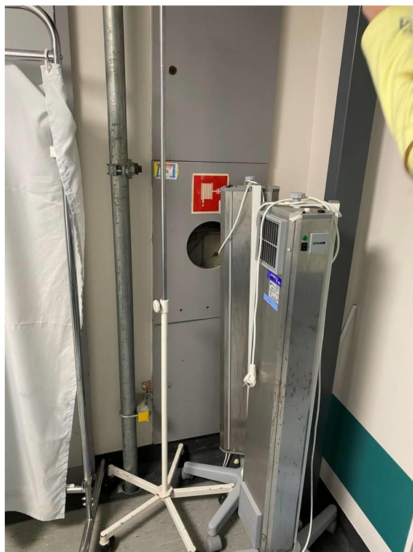
Fot. II.13. Piętro budynku łózkowego C- Brak Zaworu hydrantowego. Prowadzenie instalacji inne niż w projekcie budowlanym. W projekcie budowlanym instalację prowadzono w starych szachtach. Nie ma informacji dlaczego wykonano instalacje poza szachtami na ścianie korytarzy.
