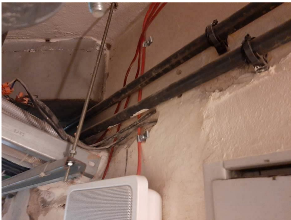
Fot. III.126. Stan techniczny instalacji systemów przeciwpożarowych piwnicy budynku „C” Nieprawidłowe prowadzenie kabli – brak uchwytów.
