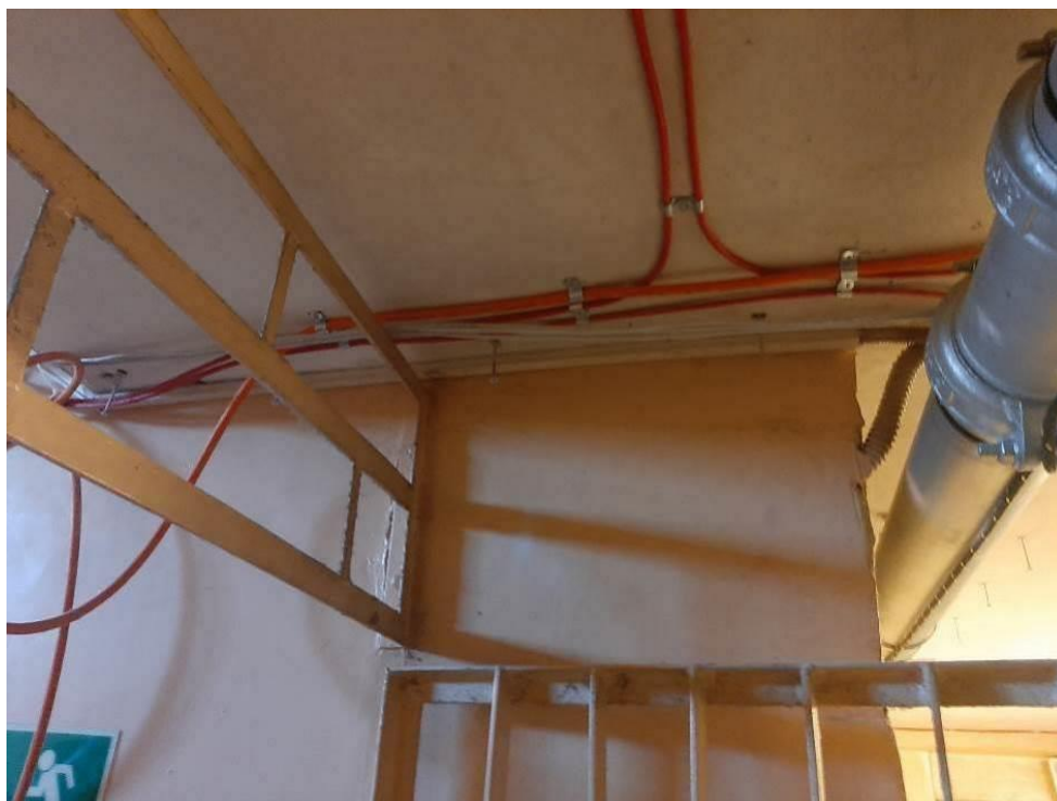
Fot. III.107. Stan techniczny instalacji systemów przeciwpożarowych piwnicy budynku „C” Nieprawidłowe prowadzenie kabli – brak uchwytów.
