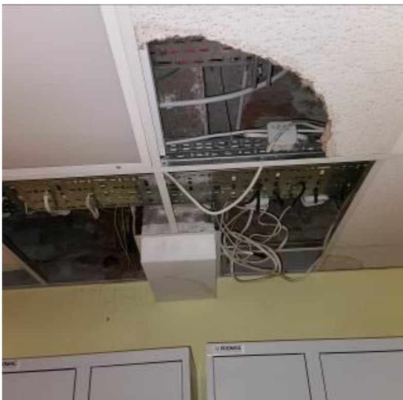
Fot. nr I.13. Brak uzupełnienia i naprawy sufitu podwieszonego po realizacji prac w przestrzeni podstropowej. Miejsce swobodnego przepływu zanieczyszczonego powietrza pomiędzy pomieszczeniami. BUD.D.
