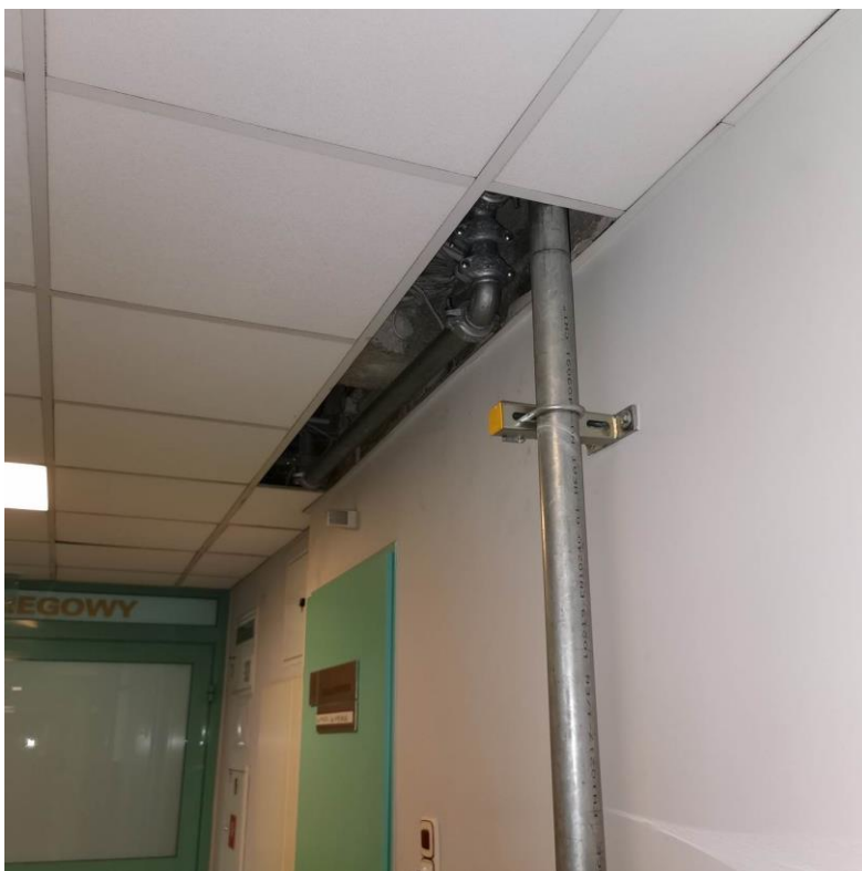
Fot. nr I.101. Ubytki sufitu powodujące swobodną migrację zanieczyszczonego powietrza pomiędzy pomieszczeniami. BUD.B.
