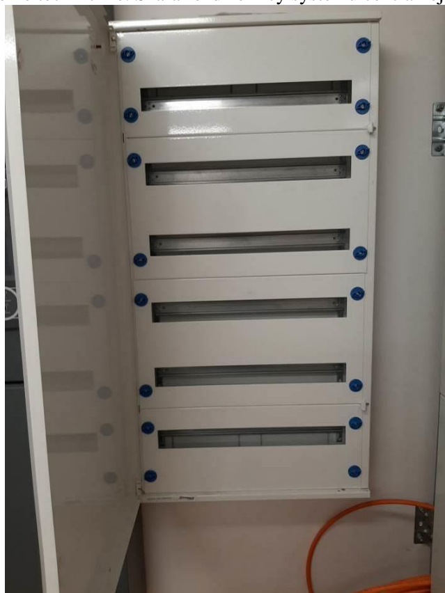
Fot. III.381. Pomieszczenie techniczne. Szafa rozdzielnic systemu centralnej baterii. Brak wyposażenia elektrycznego.
