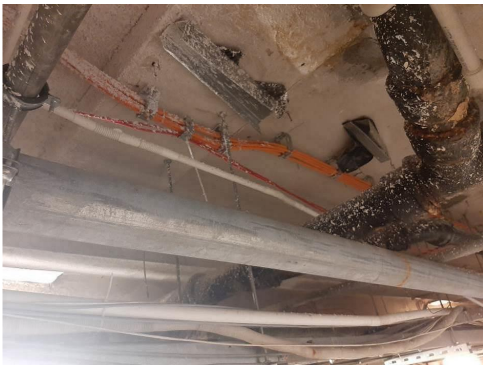
Fot. III.67. Stan techniczny instalacji systemów przeciwpożarowych piwnicy budynku „C” Nieprawidłowe prowadzenie kabli sygnalizacyjnych (czerwone) – brak uchwytów
