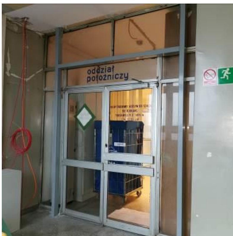
Fot. nr I.20. Wbudowana rama stalowa na potrzeby zamocowania drzwi p. poż. Brak wymaganych drzwi. BUD.B
