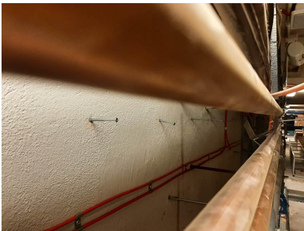
Fot. III.162. Stan techniczny instalacji systemów przeciwpożarowych piwnicy budynku „C” Nieprawidłowe prowadzenie kabli – brak uchwytów.
