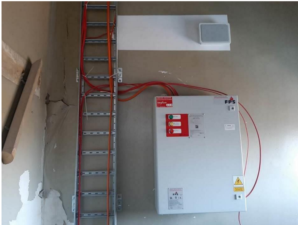
Fot. III.337. System oddymiania. Klatka d. Niedokończona instalacja.
