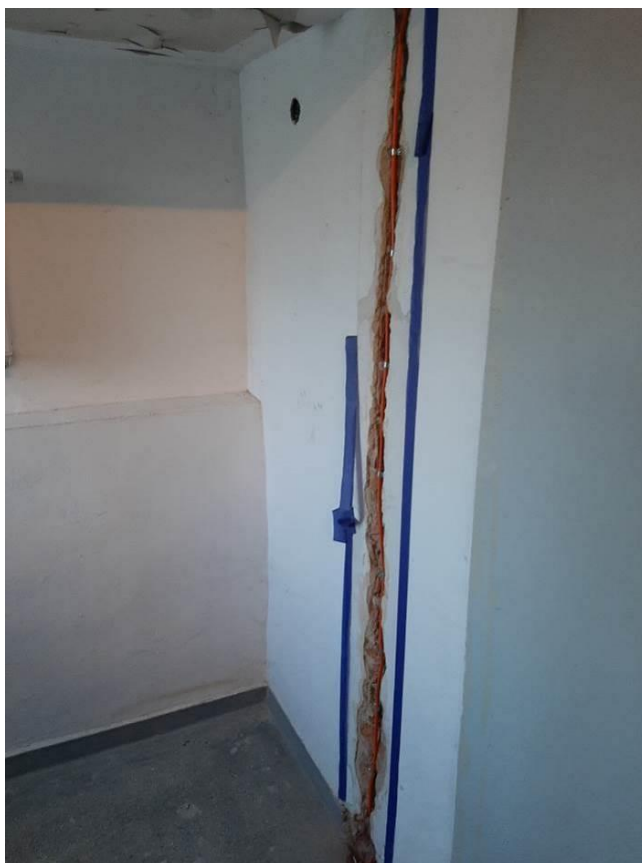
Fot. III.268. System oddymiania. Klatka h. Niedokończona instalacja.
