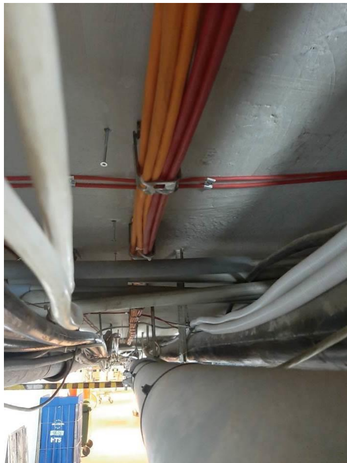
Fot. III.136. Stan techniczny instalacji systemów przeciwpożarowych piwnicy budynku „C” Poprawne ułożenie instalacji.
