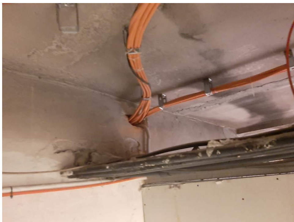
Fot.III.42. Stan techniczny instalacji systemów przeciwpożarowych piwnicy budynku „B” Nieprawidłowe prowadzenie kabli zasilających (pomarańczowe) – razem i inną instalacją. Nieprawidłowe prowadzenie kabli sygnalizacyjnych (czerwone) – brak uchwytów.
