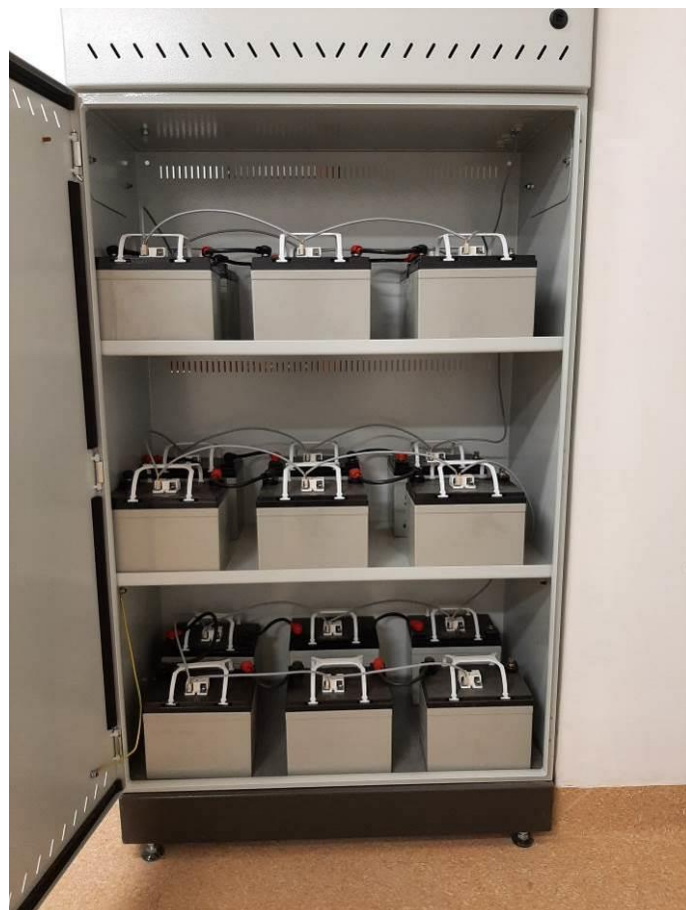
Fot.III.387. Pomieszczenie techniczne. Szafa systemu centralnej baterii. Niepodłączone akumulatory buforowe.
