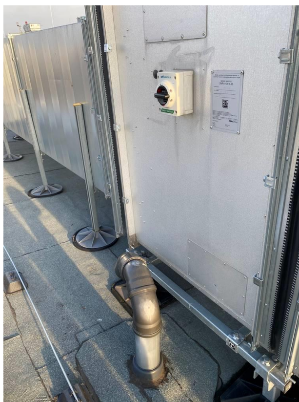
Fot. II.28. Dach budynku łózkowego C- Brak sprawdzenia amortyzacji wentylatorów. Koniecznie należy zweryfikować hałas i drgania przenoszone od instalacji wentylacji pożarowej.
