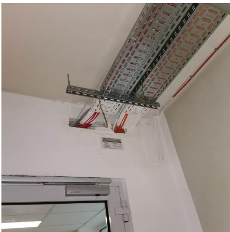
Fot. nr I.16. Brak prawidłowego wykonania zabezpieczeń przejść instalacyjnych przez ścianę. BUD.B
