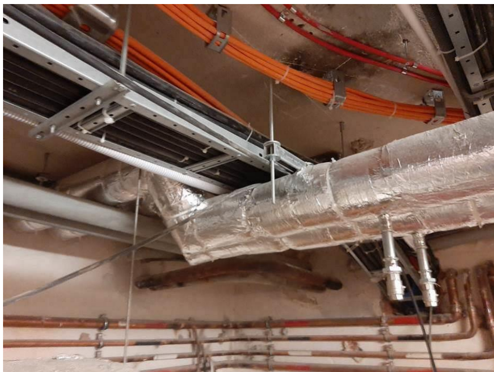
Fot.III.189. Stan techniczny instalacji systemów przeciwpożarowych piwnicy budynku „C” Prawidłowe prowadzenie instalacji.
