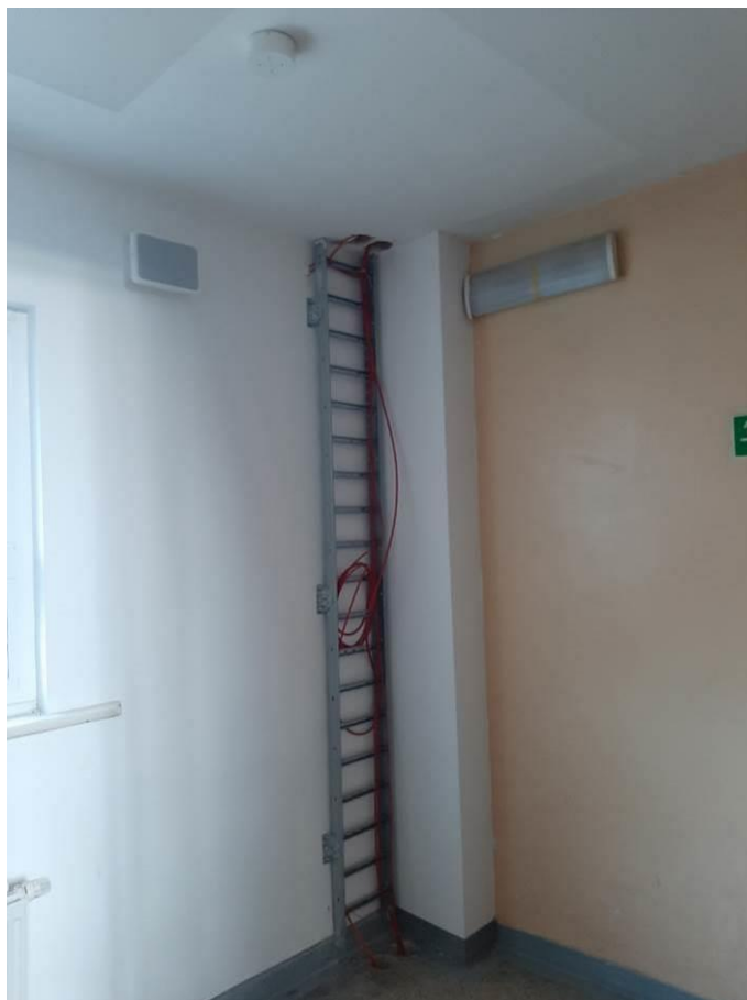
Fot. III.328. System oddymiania. Klatka c. Niedokończona instalacja. Brak odpowiednich przepustów kablowych.
