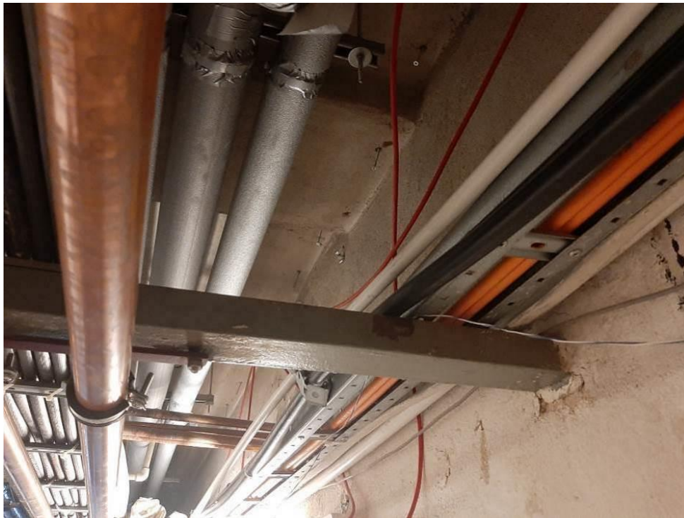
Fot. III.17. Stan techniczny instalacji systemów przeciwpożarowych piwnicy budynku „B” Nieprawidłowe prowadzenie kabli sygnalizacyjnych (czerwone) – brak uchwytów.
