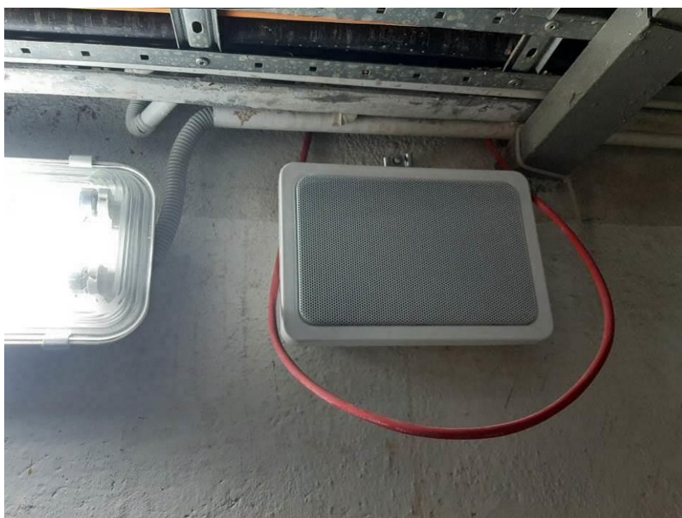
Fot. III.26. Stan techniczny instalacji systemów przeciwpożarowych piwnicy budynku „B” Nieprawidłowe prowadzenie kabli sygnalizacyjnych (czerwone) – brak uchwytów. Niepodłączony głośnik DSO.
