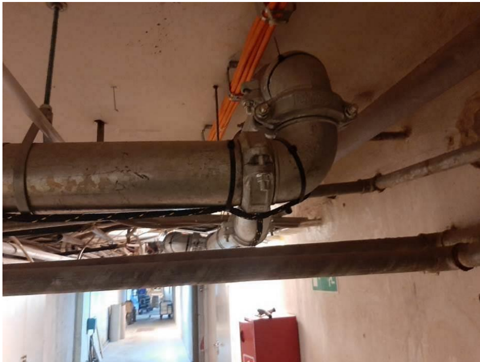
Fot. III.117. Stan techniczny instalacji systemów przeciwpożarowych piwnicy budynku „C” Poprawny montaż detektora wycieku instalacji hydrantowej.
