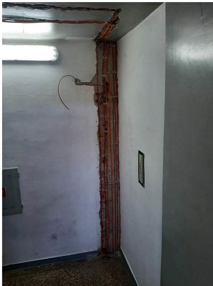
Fot.III.260. System oddymiania. Klatka h. Niedokończona instalacja. Brak urządzeń końcowych.
