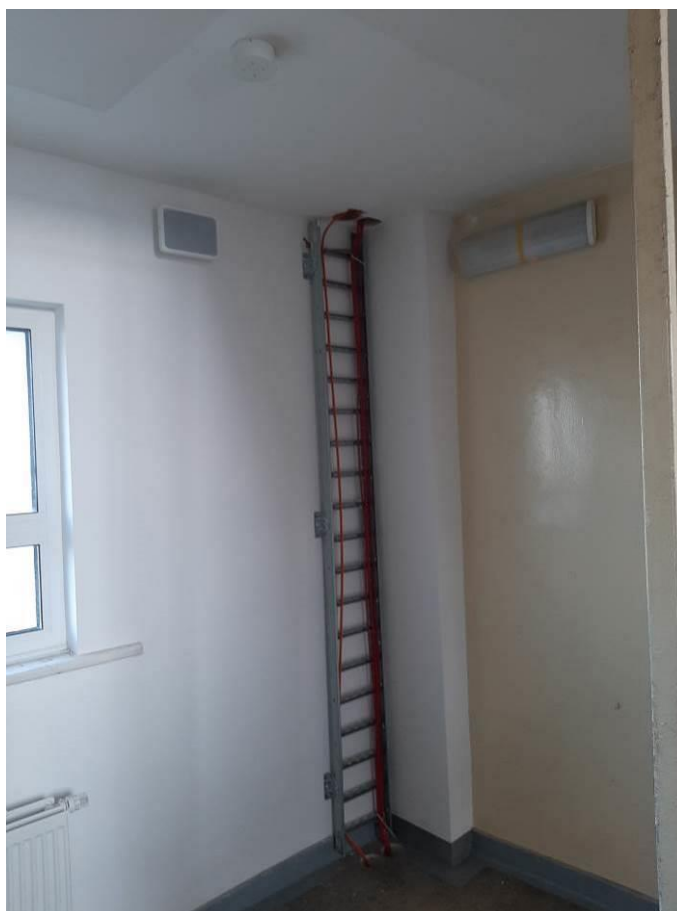
Fot. III.322. System oddymiania. Klatka c. Niedokończona instalacja. Brak odpowiednich przepustów kablowych.
