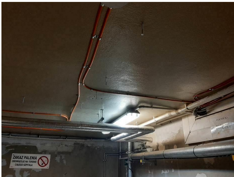
Fot. III.119. Stan techniczny instalacji systemów przeciwpożarowych piwnicy budynku „C” Prawidłowe prowadzenie instalacji. Brak odpowiedniego przepustu kablowego.
