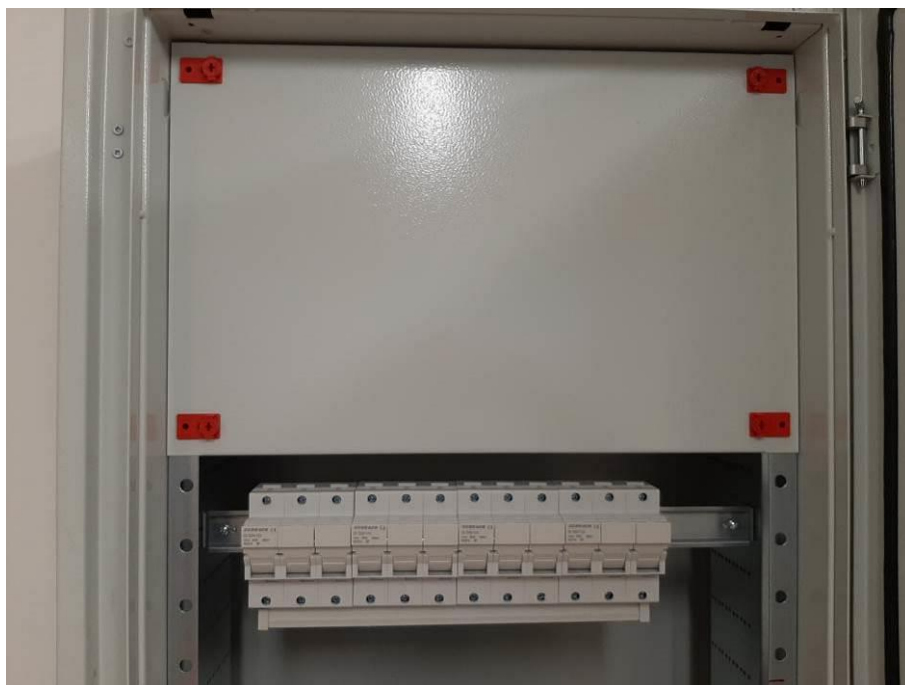
Fot. III.395. Pomieszczenie techniczne. Szafa rozdzielnic elektrycznej. Brak okablowania szafy.
