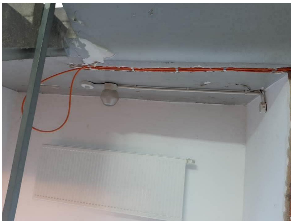
Fot. III.263. System oddymiania. Klatka h. Niedokończona instalacja. Brak urządzeń końcowych.
