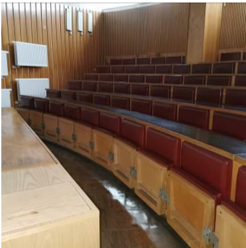
Fot. nr I.53. Brak usunięcia łatwopalnego wyposażenia Sali wykładowej. BUD.A.
