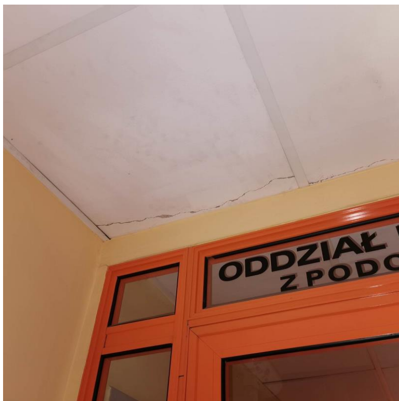
Fot. nr I.82. Uszkodzony element sufitu systemowego.
