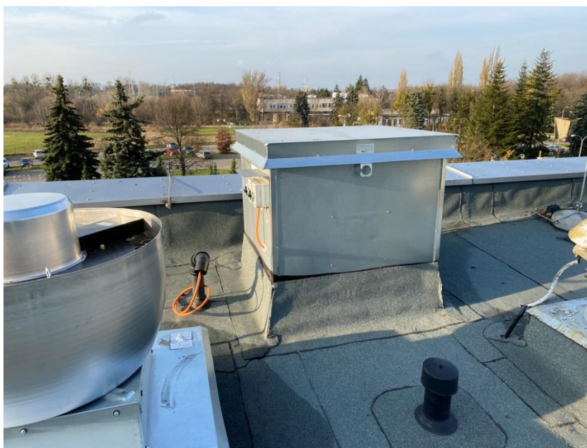
Fot.II.24. Dach budynku diagnostycznego B- Brak zasilania. Kable do urządzeń pozostawione na dachu bez podejścia do urządzenia. Brak koryt kablowych.
