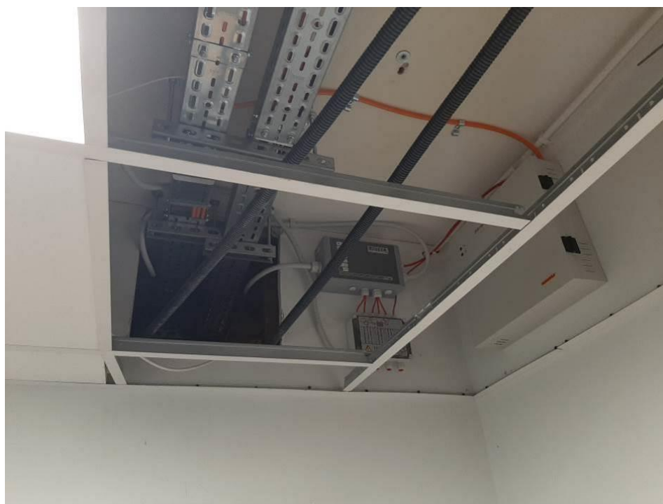
Fot. III.226. System detekcji ciepła LISTEC. Budynek „C”. Brak uchwytyów kablowych.
