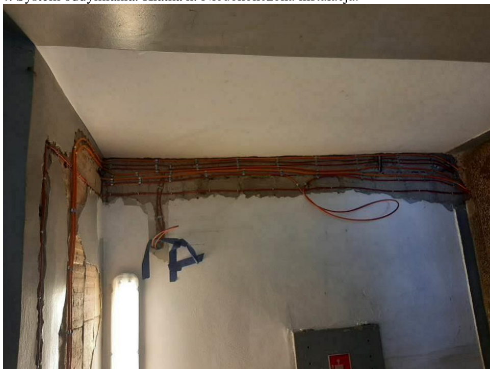
Fot. III.265. System oddymiania. Klatka h. Niedokończona instalacja. Brak urządzeń końcowych.
