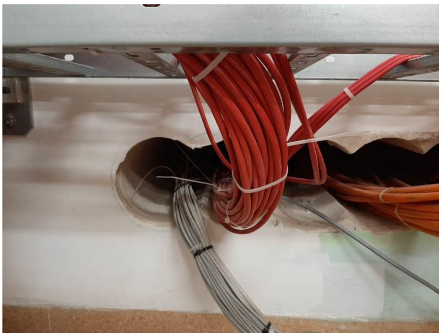
Fot. III.364. Pomieszczenie techniczne. Okablowanie DSO. Brak odpowiednich przepustów kablowych.
