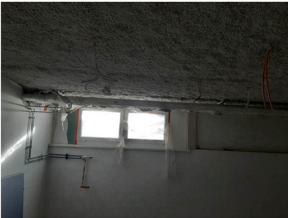
Fot. III.184. Stan techniczny instalacji systemów przeciwpożarowych piwnicy budynku „C” Nieprawidłowe prowadzenie kabli – brak uchwytów. Brak urządzeń końcowych.
