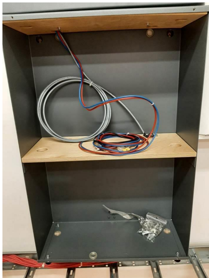
Fot. III.379. Pomieszczenie techniczne. Szafa systemu sygnalizacji pożaru. Brak akumulatorów buforowych.
