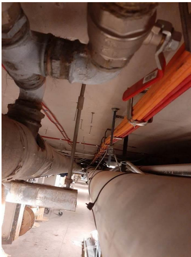
Fot. III.141. Stan techniczny instalacji systemów przeciwpożarowych piwnicy budynku „C” Nieprawidłowe prowadzenie kabli – kable sygnalizacyjne razem z zasilającymi.
