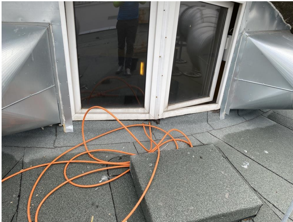
Fot.II.11. Dach Rotundy budynek A - Brak koryt kablowych. Kable są rzucone na dachu bez zabezpieczenia przed ptakami czy przypadkowym uszkodzeniem.
