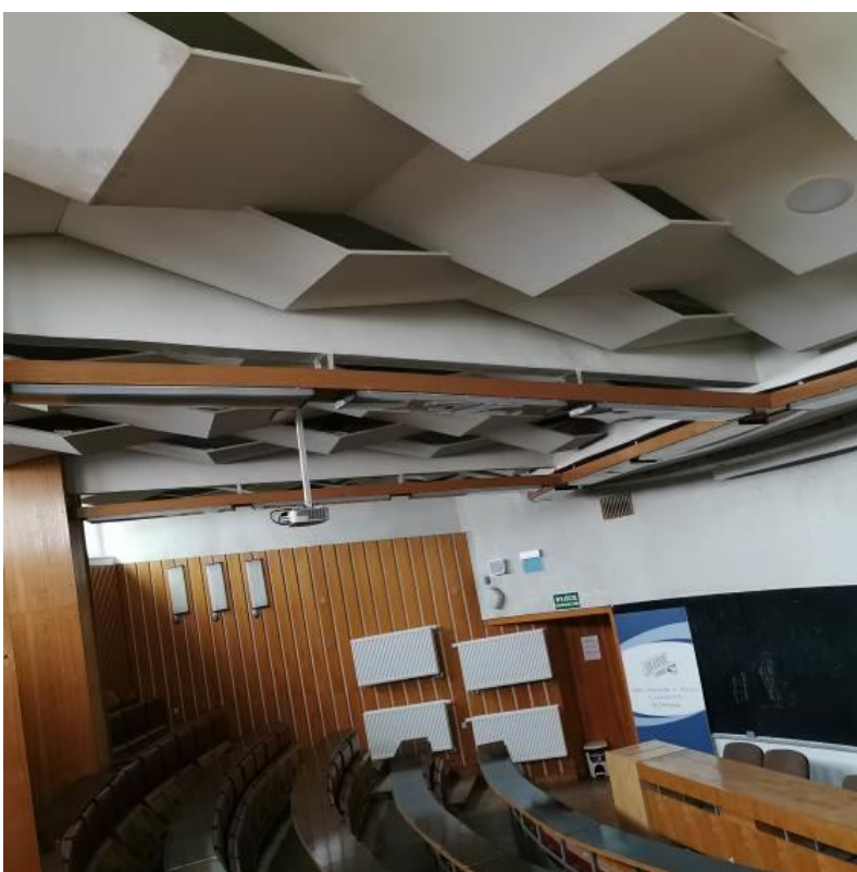
Fot. nr I.50. Brak usunięcia łatwopalnych elementów sufitowych i okładzin ściennych z wnętrza pomieszczenia Sali wykładowej. BUD.A.
