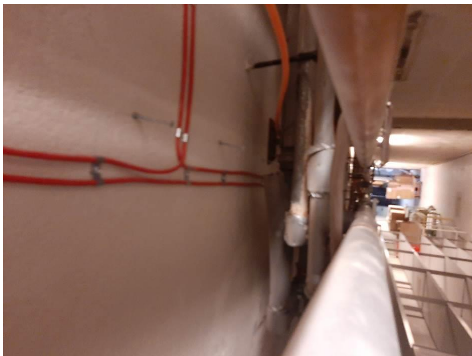
Fot. III.167. Stan techniczny instalacji systemów przeciwpożarowych piwnicy budynku „C” Nieprawidłowe prowadzenie kabli – brak uchwytów.
