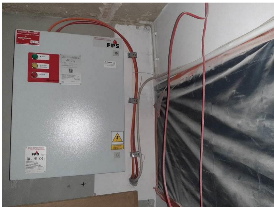
Fot. III.353. System oddymiania. Klatka d. Niedokończona instalacja. Brak urządzeń końcowych. Brak odpowiednich przepustów kablowych.
