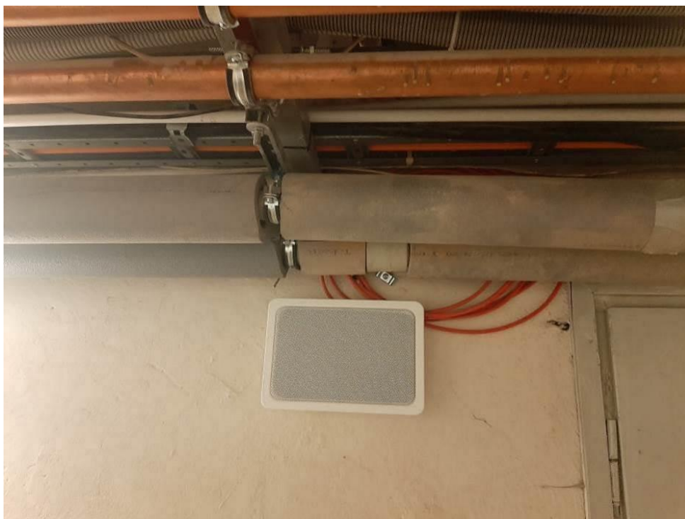
Fot. III.13. Stan techniczny instalacji systemów przeciwpożarowych piwnicy budynku „B” Niepodłączony głośnik DSO. Nieprawidłowe prowadzenie kabli sygnalizacyjnych (czerwone) – brak uchwytów.
