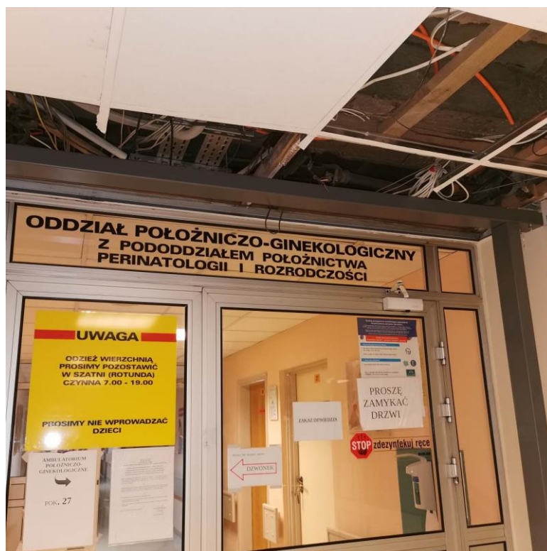
Fot. nr I.89. Ubytki sufitu powodujące swobodną migrację zanieczyszczonego powietrza pomiędzy pomieszczeniami. Brak zamontowanej stolarki drzwiowej -elementu ochrony przeciwpożarowej. BUD.B.
