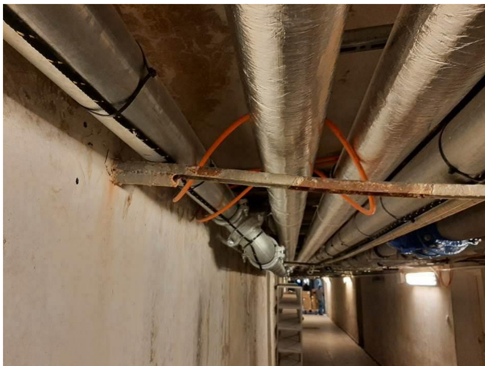
Fot. III.161. Stan techniczny instalacji systemów przeciwpożarowych piwnicy budynku „C” Nieprawidłowe prowadzenie kabli – brak uchwytów.
