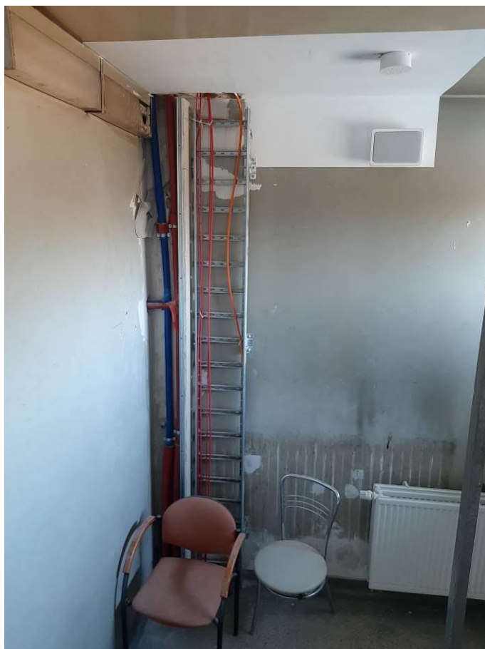
Fot. III.344. System oddymiania. Klatka d. Niedokończona instalacja. Brak odpowiednich przepustów kablowych.
