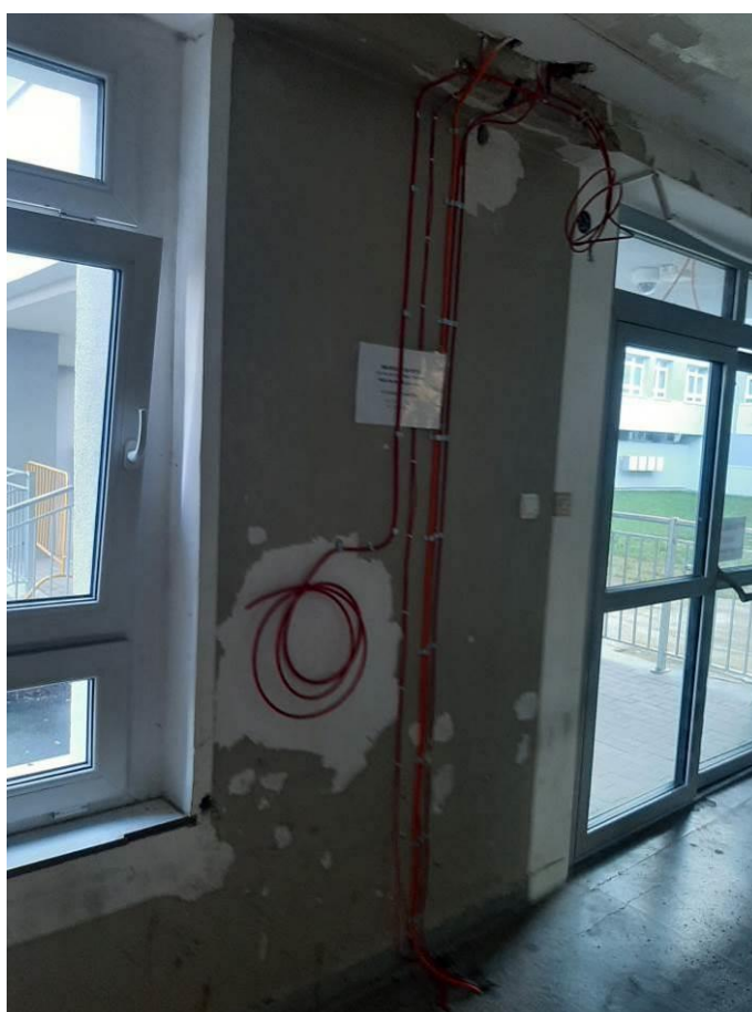
Fot. III.287. System oddymiania. Klatka g. Niedokończona instalacja. Brak urządzeń końcowych. Brak odpowiednich przepustów kablowych.
