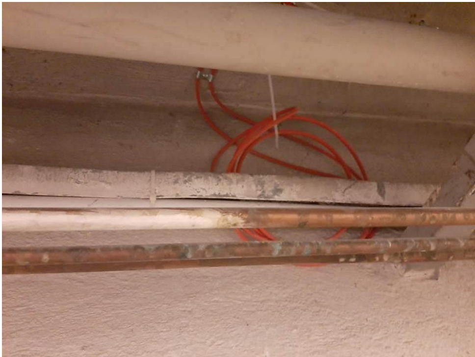
Fot.III.57. Stan techniczny instalacji systemów przeciwpożarowych piwnicy łącznika „IV” Nieprawidłowe prowadzenie kabli zasilających (pomarańczowe) – brak uchwytów.
