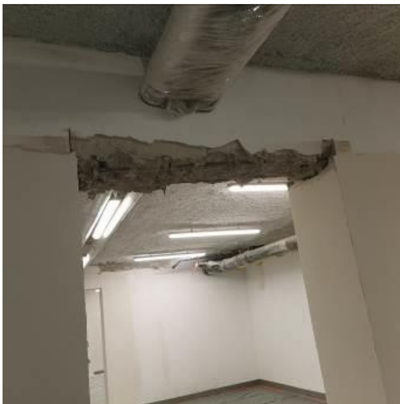
Fot. nr I.7. Widok wadliwie wykonanego otworu w ścianie konstrukcyjnej. BUD.D.
