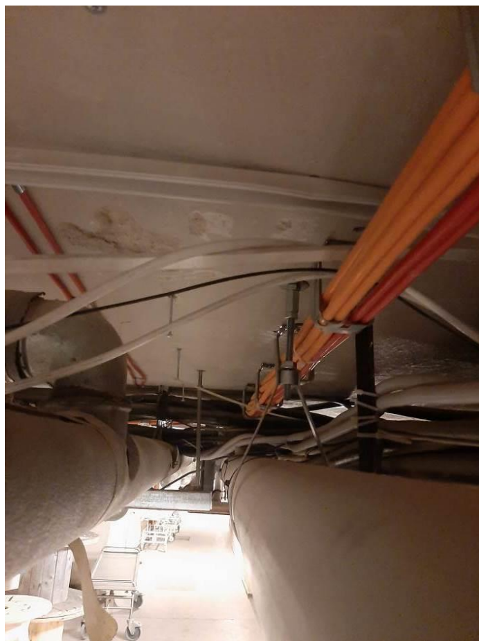
Fot. III.145. Stan techniczny instalacji systemów przeciwpożarowych piwnicy budynku „C” Nieprawidłowe prowadzenie kabli – kable sygnalizacyjne razem z zasilającymi.
