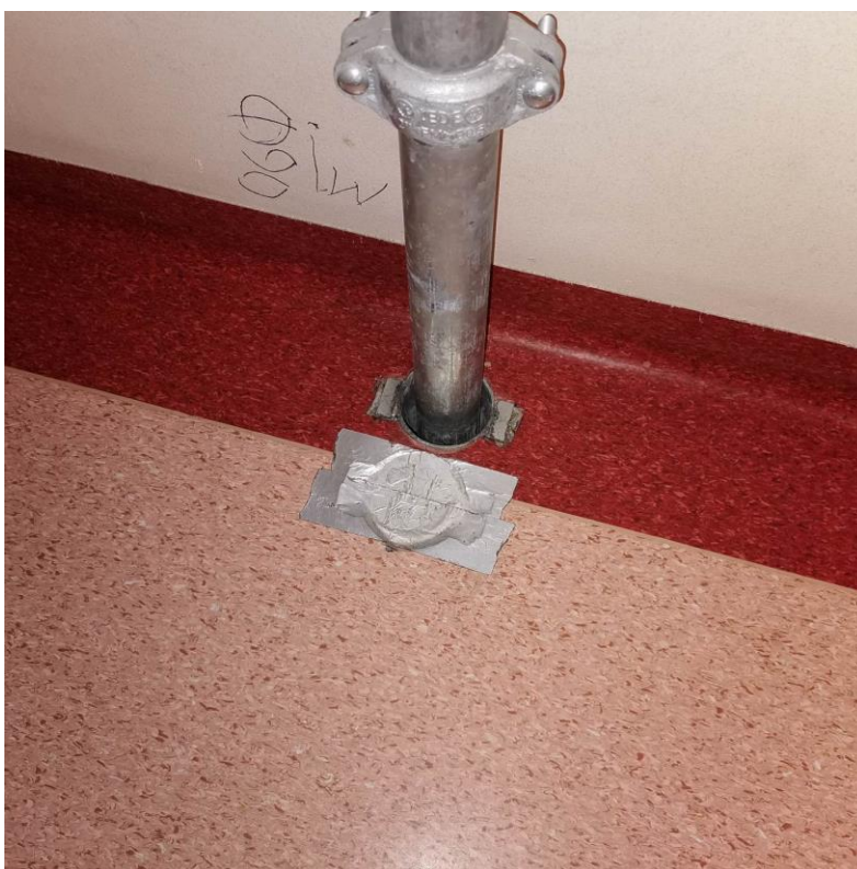
Fot. nr I.96. Uszkodzona posadzka podczas robót instalacyjnych. BUD.B.
