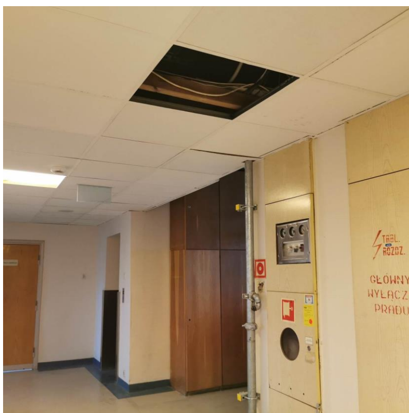
Fot. nr I.112. Ubytki sufitu powodujące swobodną migrację zanieczyszczonego powietrza pomiędzy pomieszczeniami. Pion instalacji hydrantowej utrudniający komunikację na korytarzu. BUD.D.
