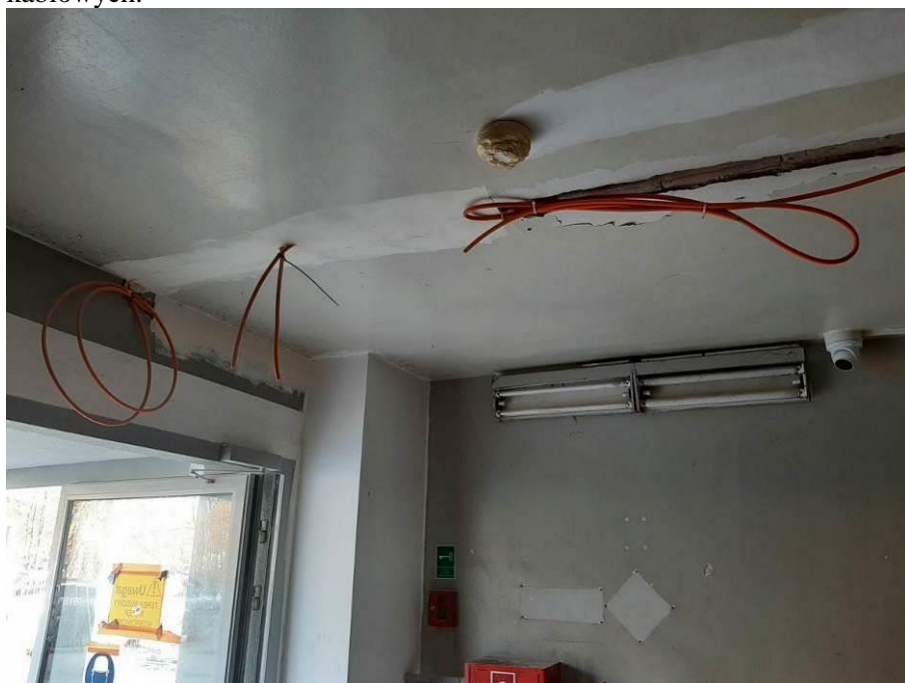
Fot. III.349. System oddymiania. Klatka d. Niedokończona instalacja. Brak urządzeń końcowych. Brak odpowiednich przepustów kablowych.
