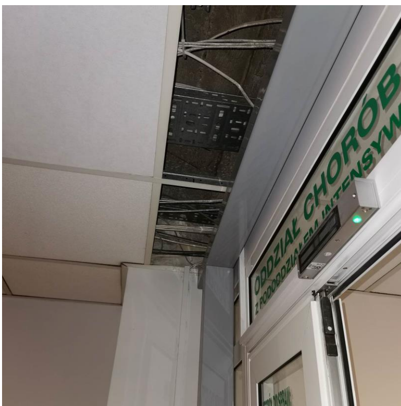
Fot. nr I.102. Ubytki sufitu powodujące swobodną migrację zanieczyszczonego powietrza pomiędzy pomieszczeniami. Brak zamontowanej stolarki drzwiowej – elementu ochrony przeciwpożarowej na granicy stref pożarowych. BUD.B.
