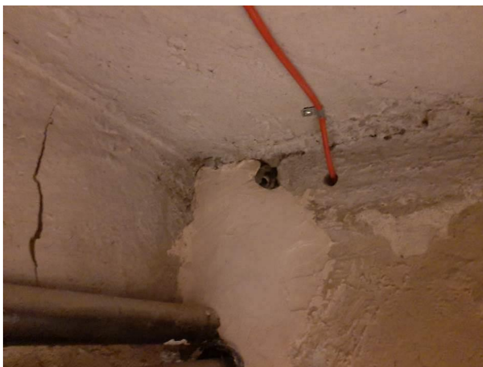
Fot. III.102. Stan techniczny instalacji systemów przeciwpożarowych piwnicy budynku „C” Nieprawidłowe prowadzenie kabli – brak odpowiedniego przepustu kablowego.
