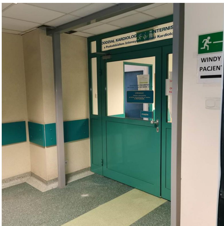
Fot. nr I.97. Brak zamontowanej stolarki drzwiowej – elementu ochrony przeciwpożarowej. BUD.B.
