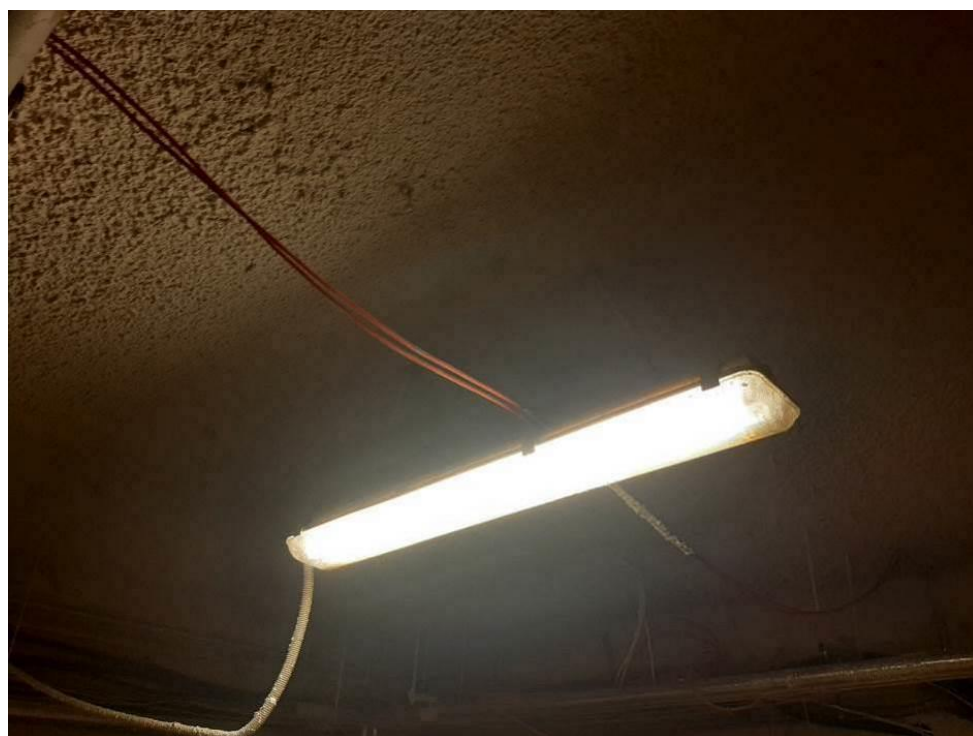
Fot. III.86. Stan techniczny instalacji systemów przeciwpożarowych piwnicy budynku „C” Nieprawidłowe prowadzenie kabli sygnalizacyjnych (czerwone) – brak uchwytów.
