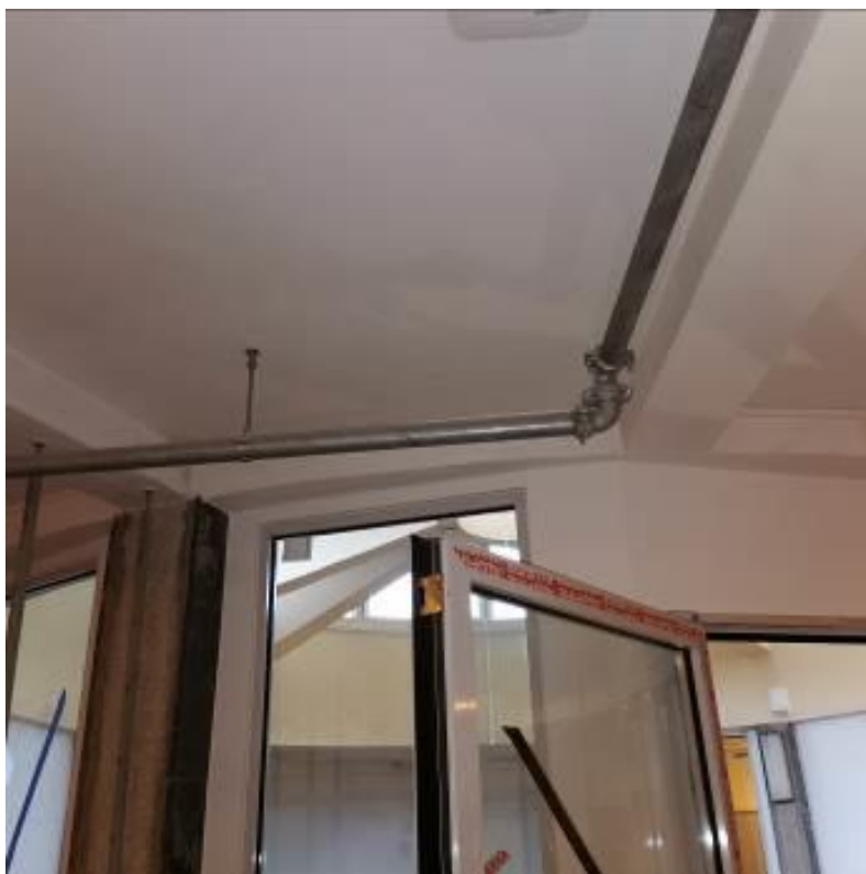
Fot. nr I.41. Instalacja hydrantowa zamontowana w strefie narażonej na działanie ognia. BUD.B.
