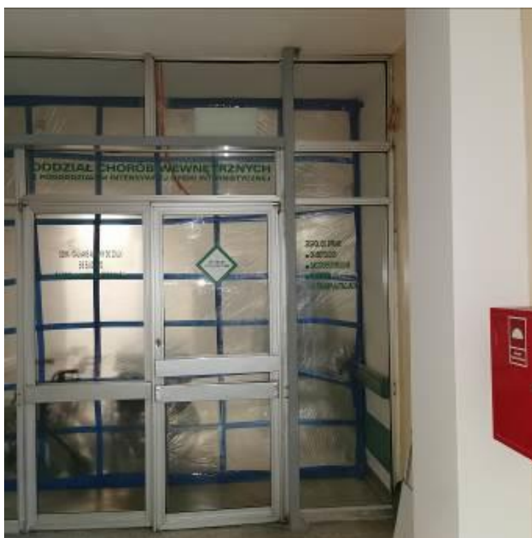
Fot. nr I.32. Zamocowana konstrukcja stalowa na potrzeby wymiany drzwi zgodnie z wytycznymi ekspertyzy przeciwpożarowej. Brak właściwych drzwi p. poż. BUD.B.
