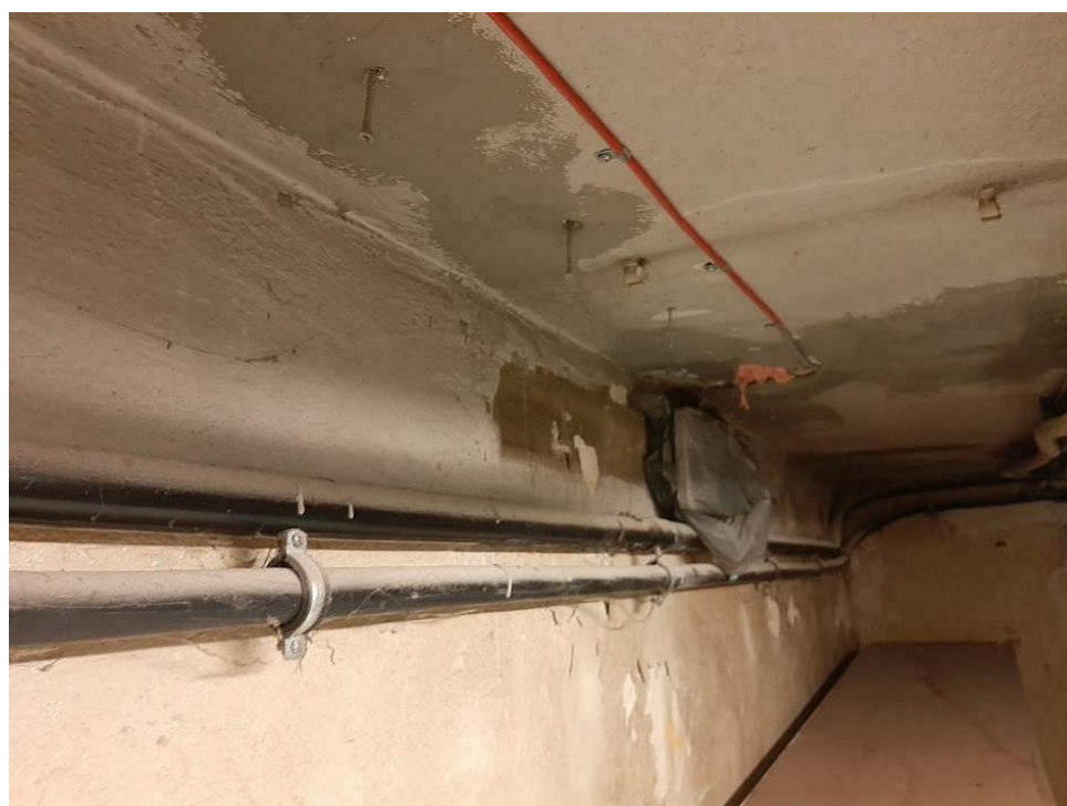
Fot. III.104. Stan techniczny instalacji systemów przeciwpożarowych piwnicy budynku „C” Nieprawidłowe prowadzenie kabli – brak odpowiedniego przepustu kablowego.
