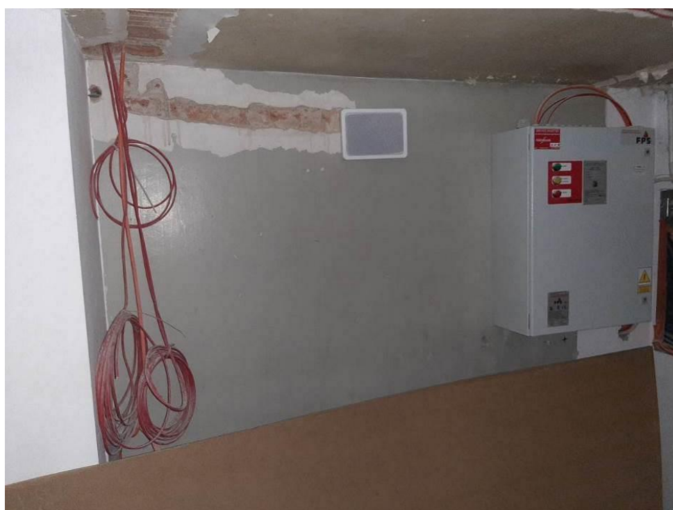
Fot. III.351. System oddymiania. Klatka d. Niedokończona instalacja. Brak urządzeń końcowych. Brak odpowiednich przepustów kablowych.
