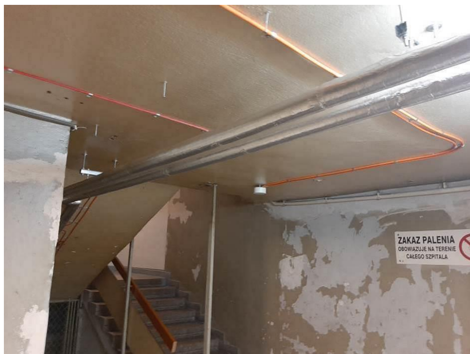
Fot. III.120. Stan techniczny instalacji systemów przeciwpożarowych piwnicy budynku „C” Prawidłowe prowadzenie instalacji.
