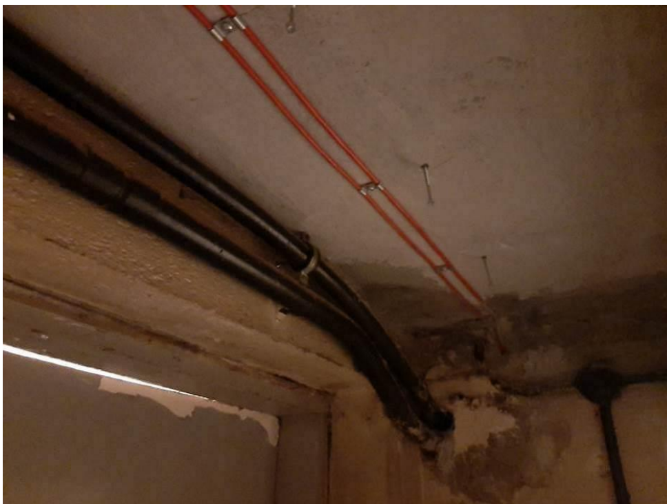
Fot. III.96. Stan techniczny instalacji systemów przeciwpożarowych piwnicy budynku „C” Nieprawidłowe prowadzenie kabli sygnalizacyjnych (czerwone) – brak odpowiedniego przepustu kablowego.
