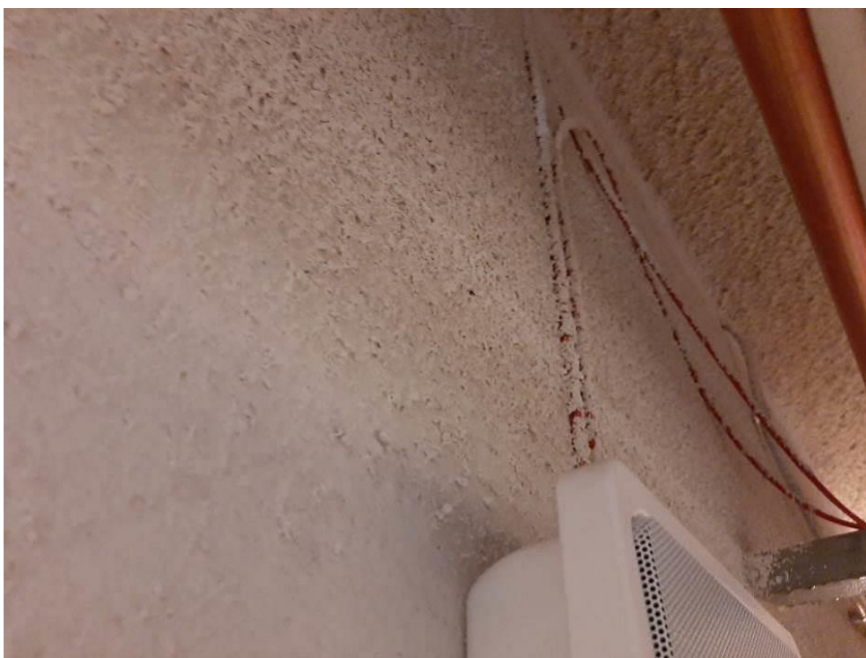
Fot. III.74. Stan techniczny instalacji systemów przeciwpożarowych piwnicy budynku „C” Nieprawidłowe prowadzenie kabli sygnalizacyjnych (czerwone) – brak uchwytów.
