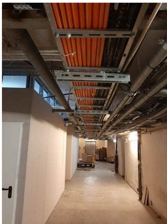
Fot.III.66. Stan techniczny instalacji systemów przeciwpożarowych piwnicy łącznika „IV” Nieprawidłowe prowadzenie kabli zasilających (pomarańczowe) – razem z innymi instalacjami.
