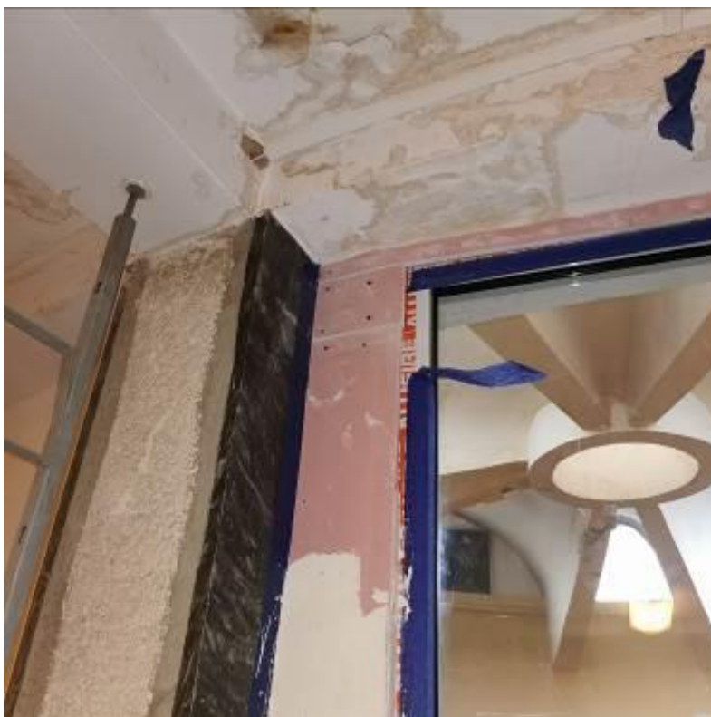
Fot. nr I.45. Brak wykonania budowlanych robót wykończeniowych. BUD.A.
