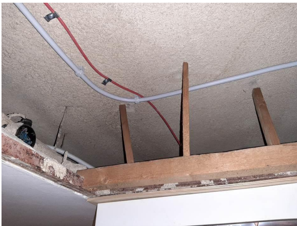
Fot. III.236. System detekcji ciepła LISTEC. Budynek „B” parter. Prawidłowo wykonana instalacja.
