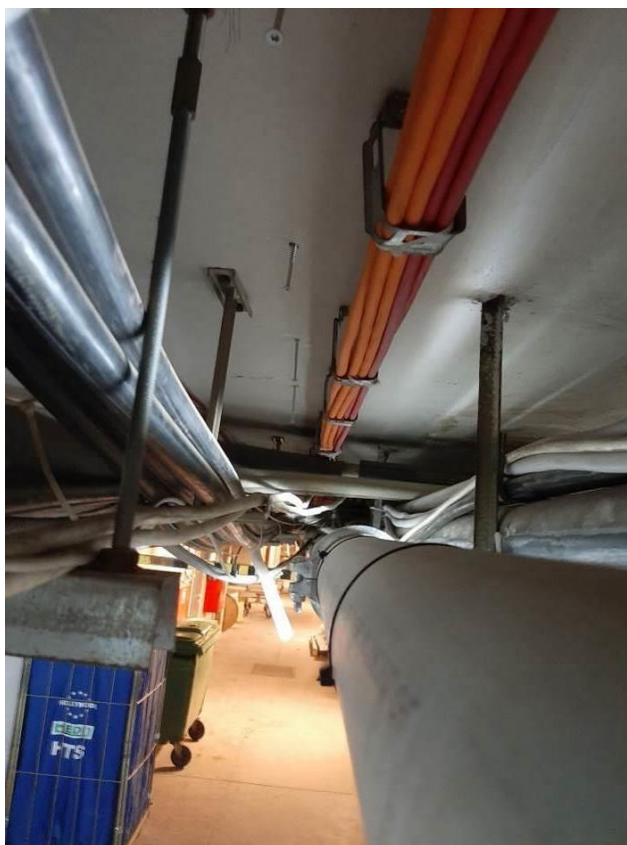
Fot. III.137. Stan techniczny instalacji systemów przeciwpożarowych piwnicy budynku „C” Poprawne ułożenie instalacji.
