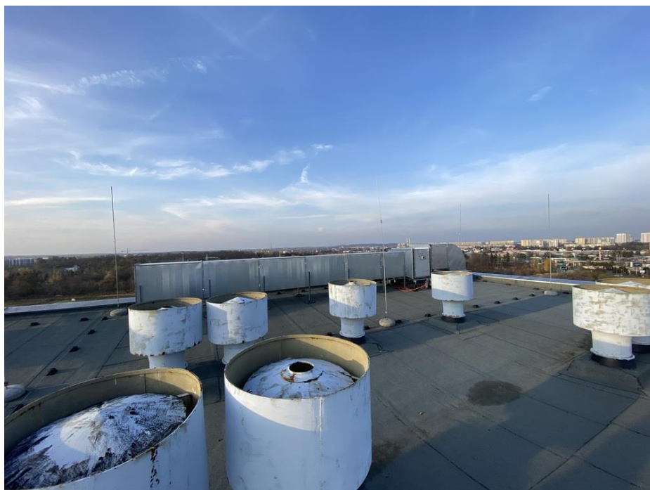
Fot. II.3. Dach budynku Łózkowego C - Wykonana instalacja oddymiania nie jest zgodna z projektem budowlanym. Brak projektu wykonawczego. Zmiany w prowadzeniu tras przewodów w stosunku do dokumentacji pierwotnej - budowlanej.
