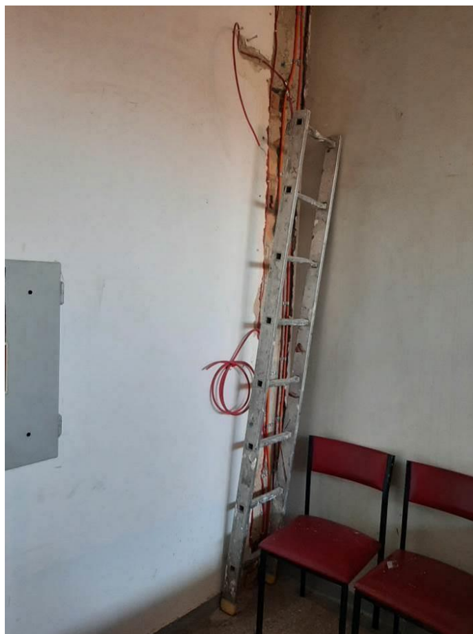
Fot. III.255. System oddymiania. Klatka h. Niedokończona instalacja. Brak urządzeń końcowych.
