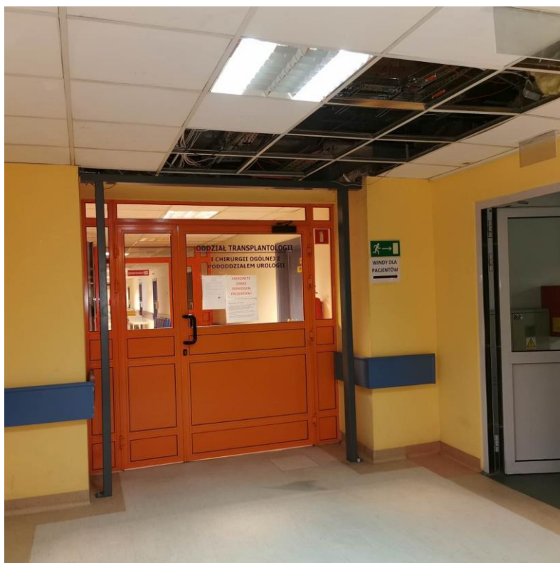
Fot. nr I.84. Ubytki elementów sufitu podwieszonego oraz brak zamontowania drzwi p. pożarowych. BUD.C.
