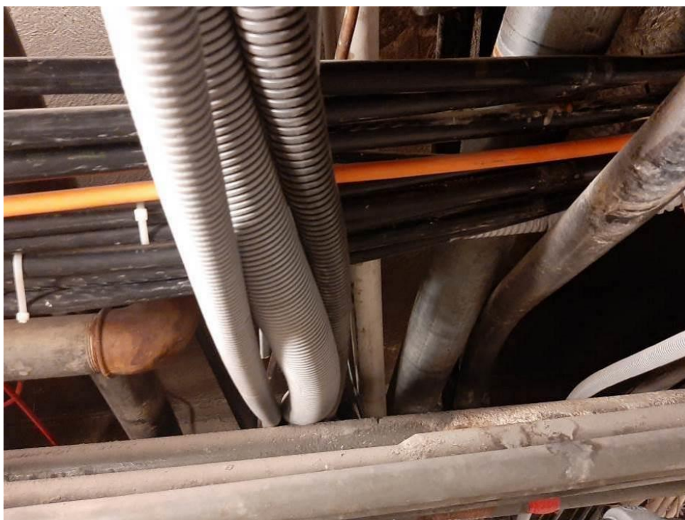
Fot. III.36. Stan techniczny instalacji systemów przeciwpożarowych piwnicy budynku „B” Nieprawidłowe prowadzenie kabli zasilających (pomarańczowe) – niezachowana odległość od innych instalacji. Nieprawidłowe prowadzenie kabli sygnalizacyjnych (czerwone) – brak uchwytów.
