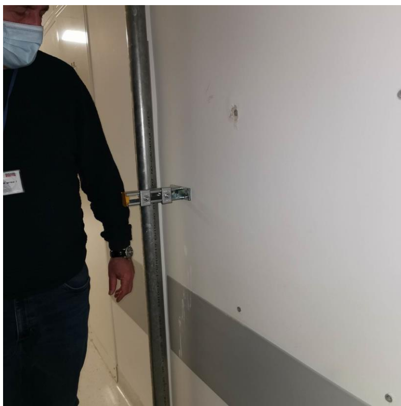
Fot. nr I.62. Lokalizacja pionu wodociągowego kolidująca z bezpiecznym korzystaniem z komunikacji. BUD.D.
