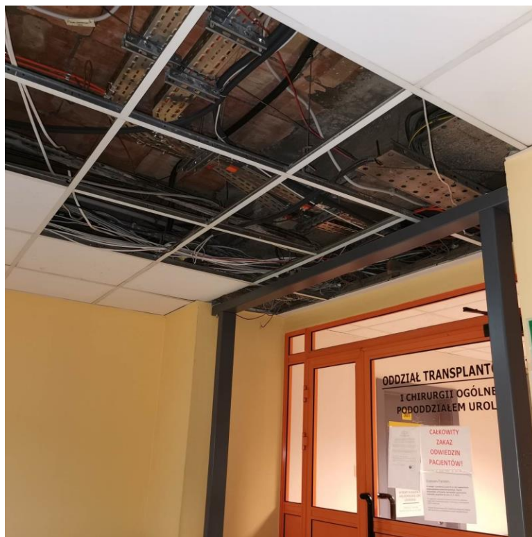
Fot. nr I.87. Ubytki sufitu powodujące swobodną migrację zanieczyszczonego powietrza pomiędzy pomieszczeniami. Brak zamontowanej stolarki drzwiowej – elementu ochrony przeciwpożarowej. BUD.C.
