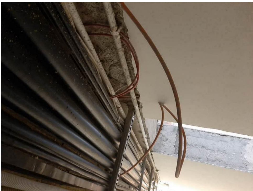
Fot. III.177. Stan techniczny instalacji systemów przeciwpożarowych piwnicy budynku „C” Nieprawidłowe prowadzenie kabli – brak uchwytów.
