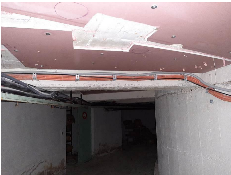
Fot. III.208. Stan techniczny instalacji systemów przeciwpożarowych piwnicy rotundy Prawidłowe prowadzenie instalacji. Brak wyposażenia systemu SSP.
