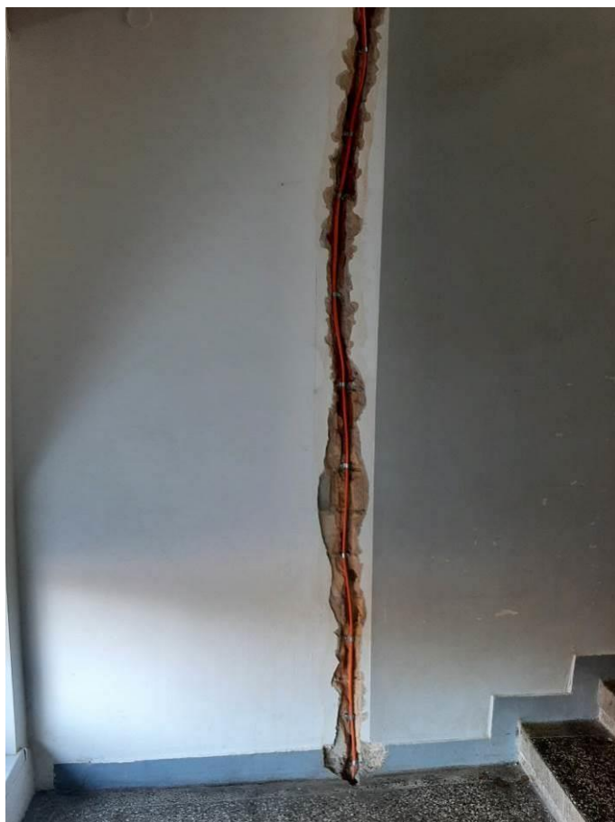
Fot. III.264. System oddymiania. Klatka h. Niedokończona instalacja.
