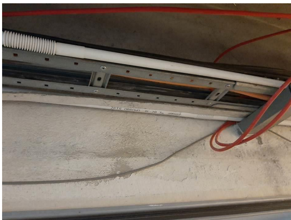
Fot. III.20. Stan techniczny instalacji systemów przeciwpożarowych piwnicy budynku „B” Nieprawidłowe prowadzenie kabli sygnalizacyjnych (czerwone) – brak uchwytów.
