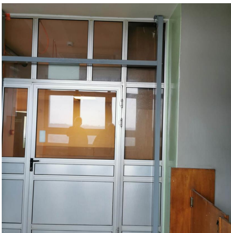
Fot. nr I.108. Brak wymiany drzwi – elementu ochrony przeciwpożarowej. BUD.B.
