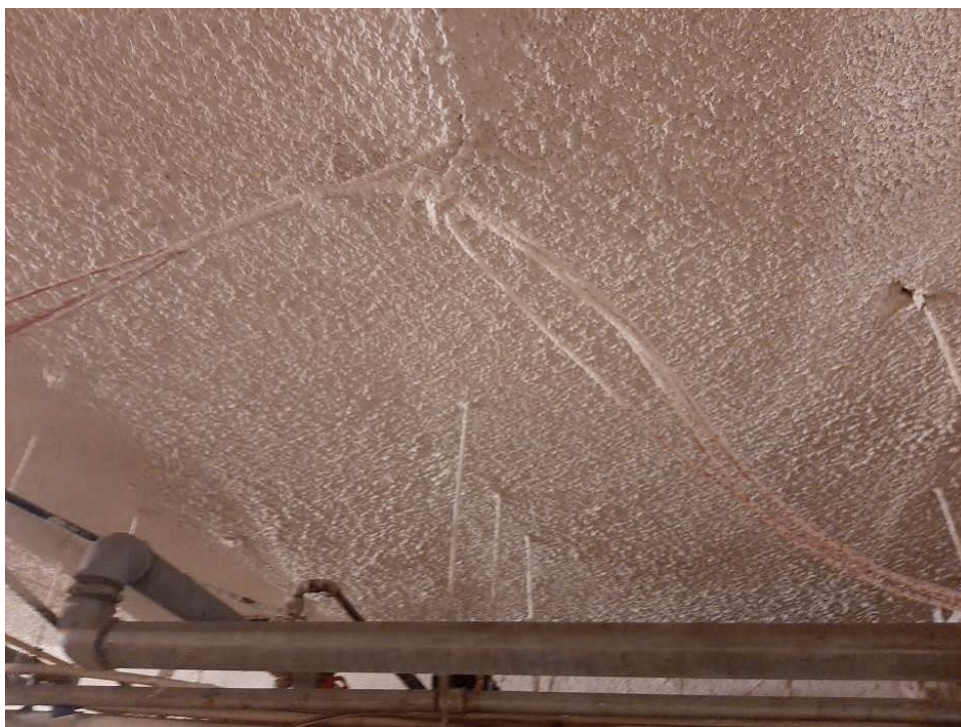
Fot. III.76. Stan techniczny instalacji systemów przeciwpożarowych piwnicy budynku „C” Nieprawidłowe prowadzenie kabli sygnalizacyjnych (czerwone) – brak uchwytów.
