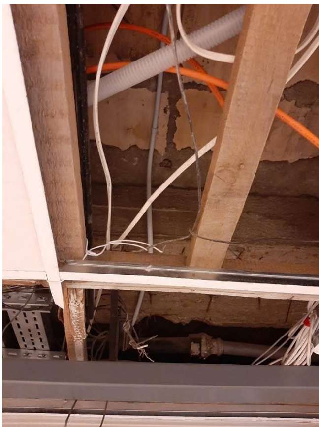
Fot. III.227. System detekcji ciepła LISTEC. Budynek „C”. Brak uchwytyów kablowych.
