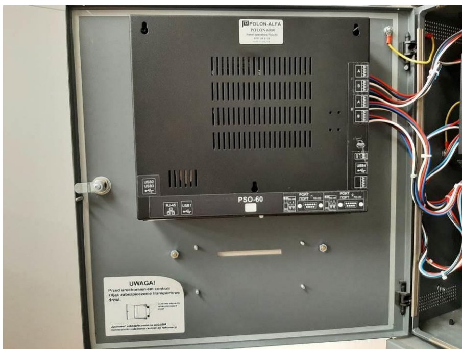
Fot. III.378. Pomieszczenie techniczne. Szafa systemu sygnalizacji pożaru.
