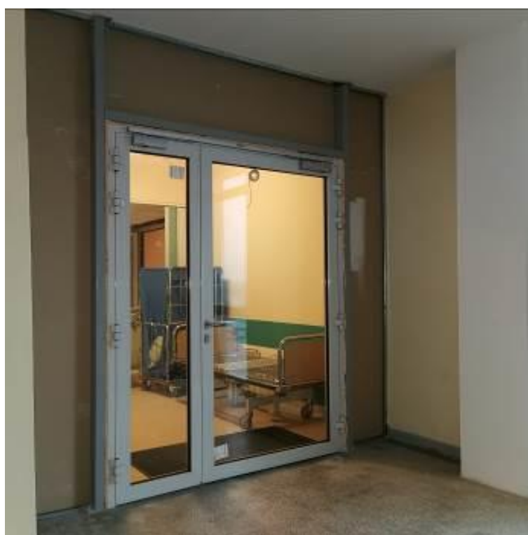
Fot. nr I.36. Brak robót wykończeniowych w miejscu powstania ściany oddzielającej strefy pożarowe. BUD.B.
