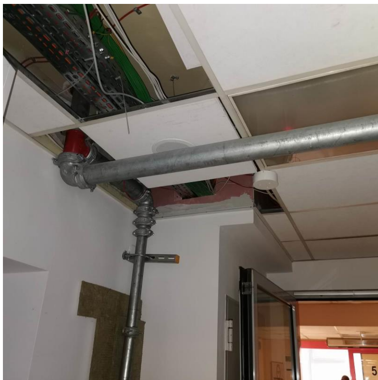
Fot. nr I.67. Brak zabudowy instalacji hydrantowej i uzupełnienia sufitu podwieszonego powoduje migrację zanieczyszczonego powietrza. BUD.C.
