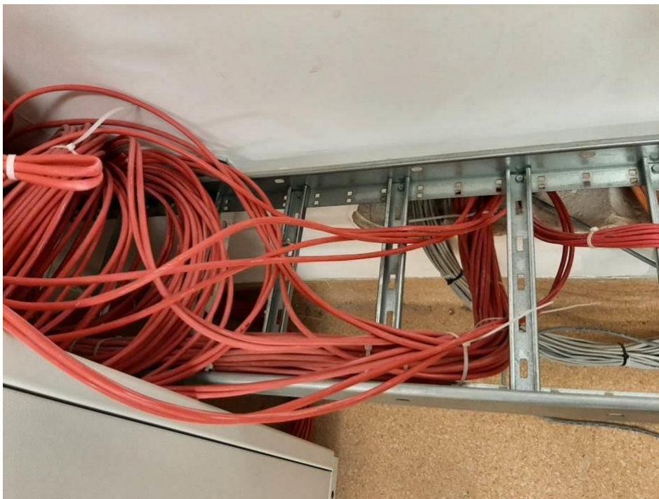
Fot. III.365. Pomieszczenie techniczne. Okablowanie DSO. Niedokończona instalacja.
