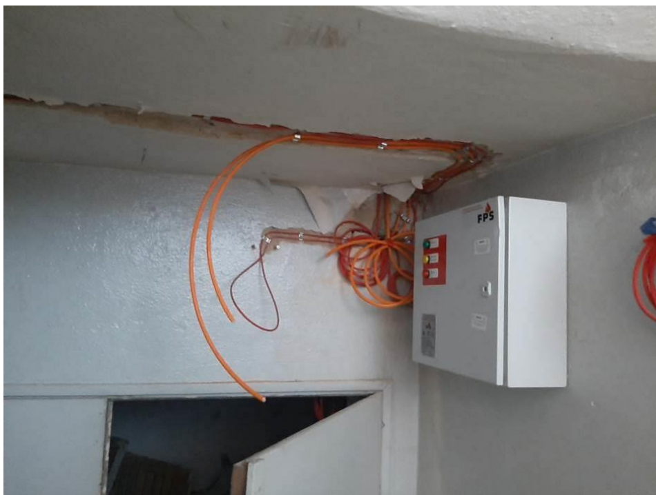
Fot. III.270. System oddymiania. Klatka h. Niedokończona instalacja. Brak urządzeń końcowych.
