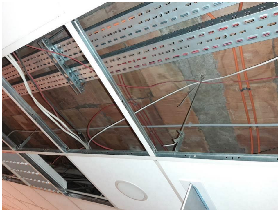
Fot. III.231. System detekcji ciepła LISTEC. Budynek „C”. Brak uchwytów kablowych.
