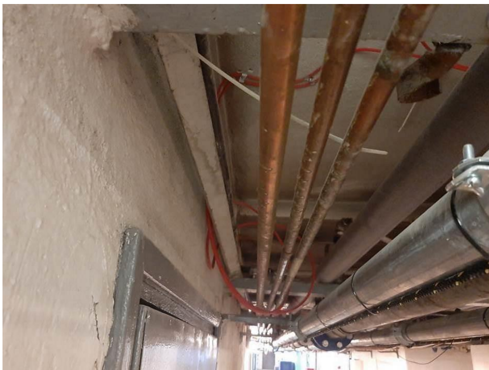
Fot.III.45. Stan techniczny instalacji systemów przeciwpożarowych piwnicy budynku „B” Nieprawidłowe prowadzenie kabli sygnalizacyjnych (czerwone) – brak uchwytów.
