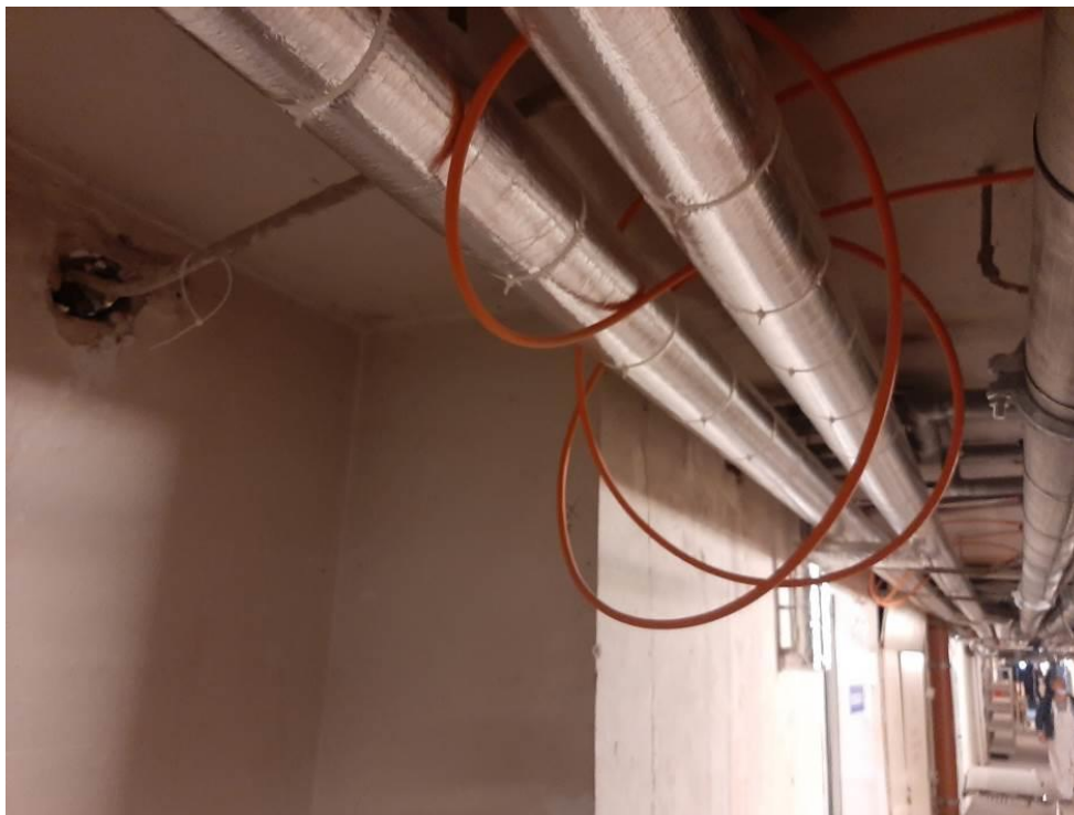
Fot. III.152. Stan techniczny instalacji systemów przeciwpożarowych piwnicy budynku „C” Nieprawidłowe prowadzenie kabli – brak uchwytów.
