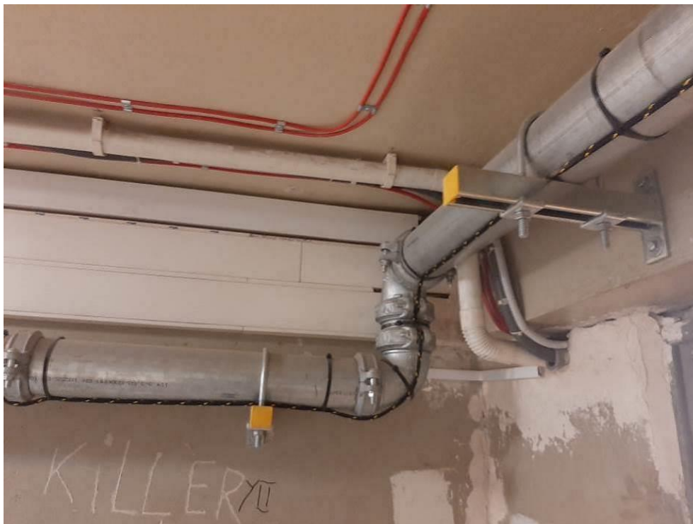
Fot. III.118. Stan techniczny instalacji systemów przeciwpożarowych piwnicy budynku „C” Prawidłowe prowadzenie instalacji. Brak odpowiedniego przepustu kablowego.
