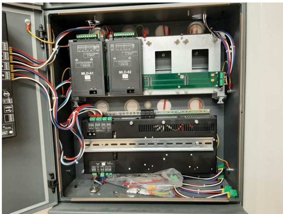
Fot.III.377. Pomieszczenie techniczne. Szafa systemu sygnalizacji pożaru. Niekompletne wyposażenie szafy.
