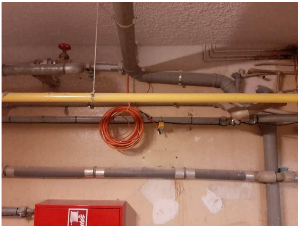
Fot.III.93. Stan techniczny instalacji systemów przeciwpożarowych piwnicy budynku „C” Nieprawidłowe prowadzenie kabli zasilających (pomarańczowe) – brak uchwytów, brak urządzenia końcowego.
