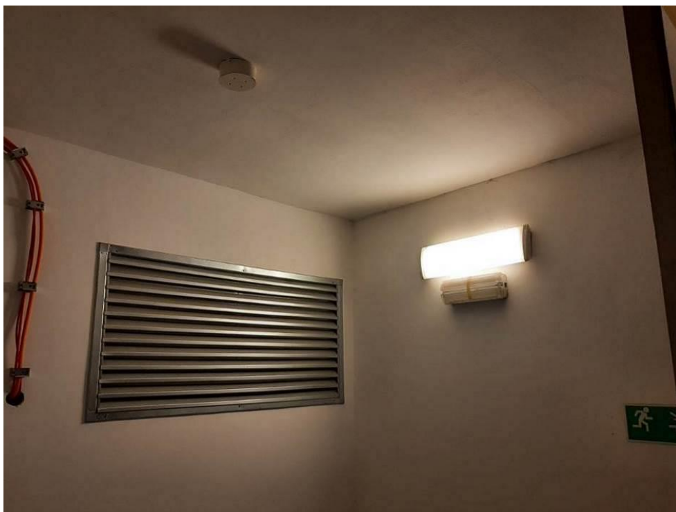
Fot. III.309. System oddymiania. Klatka a. Brak odpowiednich przepustów kablowych.
