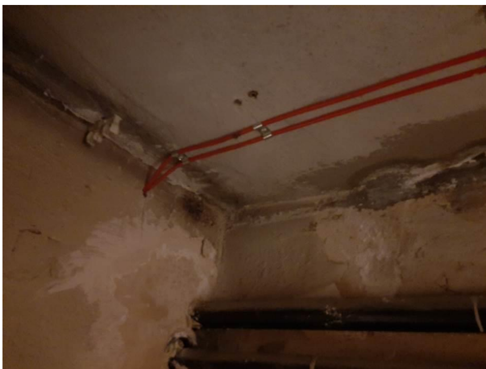
Fot. III.100. Stan techniczny instalacji systemów przeciwpożarowych piwnicy budynku „C” Nieprawidłowe prowadzenie kabli – brak odpowiedniego przepustu kablowego.
