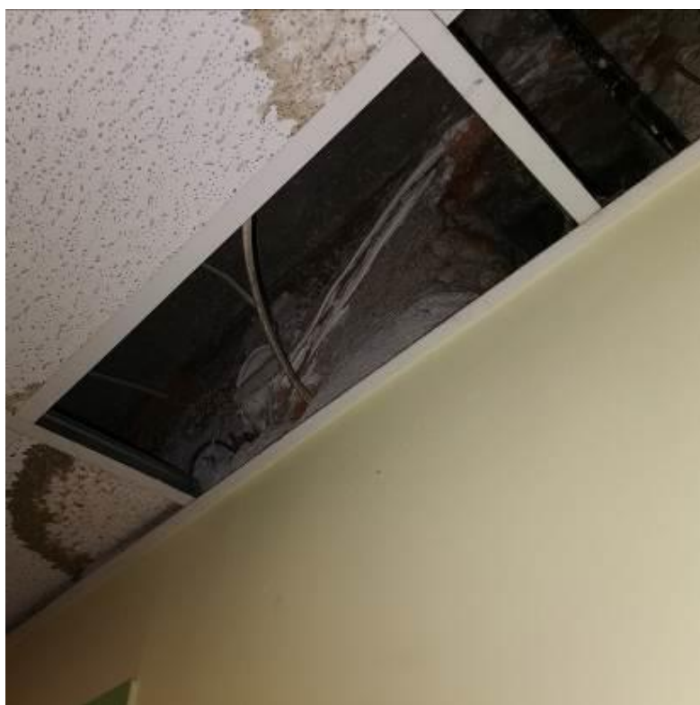
Fot. nr I.12. Brak uzupełnienia sufitu podwieszonego po realizacji prac w przestrzeni podstropowej. Miejsce swobodnego przepływu zanieczyszczonego powietrza pomiędzy pomieszczeniami. BUD.D.
