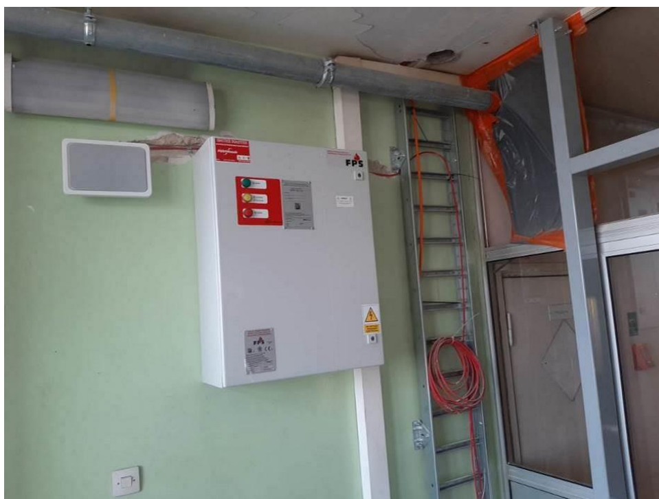
Fot. III.294. System oddymiania. Klatka a. Niedokończona instalacja. Brak urządzeń końcowych. Brak odpowiednich przepustów kablowych.
