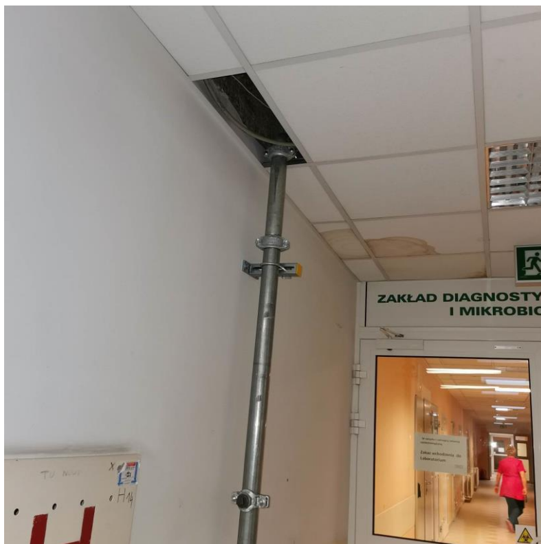
Fot. nr I.73. Brak zabudowy instalacji hydrantowej powoduje trudności w utrzymaniu warunków higienicznych. BUD.C.
