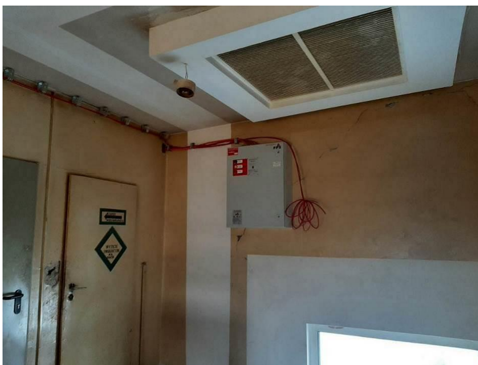
Fot. III.312. System oddymiania. Klatka c. Niedokończona instalacja. Brak urządzeń końcowych.
