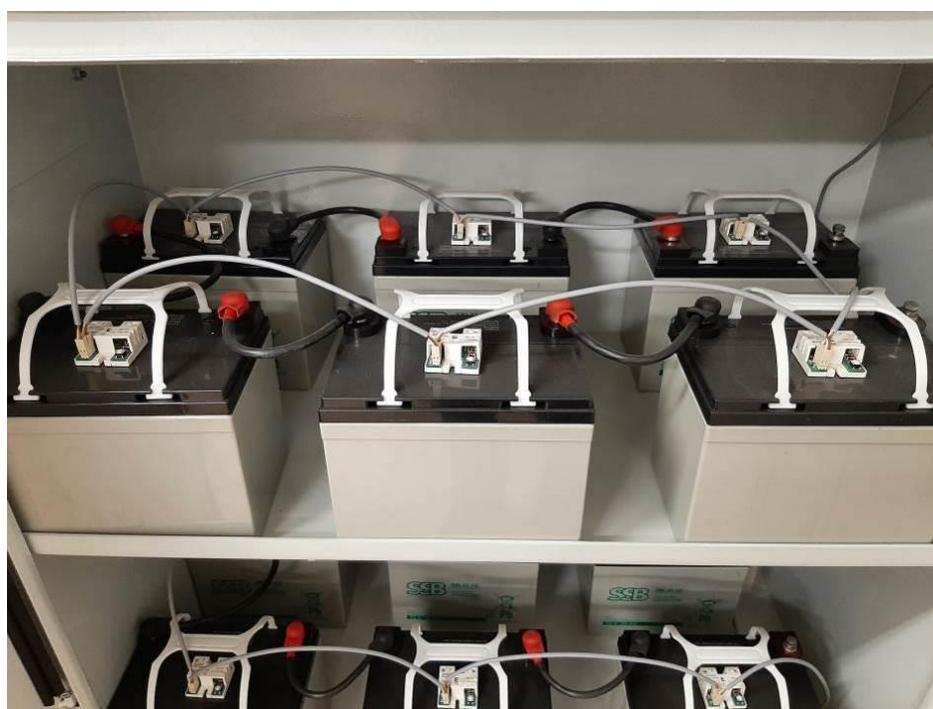
Fot.III.388. Pomieszczenie techniczne. Szafa systemu centralnej baterii. Niepodłączone akumulatory buforowe.
