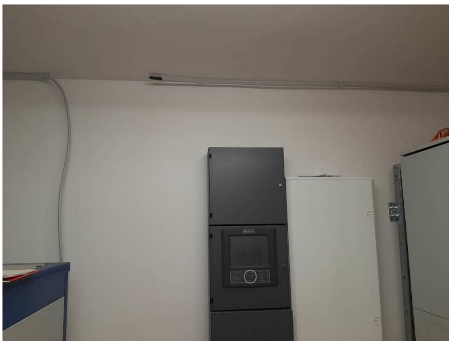
Fot. III.405. Pomieszczenie techniczne. Instalacja liniowej czujki ciepła. Prawidłowo ułożona instalacja
