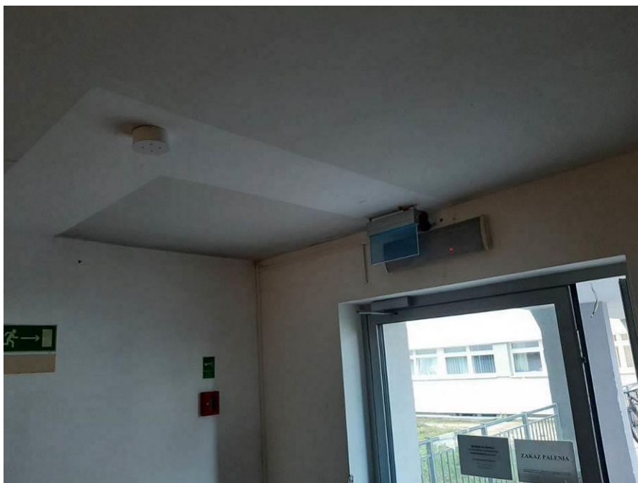
Fot. III.329. System oddymiania. Klatka c. Brak odpowiednich przepustów kablowych.
