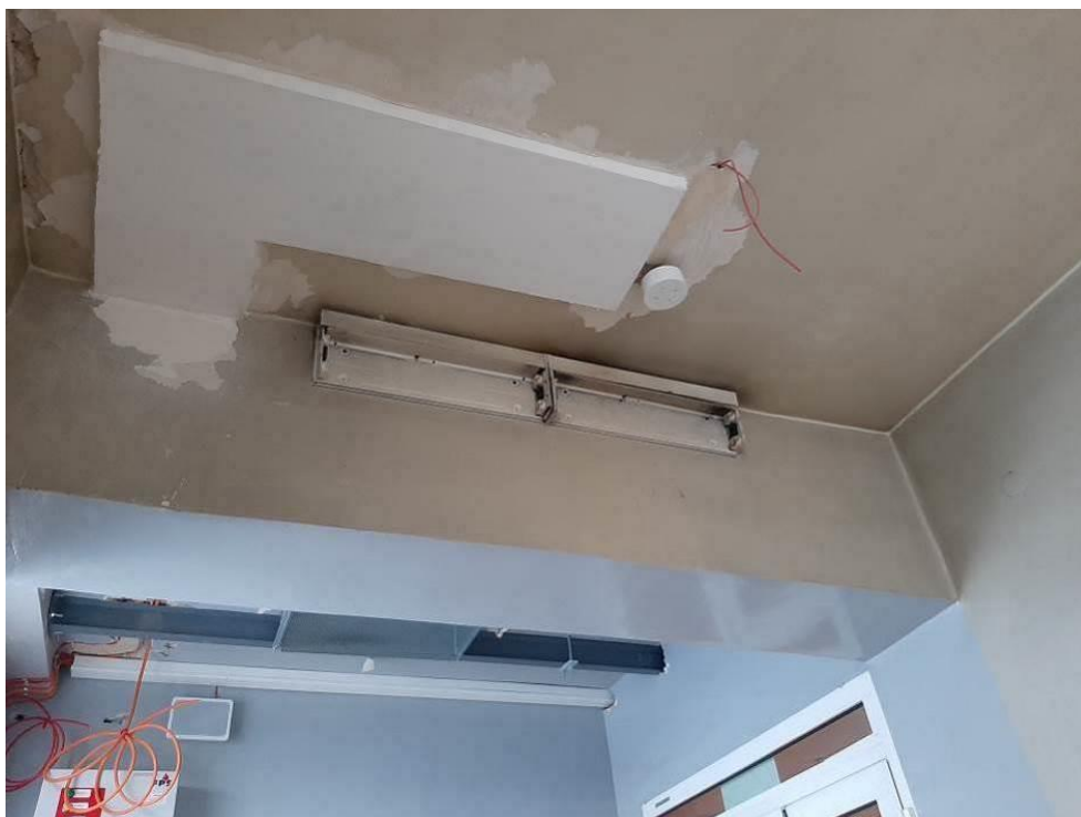
Fot. III.280. System oddymiania. Klatka g. Niedokończona instalacja. Brak urządzeń końcowych.
