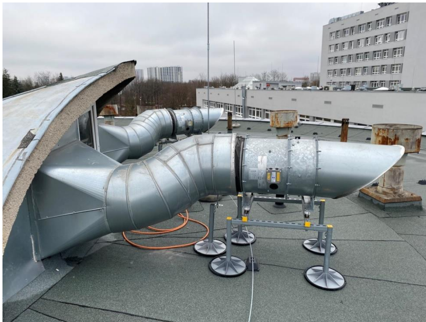
Fot. II.10. Dach Rotundy budynek A - Niepodłączone wentylatory oddymniające. Nie zweryfikowano głośności urządzeń i nie ma informacji o tłumieniu drgań. Czy zastosowane przekładki amortyzujące są wystarczające.
