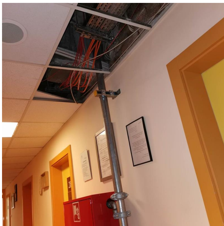
Fot. nr I.70. Brak zabudowy instalacji hydrantowej i uzupełnienia sufitu podwieszonego powoduje migrację zanieczyszczonego powietrza. BUD.C.
