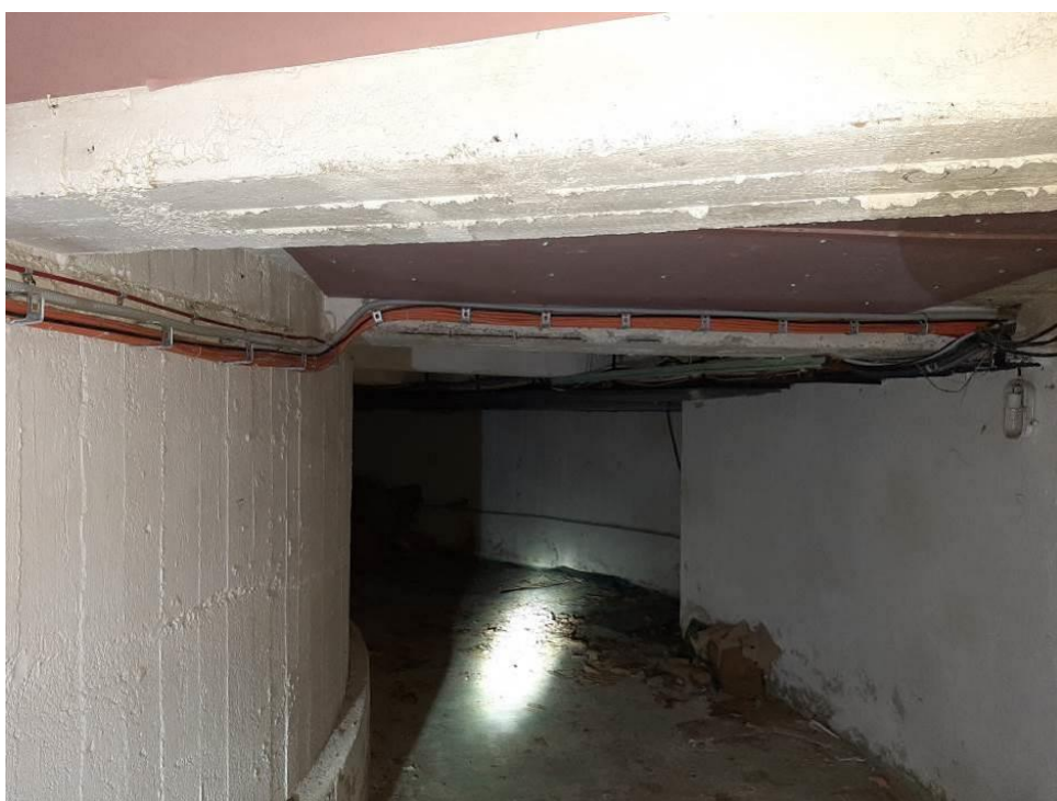
Fot. III.214. Stan techniczny instalacji systemów przeciwpożarowych piwnicy rotundy Prawidłowe prowadzenie instalacji. Brak wyposażenia systemu SSP.
