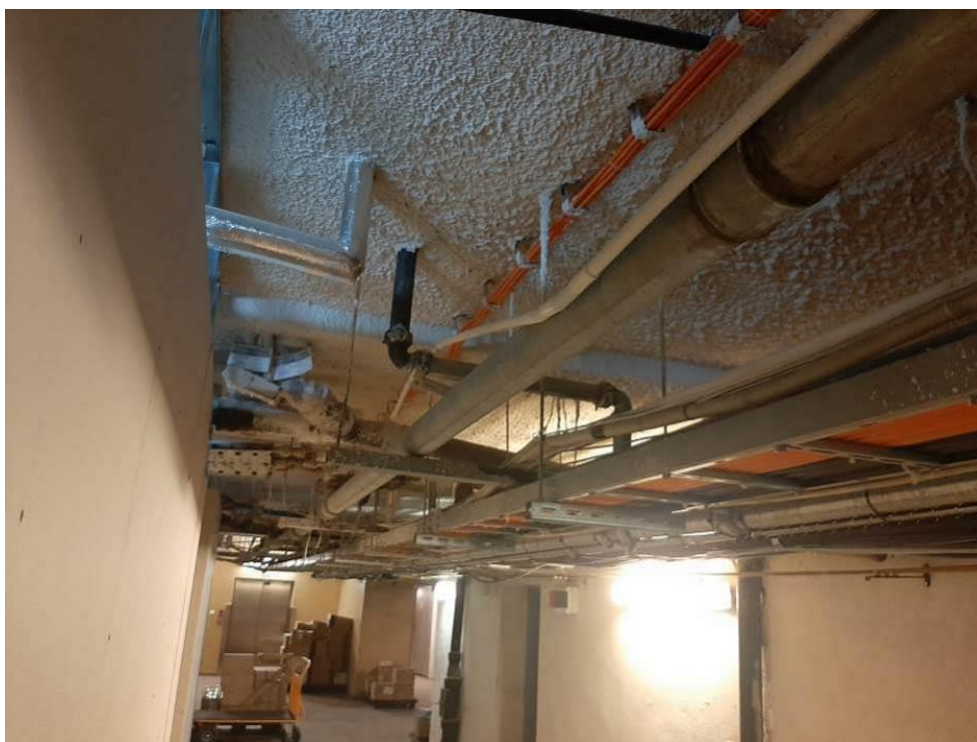
Fot. III.70. Stan techniczny instalacji systemów przeciwpożarowych piwnicy budynku „C” Nieprawidłowe prowadzenie kabli zasilających (pomarańczowe) – razem z innymi instalacjami.
