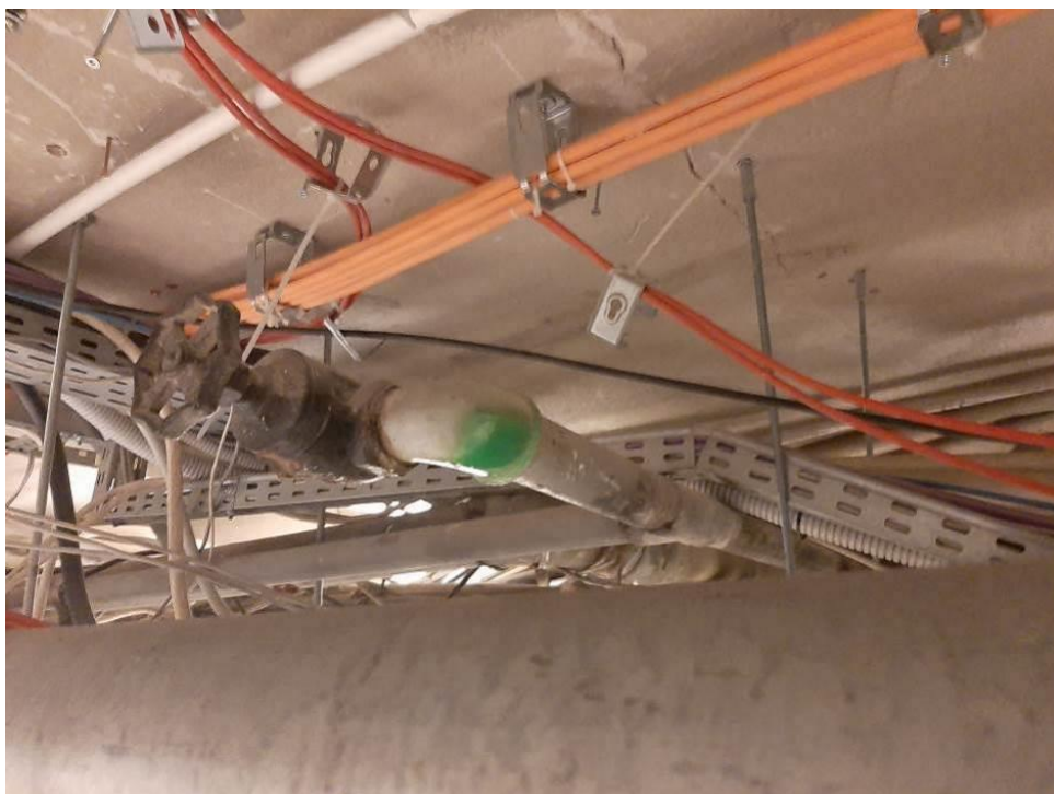
Fot. III.59. Stan techniczny instalacji systemów przeciwpożarowych piwnicy łącznika „IV” Nieprawidłowe prowadzenie kabli zasilających (pomarańczowe) – skrzyżowanie z innymi instalacjami. Nieprawidłowe prowadzenie kabli sygnalizacyjnych (czerwone) – uchwyty nieprzykręcone do podłoża.
