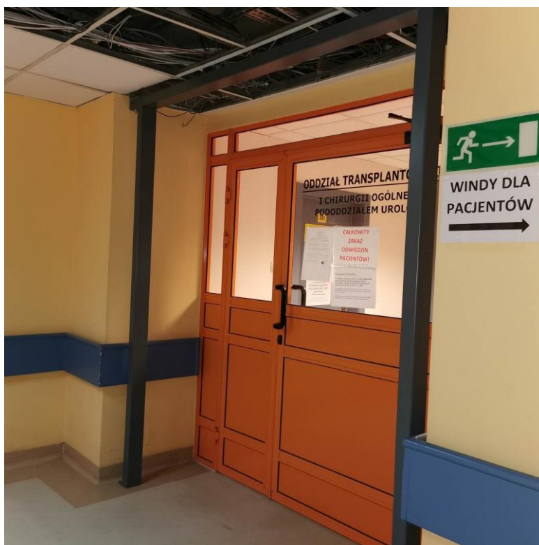
Fot. nr I.86. Ubytki sufitu powodujące swobodną migrację zanieczyszczonego powietrza pomiędzy pomieszczeniami. BUD.C.
