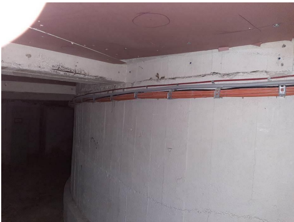
Fot. III.212. Stan techniczny instalacji systemów przeciwpożarowych piwnicy rotundy Prawidłowe prowadzenie instalacji. Brak wyposażenia systemu SSP.
