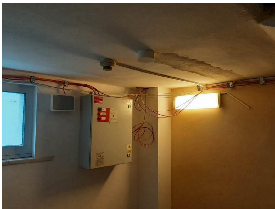
Fot. III.330. System oddymiania. Klatka c. Niedokończona instalacja. Brak odpowiednich przepustów kablowych.
