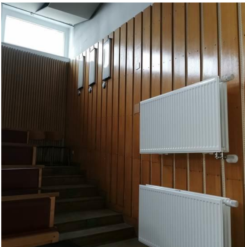
Fot. nr I.52. Brak usunięcia łatwopalnych elementów okładzin ściennych z wnętrza pomieszczenia Sali wykładowej. BUD.A.
