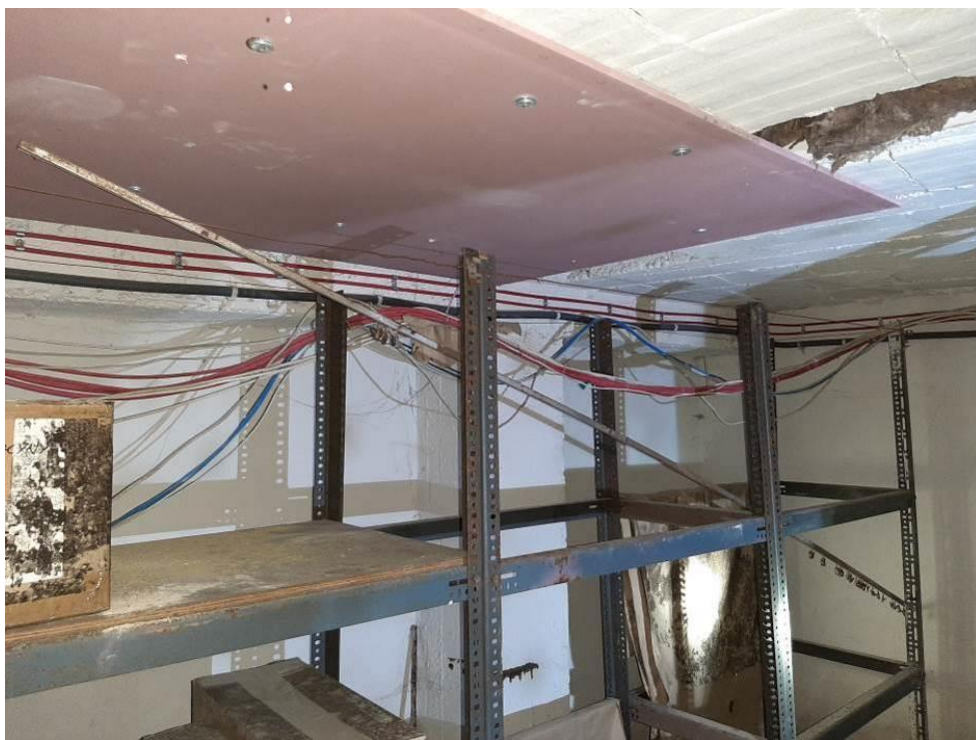
Fot. III.211. Stan techniczny instalacji systemów przeciwpożarowych piwnicy rotundy Brak uchwytów kablowych.
