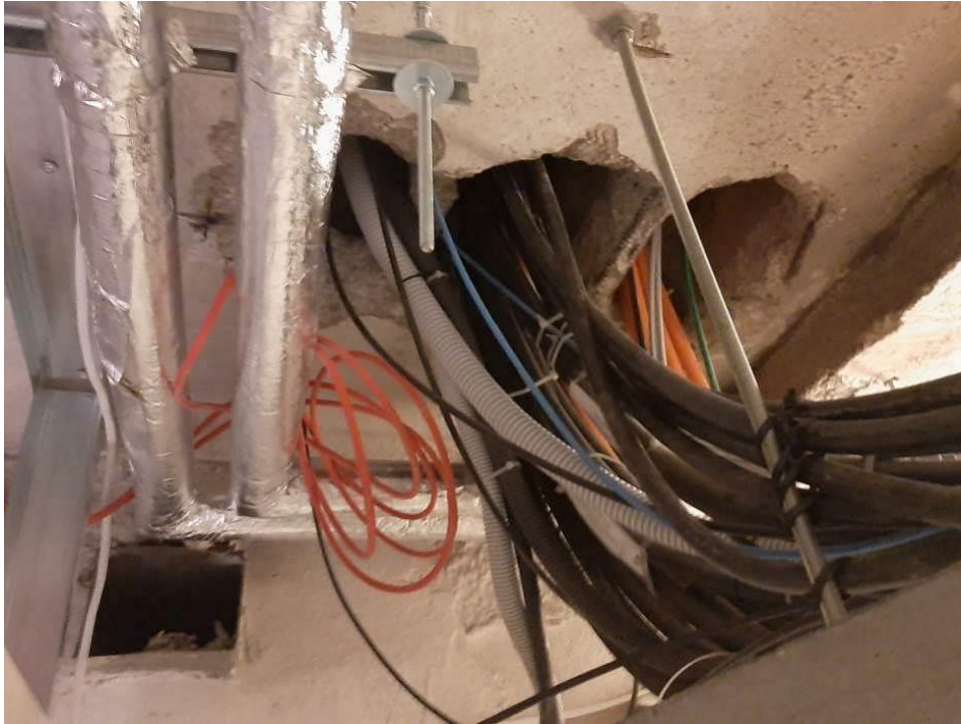
Fot. III.49. Stan techniczny instalacji systemów przeciwpożarowych piwnicy budynku „B” Nieprawidłowe prowadzenie kabli zasilających (pomarańczowe) – razem z innymi instalacjami. Nieprawidłowe prowadzenie kabli sygnalizacyjnych (czerwone) – brak uchwytów. Brak odpowiedniego przepustu kablowego.
