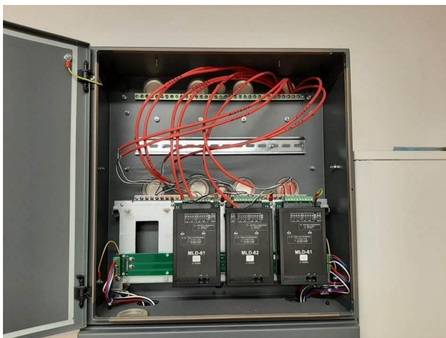
Fot. III.376. Pomieszczenie techniczne. Szafa systemu sygnalizacji pożaru. Częściowe okablowanie linii dozorowych.
