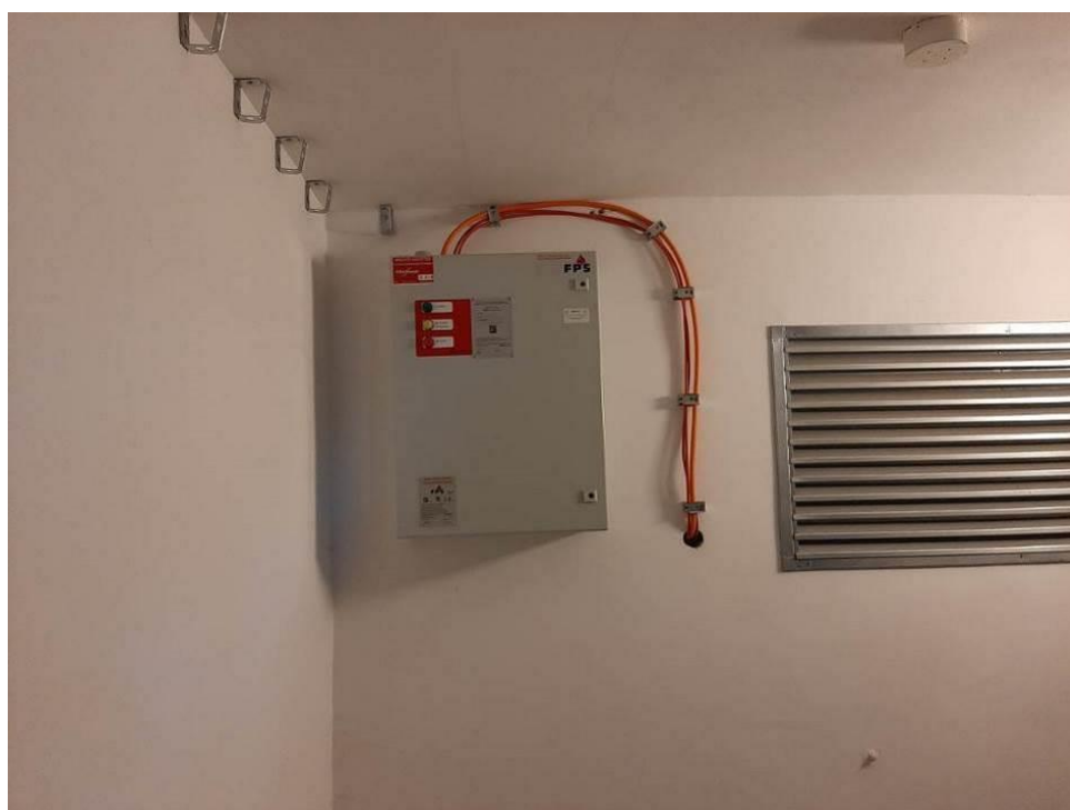
Fot.III.308. System oddymiania. Klatka a. Niedokończona instalacja. Brak odpowiednich przepustów kablowych.
