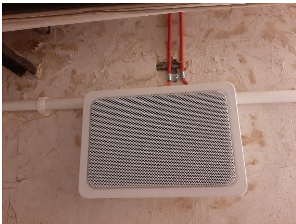
Fot. III.168. Stan techniczny instalacji systemów przeciwpożarowych piwnicy budynku „C” Prawidłowo wykonana instalacja
