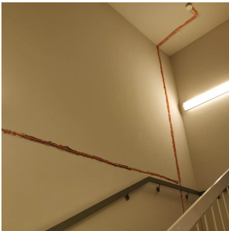
Fot. nr I.107. Brak uzupełnienie tynku ochronnego instalacji pożarowych. BUD.C.
