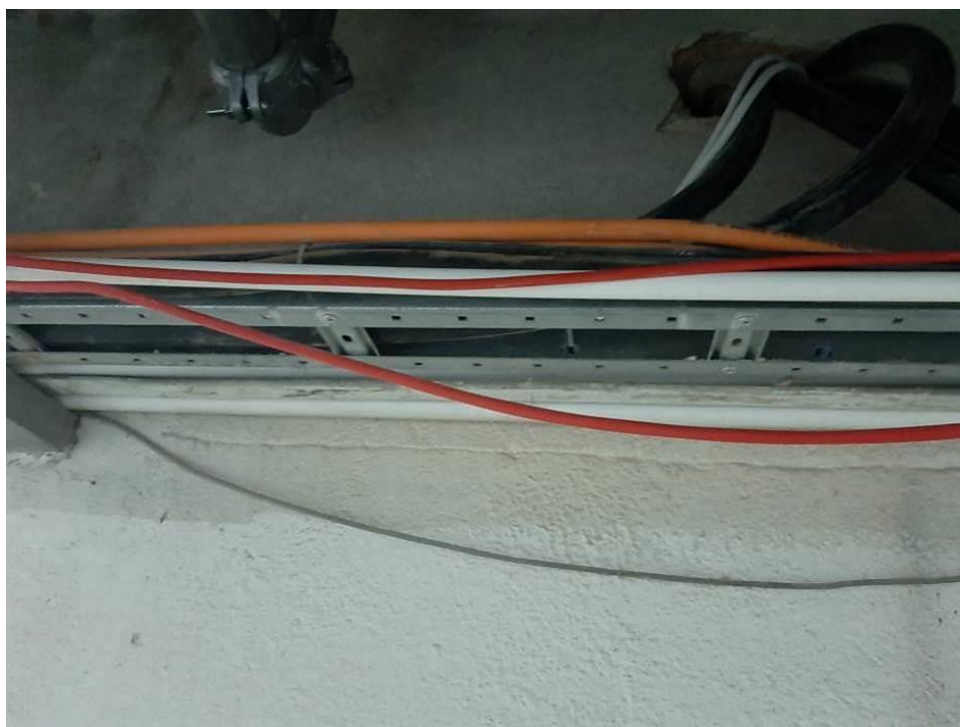
Fot. III.24. Stan techniczny instalacji systemów przeciwpożarowych piwnicy budynku „B” Nieprawidłowe prowadzenie kabli sygnalizacyjnych (czerwone) – brak uchwytów. Ułożenie kabli systemów przeciwpożarowych w sąsiedztwie normalnych.
