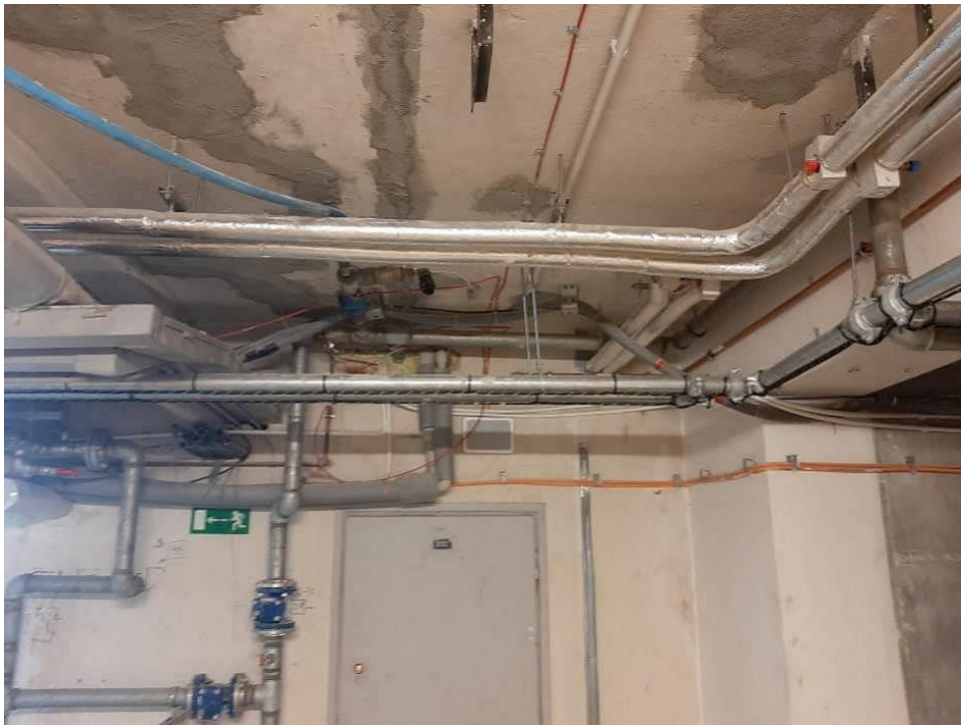
Fot. III.3. Stan techniczny instalacji systemów przeciwpożarowych piwnicy budynku „B” Prawidłowe ułożenie detektora wycieków na instalacji hydrantowej. Prawidłowe ułożenie zasilających przewodów elektrycznych (pomarańczowe) na uchwytych ściennych. Nieprawidłowe prowadzenie kabli sygnalizacyjnych (czerwone) – brak uchwytów.
