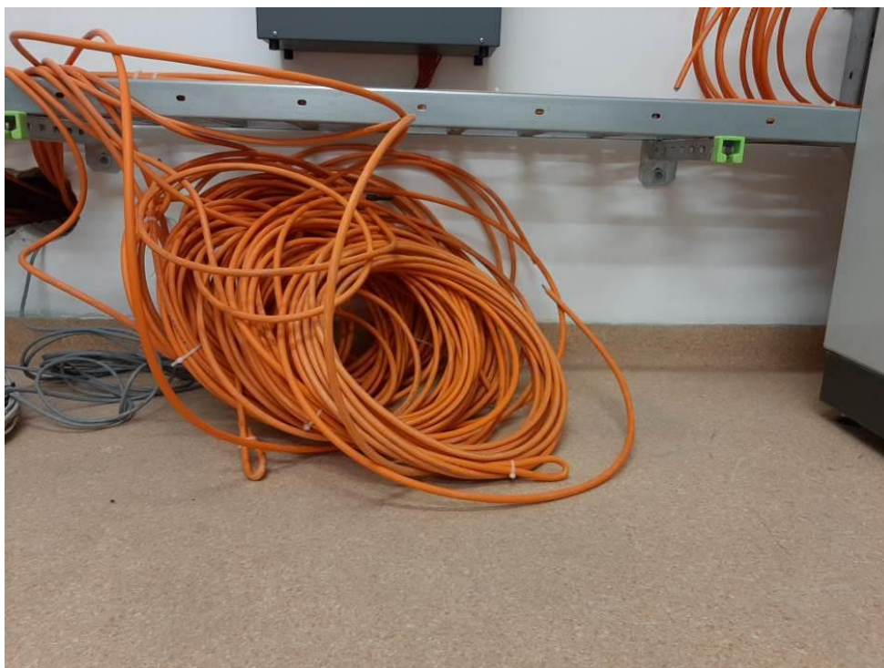
Fot.III.391. Pomieszczenie techniczne. Okablowanie systemu centralnej baterii. Niewprowadzone do szafy obwody zasilania.
