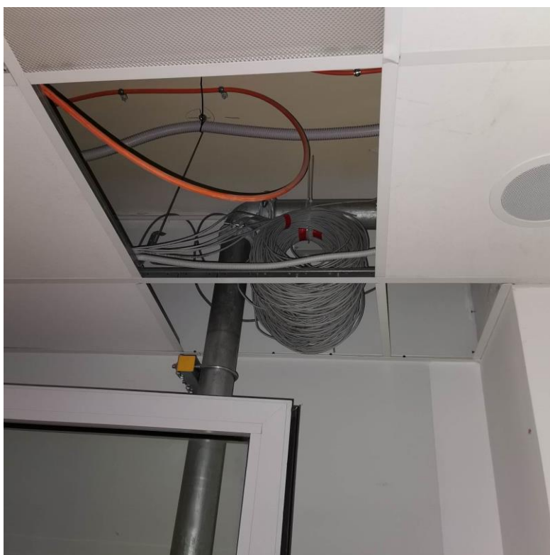
Fot. nr I.80. Brak uzupełnienia sufitu podwieszonego. Instalacja kablowa nie została rozprowadzona. BUD.D.
