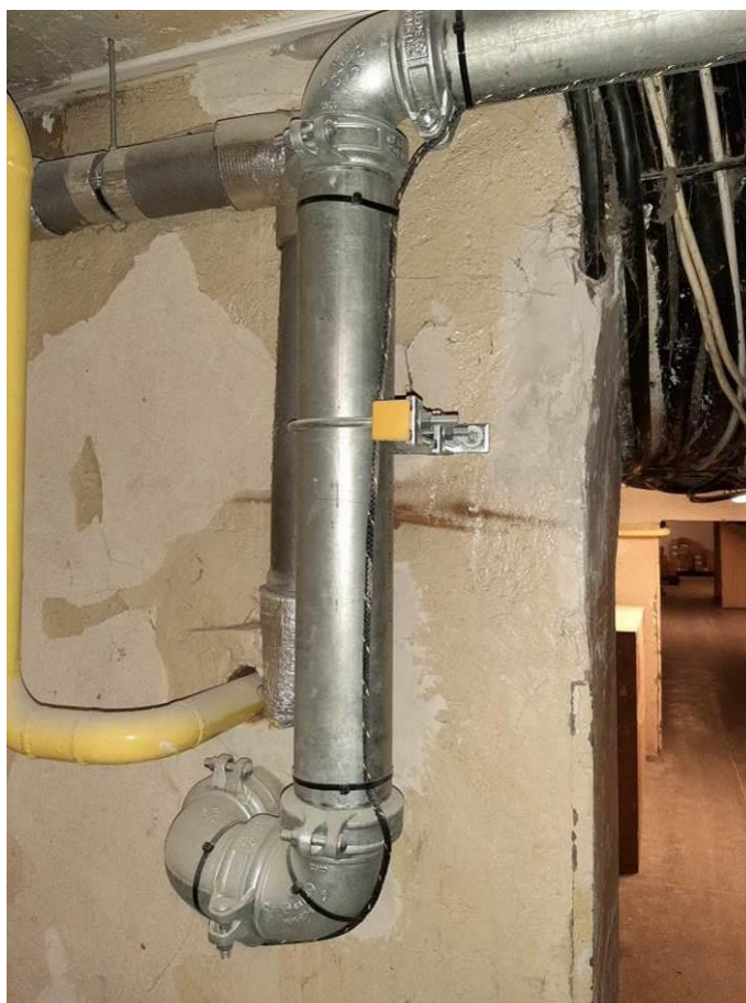
Fot.III.247. Montaż liniowego detektora wycieku na instalacji hydrantowej. Nieprawidłowa lokalizacja detektora – na rurociągu pionowym.
