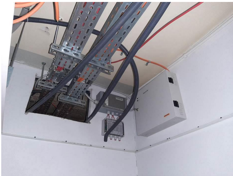
Fot. III.219. System detekcji ciepła LISTEC. Budynek „C”. Brak uchwytów kablowych.
