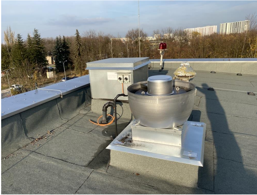
Fot. II.25. Dach budynku diagnostycznego B - Brak zasilania. Brak możliwości weryfikacji czy urządzenia jest sprawne i zgodne z projektem budowlanym. Brak też dokumentacji powykonawczej wraz z symulacją poprawności działania.
