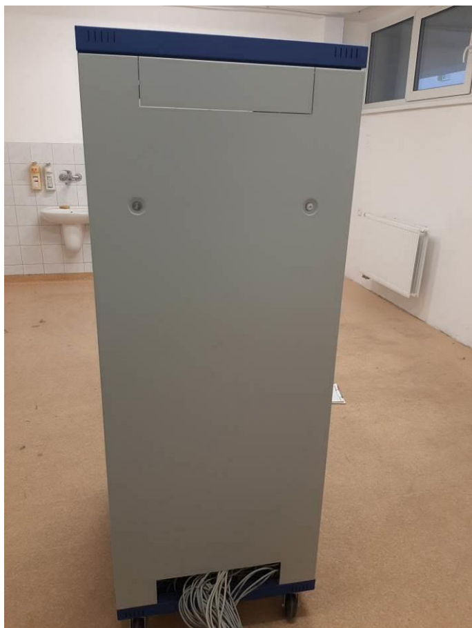
Fot. III.373. Pomieszczenie techniczne. Szafa systemu optycznej detekcji pożaru. Niepodłączone okablowanie systemu do urządzeń nadzorujących w szafie.
