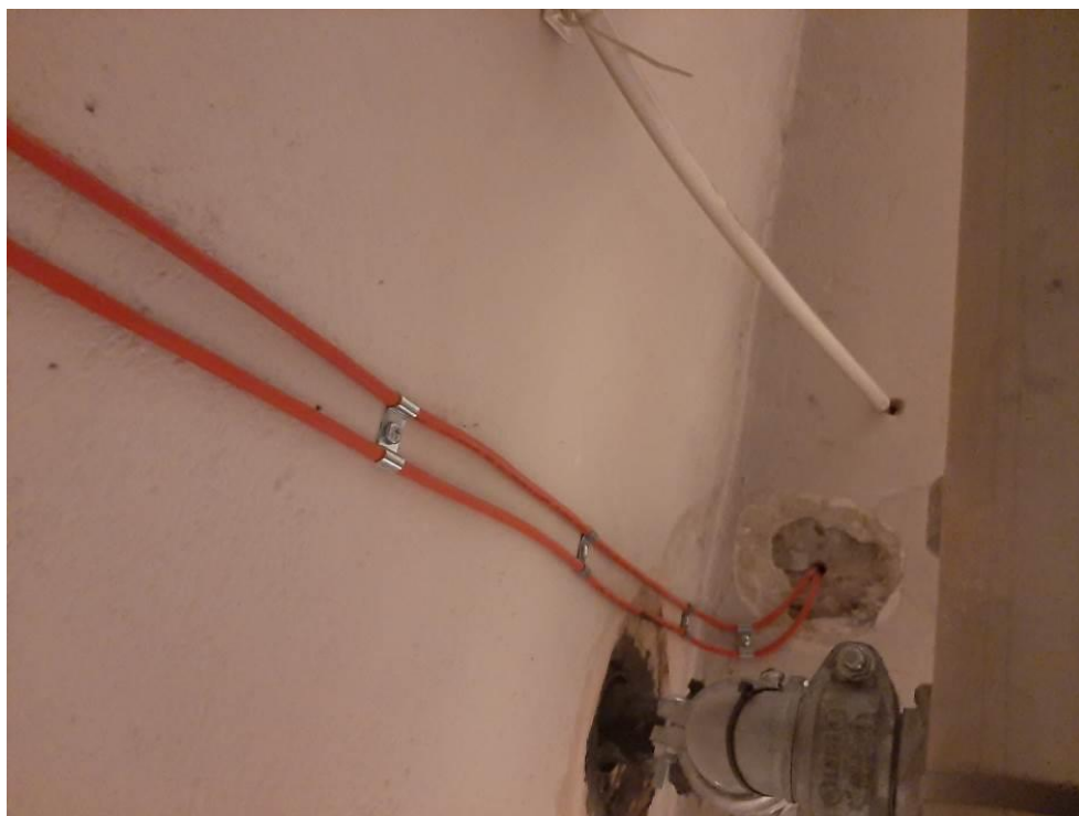
Fot. III.172. Stan techniczny instalacji systemów przeciwpożarowych piwnicy budynku „C” Nieprawidłowe prowadzenie kabli – brak odpowiedniego przepustu kablowego.
