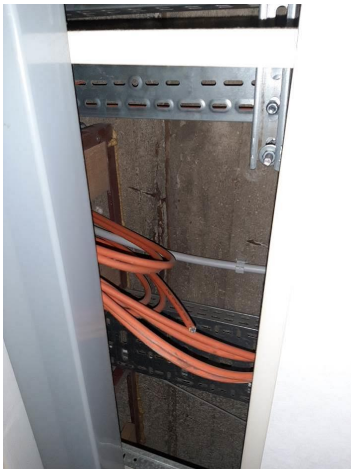
Fot. III.223. System detekcji ciepła LISTEC. Budynek „C”. Niezakończona instalacja.
