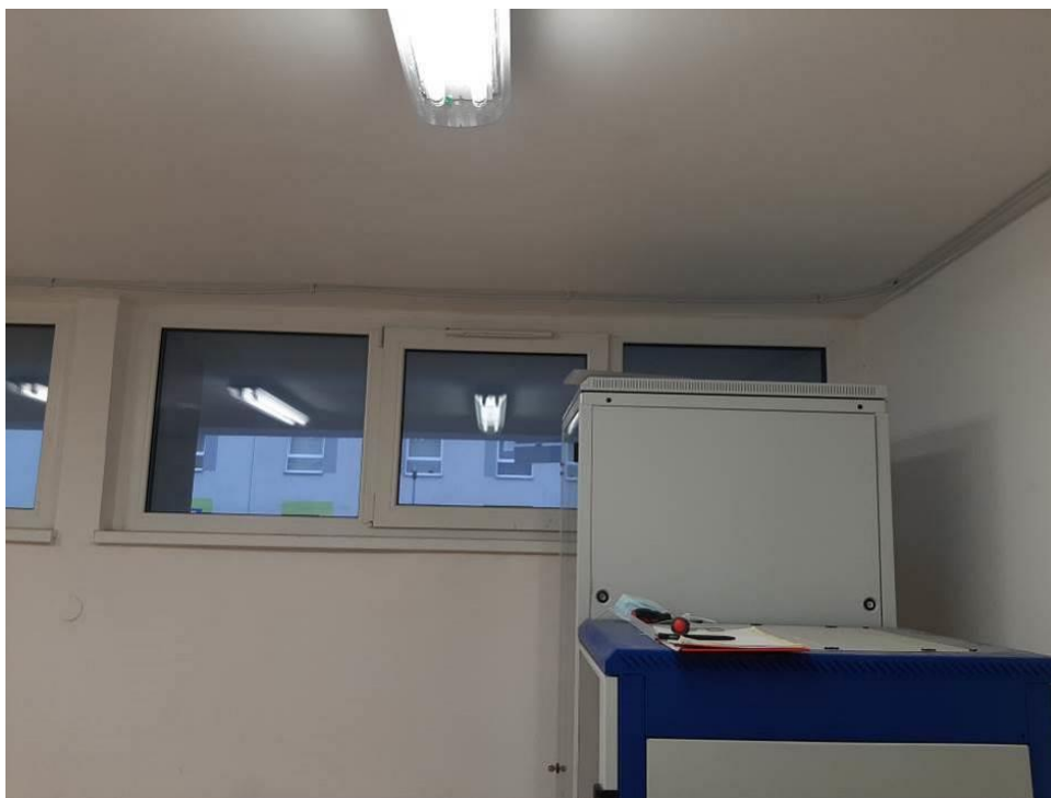
Fot. III.400. Pomieszczenie techniczne. Instalacja liniowej czujki ciepła. Prawidłowo ułożona instalacja
