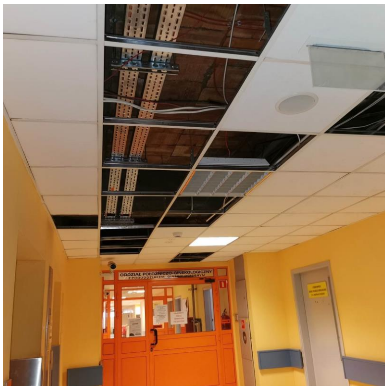
Fot. nr I.85. Ubytki sufitu powodujące swobodną migrację zanieczyszczonego powietrza pomiędzy pomieszczeniami. BUD.C.
