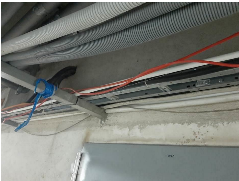
Fot. III.23. Stan techniczny instalacji systemów przeciwpożarowych piwnicy budynku „B” Nieprawidłowe prowadzenie kabli sygnalizacyjnych (czerwone) – brak uchwytów.
