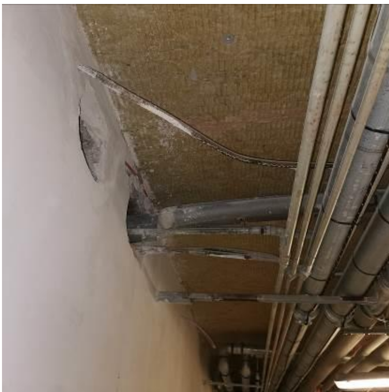
Fot. nr I.3. Niezabezpieczone otwory w ścianie wykonane dla prowadzenia instalacji. BUD.C.
