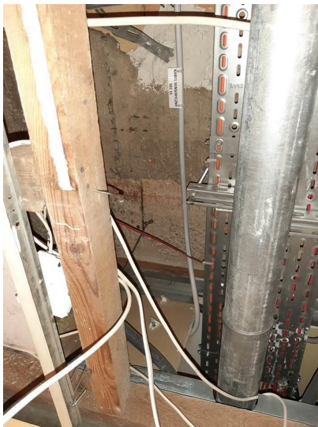
Fot. III.217. System detekcji ciepła LISTEC. Budynek „C”. Brak uchwyty.
