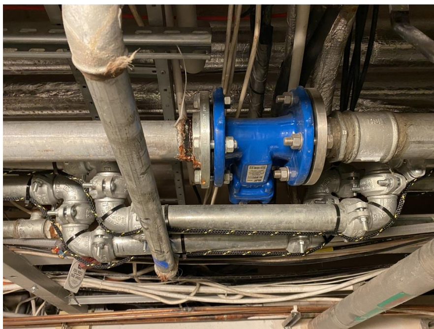
Fot. II.22. Piwnica budynku diagnostycznego B - Brak dostępu do armatury. Wykonana instalacja zasilania urządzenia zamontowane na innej instalacji. Wymaga to przebudowy i stworzenia dostępu do zaworu.
