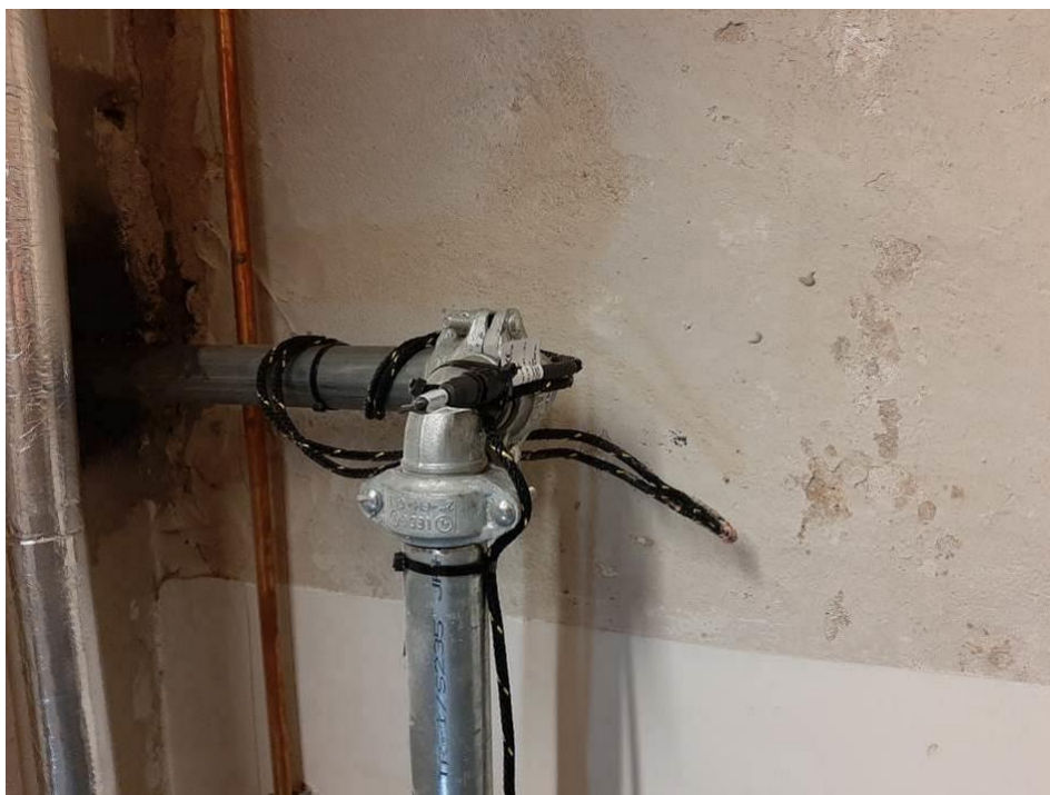
Fot. III.250. Montaż liniowego detektora wycieku na instalacji hydrantowej. Nieprawidłowe ułożenie detektora.
