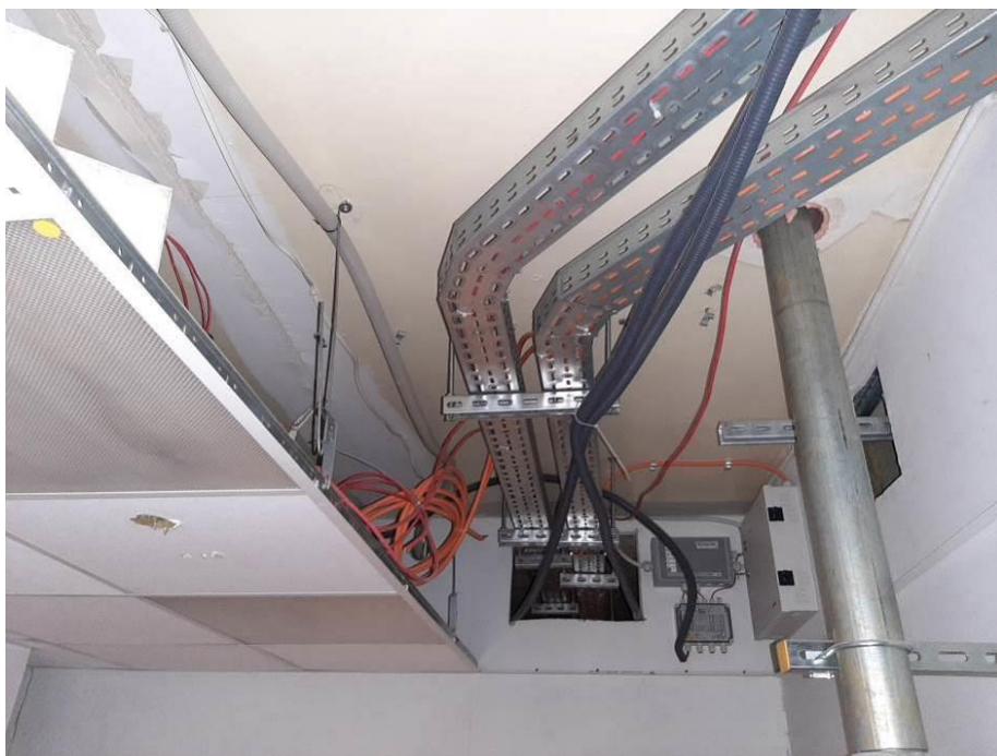
Fot. III.221. System detekcji ciepła LISTEC. Budynek „C”. Brak uchwytów kablowych. Niedokończona instalacja.
