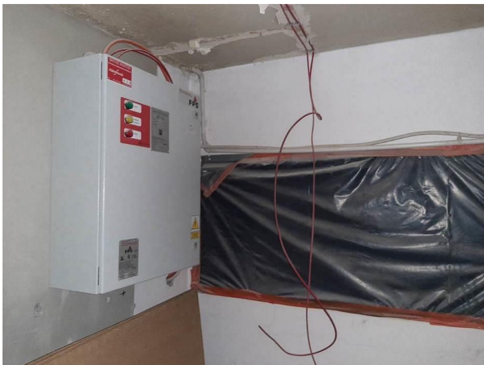
Fot. III.352. System oddymiania. Klatka d. Niedokończona instalacja. Brak urządzeń końcowych. Brak odpowiednich przepustów kablowych.
