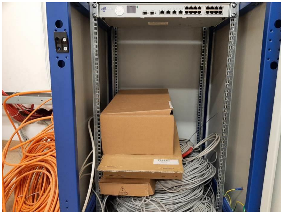
Fot. III.370. Pomieszczenie techniczne. Szafa systemu optycznej detekcji pożaru. Niepodłączone okablowanie systemu do urządzeń nadzorujących w szafie.
