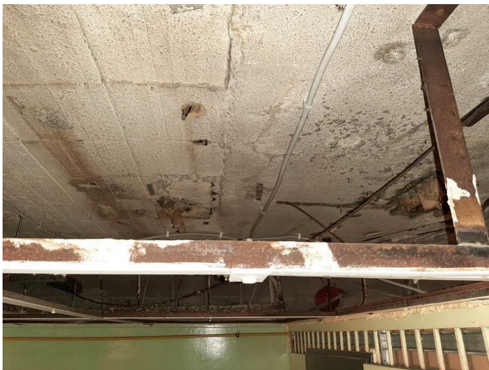
Fot. III.239. System detekcji ciepła LISTEC. Budynek „B” parter. Prawidłowo wykonana instalacja.
