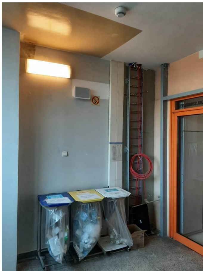
Fot. III.303. System oddymiania. Klatka a. Niedokończona instalacja. Brak odpowiednich przepustów kablowych.
