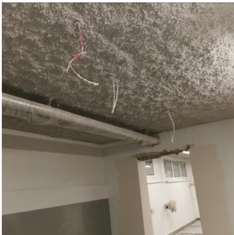
Fot. nr I.9. Widok izolacji natryskowej poprawiającej odporność ogniową stropu nad piwnicą. BUD.D.
