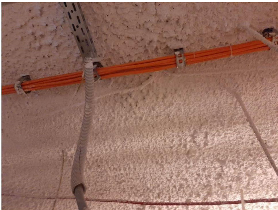
Fot. III.73. Stan techniczny instalacji systemów przeciwpożarowych piwnicy budynku „C” Nieprawidłowe prowadzenie kabli sygnalizacyjnych (czerwone) – brak uchwytów. Nieprawidłowe prowadzenie kabli zasilających (pomarańczowe) – zbliżenie do innych instalacji.
