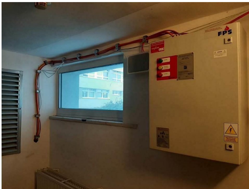
Fot. III.331. System oddymiania. Klatka c. Brak odpowiednich przepustów kablowych.
