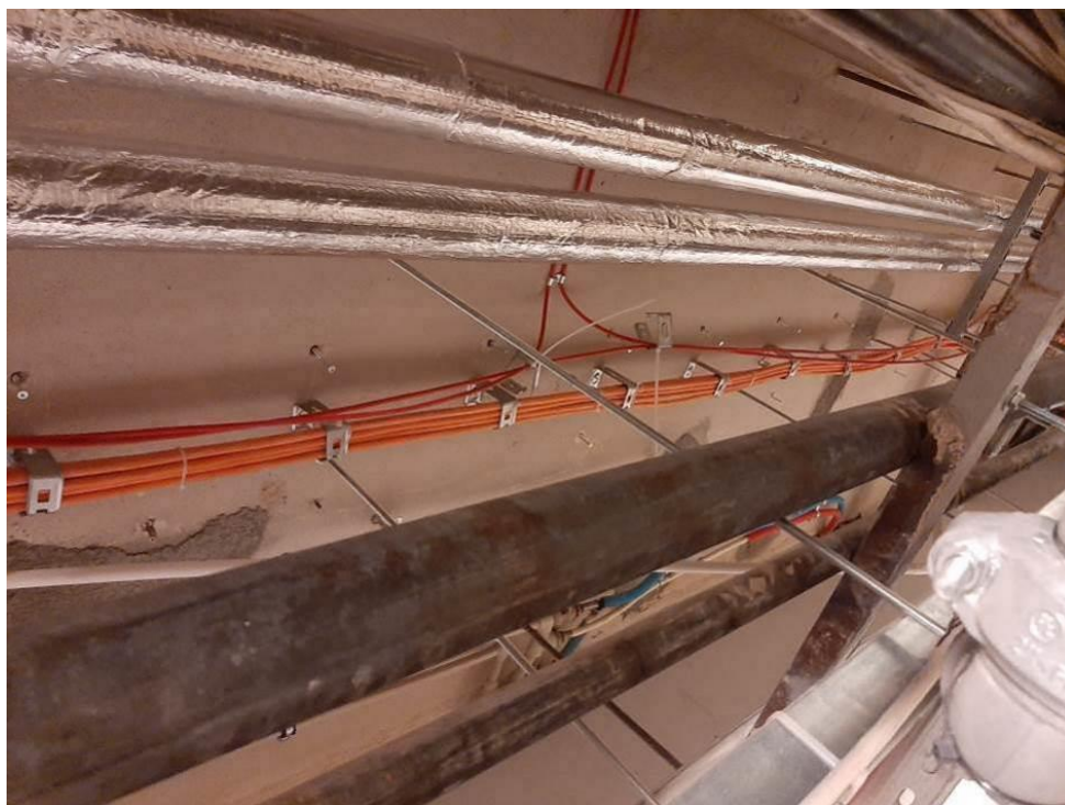
Fot. III.61. Stan techniczny instalacji systemów przeciwpożarowych piwnicy łącznika „IV” Nieprawidłowe prowadzenie kabli sygnalizacyjnych (czerwone) – brak uchwytów.
