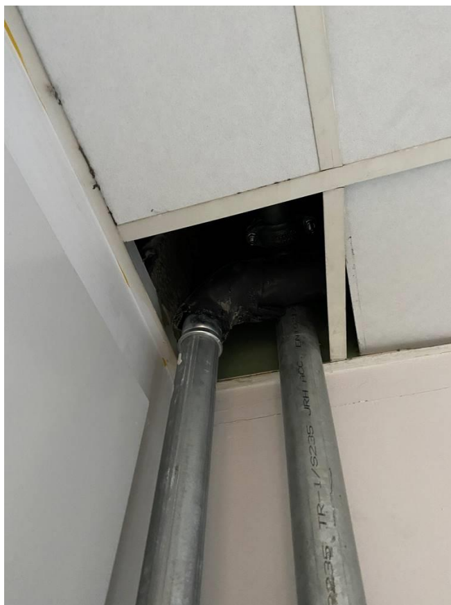
Fot. II.15. Piętro budynku łózkowego C- Nieobrobione przejścia przez sufity powieszane. W miejscach przejść zdemontowano sufit i tak pozostawiono. Wymaga dokończenia.
