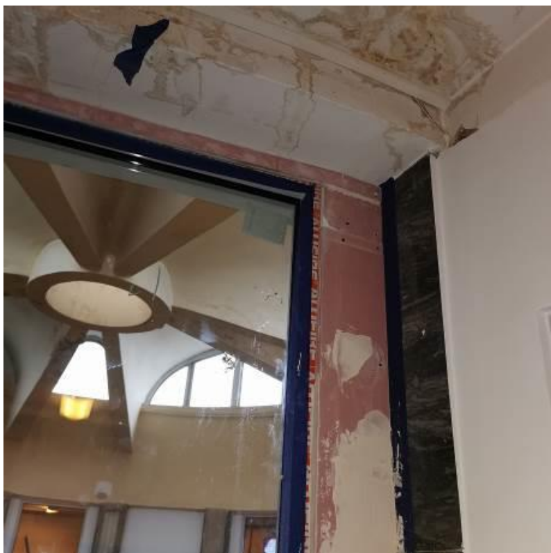
Fot. nr I.44.Brak wykonania robót budowlanych wykończeniowych. BUD.A.
