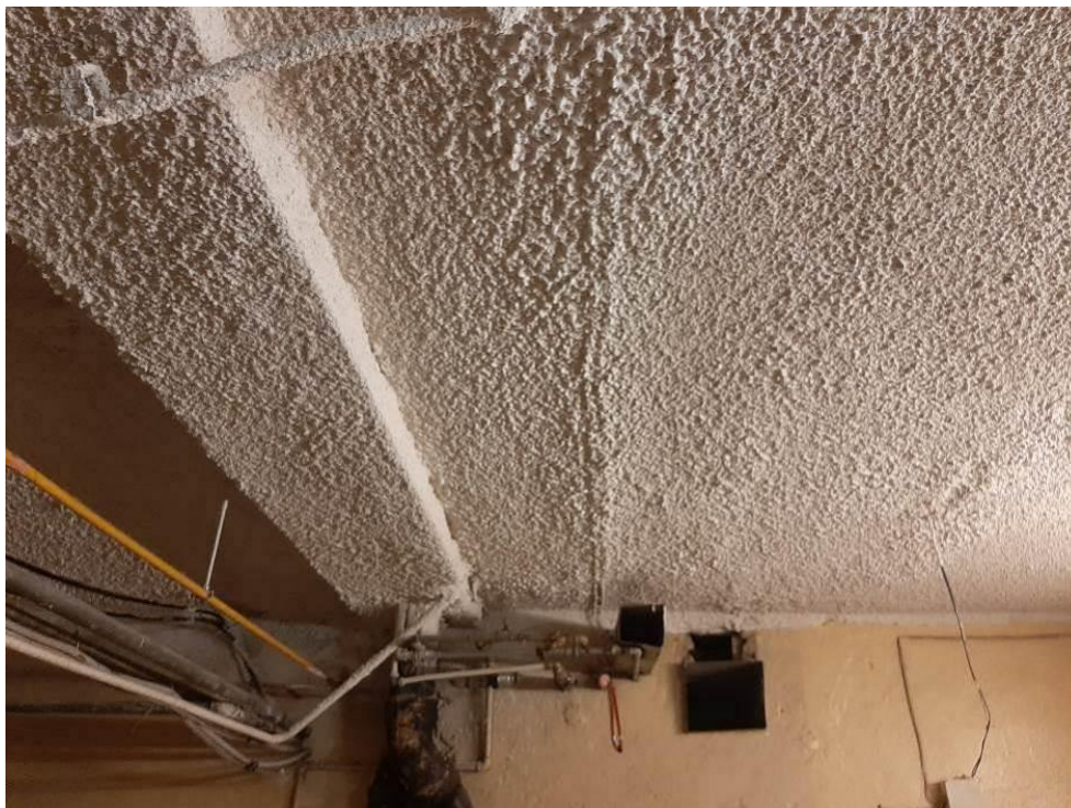
Fot. III.80. Stan techniczny instalacji systemów przeciwpożarowych piwnicy budynku „C” Nieprawidłowe prowadzenie kabli sygnalizacyjnych (czerwone) – przykrycie warstwą izolacji.
