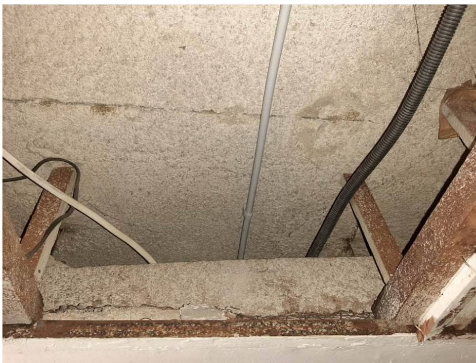
Fot. III.242. System detekcji ciepła LISTEC. Budynek „B” parter. Prawidłowo wykonana instalacja.
