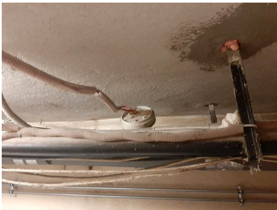
Fot. III.112. Stan techniczny instalacji systemów przeciwpożarowych piwnicy budynku „C” Niezamocowana czujka.
