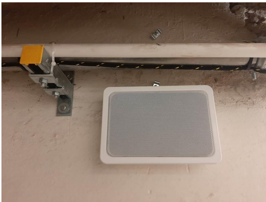
Fot. III.197. Stan techniczny instalacji systemów przeciwpożarowych piwnicy łącznika „II” Brak instalacji do głośnika systemu DSO.
