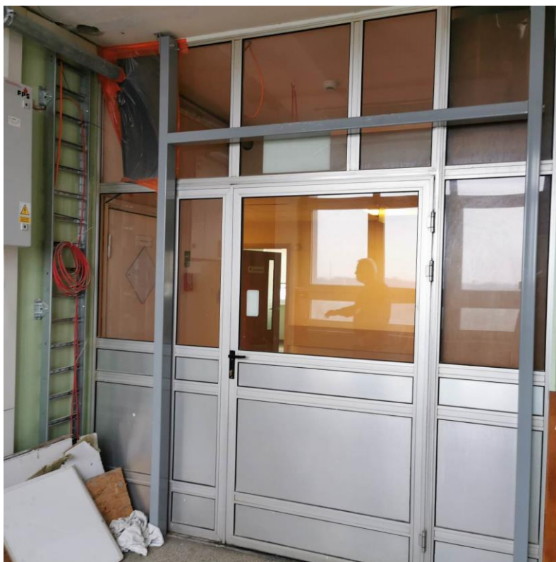
Fot. nr I.109. Brak zabudowy „szachtów instalacyjnych”. BUD.B.
