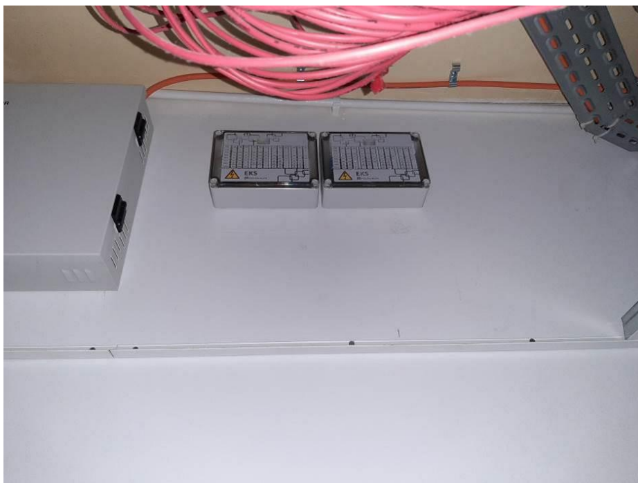
Fot. III.216. System detekcji ciepła LISTEC. Budynek „C”. Brak uchwytyów kablowych. Niepodłączone urządzenia.
