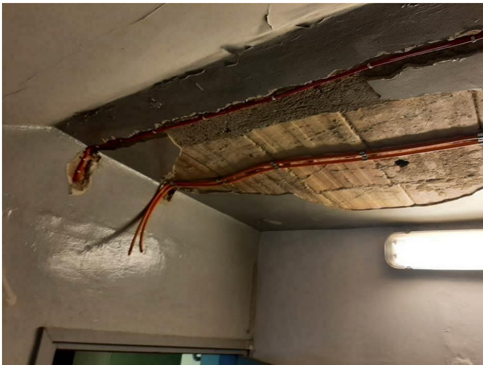
Fot. III.266. System oddymiania. Klatka h. Niedokończona instalacja. Brak urządzeń końcowych.
