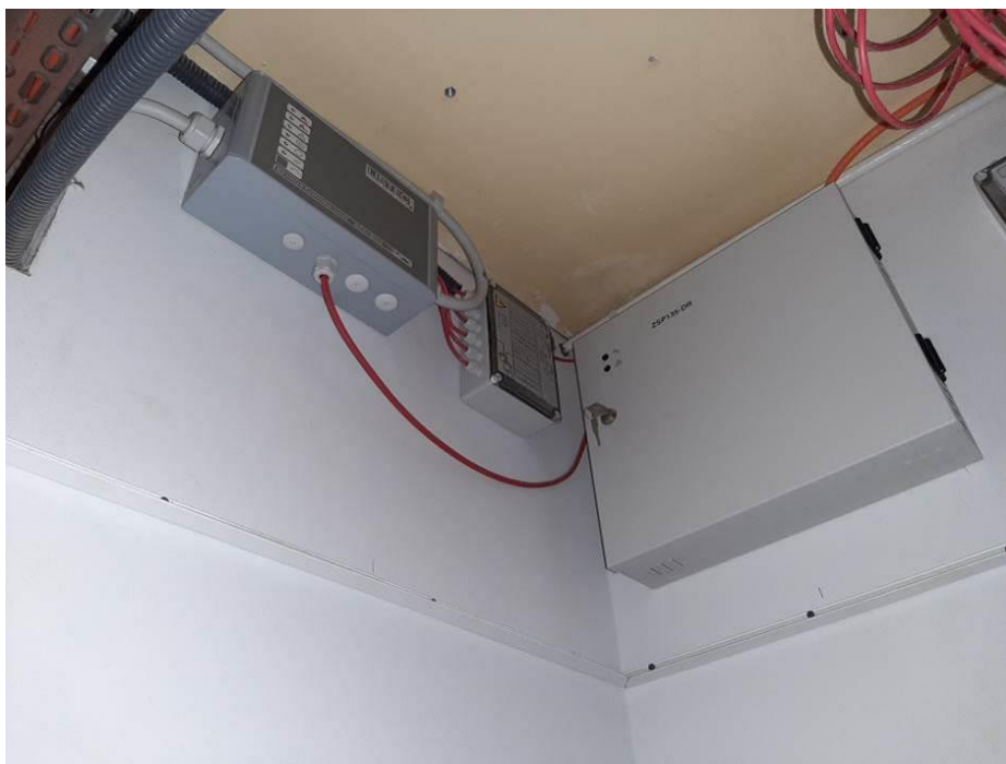
Fot. III.215. System detekcji ciepła LISTEC. Budynek „C”. Brak uchwytyów kablowych.
