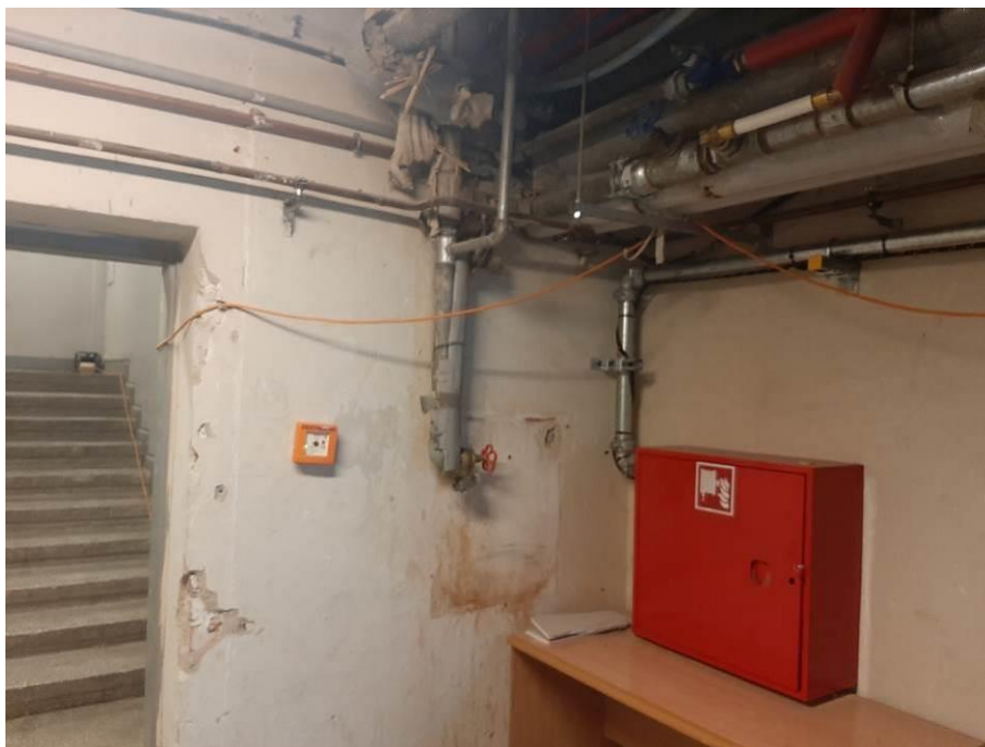
Fot. III.1. Stan techniczny instalacji systemów przeciwpożarowych piwnicy budynku „B” Prawidłowe ułożenie detektora wycieków na instalacji hydrantowej. Nieużywany przycisk ROP.
