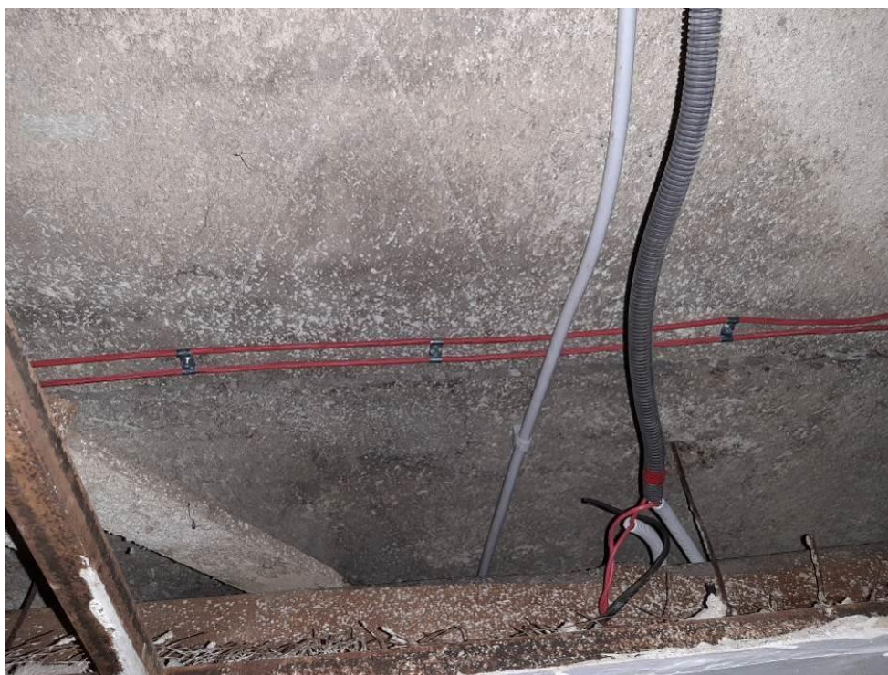
Fot. III.244. System detekcji ciepła LISTEC. Budynek „B” parter. Prawidłowo wykonana instalacja.
