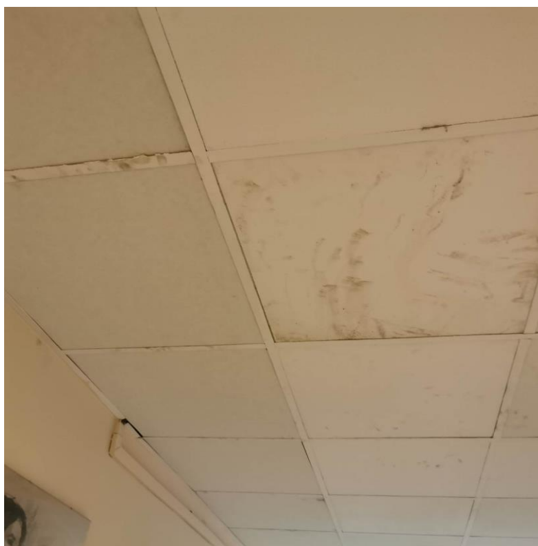
Fot. nr I.114. Uszkodzone elementy sufitu systemowego. BUD.D.
