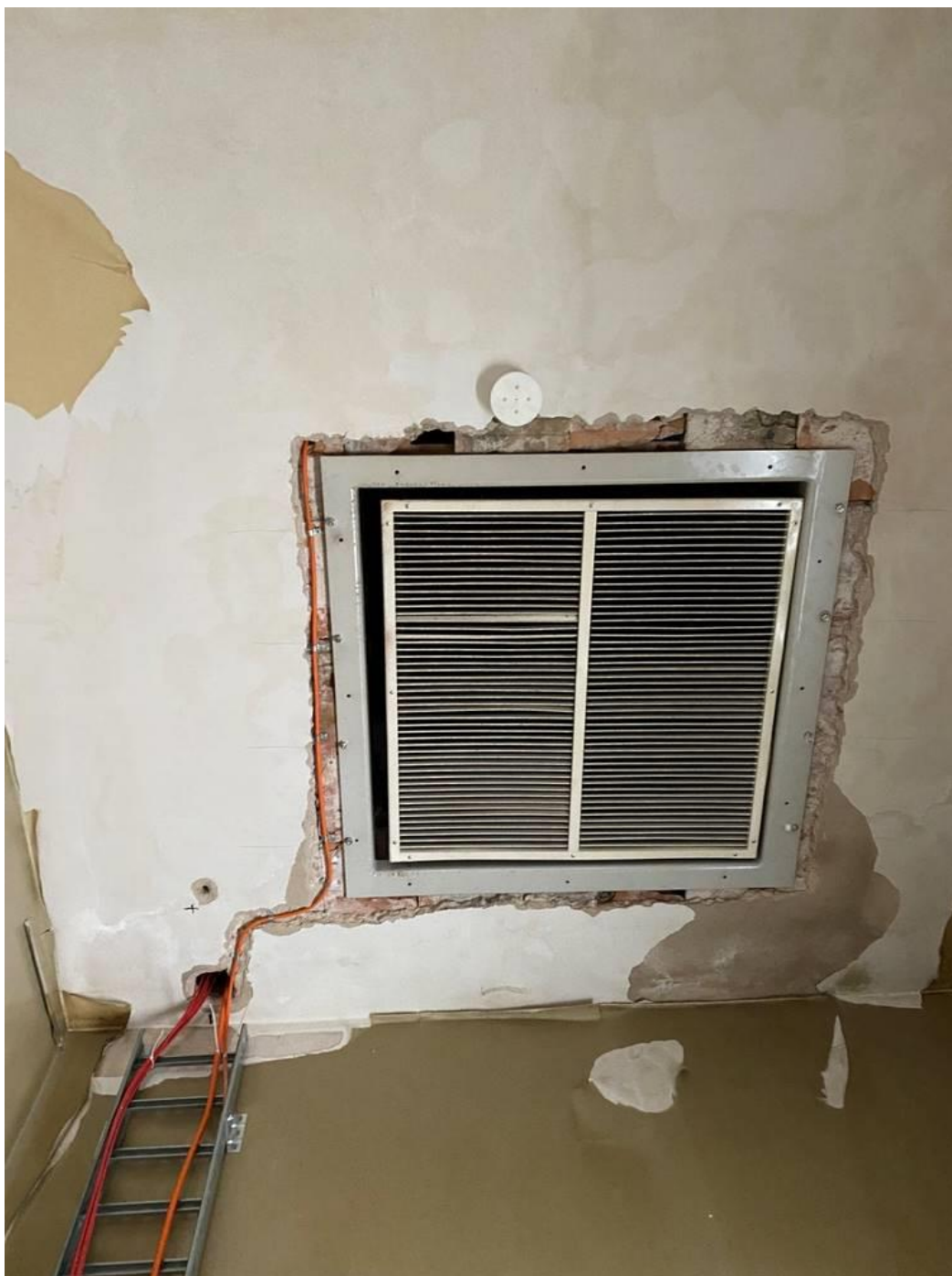
Fot. II.19. Zwieńczenie klatki schodowej C– budynek łózkowy Nieobrobione przejścia wentylacji oddymiającej. Roboty niedokończone. Niezabezpieczone przejścia kabli przez dach. Prace do dokończenia.
