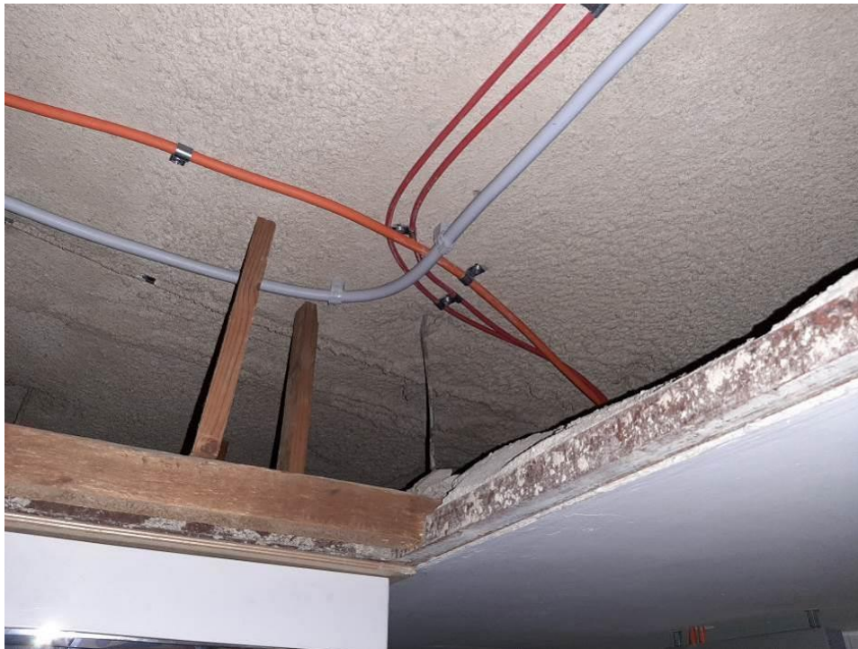
Fot. III.237. System detekcji ciepła LISTEC. Budynek „B” parter. Prawidłowo wykonana instalacja.
