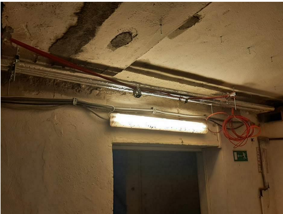
Fot. III.50. Stan techniczny instalacji systemów przeciwpożarowych piwnicy budynku „B” Nieprawidłowe prowadzenie kabli zasilających (pomarańczowe) – razem z innymi instalacjami. Nieprawidłowe prowadzenie kabli sygnalizacyjnych (czerwone) – brak uchwytów.
