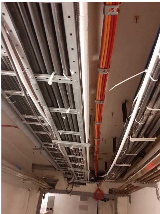
Fot. III.203. Stan techniczny instalacji systemów przeciwpożarowych piwnicy łącznika „II” Prawidłowe prowadzenie instalacji. Niezakończona instalacja.
