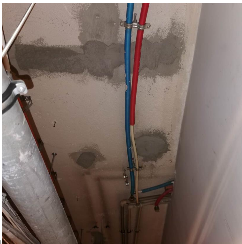
Fot. nr I.126. Brak wykonania zabezpieczenie – zwiększenia odporności pożarowej stropu w piwnicy BUD.B.
