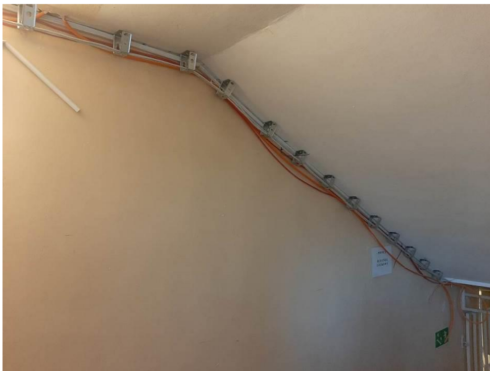
Fot. III.333. System oddymiania. Klatka c. Niedokończona instalacja. Brak urządzeń końcowych
