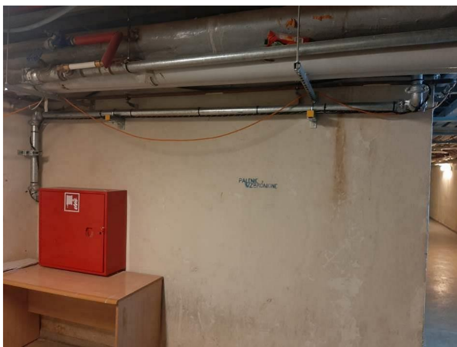
Fot. III.2. Stan techniczny instalacji systemów przeciwpożarowych piwnicy budynku „B” Prawidłowe ułożenie detektora wycieków na instalacji hydrantowej.
