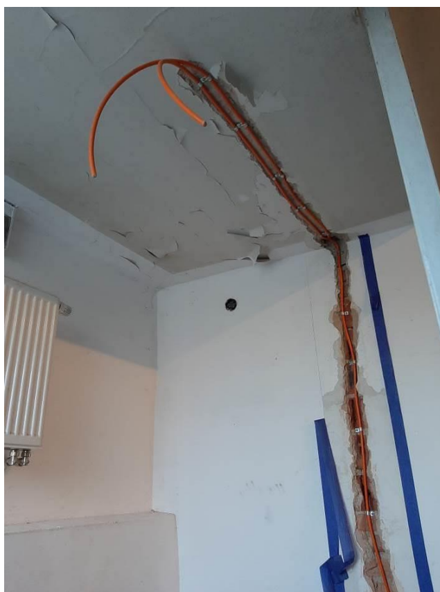
Fot. III.269. System oddymiania. Klatka h. Niedokończona instalacja. Brak urządzeń końcowych.
