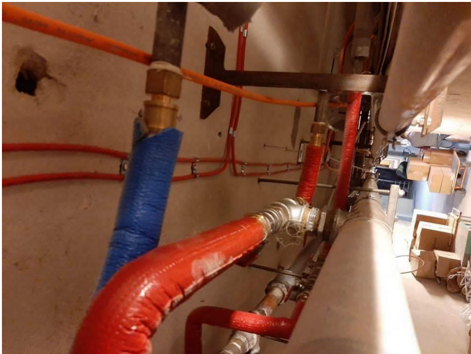
Fot. III.171. Stan techniczny instalacji systemów przeciwpożarowych piwnicy budynku „C” Nieprawidłowe prowadzenie kabli – brak uchwytów.
