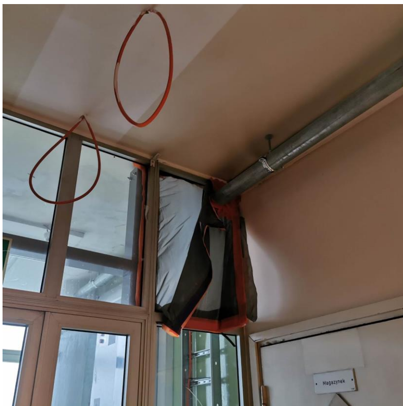
Fot. nr I.111. Ubytek szyby w ścianie na granicy stref pożarowych w miejscu prowadzenia nowych instalacji hydrantowych. BUD.B.
