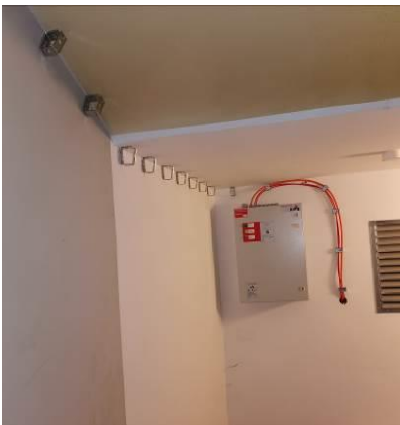
Fot. nr I.14. Brak zamocowania instalacji w przytwierdzonych elementach instalacyjnych. BUD.B
