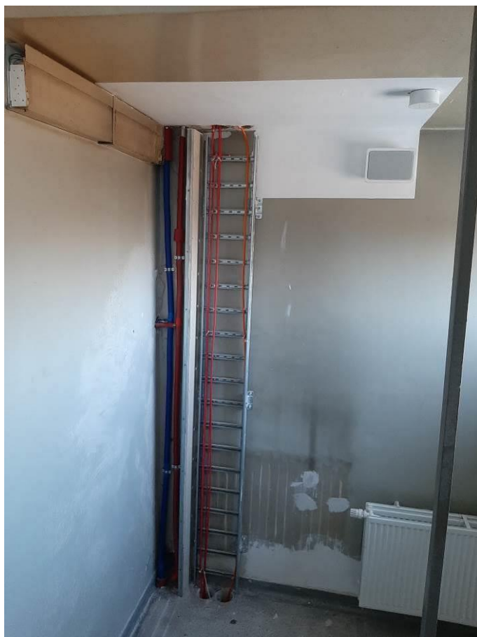
Fot. III.342. System oddymiania. Klatka d. Niedokończona instalacja. Brak odpowiednich przepustów kablowych.
