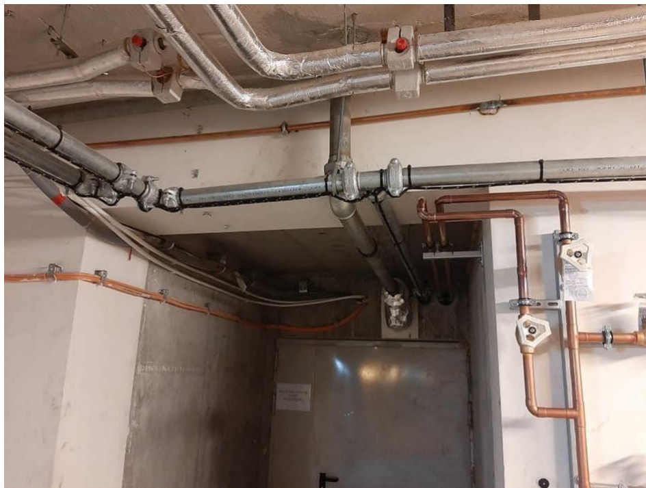
Fot. III.4. Stan techniczny instalacji systemów przeciwpożarowych piwnicy budynku „B” Prawidłowe ułożenie zasilających przewodów elektrycznych (pomarańczowe) na uchwytych ściennych. Prawidłowe ułożenie detektora wycieków na instalacji hydrantowej.
