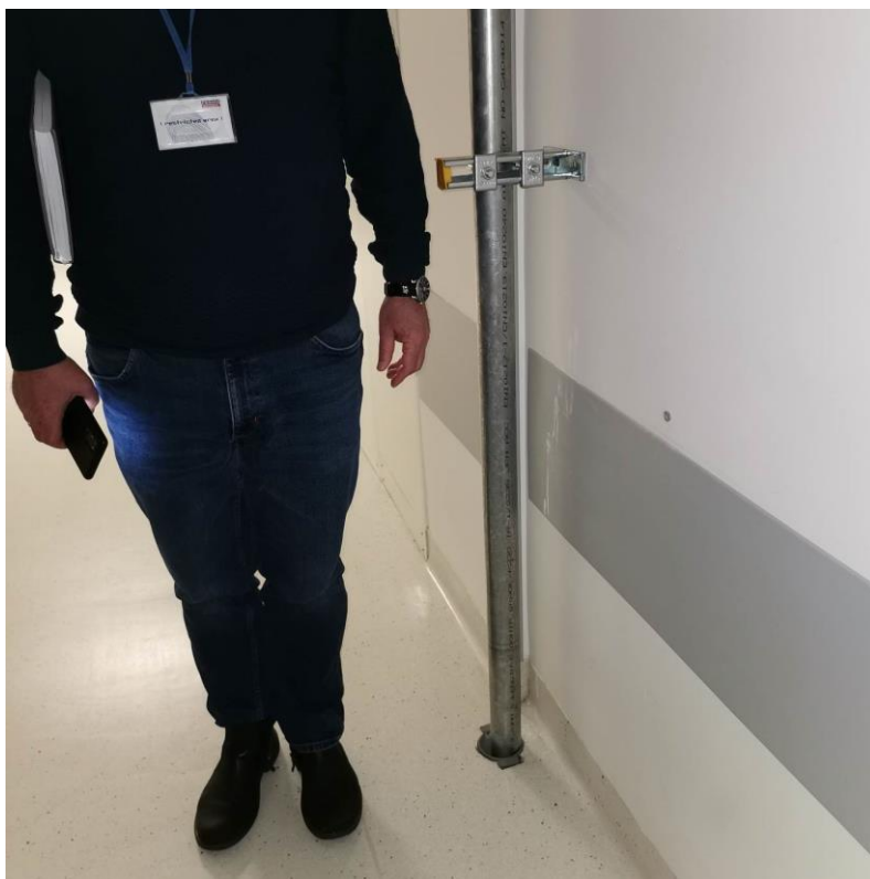
Fot. nr I.63. Lokalizacja pionu wodociągowego kolidująca z bezpiecznym korzystaniem z komunikacji. BUD.D.
