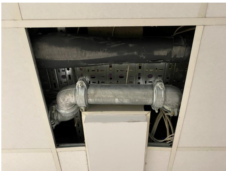
Fot. II.16. Korytarz w budynku łózkowym C– ostatnia kondygnacja. Instalacja miejscami wystaje z sufitów podwieszanych. Wymaga przebudowy. Niedopuszczalne jest pozostawienie wystającej instalacji z otwartymi sufitami.
