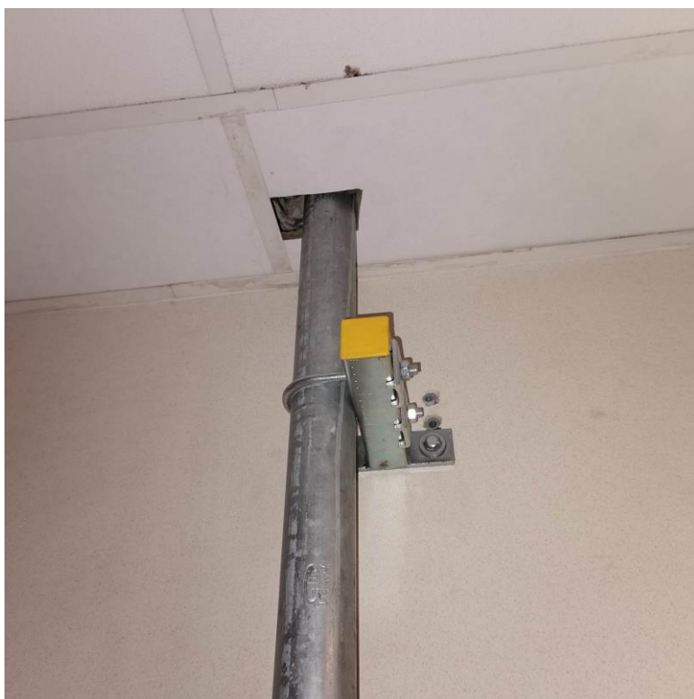
Fot. nr I.95. Brak szczelnego wykonania zabudowy instalacji w suficie. BUD.B.
