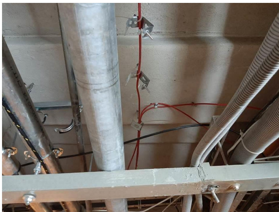
Fot.III.6. Stan techniczny instalacji systemów przeciwpożarowych piwnicy budynku „B” Nieprawidłowe prowadzenie kabli sygnalizacyjnych (czerwone) – brak uchwytów, uchwyty niezamocowane w suficie.
