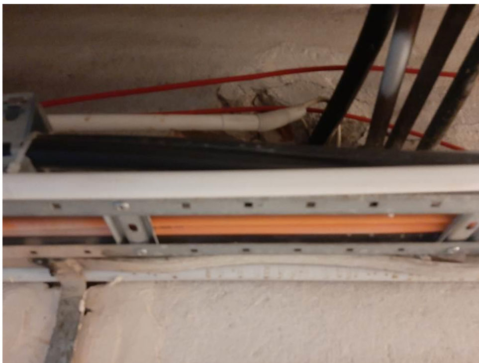
Fot. III.19. Stan techniczny instalacji systemów przeciwpożarowych piwnicy budynku „B” Nieprawidłowe prowadzenie kabli sygnalizacyjnych (czerwone) – brak uchwytów.
