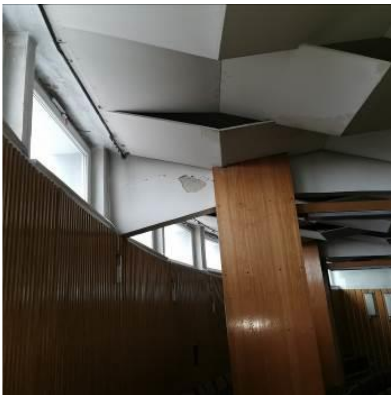
Fot. nr I.49. Brak usunięcia łatwopalnych elementów sufitowych i okładzin ściennych z wnętrza pomieszczenia Sali wykładowej. BUD.A.
