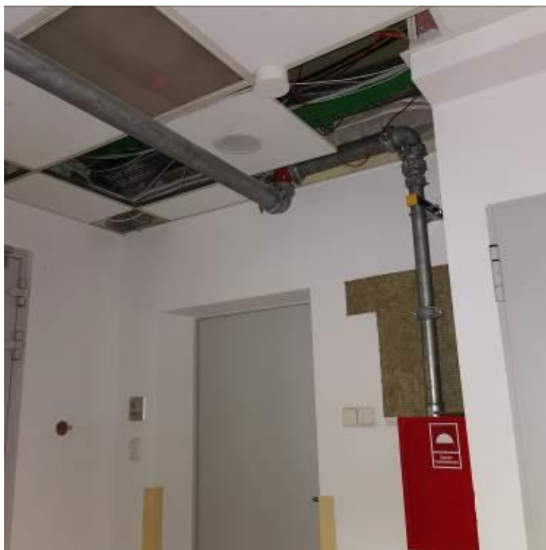
Fot. nr I.17. Brak uzupełnienia sufitu podwieszonego po realizacji prac w przestrzeni podstropowej. Miejsce swobodnego przepływu zanieczyszczonego powietrza pomiędzy pomieszczeniami. BUD.B
