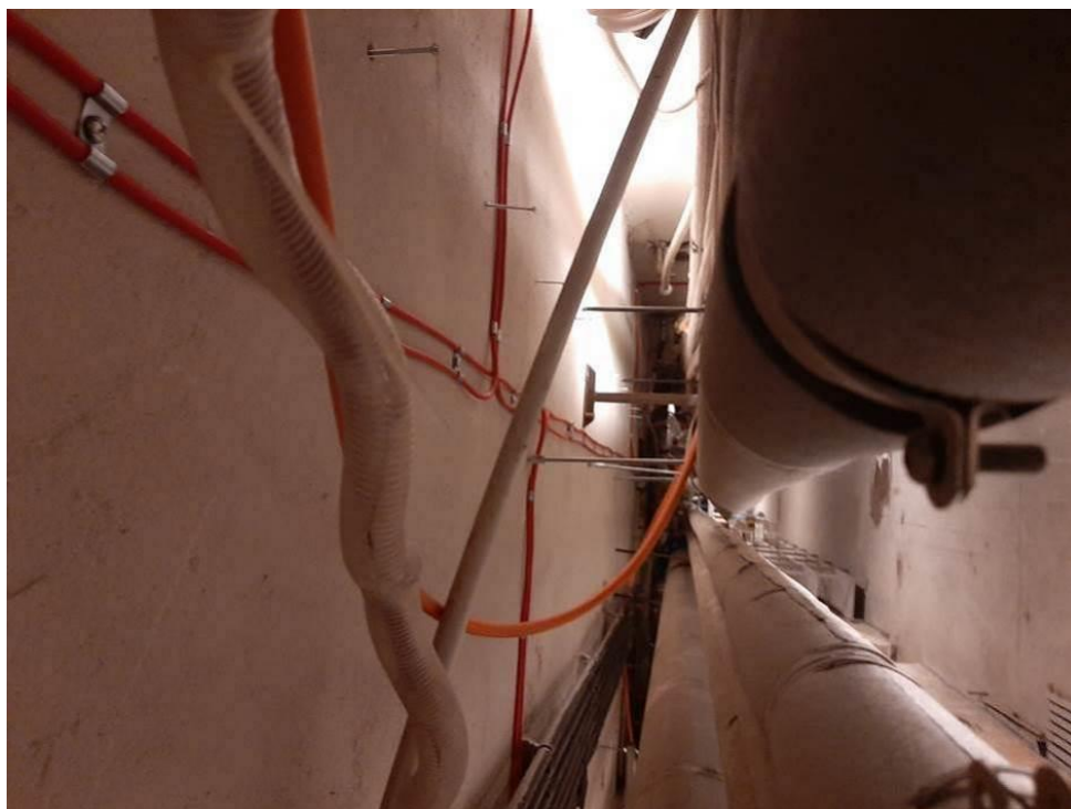
Fot. III.159. Stan techniczny instalacji systemów przeciwpożarowych piwnicy budynku „C” Nieprawidłowe prowadzenie kabli – brak uchwytów.
