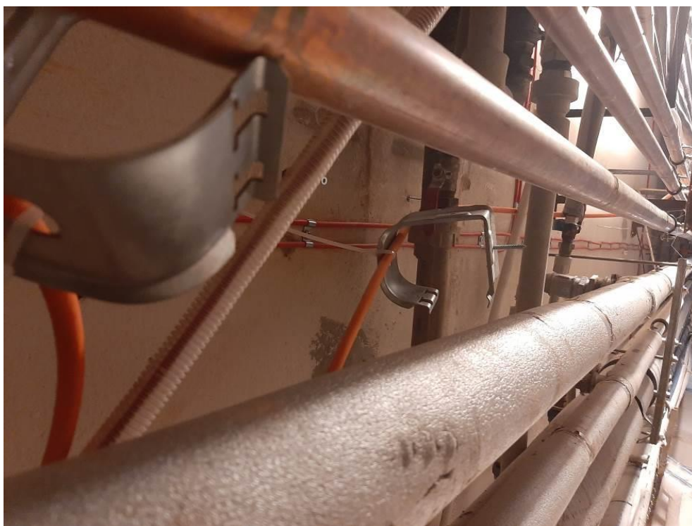
Fot.III.174. Stan techniczny instalacji systemów przeciwpożarowych piwnicy budynku „C” Nieprawidłowe prowadzenie kabli – brak uchwytów.
