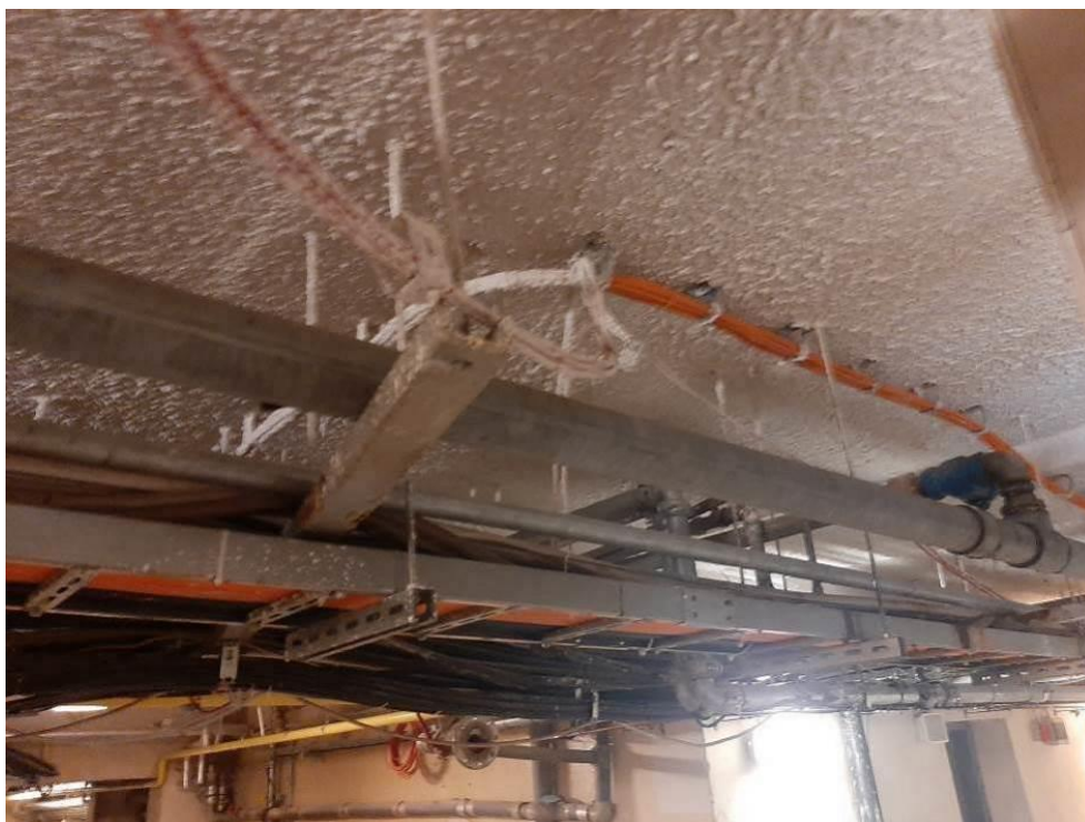
Fot. III.75. Stan techniczny instalacji systemów przeciwpożarowych piwnicy budynku „C” Nieprawidłowe prowadzenie kabli sygnalizacyjnych (czerwone) – brak uchwytów.
