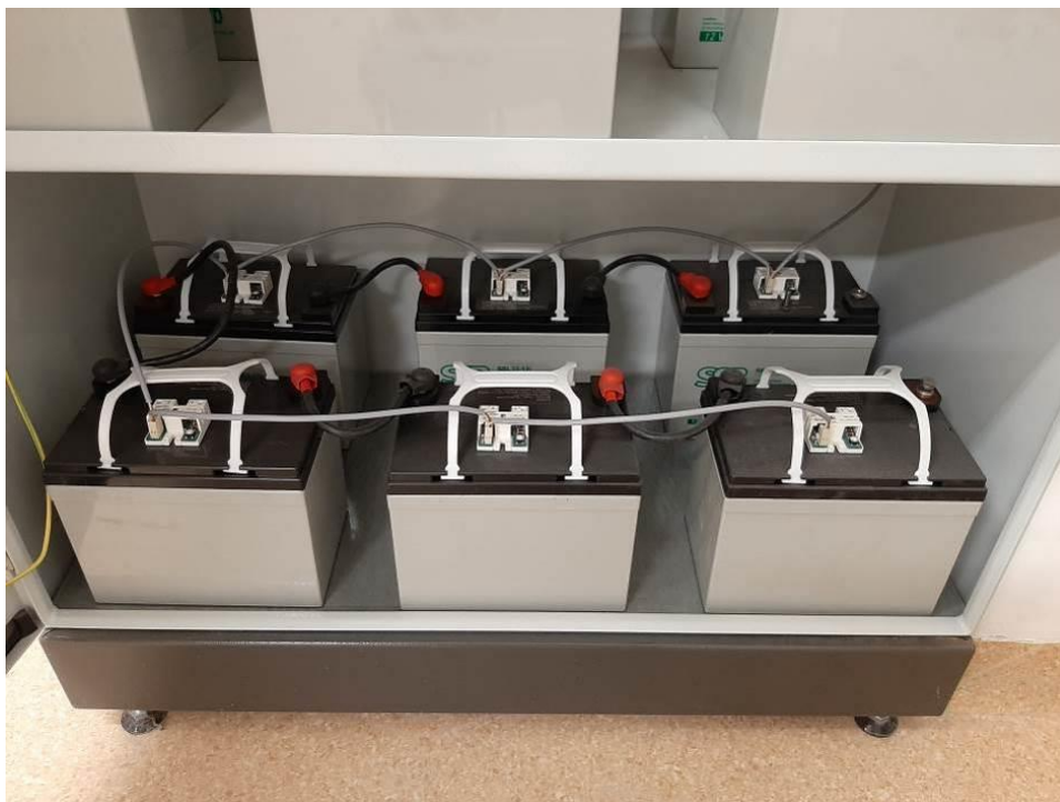
Fot. III.390. Pomieszczenie techniczne. Szafa systemu centralnej baterii. Niepodłączone akumulatory buforowe.
