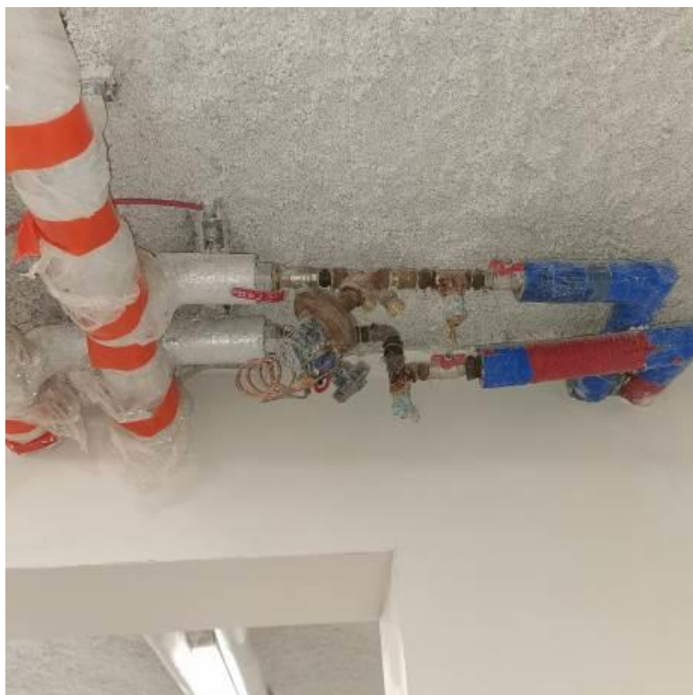
Fot. nr I.5. Widok izolacji natryskowej poprawiającej odporność ogniową stropu nad piwnicą. BUD.A.
