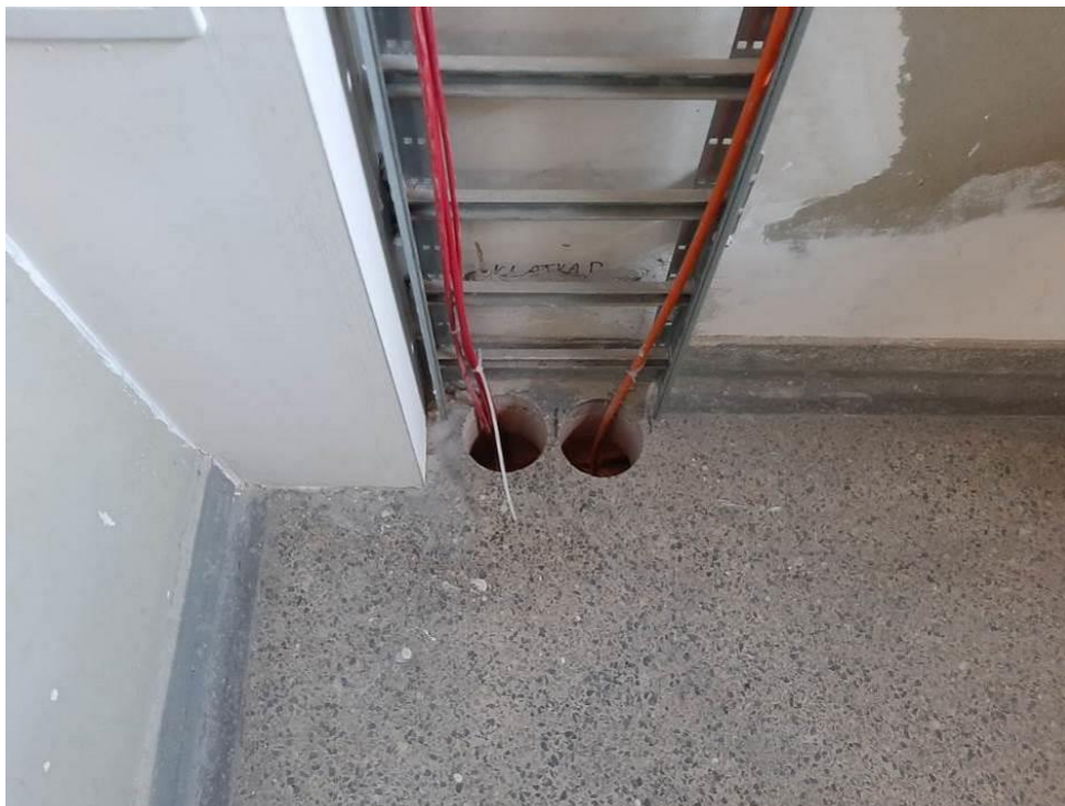
Fot.III.338. System oddymiania. Klatka d. Niedokończona instalacja. Brak odpowiednich przepustów kablowych.
