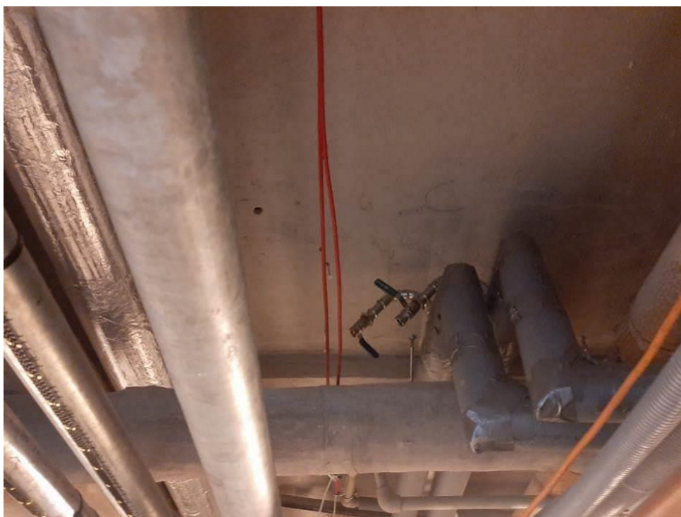
Fot. III.8. Stan techniczny instalacji systemów przeciwpożarowych piwnicy budynku „B” Nieprawidłowe prowadzenie kabli zasilających (pomarańczowe) – brak uchwytów. Nieprawidłowe prowadzenie kabli sygnalizacyjnych (czerwone) – brak uchwytów.
