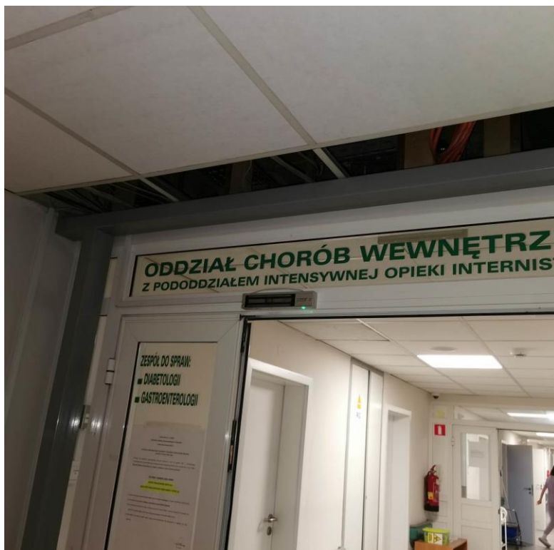
Fot. nr I.103. Ubytki sufitu powodujące swobodną migrację zanieczyszczonego powietrza pomiędzy pomieszczeniami. Brak zamontowanej stolarki drzwiowej- elementu ochrony przeciwpożarowej. BUD.B.
