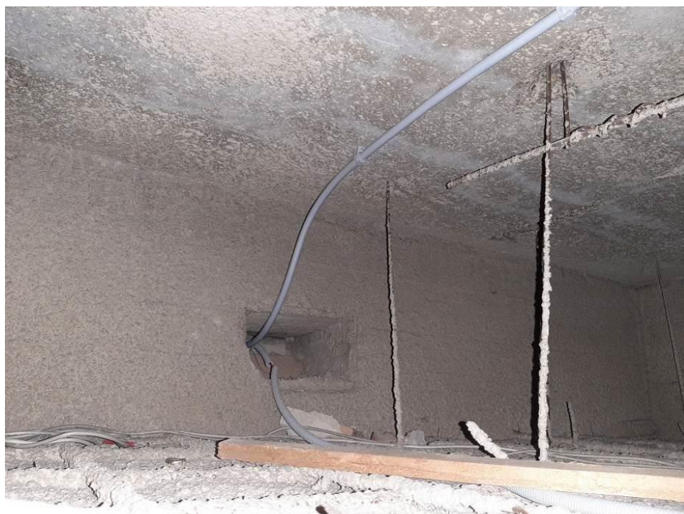
Fot. III.234. System detekcji ciepła LISTEC. Budynek „B” parter. Brak odpowiedniego przepustu kablowego.
