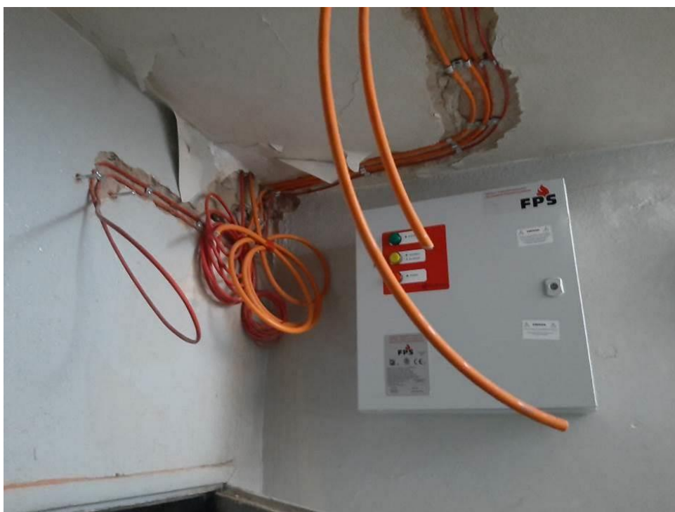
Fot. III.271. System oddymiania. Klatka h. Niedokończona instalacja. Brak urządzeń końcowych.
