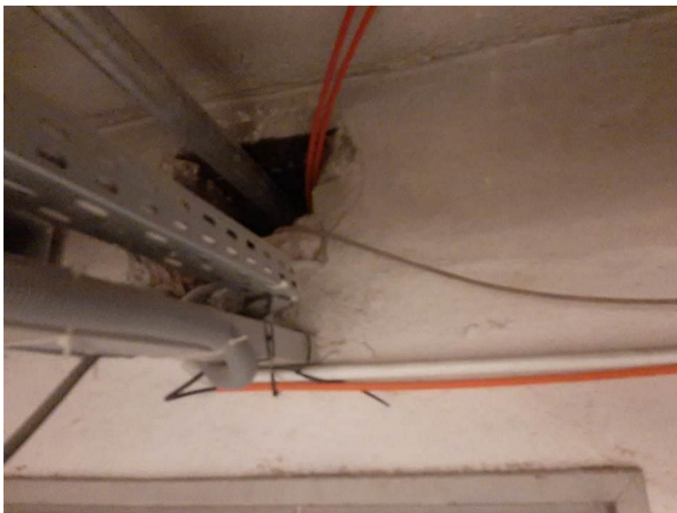
Fot.III.43. Stan techniczny instalacji systemów przeciwpożarowych piwnicy budynku „B” Nieprawidłowe prowadzenie kabli zasilających (pomarańczowe) – razem i inną instalacją. Nieprawidłowe prowadzenie kabli zasilających (pomarańczowe) – brak uchwytów. Brak odpowiedniego przepustu kanałowego.
