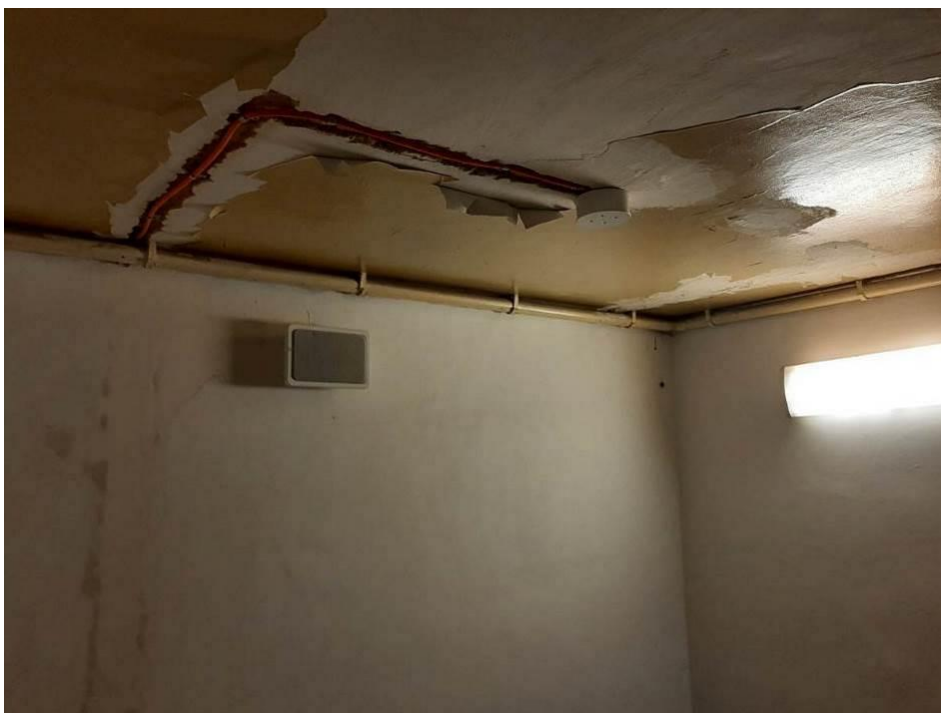
Fot.III.311. System oddymiania. Klatka a. Niedokończona instalacja. Brak odpowiednich przepustów kablowych.
