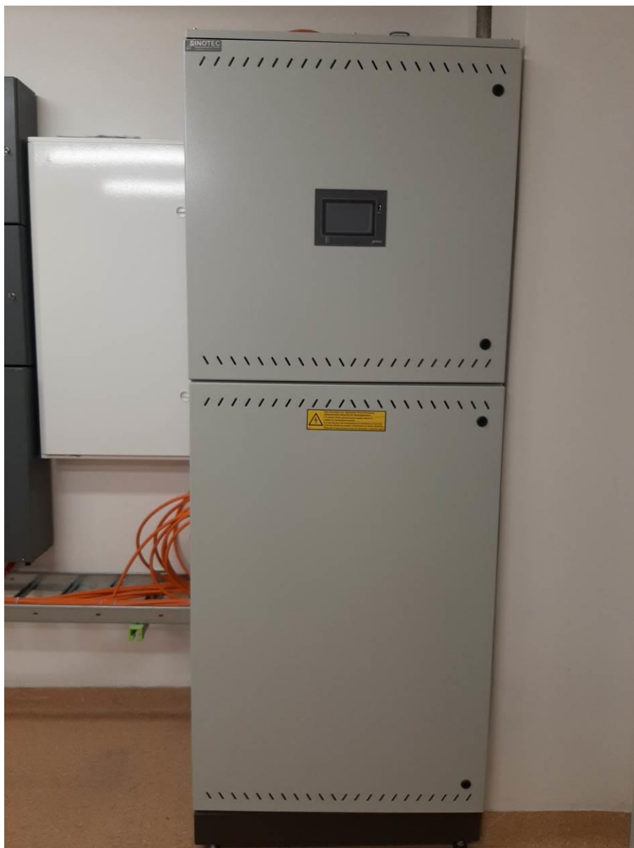
Fot. III.382. Pomieszczenie techniczne. Szafa systemu centralnej baterii.
