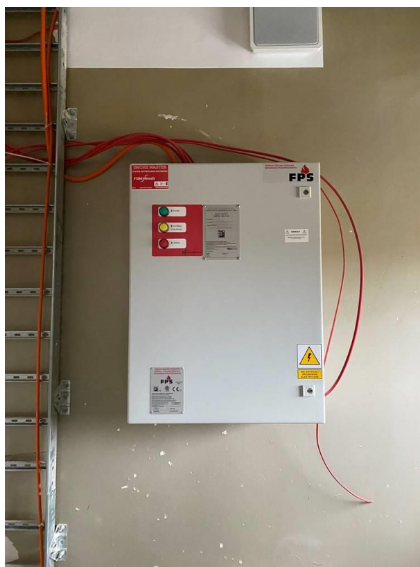
Fot. II.18. Klatka schodowa budynku łózkowego C- Niepodłączone centrale oddymiające. Brak możliwości weryfikacji wydajności instalacji oddymienia.
