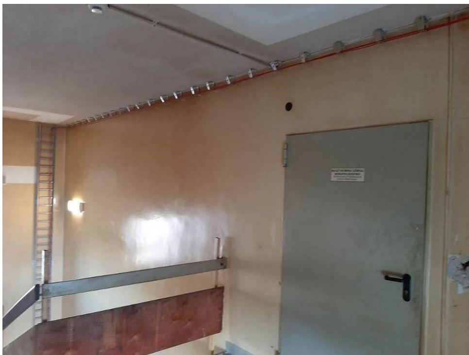
Fot. III.313. System oddymiania. Klatka c. Instalacja wykonana prawidłowo
