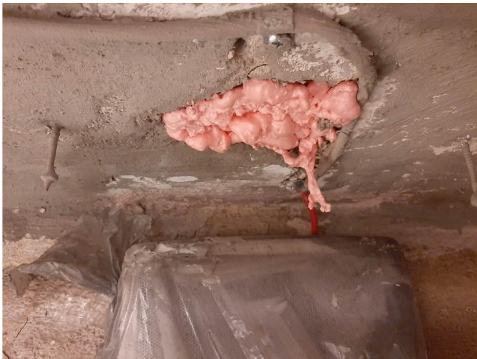
Fot. III.105. Stan techniczny instalacji systemów przeciwpożarowych piwnicy budynku „C” Nieprawidłowe prowadzenie kabli – brak odpowiedniego przepustu kablowego.
