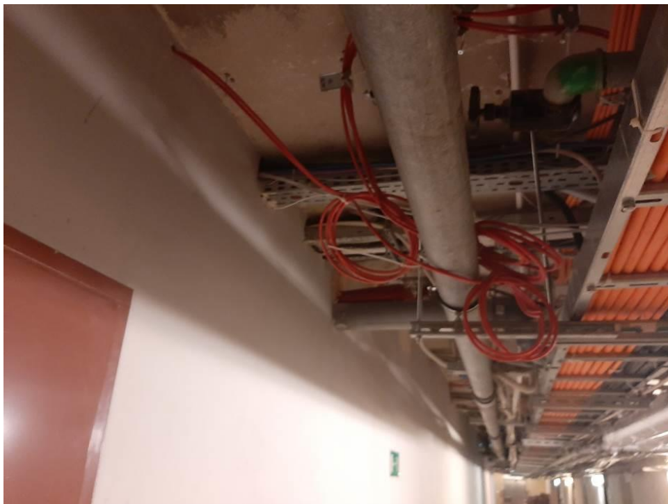
Fot.III.58. Stan techniczny instalacji systemów przeciwpożarowych piwnicy łącznika „IV” Nieprawidłowe prowadzenie kabli zasilających (pomarańczowe) – razem z innymi instalacjami. Nieprawidłowe prowadzenie kabli sygnalizacyjnych (czerwone) – brak uchwytów.
