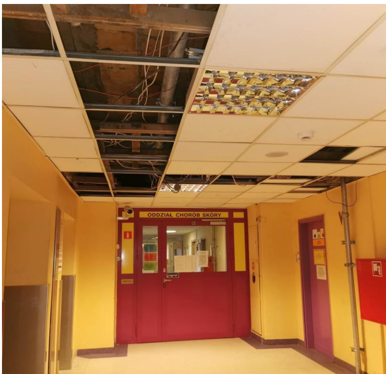
Fot. nr I.117. Ubytki sufitu powodujące swobodną migrację zanieczyszczonego powietrza pomiędzy pomieszczeniami. Brak zamontowanej stolarki drzwiowej – elementu przeciwpożarowej. BUD.C.
