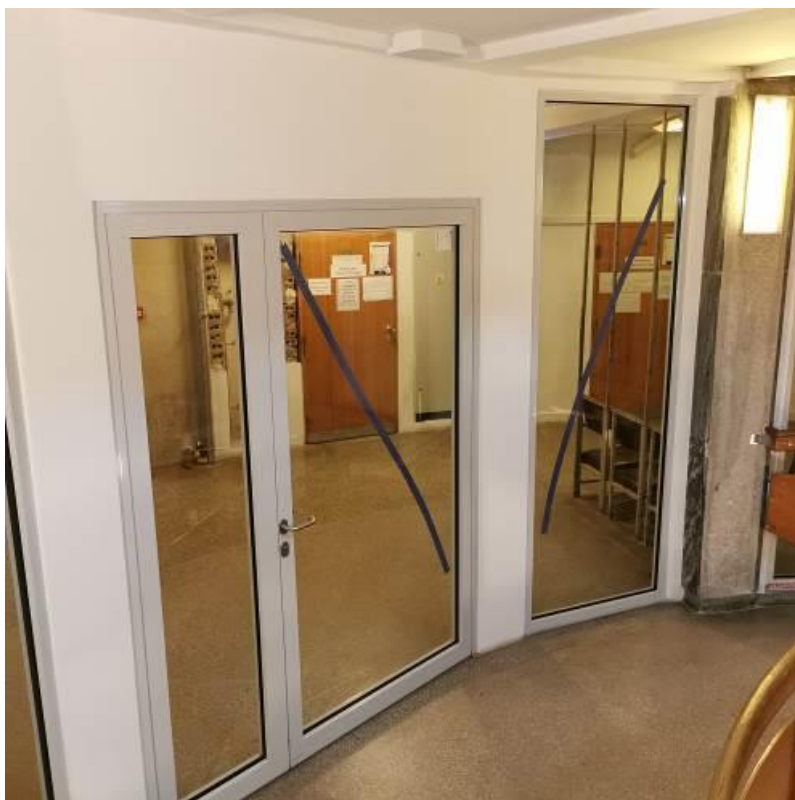
Fot. nr I.57. Wbudowana stolarka p. poż. wraz z przeszklonymi elementami ściany wewnętrznej. BUD.A.
