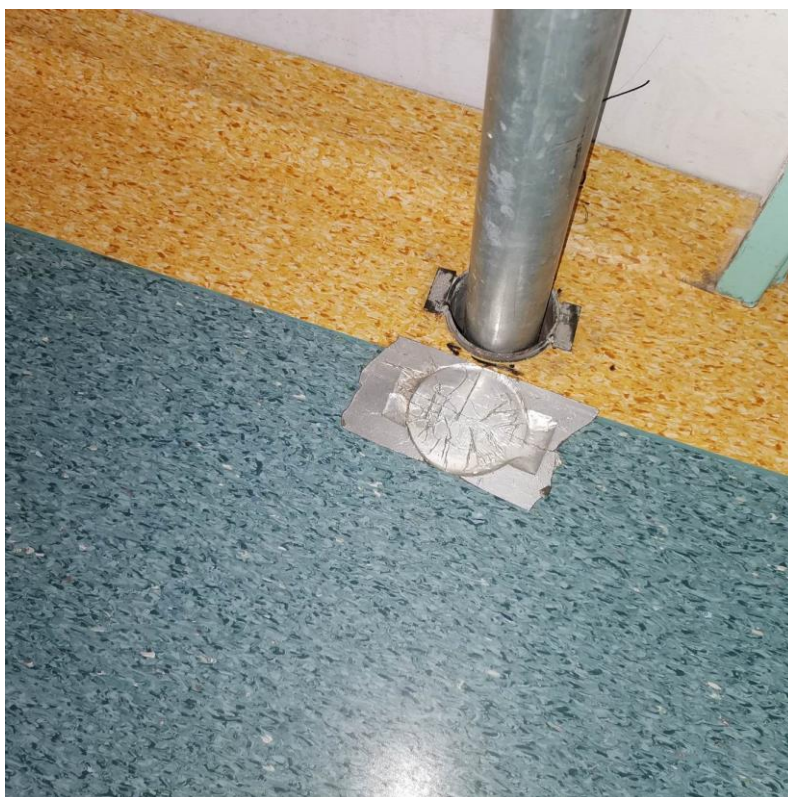
Fot. nr I.100. Uszkodzona posadzka podczas robót instalacyjnych. BUD.B.
