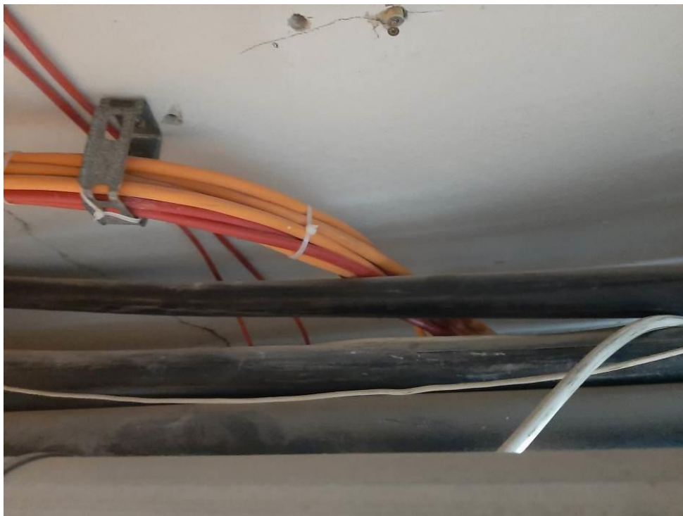
Fot.III.129. Stan techniczny instalacji systemów przeciwpożarowych piwnicy budynku „C” Nieprawidłowe prowadzenie kabli – brak uchwytów.
