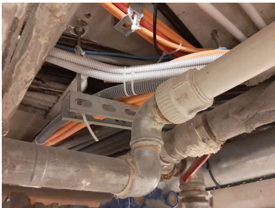
Fot. III.146. Stan techniczny instalacji systemów przeciwpożarowych piwnicy budynku „C” Poprawne ułożenie instalacji.
