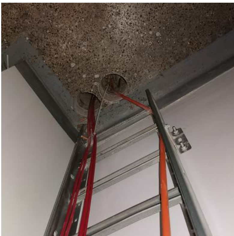
Fot. nr I.38. Brak wyposażenia przejść instalacyjnych przez strop międzykondygnacyjny. BUD.B.
