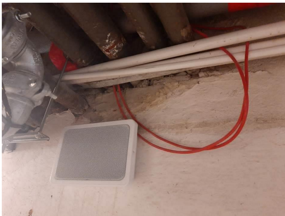
Fot. III.34. Stan techniczny instalacji systemów przeciwpożarowych piwnicy budynku „B” Nieprawidłowe prowadzenie kabli sygnalizacyjnych (czerwone) – brak uchwytów. Niepodłączony głośnik systemu DSO.
