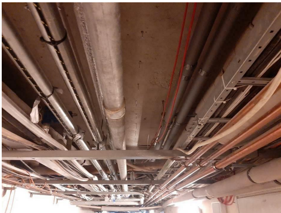
Fot. III.11. Stan techniczny instalacji systemów przeciwpożarowych piwnicy budynku „B” Prawidłowe ułożenie detektora wycieków na instalacji hydrantowej. Nieprawidłowe prowadzenie kabli zasilających (pomarańczowe) – brak uchwytyów. Nieprawidłowe prowadzenie kabli sygnalizacyjnych (czerwone) – brak uchwytyów.
