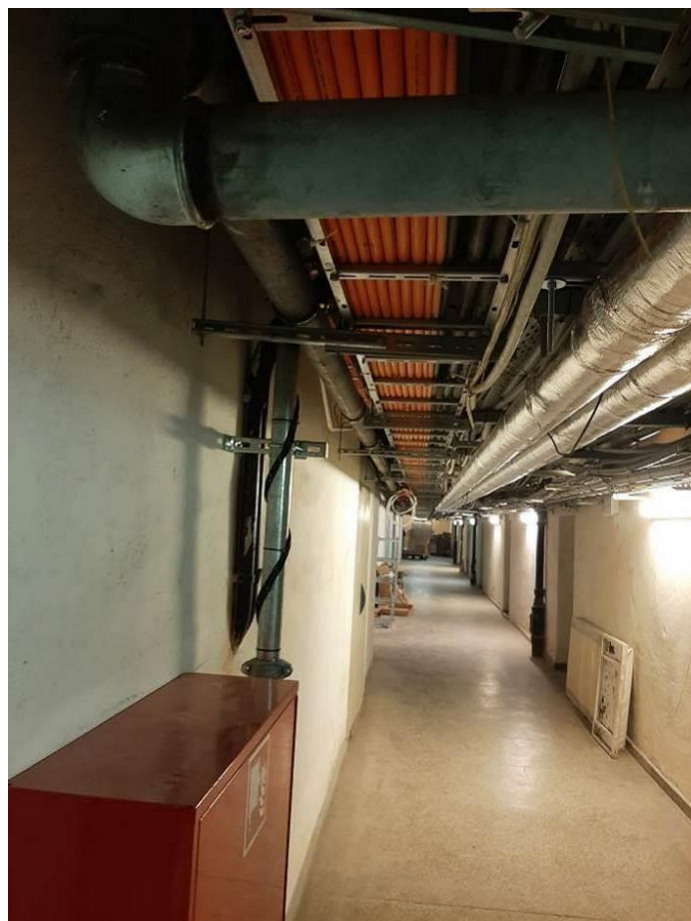
Fot. III.51. Stan techniczny instalacji systemów przeciwpożarowych piwnicy łącznika „IV” Nieprawidłowe prowadzenie kabli zasilających (pomarańczowe) – razem z innymi instalacjami. Prawidłowe prowadzenie detektora wycieków na instalacji hydrantowej.
