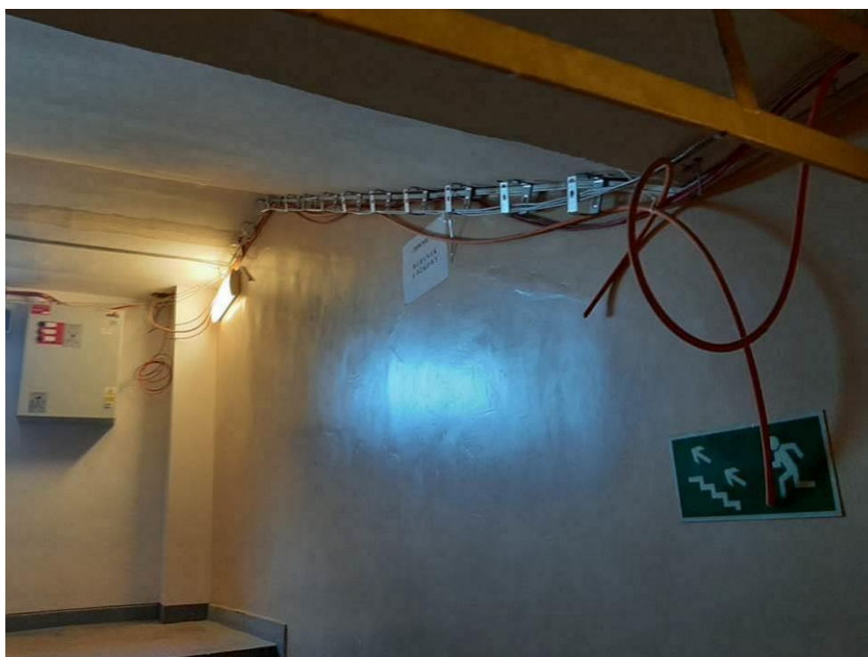
Fot. III.108. Stan techniczny instalacji systemów przeciwpożarowych piwnicy budynku „C” Nieprawidłowe prowadzenie kabli – brak uchwytów, niepodłączone urządzenie końcowe.
