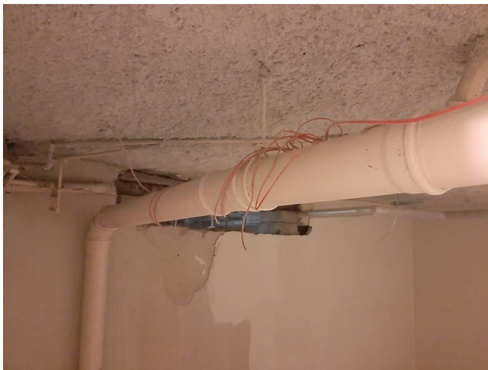
Fot. III.181. Stan techniczny instalacji systemów przeciwpożarowych piwnicy budynku „C” Nieprawidłowe prowadzenie kabli – brak uchwytów. Niezakończona instalacja.
