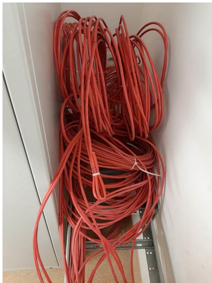
Fot. III.366. Pomieszczenie techniczne. Okablowanie DSO. Niedokończona instalacja. Przewody niepodłączone do urządzeń nadzorujących w szafie DSO.
