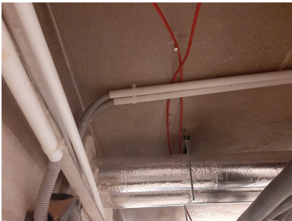
Fot. III.33. Stan techniczny instalacji systemów przeciwpożarowych piwnicy budynku „B” Nieprawidłowe prowadzenie kabli sygnalizacyjnych (czerwone) – brak uchwytów.
