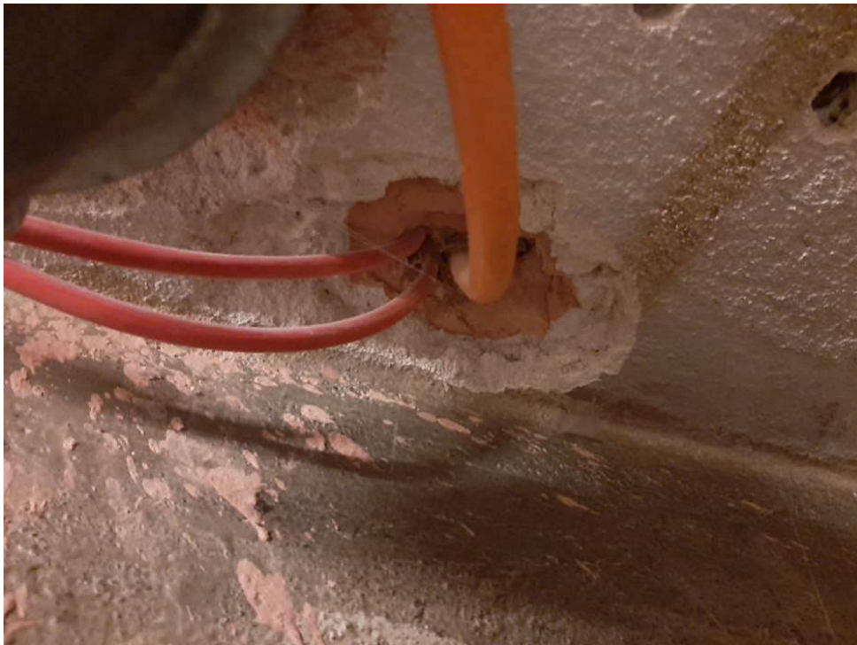
Fot. III.114. Stan techniczny instalacji systemów przeciwpożarowych piwnicy budynku „C” Nieprawidłowe prowadzenie kabli – brak uchwytów, brak odpowiedniego przepustu kablowego.
