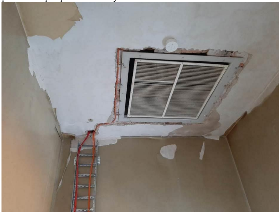
Fot. III.336. System oddymiania. Klatka d. Niedokończona instalacja. Brak odpowiednich przepustów kablowych.
