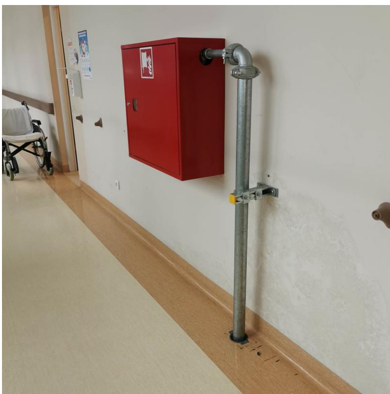
Fot. nr I.72. Lokalizacja hydrantu powoduje pogorszenie swobodnej komunikacji dla chorych i obsługi personelu. BUD.C.
