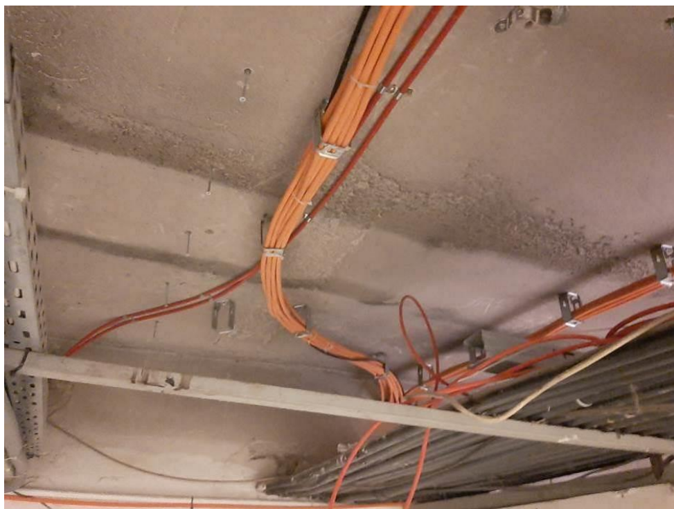
Fot.III.41. Stan techniczny instalacji systemów przeciwpożarowych piwnicy budynku „B” Nieprawidłowe prowadzenie kabli zasilających (pomarańczowe) – razem i inną instalacją. Nieprawidłowe prowadzenie kabli sygnalizacyjnych (czerwone) – brak uchwytów.
