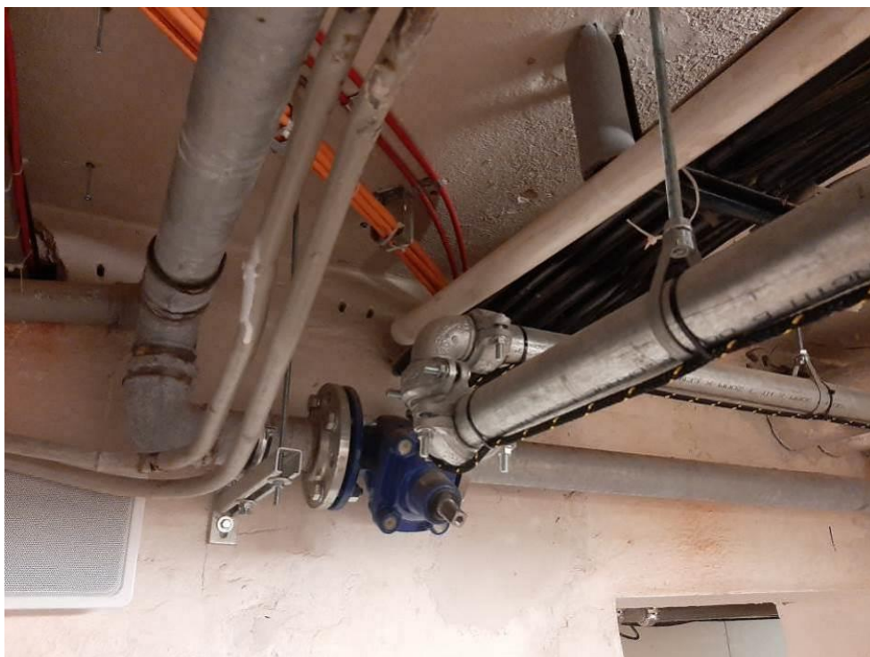
Fot. III.187. Stan techniczny instalacji systemów przeciwpożarowych piwnicy budynku „C” Poprawne prowadzenie instalacji.
