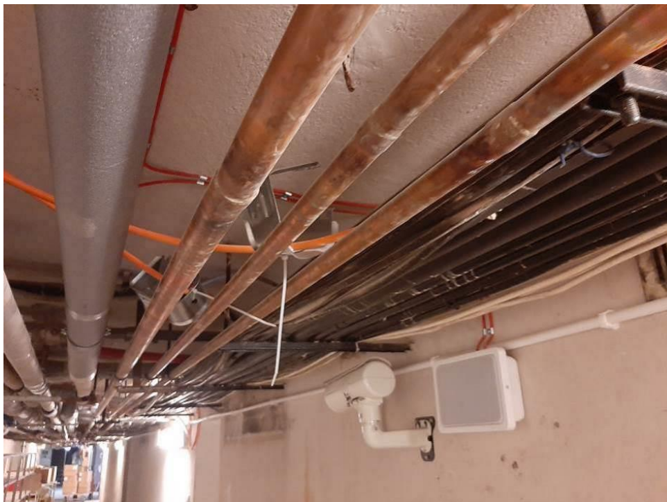
Fot. III.163. Stan techniczny instalacji systemów przeciwpożarowych piwnicy budynku „C” Nieprawidłowe prowadzenie kabli – brak uchwytów.
