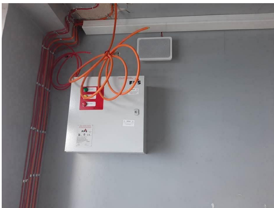
Fot. III.275. System oddymiania. Klatka g. Niedokończona instalacja.
