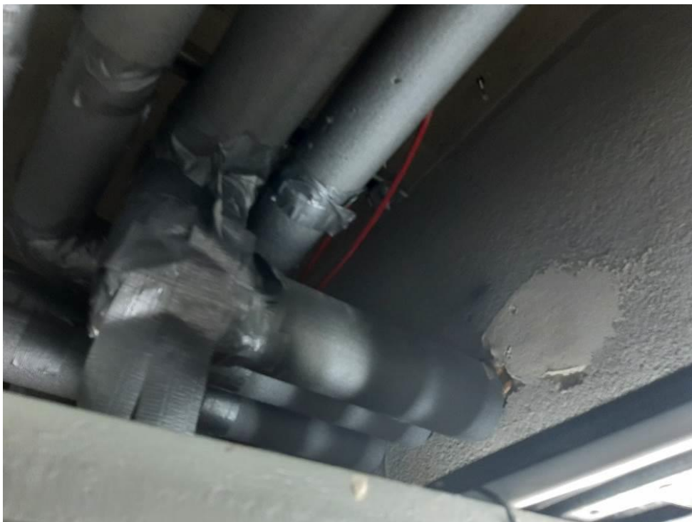
Fot. III.27. Stan techniczny instalacji systemów przeciwpożarowych piwnicy budynku „B” Nieprawidłowe prowadzenie kabli sygnalizacyjnych (czerwone) – brak uchwytów.
