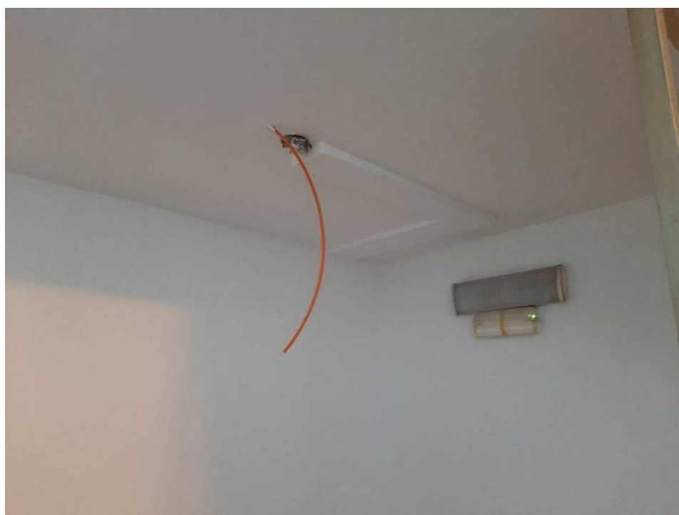
Fot. III.304. System oddymiania. Klatka a. Niedokończona instalacja. Brak urządzeń końcowych
