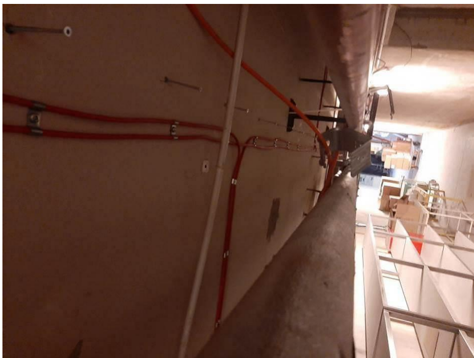
Fot. III.169. Stan techniczny instalacji systemów przeciwpożarowych piwnicy budynku „C” Nieprawidłowe prowadzenie kabli – brak uchwytów.
