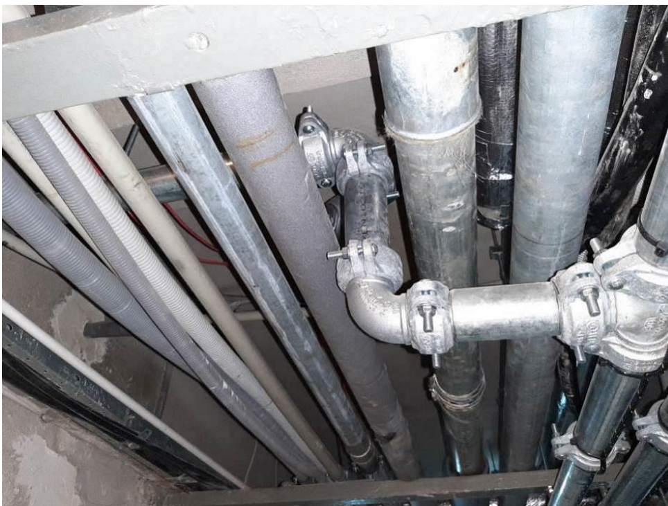
Fot.III.249. Montaż liniowego detektora wycieku na instalacji hydrantowej. Fragment instalacji nieobjętej detekcją wycieku.
