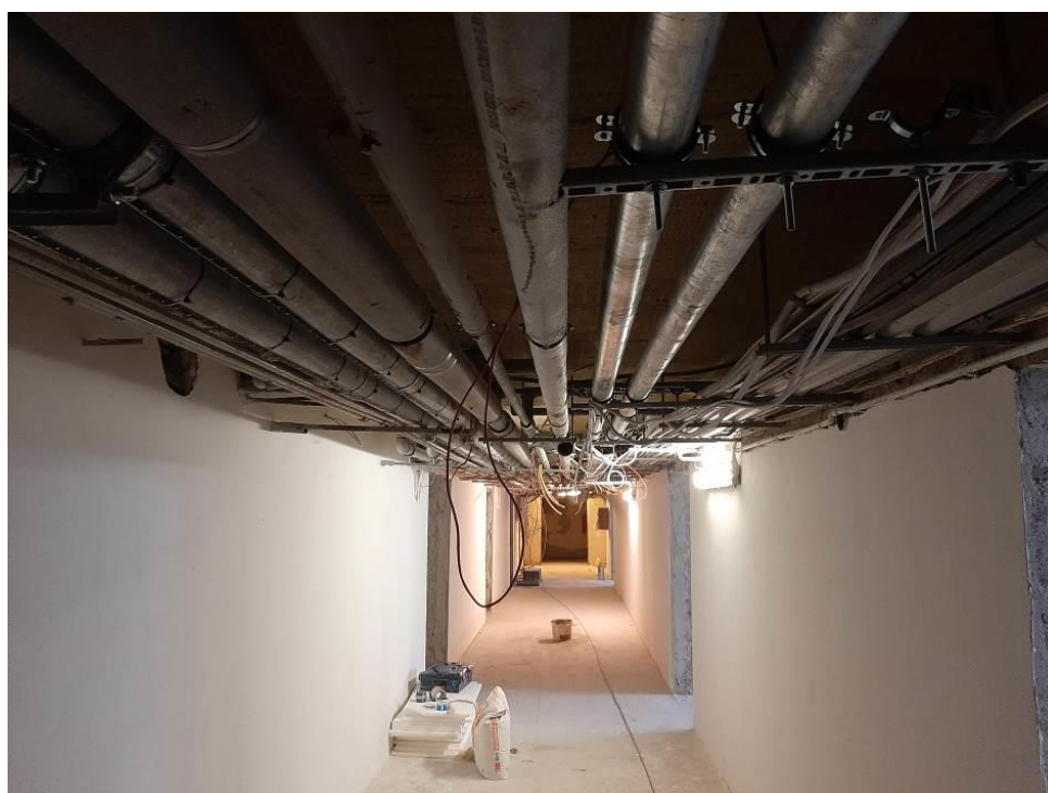
Fot. III.178. Stan techniczny instalacji systemów przeciwpożarowych piwnicy budynku „C” Nieprawidłowe prowadzenie kabli – brak uchwytów.
