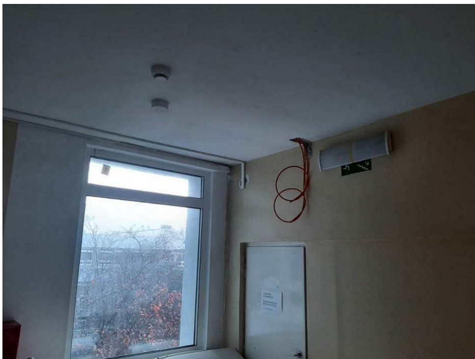
Fot. III.325. System oddymiania. Klatka c. Niedokończona instalacja. Brak urządzeń końcowych. Brak odpowiednich przepustów kablowych.
