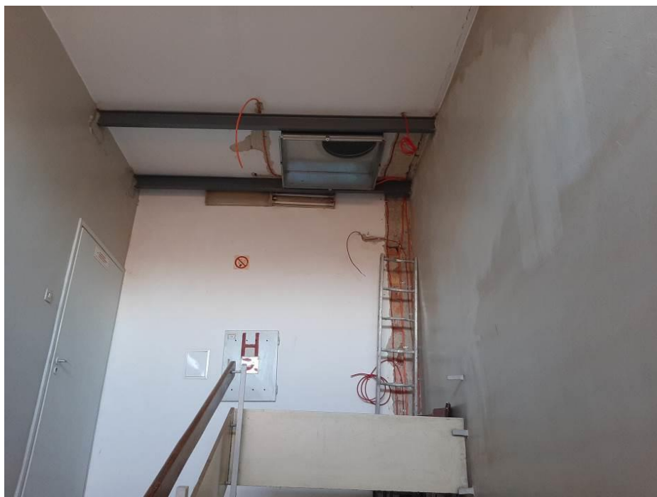
Fot. III.254. System oddymiania. Klatka h. Niedokończona instalacja. Brak urządzeń końcowych.
