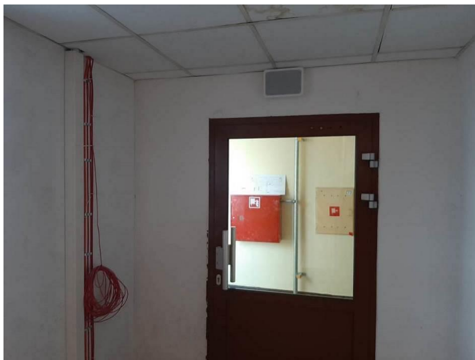
Fot. III.283. System oddymiania. Klatka g. Niedokończona instalacja. Brak odpowiedniego przepustu kablowego.
