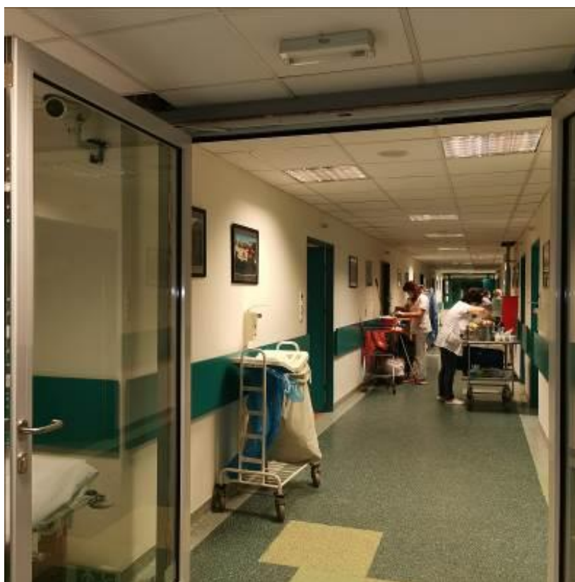
Fot. nr I.26. Wbudowane drzwi pożarowe. Brak realizowania robót wykończeniowych. BUD.C
