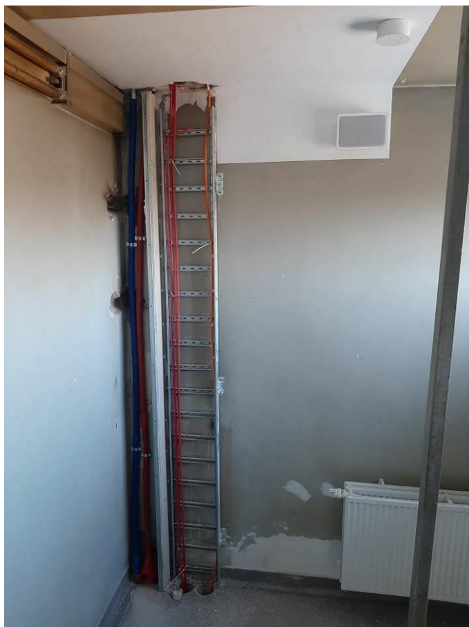
Fot. III.340. System oddymiania. Klatka d. Niedokończona instalacja. Brak odpowiednich przepustów kablowych.
