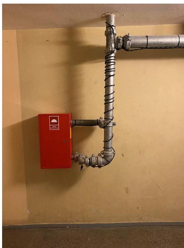
Fot. II.6. Piwnica budynku diagnostycznego B- Instalacja nie jest zaizolowana i nie jest prowadzona w pionie. Izolacja jest zapisana w projekcie. Odcinki bez pionu wymagają korekty.
