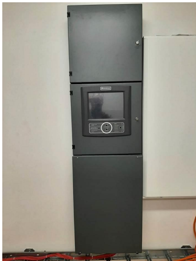
Fot. III.375. Pomieszczenie techniczne. Szafa systemu sygnalizacji pożaru.
