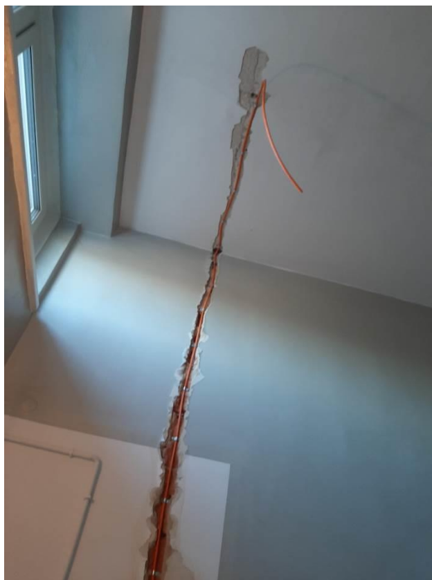
Fot. III.259. System oddymiania. Klatka h. Niedokończona instalacja. Brak urządzeń końcowych.
