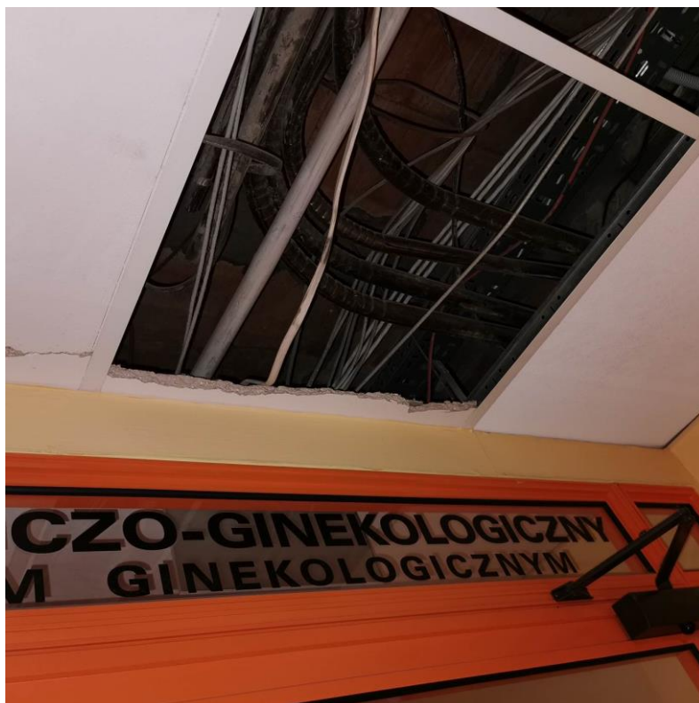
Fot. nr I.83. Uszkodzone i usunięte elementy sufitu systemowego. BUD.C.
