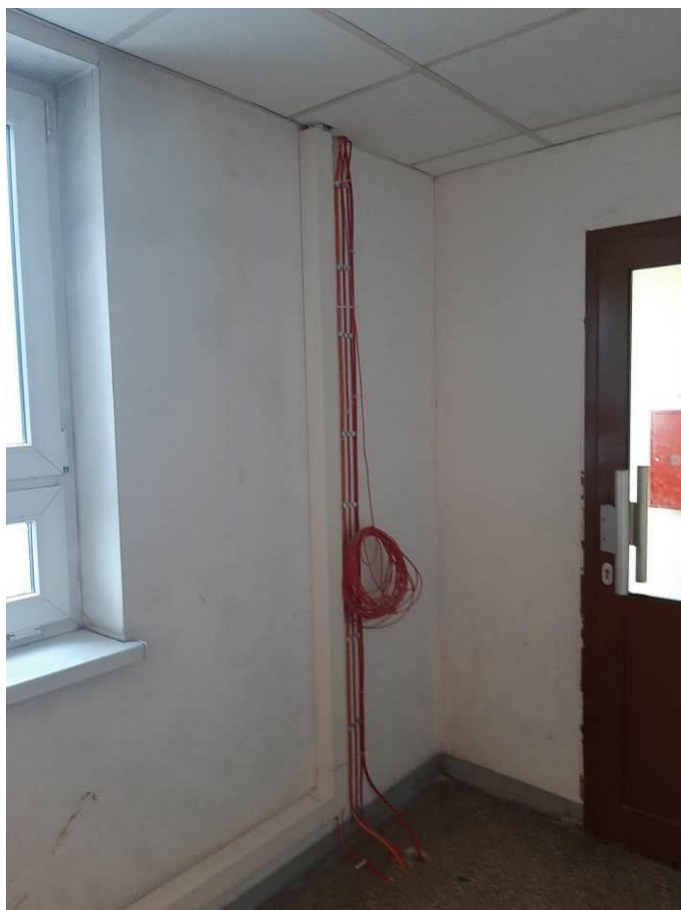
Fot. III.282. System oddymiania. Klatka g. Niedokończona instalacja. Brak odpowiedniego przepustu kablowego.
