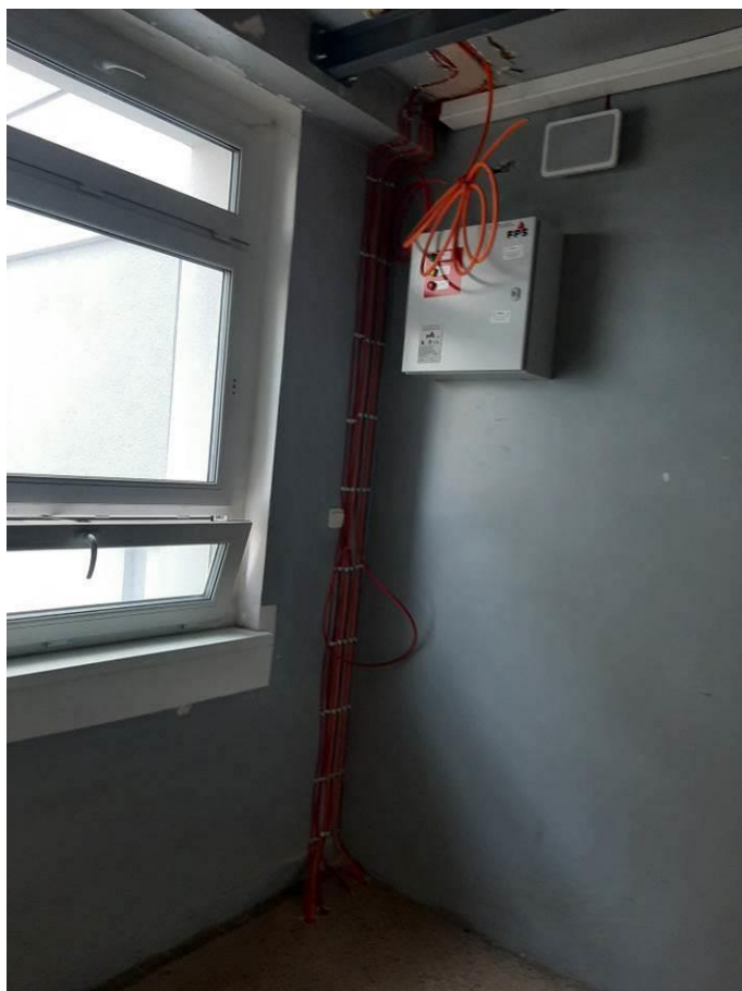
Fot. III.278. System oddymiania. Klatka g. Niedokończona instalacja. Brak odpowiedniego przepustu kablowego.
