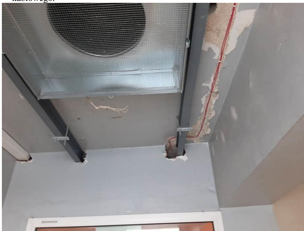
Fot. III.277. System oddymiania. Klatka g. Niedokończona instalacja. Brak odpowiedniego przepustu kablowego.
