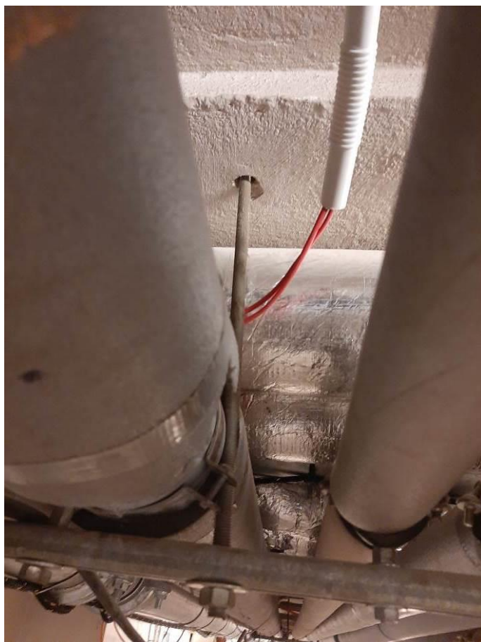
Fot. III.149. Stan techniczny instalacji systemów przeciwpożarowych piwnicy budynku „C” Nieprawidłowe prowadzenie kabli – brak uchwytów.
