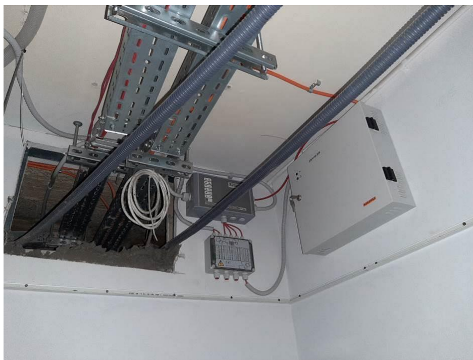
Fot. III.224. System detekcji ciepła LISTEC. Budynek „C”. Brak uchwytów kablowych.
