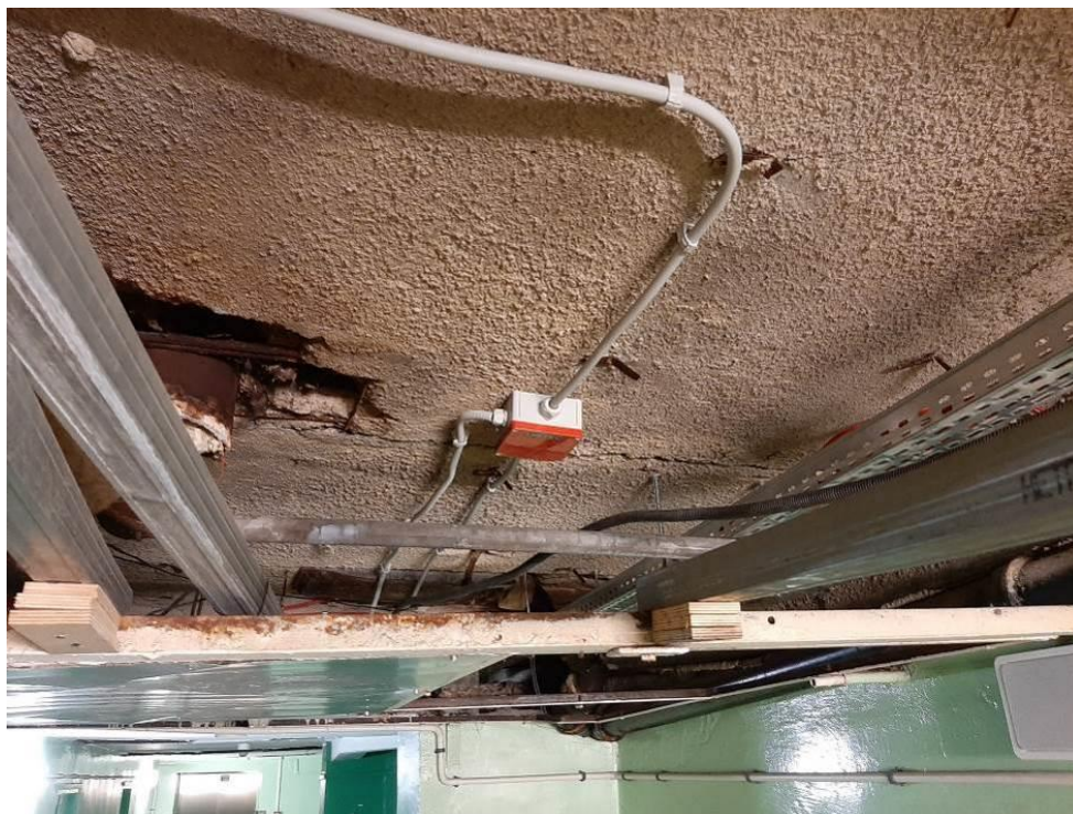
Fot. III.238. System detekcji ciepła LISTEC. Budynek „B” parter. Prawidłowo wykonana instalacja.
