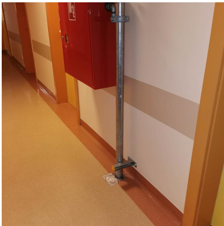
Fot. nr I.71. Uszkodzona posadzka podczas prac instalacyjnych. BUD.C.
