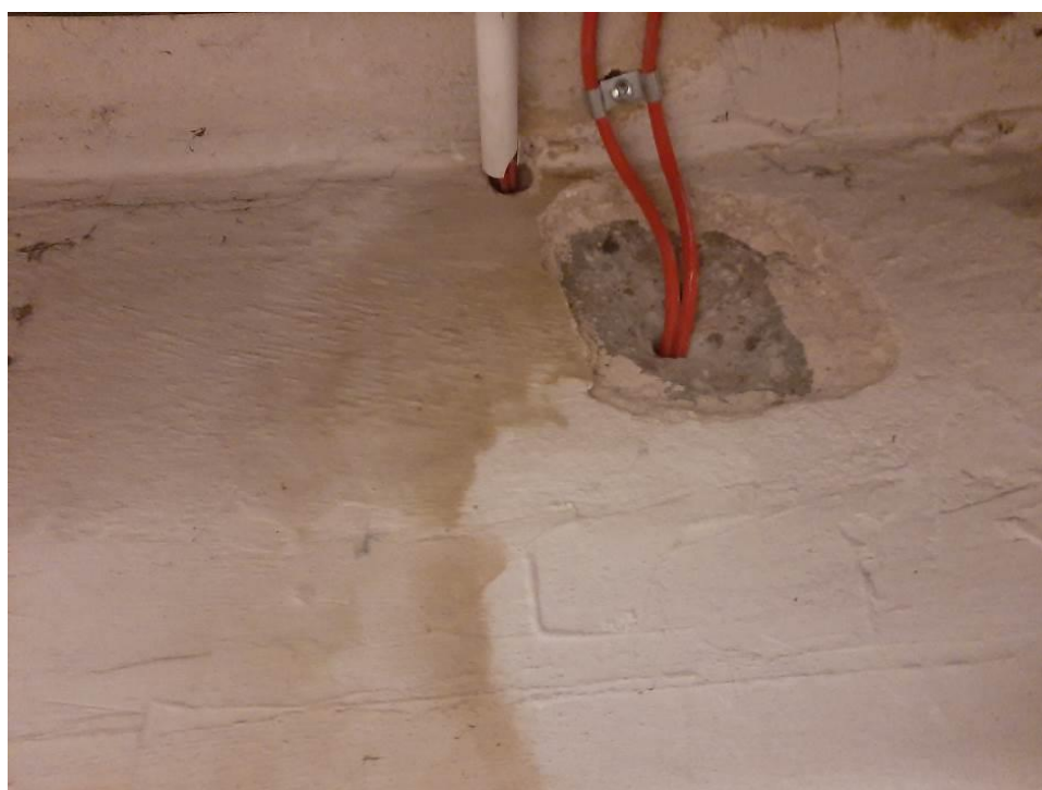
Fot. III.144. Stan techniczny instalacji systemów przeciwpożarowych piwnicy budynku „C” Nieprawidłowe prowadzenie kabli - brak odpowiedniego przepustu kablowego.
