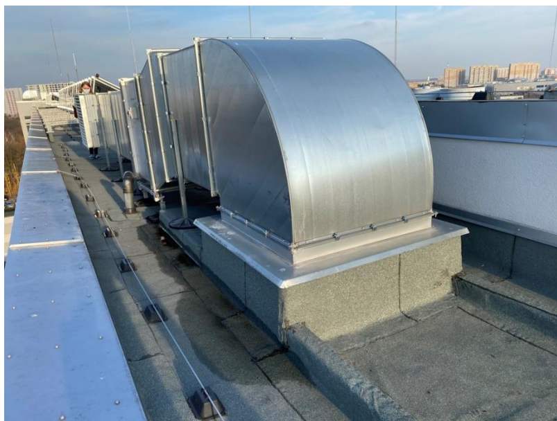
Fot. II.27. Dach budynku łózkowego C- Brak zasilania. Wykonanie instalacji wentylacji pożarowej nie pokrywa się z projektem budowlanym.
