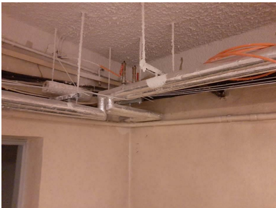
Fot. III.88. Stan techniczny instalacji systemów przeciwpożarowych piwnicy budynku „C” Nieprawidłowe prowadzenie kabli zasilających (pomarańczowe) – brak uchwytów. Nieprawidłowe prowadzenie kabli sygnalizacyjnych (czerwone) – przykrycie izolacją.
