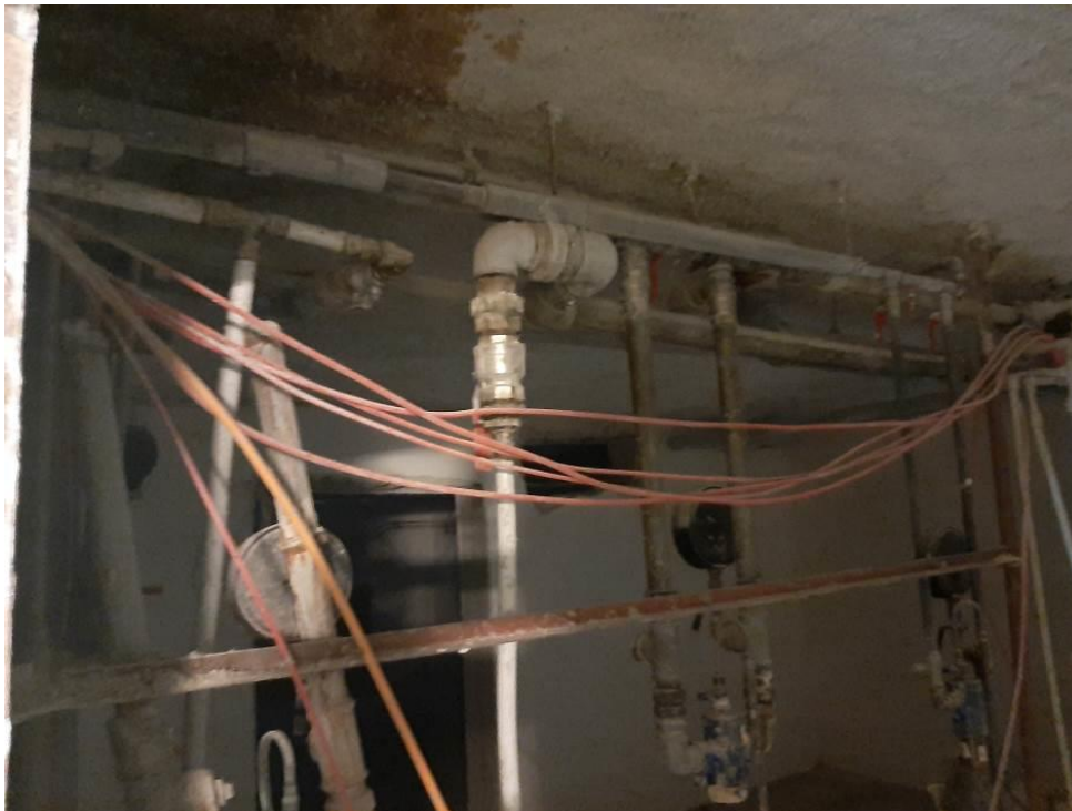
Fot. III.183. Stan techniczny instalacji systemów przeciwpożarowych piwnicy budynku „C” Nieprawidłowe prowadzenie kabli – brak uchwytów.
