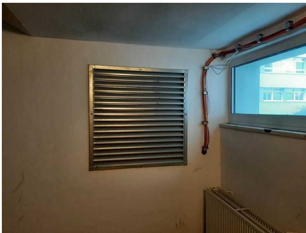
Fot. III.332. System oddymiania. Klatka c. Brak odpowiednich przepustów kablowych.
