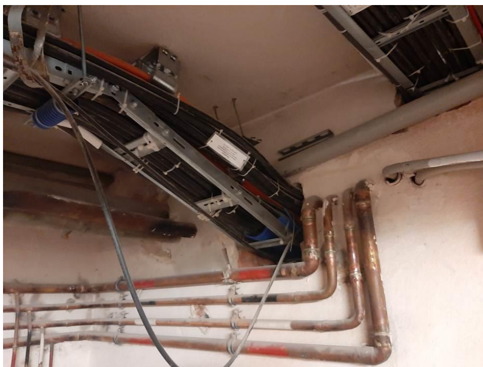
Fot. III.188. Stan techniczny instalacji systemów przeciwpożarowych piwnicy budynku „C” Brak stosownych przepustów kablowych.
