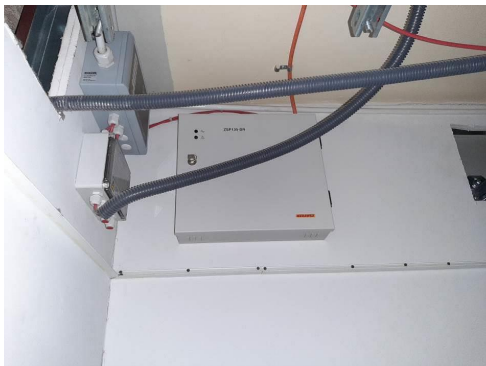
Fot. III.220. System detekcji ciepła LISTEC. Budynek „C”. Brak uchwytów kablowych.
