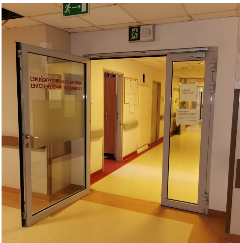
Fot. nr I.76. Drzwi na granicy stref pożarowych w budynku. BUD.C.
