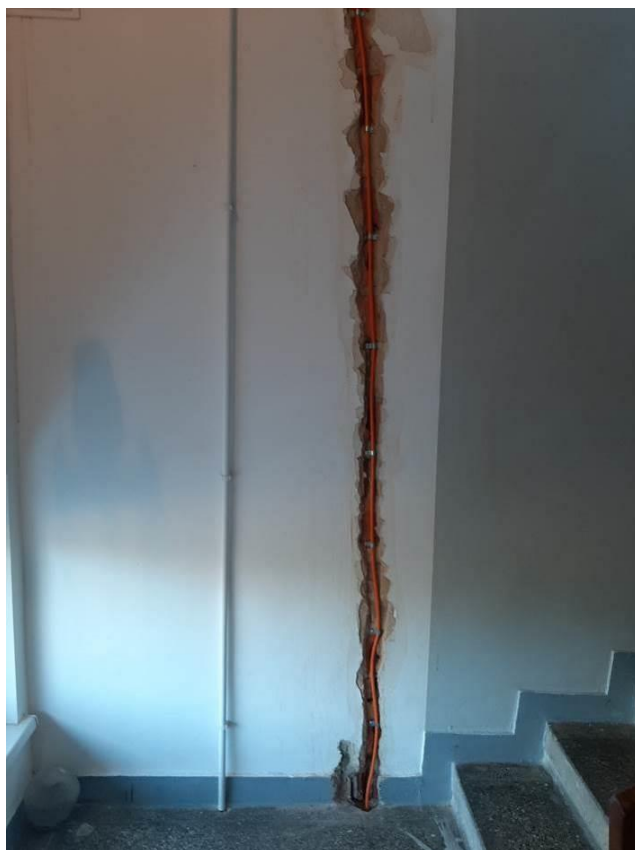
Fot. III.258. System oddymiania. Klatka h. Niedokończona instalacja.
