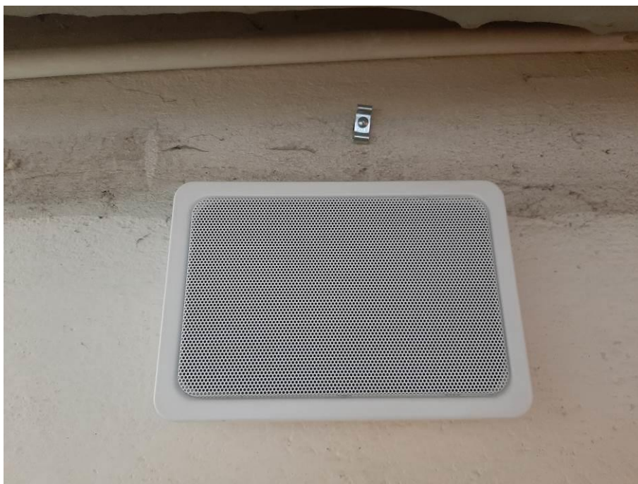
Fot. III.201. Stan techniczny instalacji systemów przeciwpożarowych piwnicy łącznika „II” Brak instalacji do głośnika systemu DSO.
