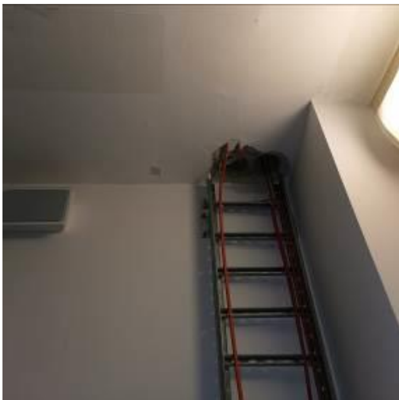
Fot. nr I.33. Brak wykonania prawidłowego przejścia przez strop na potrzeby prowadzenia instalacji. BUD.B.
