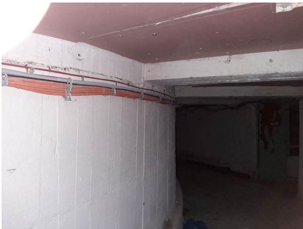
Fot. III.213. Stan techniczny instalacji systemów przeciwpożarowych piwnicy rotundy Prawidłowe prowadzenie instalacji. Brak wyposażenia systemu SSP.
