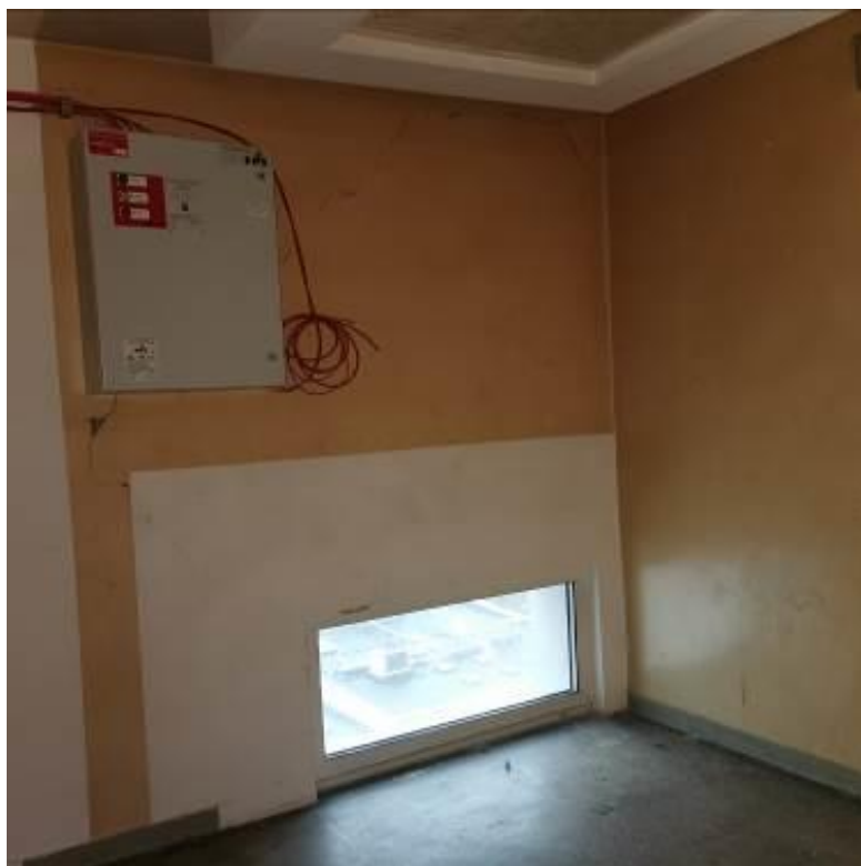
Fot. nr I.29. Uszkodzona ścian pod urządzeniem instalacyjnym. BUD.C.
