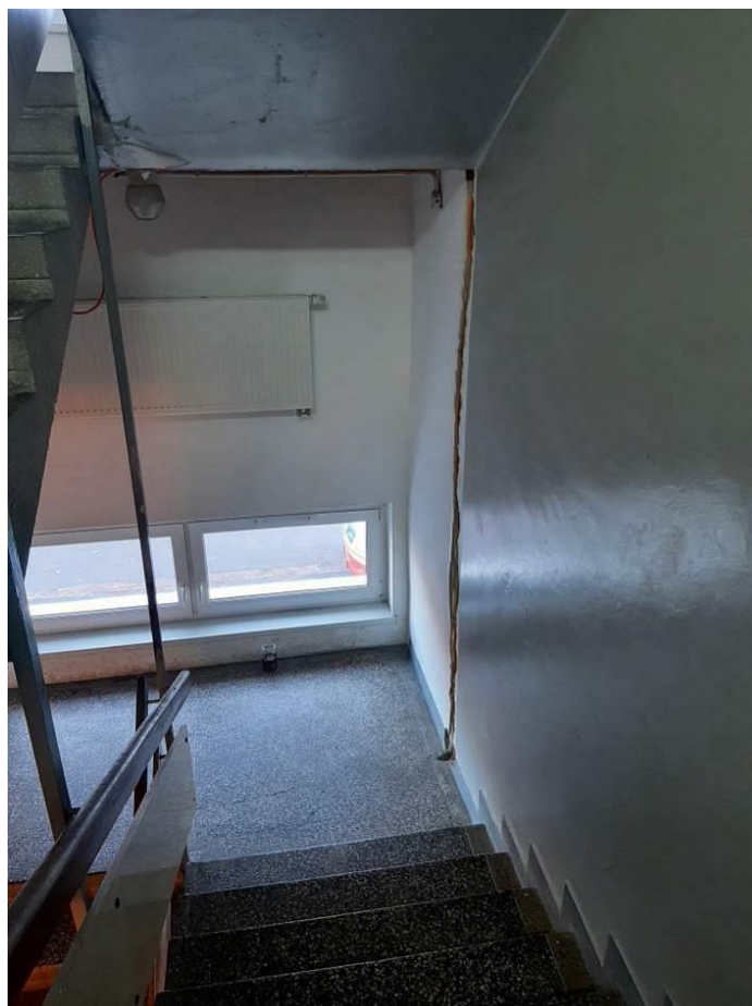
Fot. III.262. System oddymiania. Klatka h. Niedokończona instalacja. Brak urządzeń końcowych.
