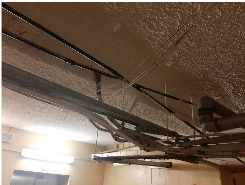
Fot. III.77. Stan techniczny instalacji systemów przeciwpożarowych piwnicy budynku „C” Nieprawidłowe prowadzenie kabli sygnalizacyjnych (czerwone) – brak uchwytów.
