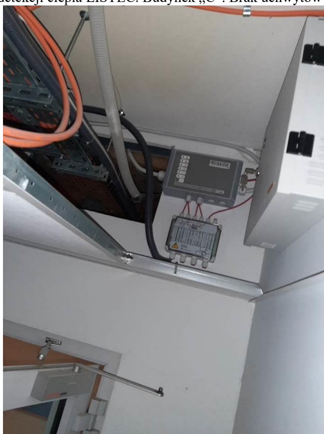
Fot. III.228. System detekcji ciepła LISTEC. Budynek „C”. Brak uchwytyów kablowych.
