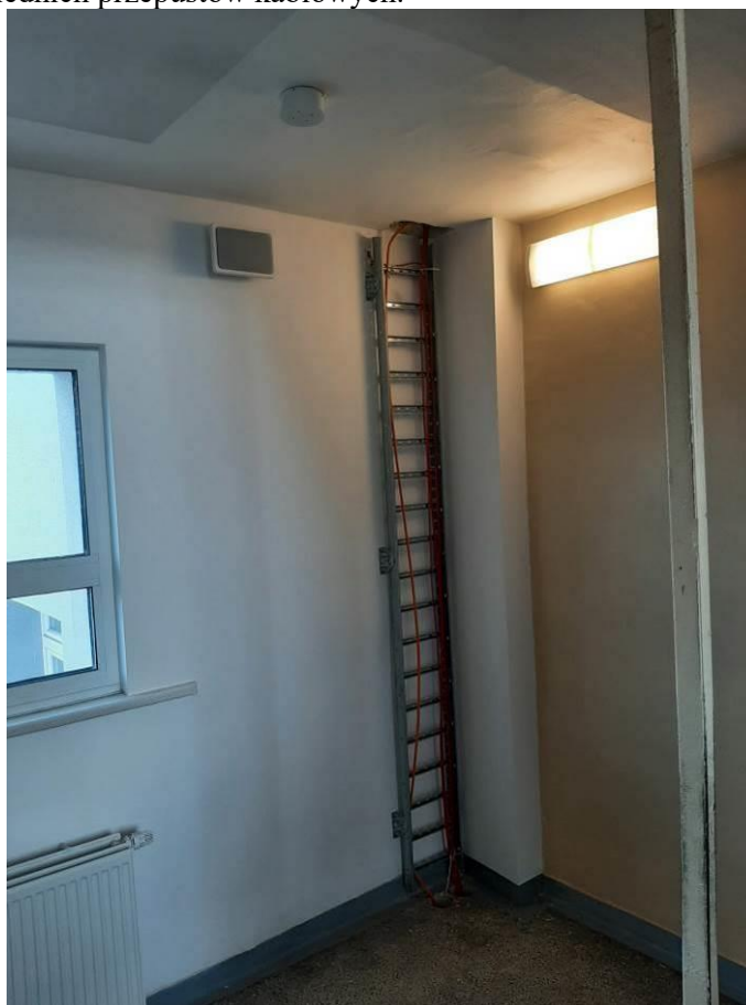
Fot. III.326. System oddymiania. Klatka c. Niedokończona instalacja. Brak odpowiednich przepustów kablowych.
