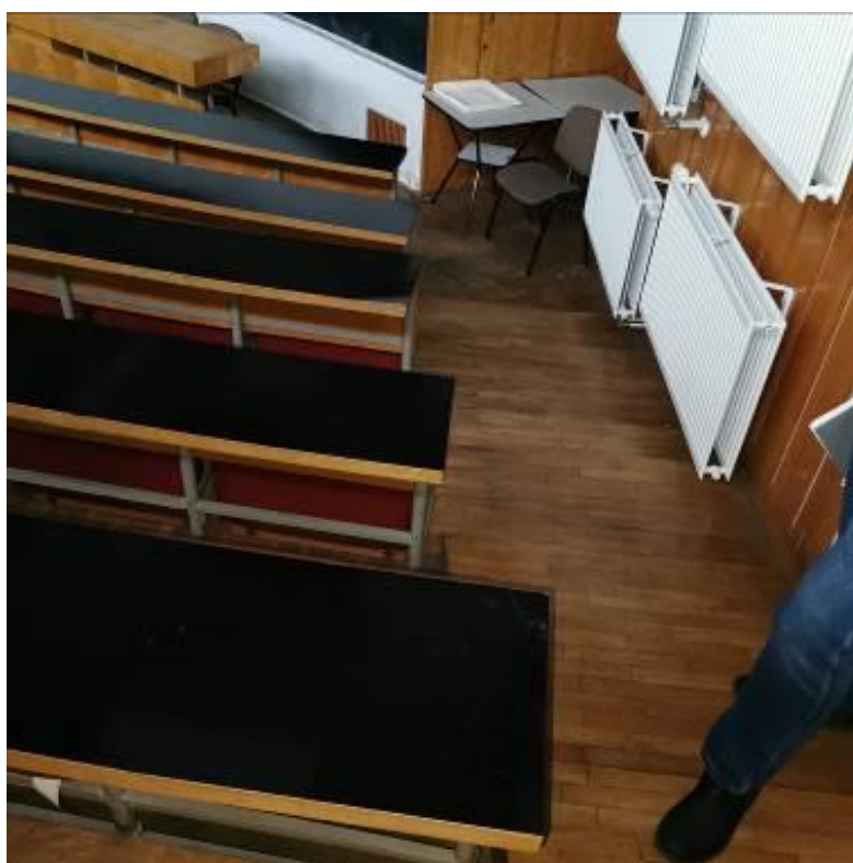
Fot. nr I.48. Brak usunięcia łatwopalnych elementów posadzki i wyposażenia z wnętrza pomieszczenia Sali wykładowej. BUD.A.
