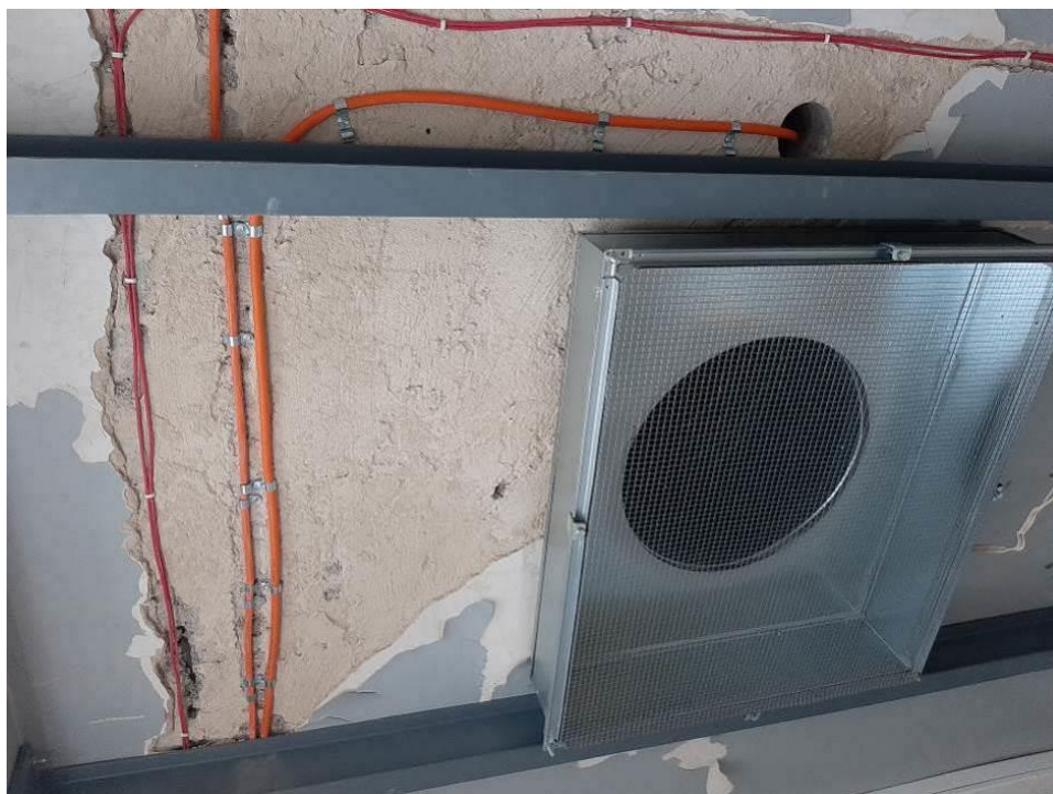
Fot. III.276. System oddymiania. Klatka g. Niedokończona instalacja. Brak odpowiedniego przepustu kablowego.
