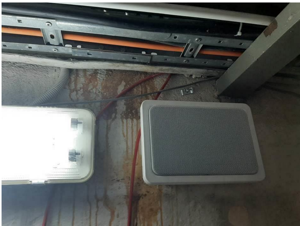
Fot. III.21. Stan techniczny instalacji systemów przeciwpożarowych piwnicy budynku „B” Nieprawidłowe prowadzenie kabli sygnalizacyjnych (czerwone) – brak uchwytów. Niepodłączony głośnik systemu DSO.
