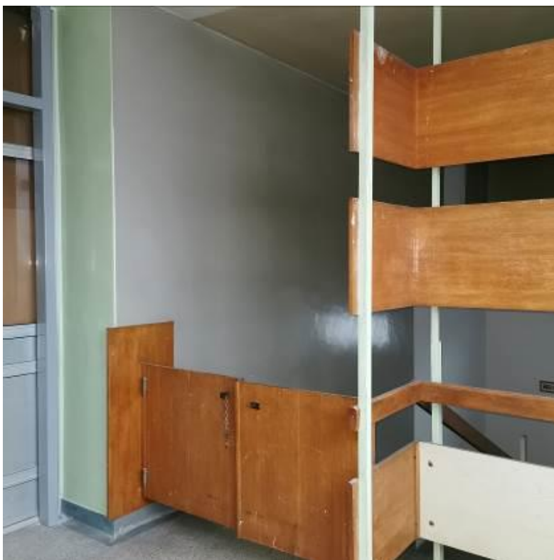
Fot. nr I.21. Elementy łatwopalne przewidziane do usunięcia, Brak realizacji założeń ekspertyzy P. poż. BUD.B
