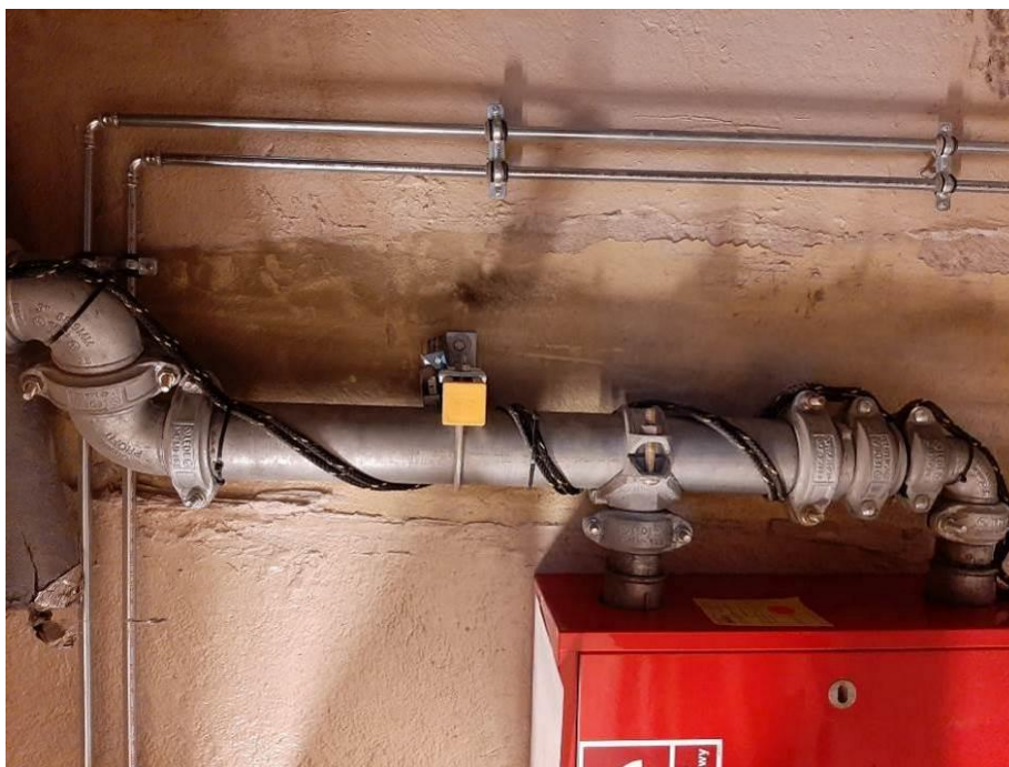
Fot. III.246. Montaż liniowego detektora wycieku na instalacji hydrantowej. Prawidłowo wykonana instalacja.
