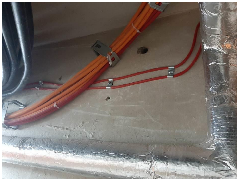
Fot. III.128. Stan techniczny instalacji systemów przeciwpożarowych piwnicy budynku „C” Nieprawidłowe prowadzenie kabli – niezamocowane uchwyty.
