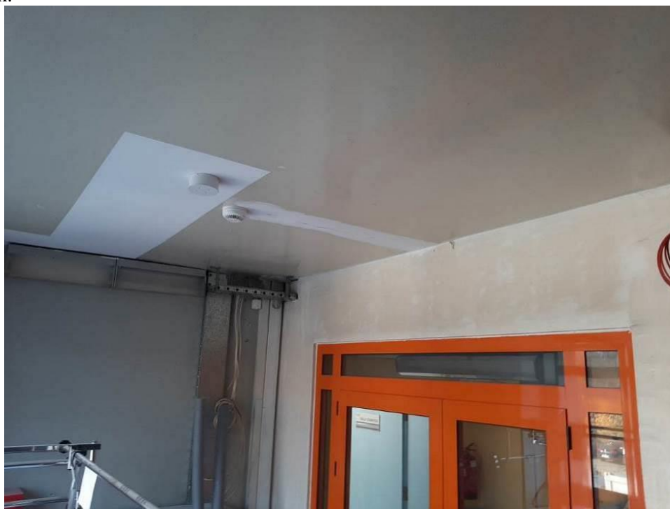
Fot. III.347. System oddymiania. Klatka d. Instalacja wykonana prawidłowo
