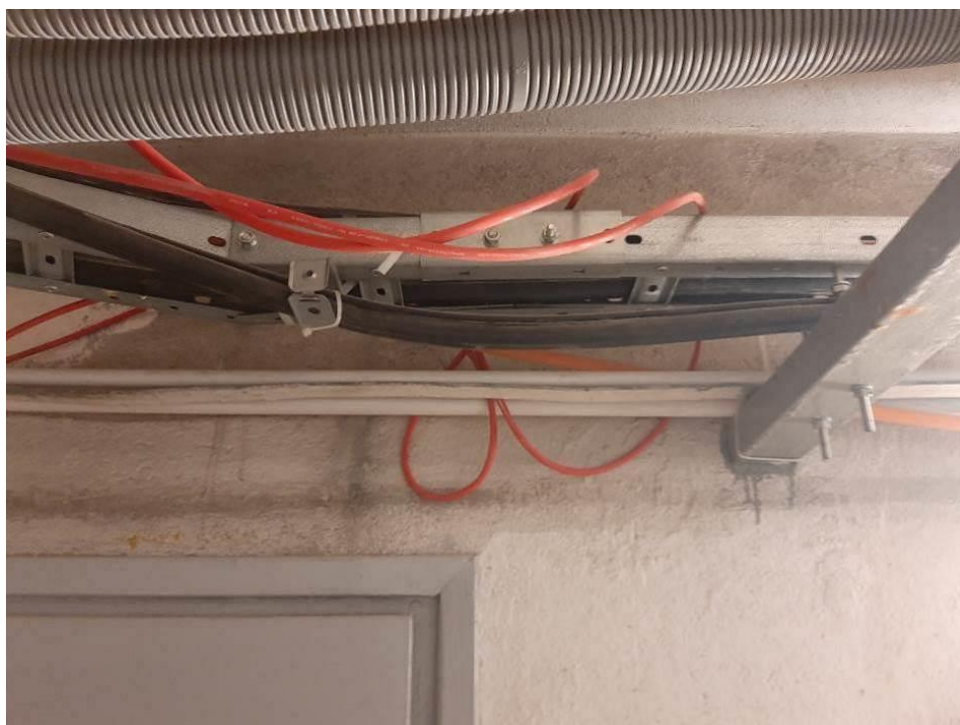
Fot. III.32. Stan techniczny instalacji systemów przeciwpożarowych piwnicy budynku „B” Nieprawidłowe prowadzenie kabli sygnalizacyjnych (czerwone) – brak uchwytów.
