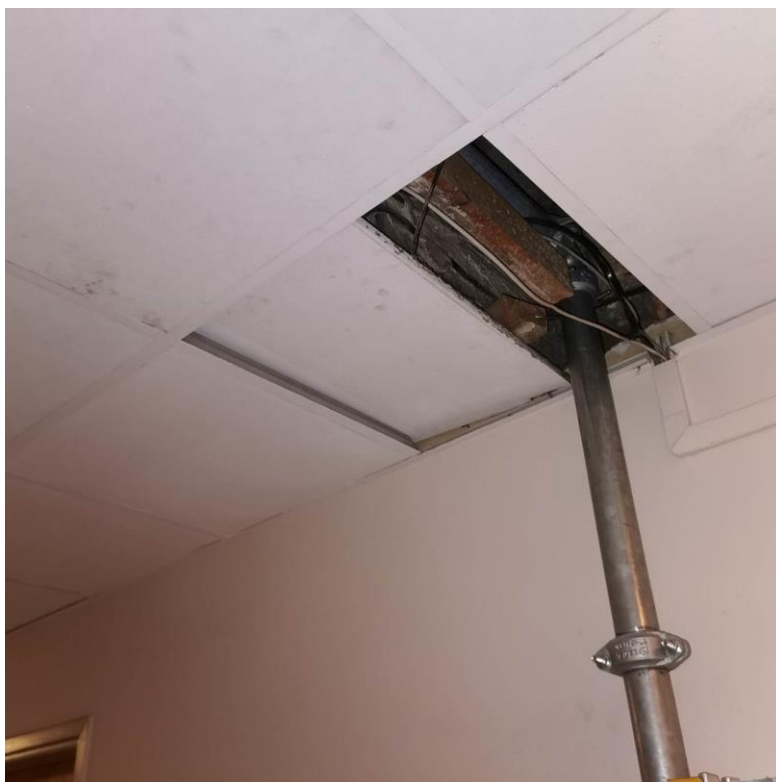
Fot. nr I.115. Ubytki sufitu powodujące swobodną migrację zanieczyszczonego powietrza pomiędzy pomieszczeniami. BUD.D.
