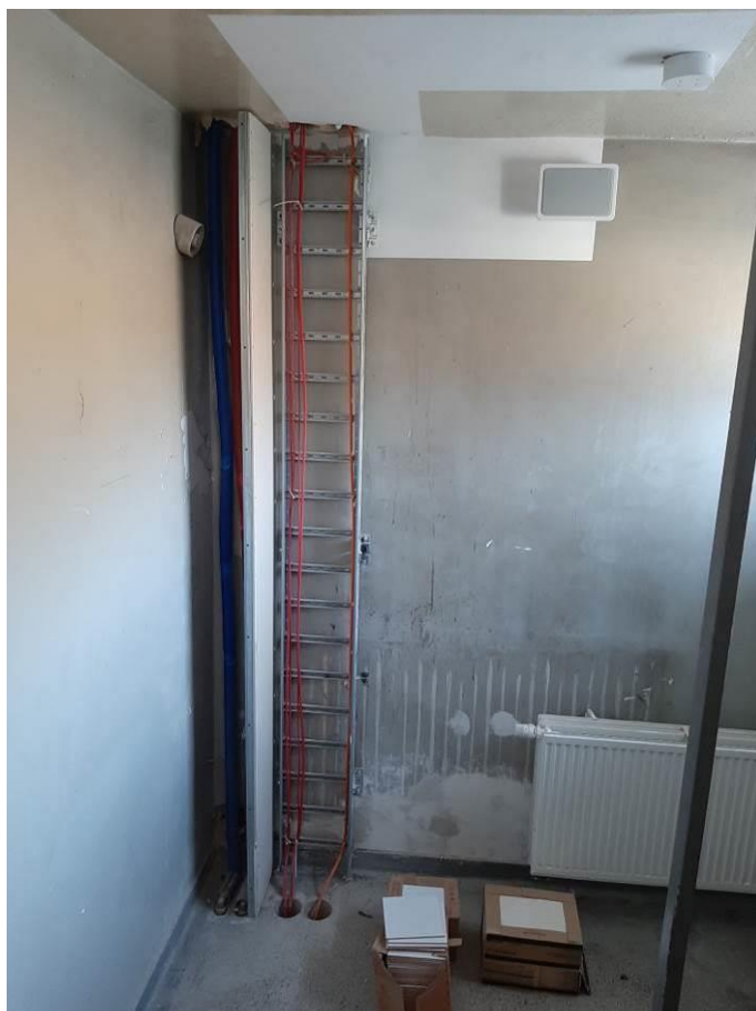
Fot. III.348. System oddymiania. Klatka d. Niedokończona instalacja. Brak odpowiednich przepustów kablowych.
