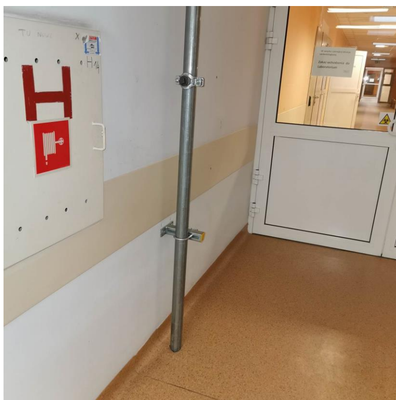
Fot. nr I.74. Brak zabudowy instalacji hydrantowej powoduje trudności w utrzymaniu warunków higienicznych. BUD.C.
