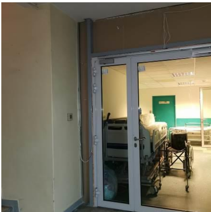
Fot. nr I.34. Brak ukończenia robót budowlanych wykończeniowych (ściana oddzielenia p. poż.) BUD.B.
