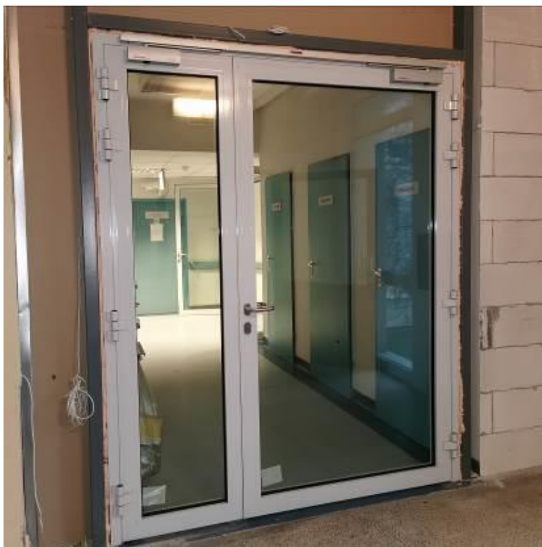
Fot. nr I.37. Brak ukończenia robót budowlanych wykończeniowych. BUD. B.
