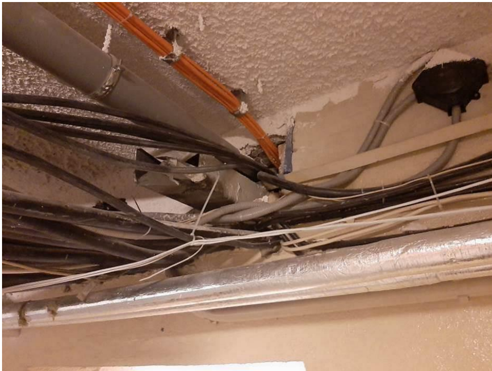
Fot. III.89. Stan techniczny instalacji systemów przeciwpożarowych piwnicy budynku „C” Nieprawidłowe prowadzenie kabli zasilających (pomarańczowe) – brak odpowiedniego przepustu kablowego.
