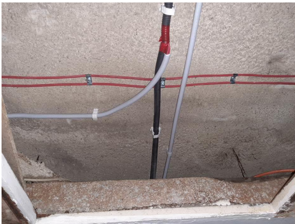
Fot. III.243. System detekcji ciepła LISTEC. Budynek „B” parter. Prawidłowo wykonana instalacja.
