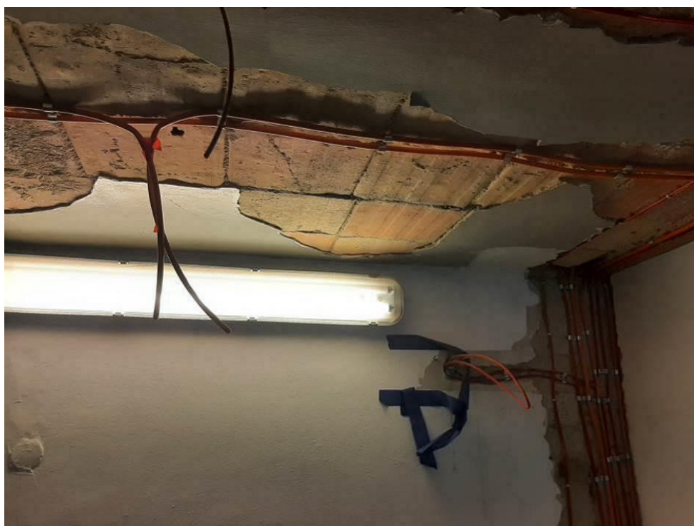
Fot. III.267. System oddymiania. Klatka h. Niedokończona instalacja. Brak urządzeń końcowych.
