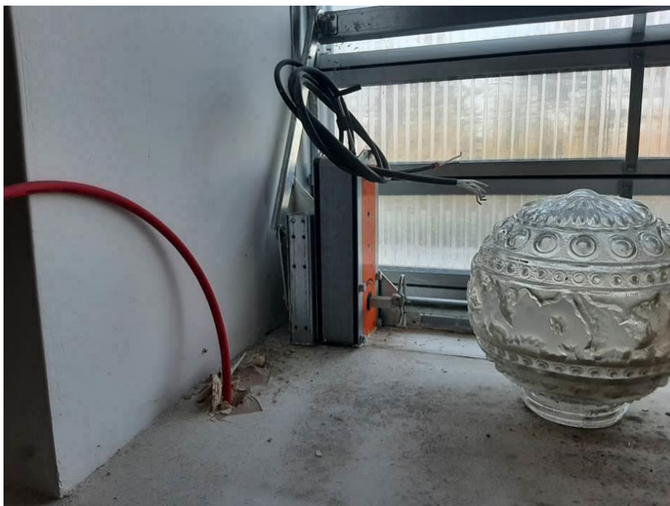
Fot. III.274. System oddymiania. Klatka h. Niedokończona instalacja. Brak urządzeń końcowych.
