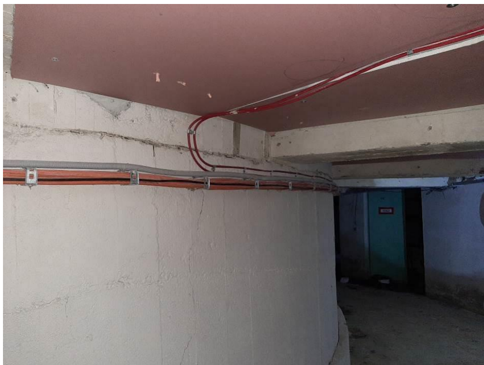
Fot. III.209. Stan techniczny instalacji systemów przeciwpożarowych piwnicy rotundy Prawidłowe prowadzenie instalacji. Brak wyposażenia systemu SSP.
