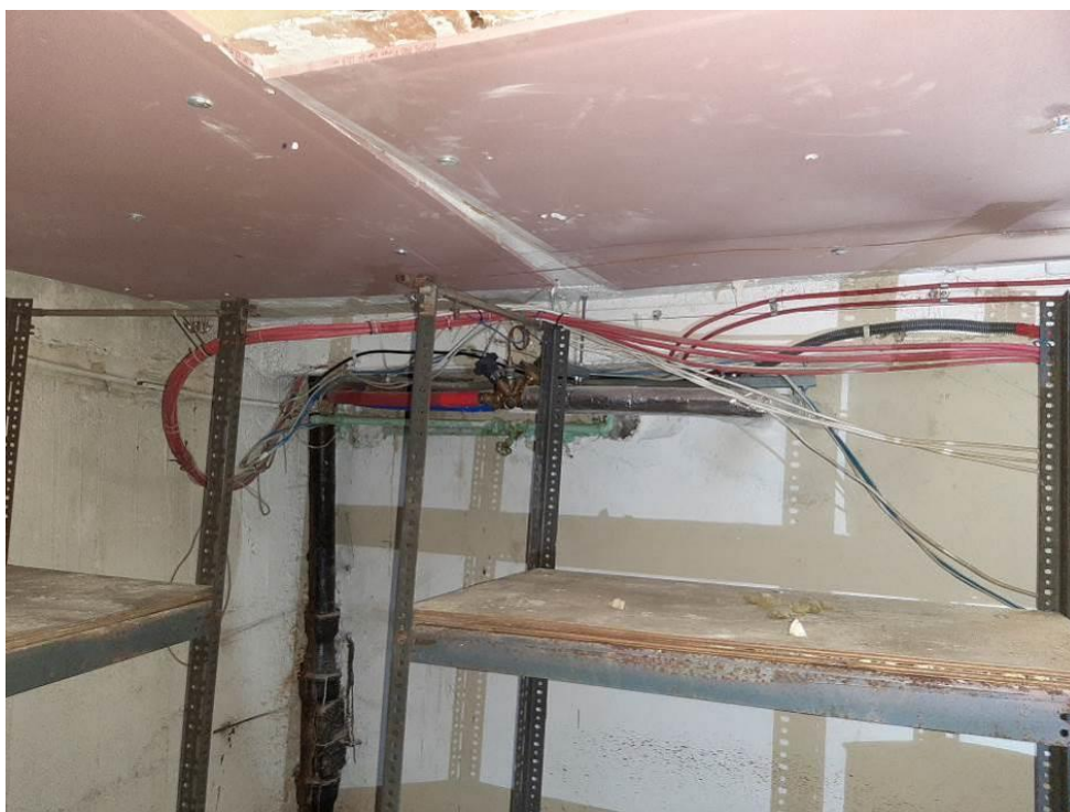
Fot. III.210. Stan techniczny instalacji systemów przeciwpożarowych piwnicy rotundy Brak uchwytów kablowych. Brak wyposażenia systemu SSP.
