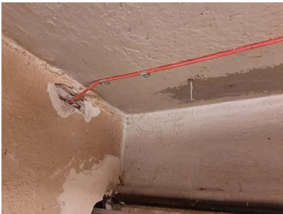
Fot. III.103. Stan techniczny instalacji systemów przeciwpożarowych piwnicy budynku „C” Nieprawidłowe prowadzenie kabli – brak odpowiedniego przepustu kablowego.
