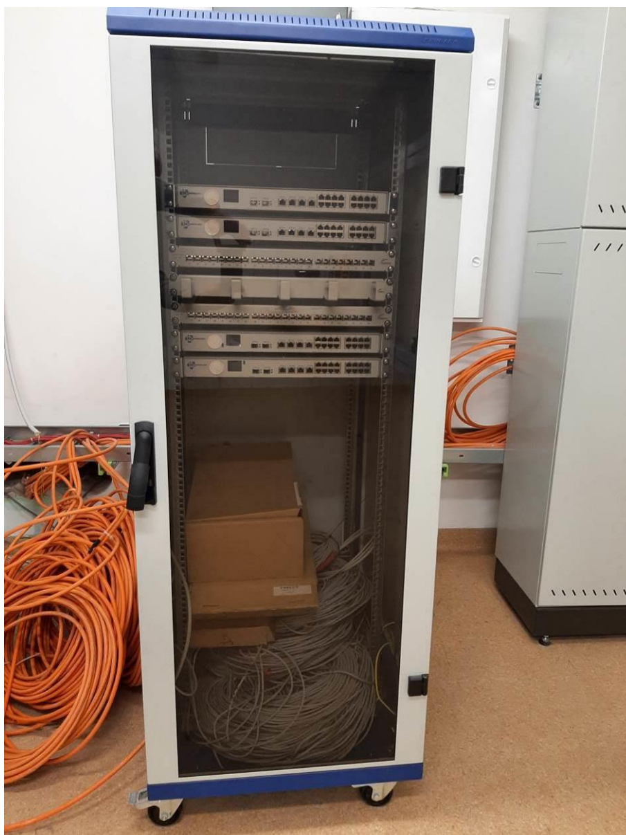
Fot. III.367. Pomieszczenie techniczne. Szafa systemu optycznej detekcji pożaru. Niepodłączone okablowanie systemu do urządzeń nadzorujących w szafie.
