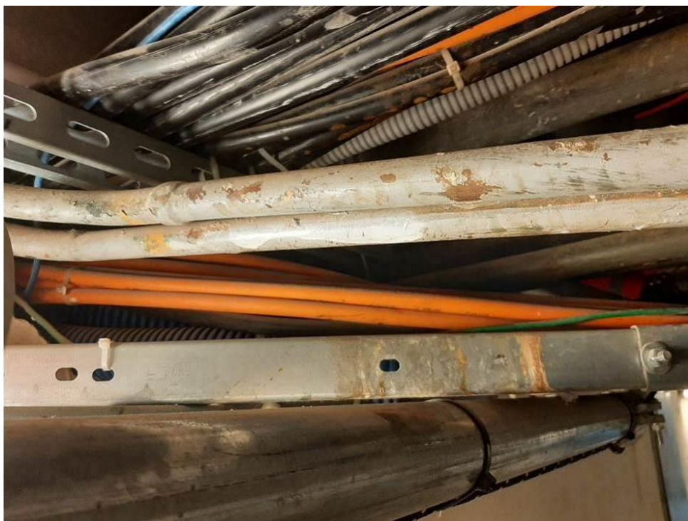
Fot. III.35. Stan techniczny instalacji systemów przeciwpożarowych piwnicy budynku „B” Nieprawidłowe prowadzenie kabli zasilających (pomarańczowe) – niezachowana odległość od innych instalacji.
