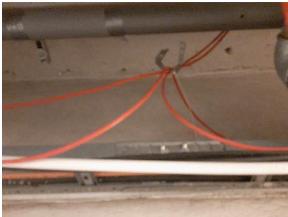
Fot. III.16. Stan techniczny instalacji systemów przeciwpożarowych piwnicy budynku „B” Nieprawidłowe prowadzenie kabli sygnalizacyjnych (czerwone) – brak uchwytów.
