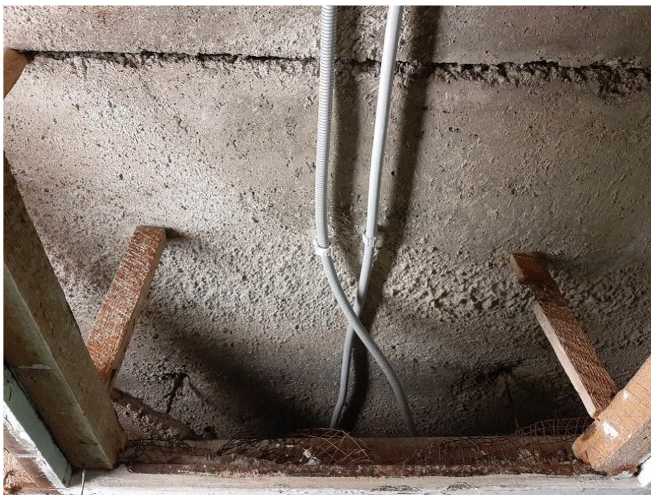
Fot. III.245. System detekcji ciepła LISTEC. Budynek „B” parter. Prawidłowo wykonana instalacja.
