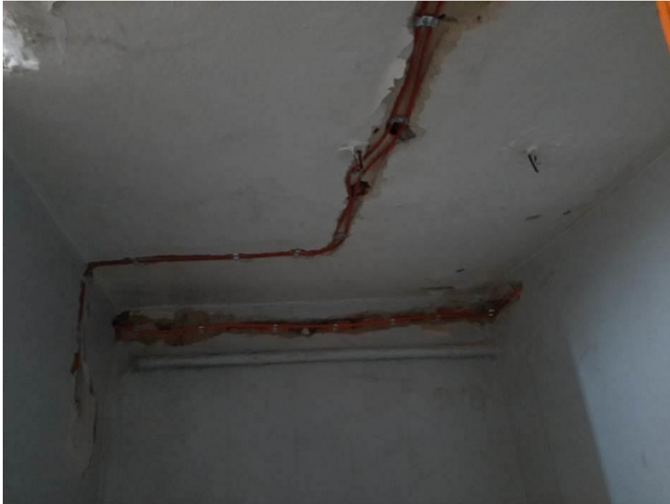
Fot. III.272. System oddymiania. Klatka h. Niedokończona instalacja. Brak urządzeń końcowych.
