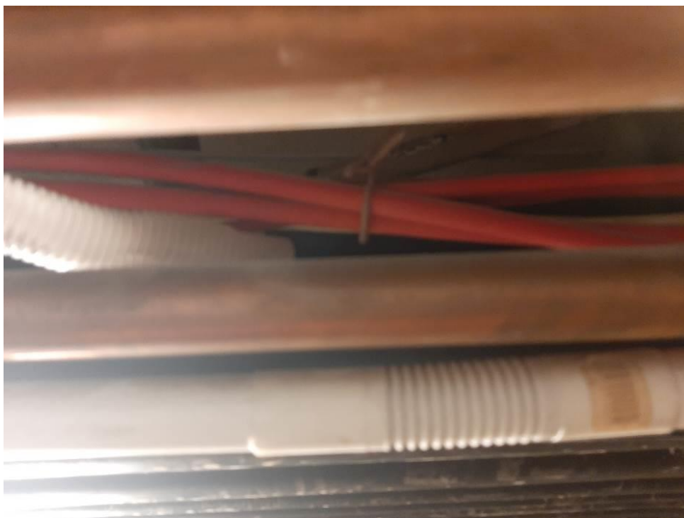
Fot. III.153. Stan techniczny instalacji systemów przeciwpożarowych piwnicy budynku „C” Nieprawidłowe prowadzenie kabli – brak uchwytów.
