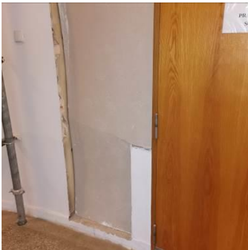
Fot. nr I.39. Brak stałej zabudowy „szachtów instalacyjnych”. BUD. B.
