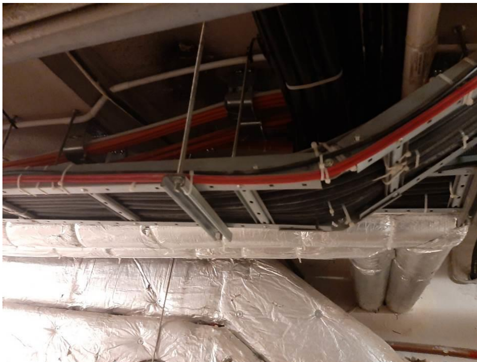
Fot. III.193. Stan techniczny instalacji systemów przeciwpożarowych piwnicy łącznika „II” Prawidłowe prowadzenie instalacji.
