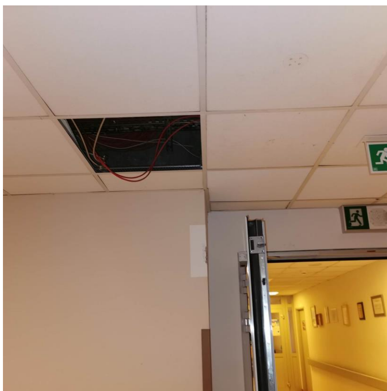
Fot. nr I.78. Brak uzupełnienia sufitu podwieszonego. BUD.B.
