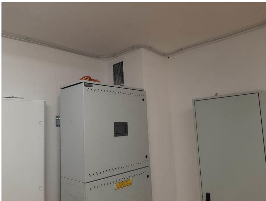
Fot. III.404. Pomieszczenie techniczne. Instalacja liniowej czujki ciepła. Prawidłowo ułożona instalacja
