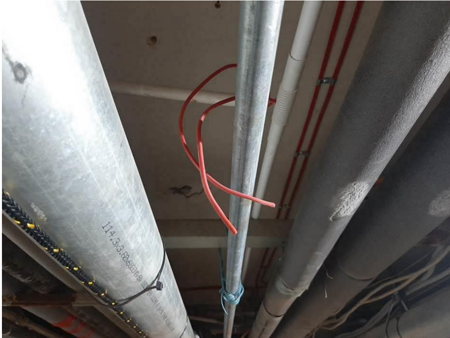
Fot. III.135. Stan techniczny instalacji systemów przeciwpożarowych piwnicy budynku „C” Brak zamontowanego urządzenia końcowego.
