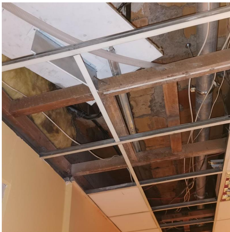
Fot. nr I.118. Ubytki sufitu powodujące swobodną migrację zanieczyszczonego powietrza pomiędzy pomieszczeniami. BUD.C.
