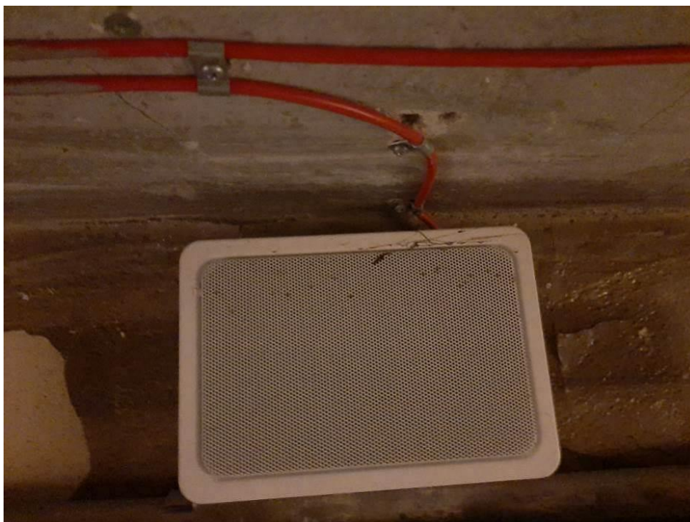
Fot. III.101. Stan techniczny instalacji systemów przeciwpożarowych piwnicy budynku „C” Nieprawidłowe zamontowanie głośnika systemu DSO.
