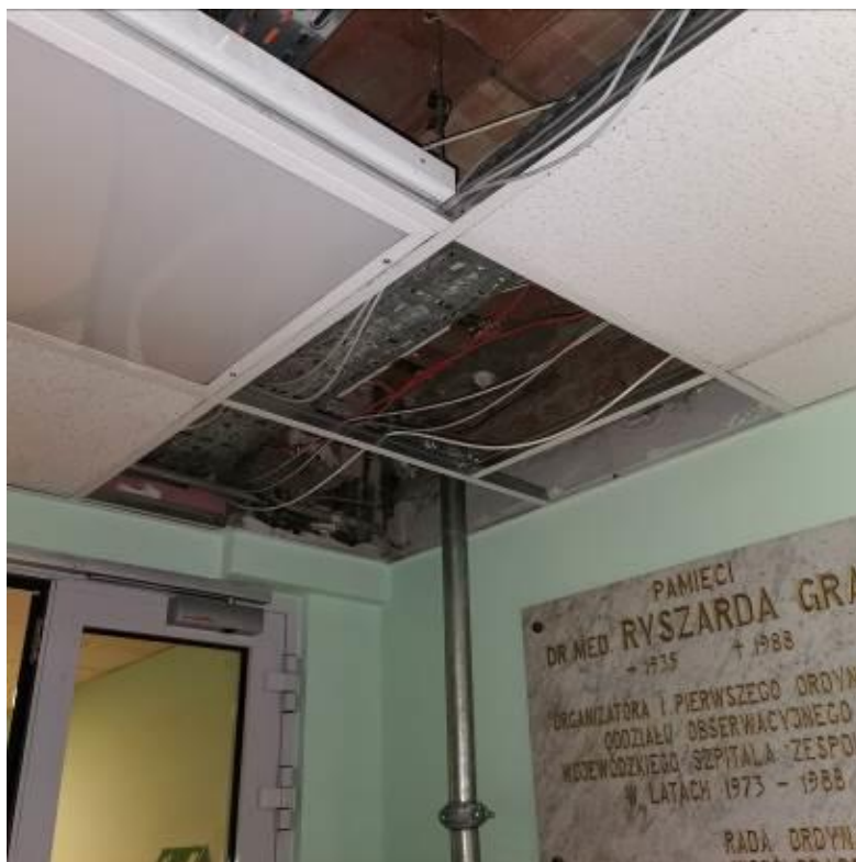
Fot. nr I.11. Brak uzupełnienia sufitu podwieszonego po realizacji prac w przestrzeni podstropowej. Miejsce swobodnego przepływu zanieczyszczonego powietrza pomiędzy pomieszczeniami. BUD.D.
