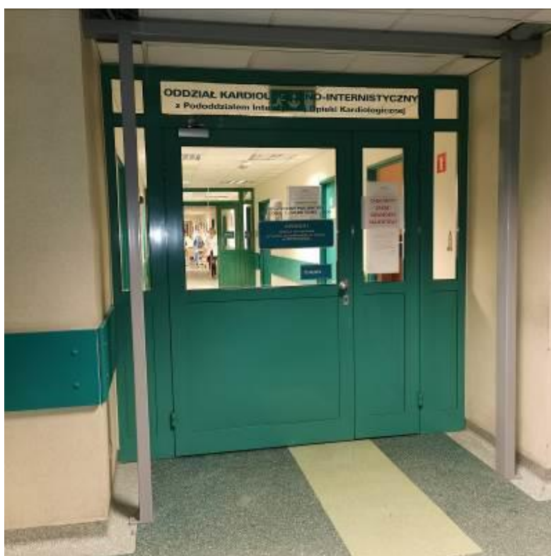
Fot. nr I.22. Wbudowana rama stalowa na potrzeby zamocowania drzwi p. poż. Brak wymaganych drzwi. BUD.C.
