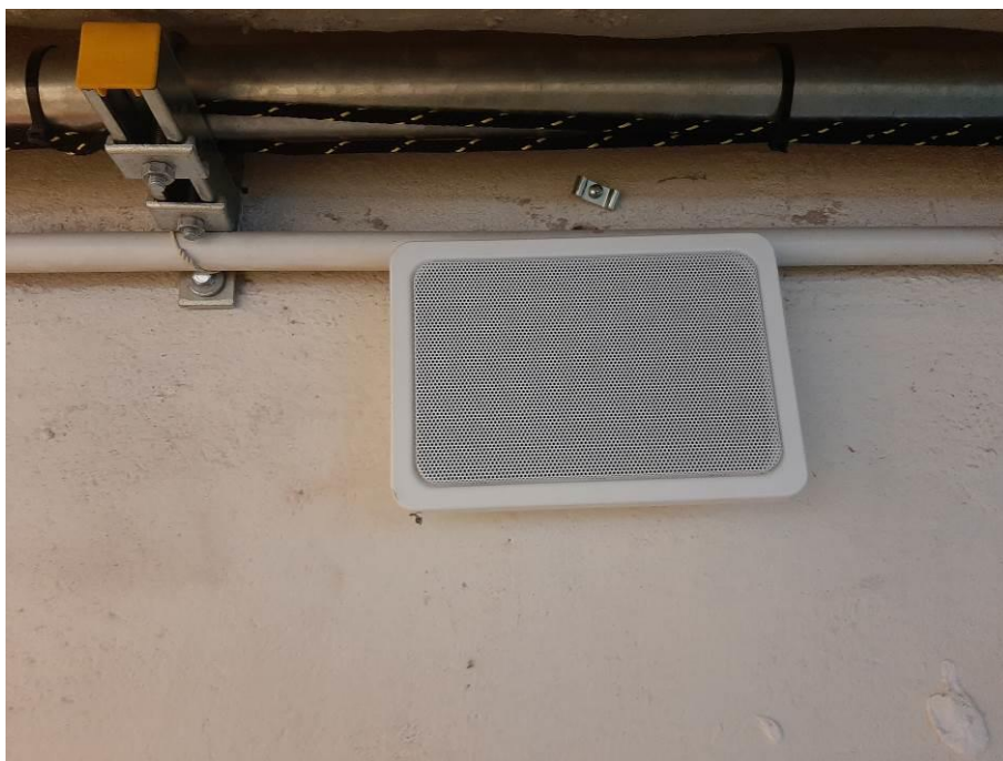
Fot. III.199. Stan techniczny instalacji systemów przeciwpożarowych piwnicy łącznika „II” Brak instalacji do głośnika systemu DSO.
