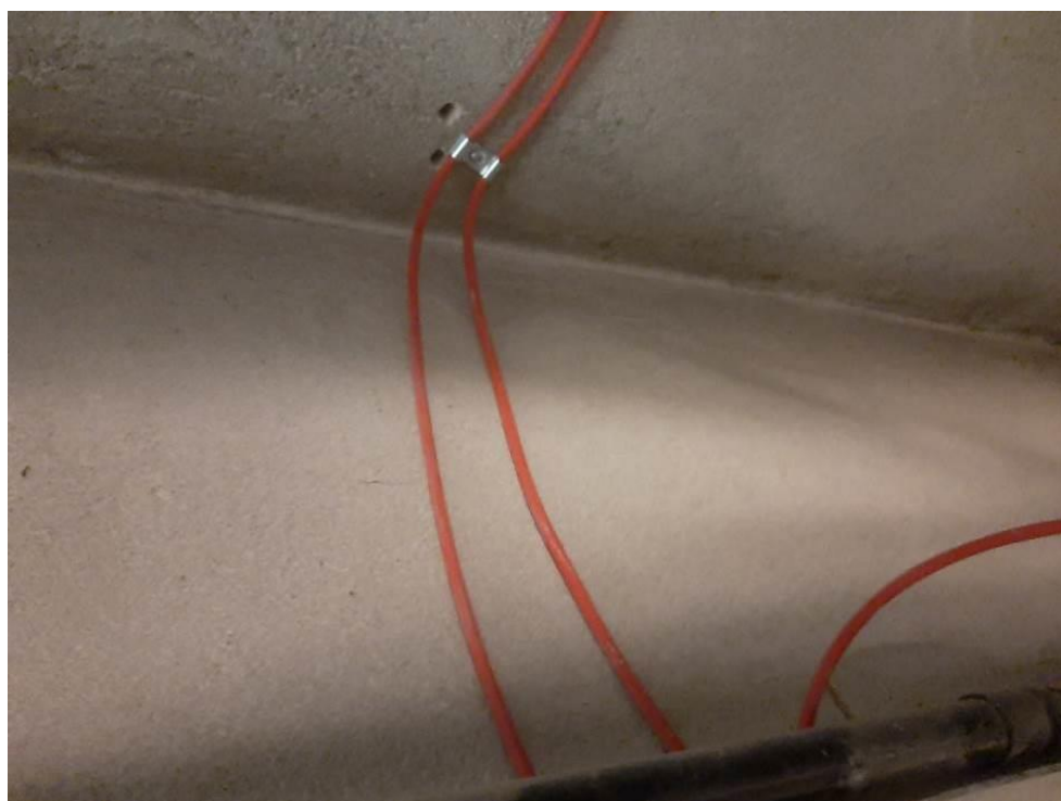
Fot.III.46. Stan techniczny instalacji systemów przeciwpożarowych piwnicy budynku „B” Nieprawidłowe prowadzenie kabli sygnalizacyjnych (czerwone) – brak uchwytów.
