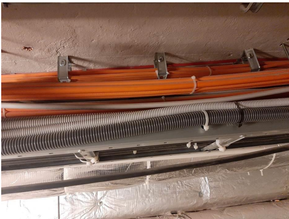
Fot.III.195. Stan techniczny instalacji systemów przeciwpożarowych piwnicy łącznika „II” Brak uchwytów kablowych dla części instalacji.
