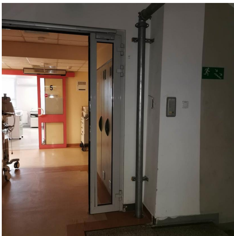
Fot. nr I.66. Brak zabudowy instalacji hydrantowej. BUD.C.
