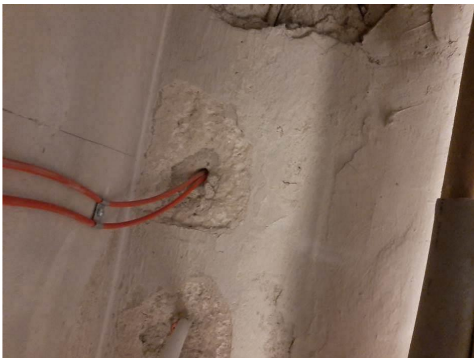
Fot.III.131. Stan techniczny instalacji systemów przeciwpożarowych piwnicy budynku „C” Nieprawidłowe prowadzenie kabli – brak odpowiedniego przepustu kablowego.
