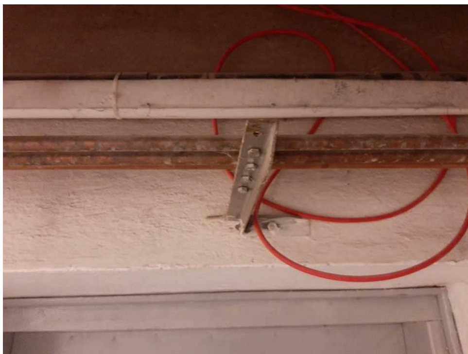
Fot.III.54. Stan techniczny instalacji systemów przeciwpożarowych piwnicy łącznika „IV” Nieprawidłowe prowadzenie kabli sygnalizacyjnych (czerwone) – brak uchwytów.
