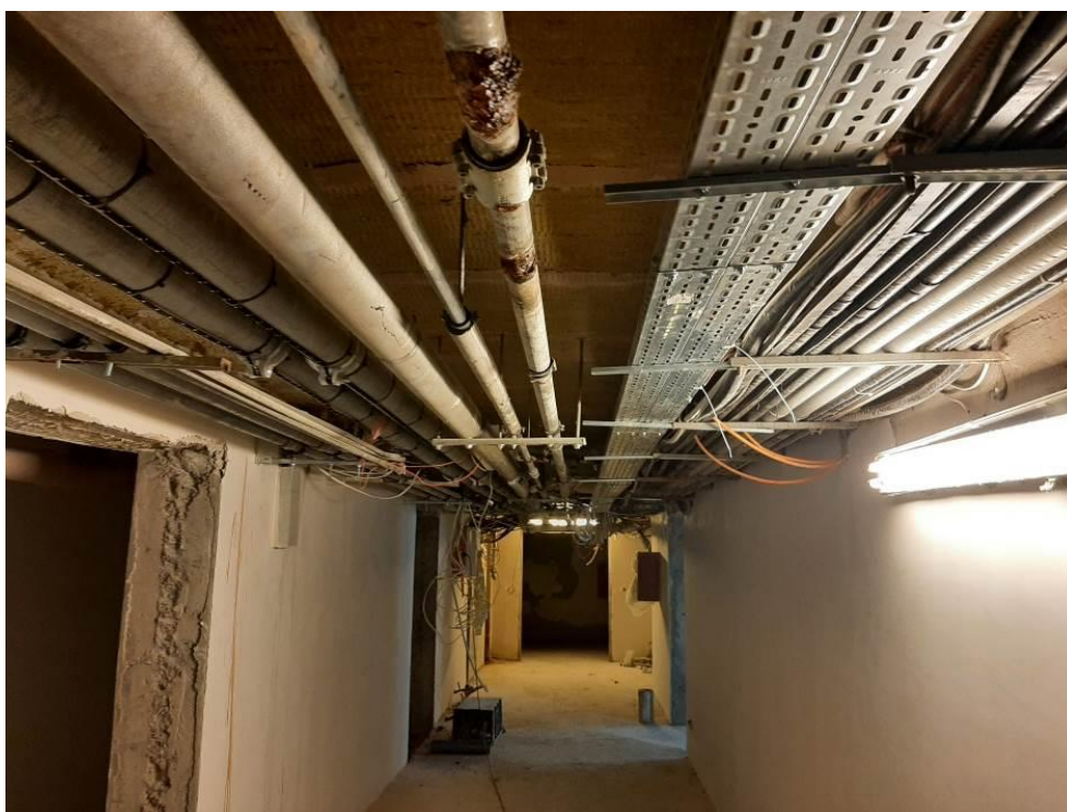
Fot. III.180. Stan techniczny instalacji systemów przeciwpożarowych piwnicy budynku „C” Nieprawidłowe prowadzenie kabli – brak uchwytów.
