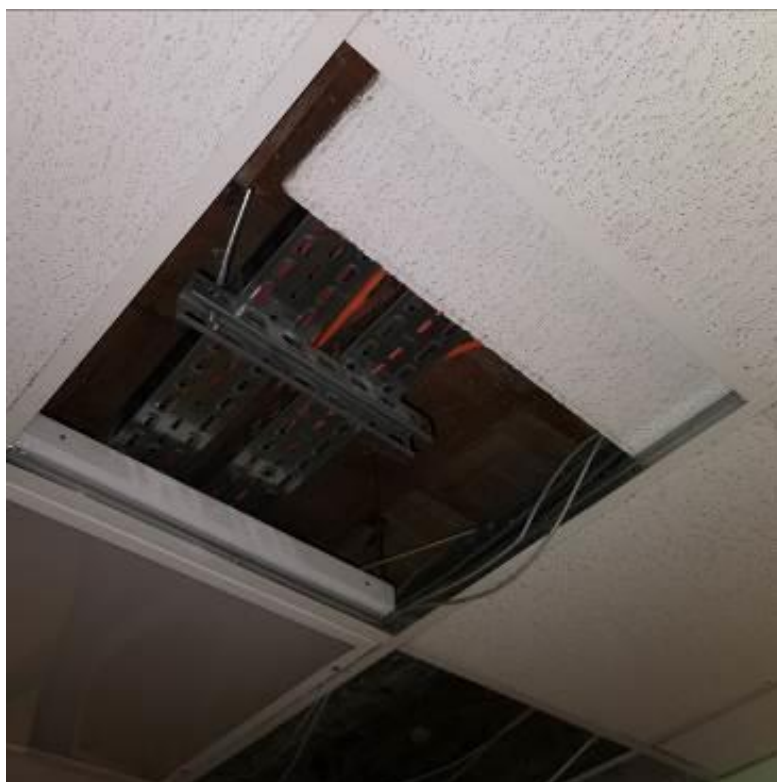
Fot. nr I.10. Brak uzupełnienia sufitu podwieszonego po realizacji prac w przestrzeni podstropowej. Miejsce swobodnego przepływu zanieczyszczonego powietrza pomiędzy pomieszczeniami. BUD.D
