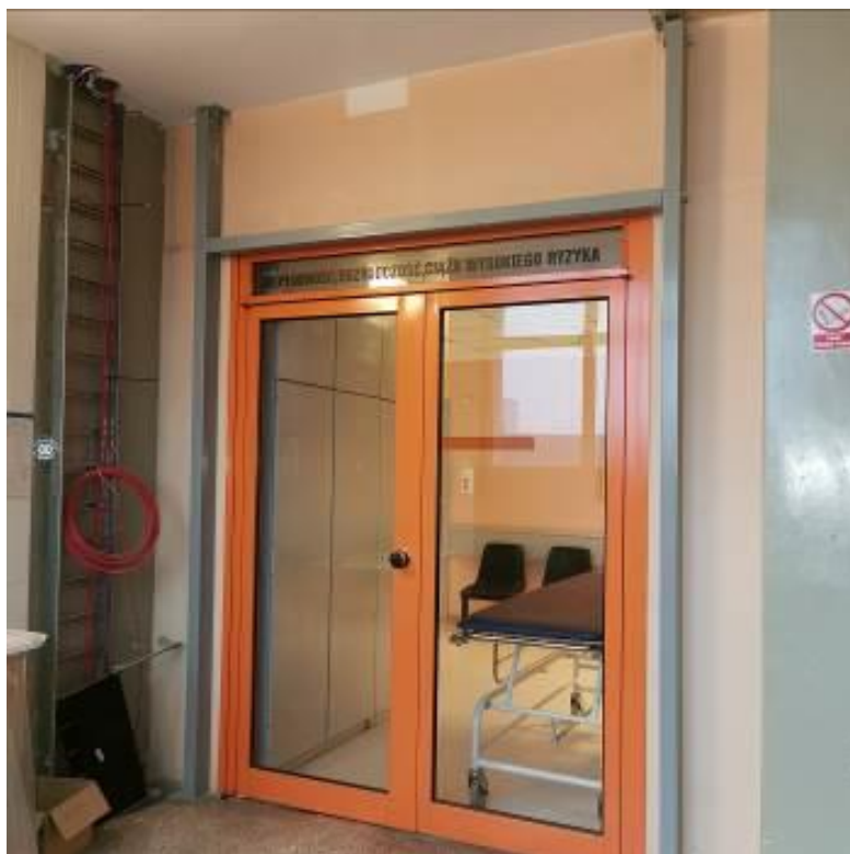
Fot. nr I.19. Wbudowana rama stalowa na potrzeby zamocowania drzwi p. poż. Brak wymaganych drzwi. BUD.B
