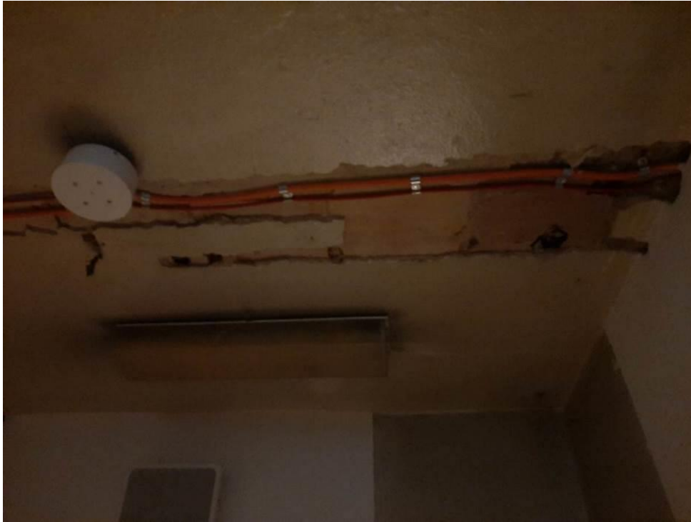
Fot. III.291. System oddymiania. Klatka g. Niedokończona instalacja. Brak odpowiednich przepustów kablowych.
