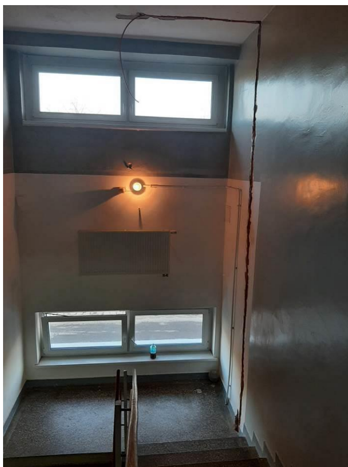
Fot. III.257. System oddymiania. Klatka h. Niedokończona instalacja. Brak urządzeń końcowych.
