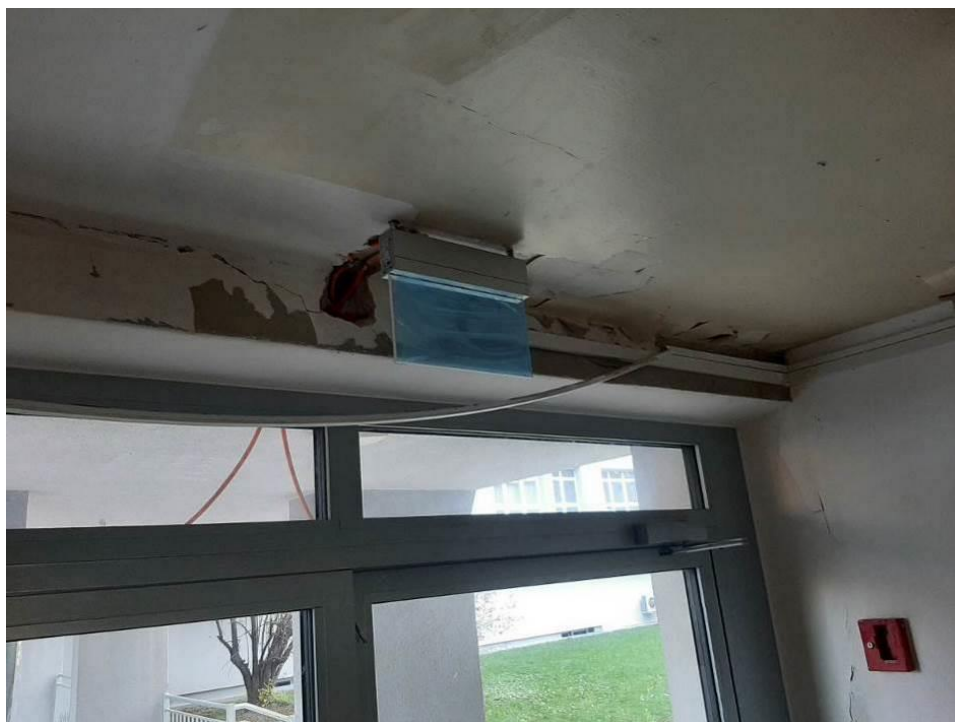
Fot. III.289. System oddymiania. Klatka g. Niedokończona instalacja. Brak odpowiednich przepustów kablowych.
