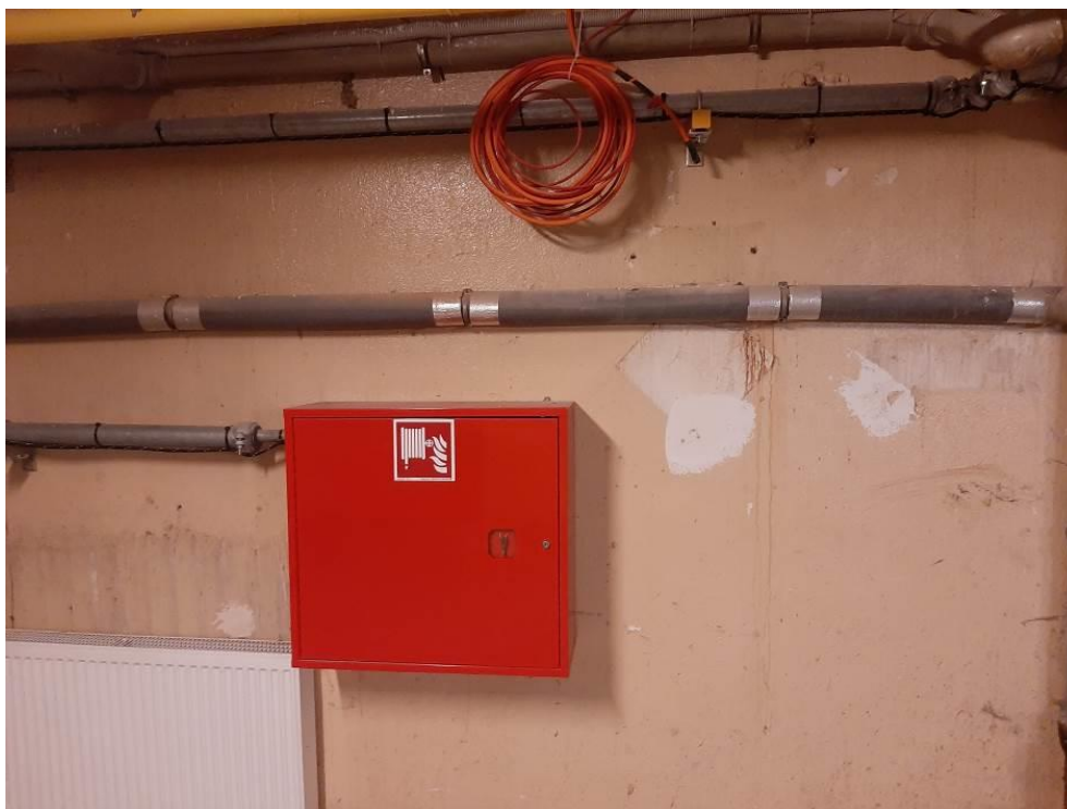
Fot. III.94. Stan techniczny instalacji systemów przeciwpożarowych piwnicy budynku „C” Nieprawidłowe prowadzenie kabli zasilających (pomarańczowe) – brak uchwytów, brak urządzenia końcowego.
