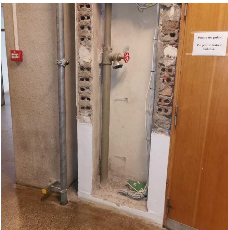
Fot. nr I.60. Brak zabudowy „szachtów instalacyjnych”. BUD.A.
