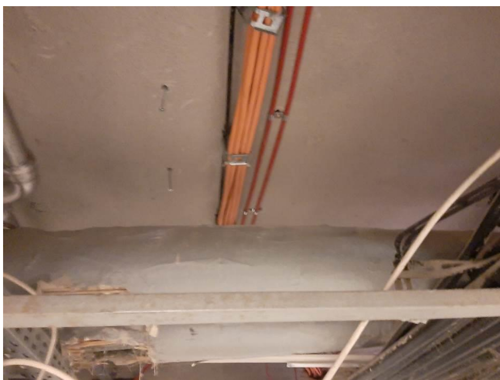
Fot.III.40. Stan techniczny instalacji systemów przeciwpożarowych piwnicy budynku „B” Nieprawidłowe prowadzenie kabli sygnalizacyjnych (czerwone) i zasilających (pomarańczowe) razem z inną instalacją.
