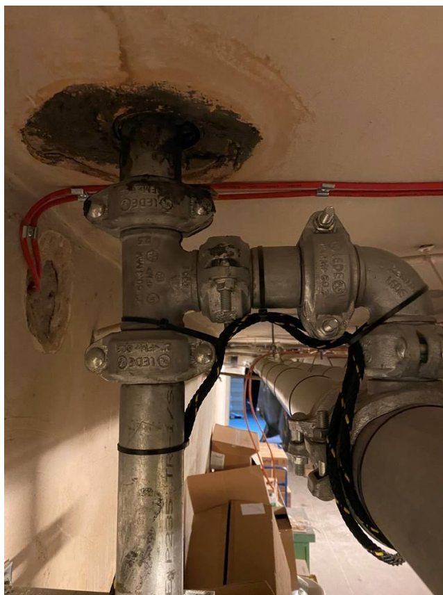
Fot. II.7. Piwnica budynku diagnostycznego B - Nieopisane/niewykonane przejścia pożarowe. Przejścia przez przegrody pożarowe powinny być zabezpieczone za pomocą przejść pożarowych opisanych na ścianie. Do tego należy wykonać dokumentację powykonawczą przejść pożarowych.
