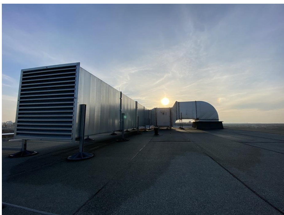
Fot. II.4. Dach budynku Łózkowego C Wykonana instalacja oddymiania nie została uruchomiona. Nie ma też takiej możliwości z uwagi na brak zasilania i sterowania. Brak uzgodnienia z rzeczoznawcą ds. przeciwpożarowych.
