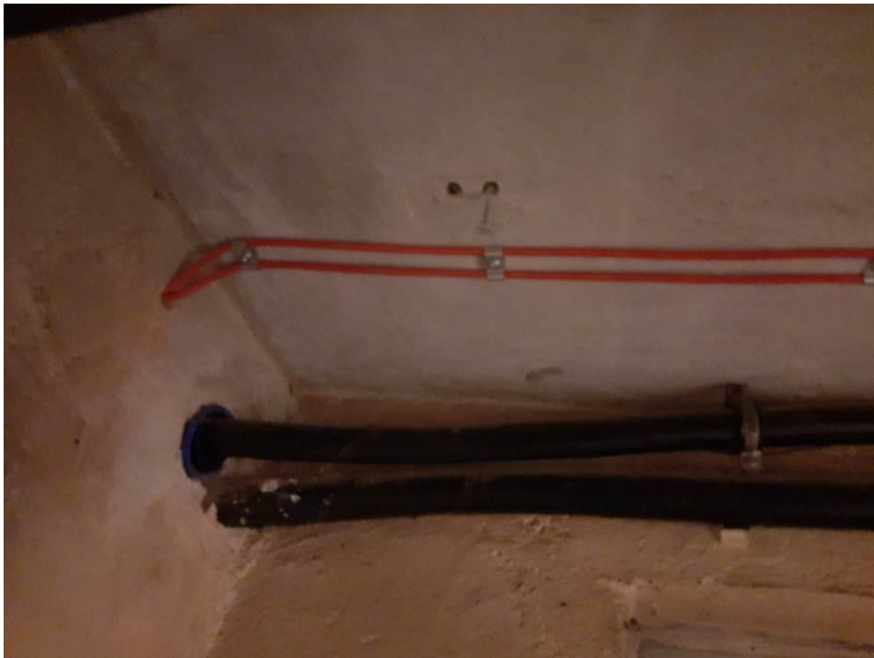
Fot. III.95. Stan techniczny instalacji systemów przeciwpożarowych piwnicy budynku „C” Nieprawidłowe prowadzenie kabli sygnalizacyjnych (czerwone) – brak odpowiedniego przepustu kablowego.
