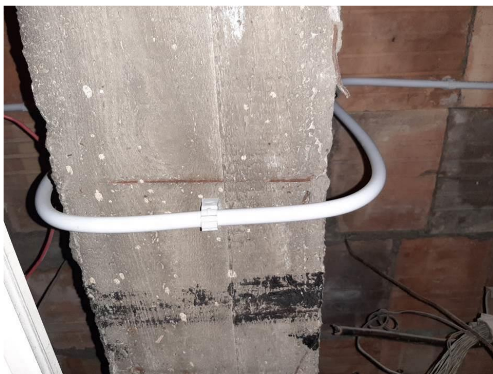
Fot. III.232. System detekcji ciepła LISTEC. Budynek „C”. Prawidłowo wykonana instalacja
