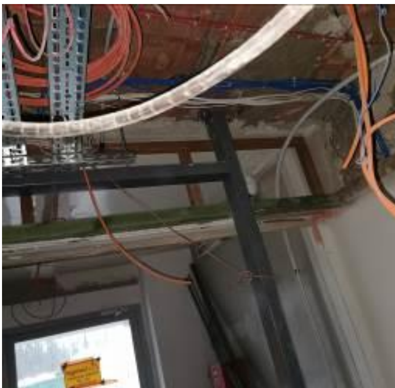
Fot. nr I.1. Wbudowana rama stalowa na potrzeby zamontowania drzwi p. poż. Brak wymaganych drzwi. Bud.C
