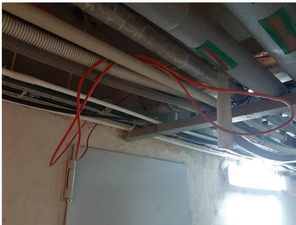
Fot. III.28. Stan techniczny instalacji systemów przeciwpożarowych piwnicy budynku „B” Nieprawidłowe prowadzenie kabli sygnalizacyjnych (czerwone) – brak uchwytów.
