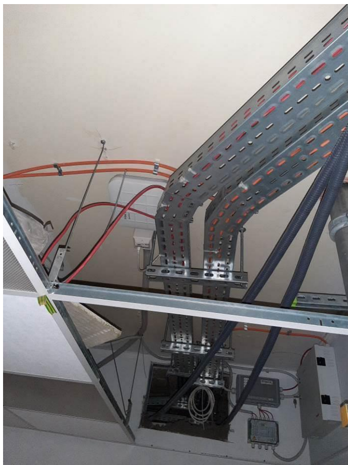
Fot. III.225. System detekcji ciepła LISTEC. Budynek „C”. Brak uchwytyów kablowych.
