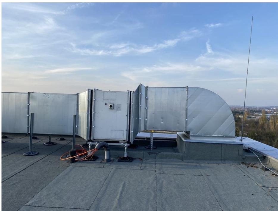
Fot. II.1. Dach budynku ŁóŹkowego C - Brak zasilania elektrycznego systemu oddymiania. Urzdzenia niepodlczane i nieruchome. Brak moŹliwosci sprawdzenia poprawnoŹci wykonania.
