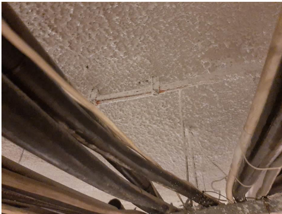
Fot. III.81. Stan techniczny instalacji systemów przeciwpożarowych piwnicy budynku „C” Nieprawidłowe prowadzenie kabli sygnalizacyjnych (czerwone) – przykrycie warstwą izolacji.
