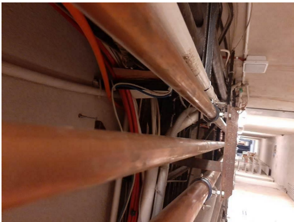
Fot. III.155. Stan techniczny instalacji systemów przeciwpożarowych piwnicy budynku „C” Nieprawidłowe prowadzenie kabli – brak uchwytów.
