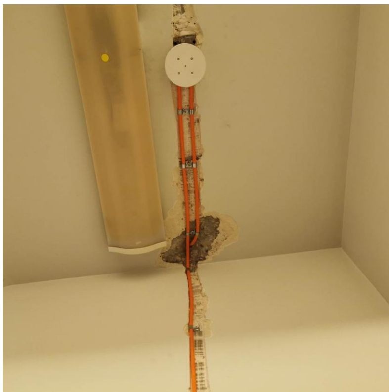
Fot. nr I.105. Brak uzupełnienia tynku ochraniającego instalacje oraz przejść przez strop międzykondygnacyjny. BUD.C.
