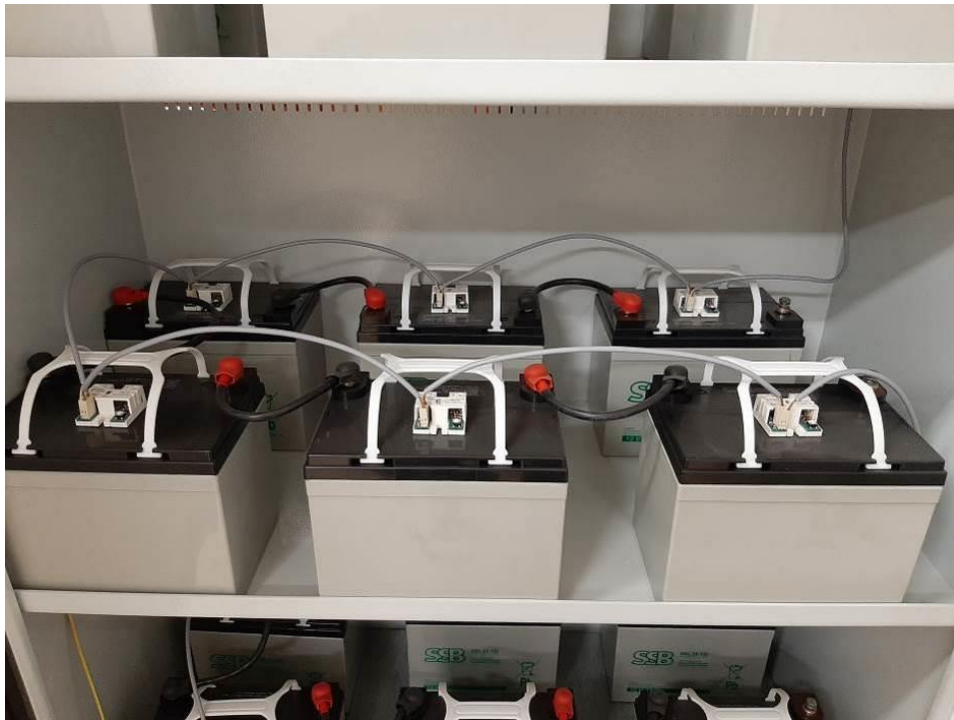
Fot. III.389. Pomieszczenie techniczne. Szafa systemu centralnej baterii. Niepodłączone akumulatory buforowe.
