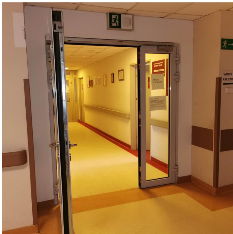
Fot. nr I.77. Drzwi na granicy stref pożarowych w budynku. BUD.C.
