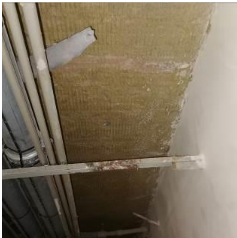
Fot. nr I.4. Widok izolacji z wełny mineralnej poprawiającej odporność ogniową stropu nad piwnicą. BUD.C.
