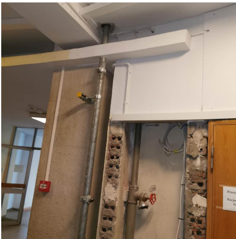
Fot. nr I.61. Lokalizacja instalacji (nowy pion wodociągowy) bez zabezpieczenia przed działaniem ognia. BUD.A.
