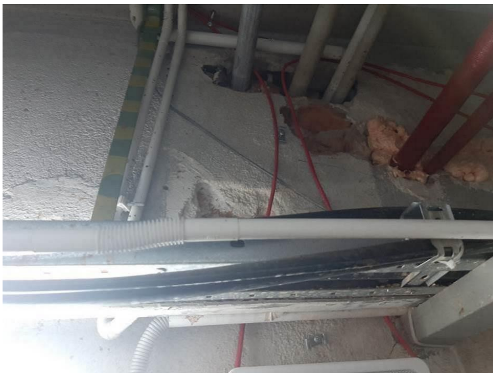
Fot. III.25. Stan techniczny instalacji systemów przeciwpożarowych piwnicy budynku „B” Nieprawidłowe prowadzenie kabli sygnalizacyjnych (czerwone) – brak uchwytów.
