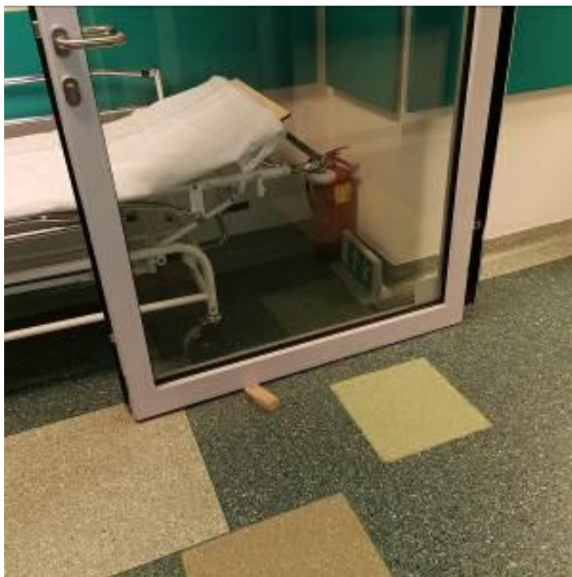
Fot. nr I.25. Wbudowane drzwi pożarowe. Brak realizowania robót wykończeniowych. BUD.C.
