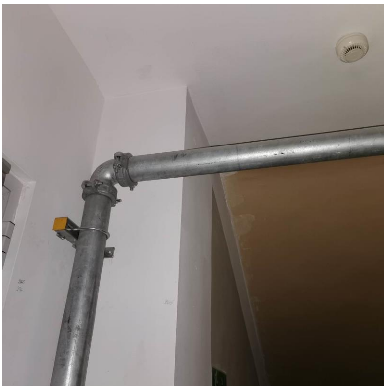
Fot. nr I.69. Brak zabudowy instalacji hydrantowej powoduje trudności w utrzymaniu warunków higienicznych. BUD.C.
