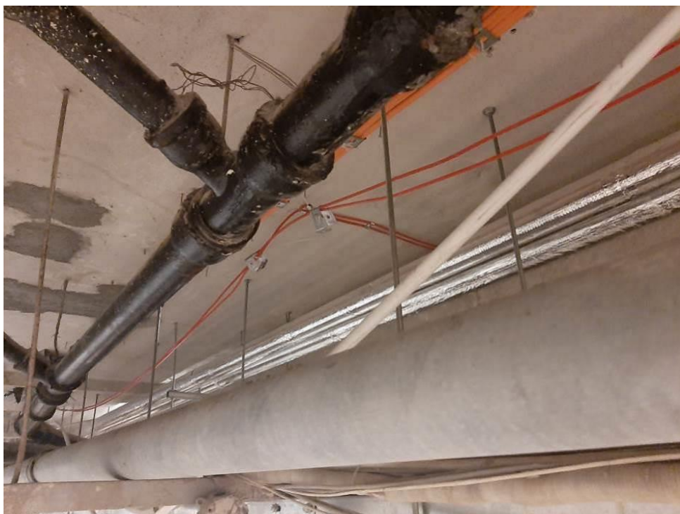
Fot. III.63. Stan techniczny instalacji systemów przeciwpożarowych piwnicy łącznika „IV” Nieprawidłowe prowadzenie kabli sygnalizacyjnych (czerwone) – brak uchwytów.
