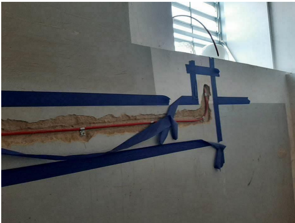
Fot. III.273. System oddymiania. Klatka h. Niedokończona instalacja.
