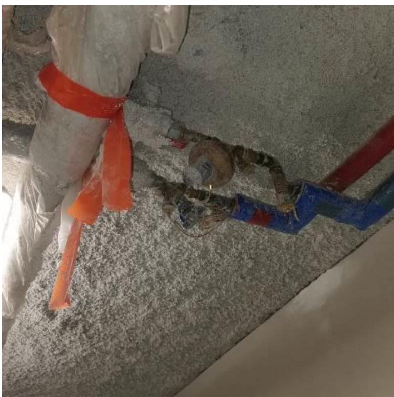
Fot. nr I.6. Widok izolacji natryskowej poprawiającej odporność ogniową stropu nad piwnicą. BUD.D.
