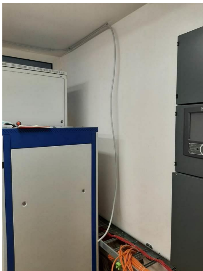
Fot. III.399. Pomieszczenie techniczne. Instalacja liniowa czujki ciepła. Niepodłączona instalacja.
