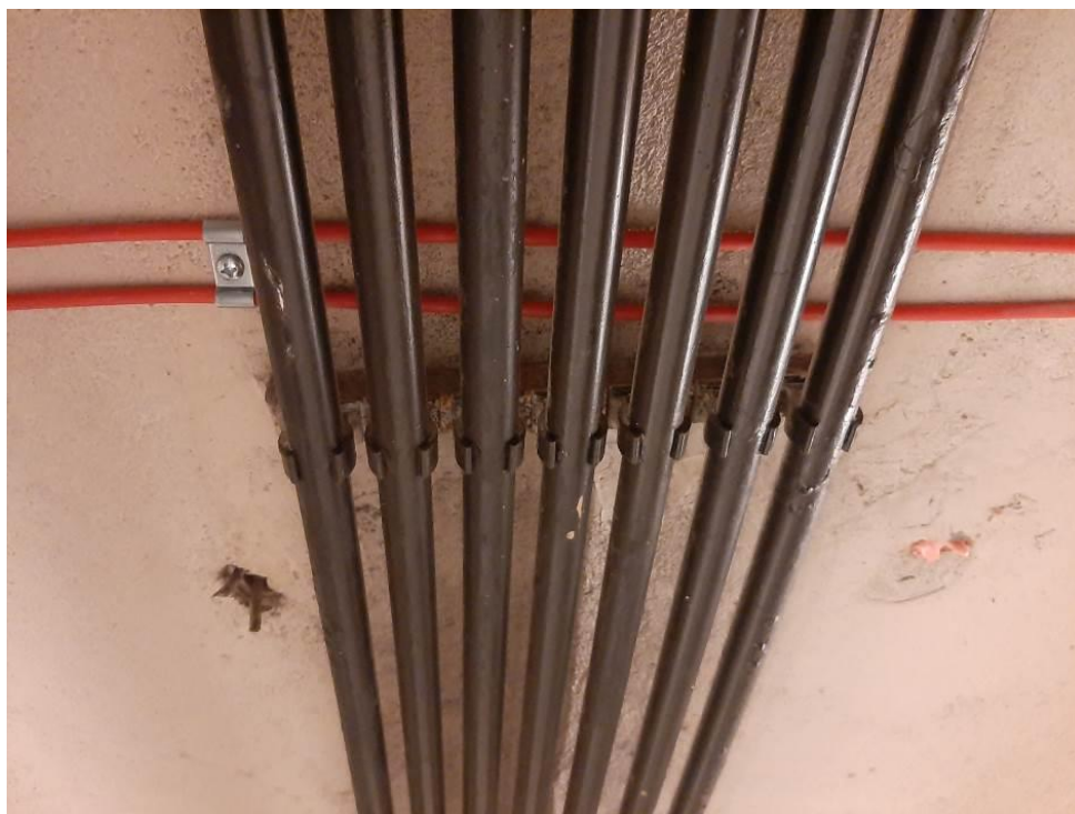
Fot. III.160. Stan techniczny instalacji systemów przeciwpożarowych piwnicy budynku „C” Prawidłowe wykonanie instalacji
