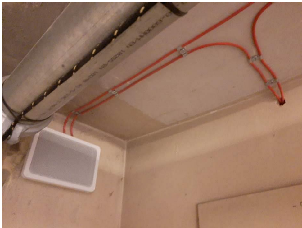
Fot. III.106. Stan techniczny instalacji systemów przeciwpożarowych piwnicy budynku „C” Nieprawidłowe prowadzenie kabli – brak odpowiedniego przepustu kablowego.
