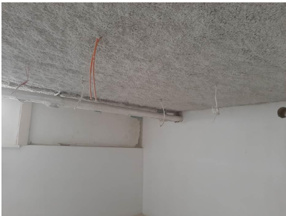
Fot. III.185. Stan techniczny instalacji systemów przeciwpożarowych piwnicy budynku „C” Brak urządzeń końcowych.
