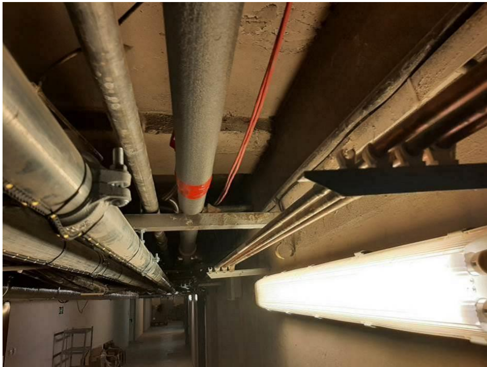
Fot.III.55. Stan techniczny instalacji systemów przeciwpożarowych piwnicy łącznika „IV” Nieprawidłowe prowadzenie kabli zasilających (pomarańczowe) – brak uchwytów.
