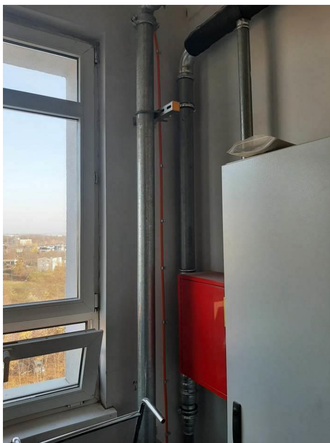
Fot. III.334. System oddymiania. Klatka c. Instalacja wykonana prawidłowo.
