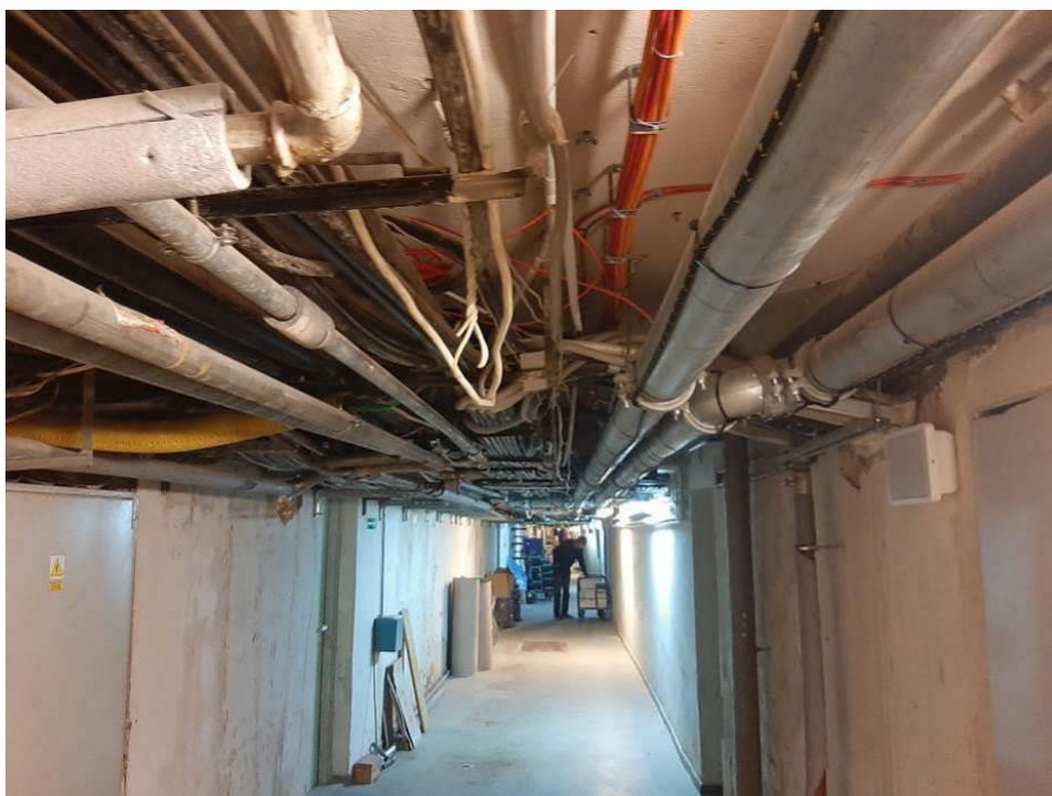
Fot. III.124. Stan techniczny instalacji systemów przeciwpożarowych piwnicy budynku „C” Nieprawidłowe prowadzenie kabli – brak uchwytów, niechlujne ułożenie instalacji.
