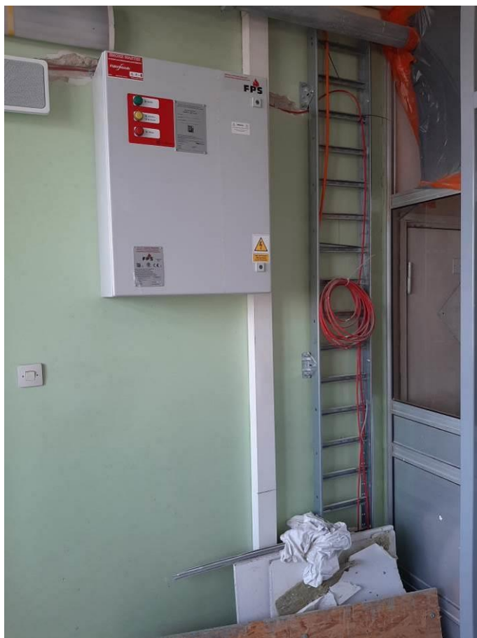
Fot. III.295. System oddymiania. Klatka a. Niedokończona instalacja. Brak urządzeń końcowych. Brak odpowiednich przepustów kablowych.
