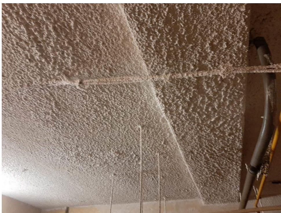
Fot. III.78. Stan techniczny instalacji systemów przeciwpożarowych piwnicy budynku „C” Nieprawidłowe prowadzenie kabli sygnalizacyjnych (czerwone) – brak uchwytów.
