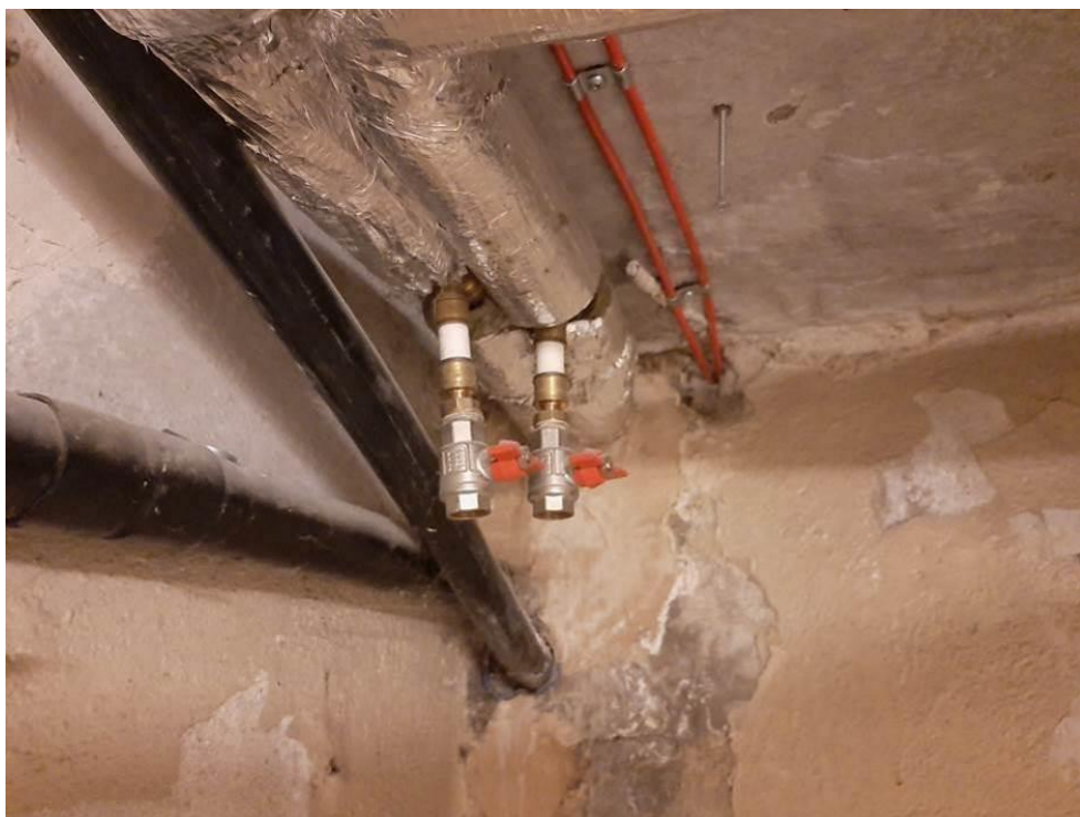
Fot. III.99. Stan techniczny instalacji systemów przeciwpożarowych piwnicy budynku „C” Nieprawidłowe prowadzenie kabli – brak odpowiedniego przepustu kablowego.
