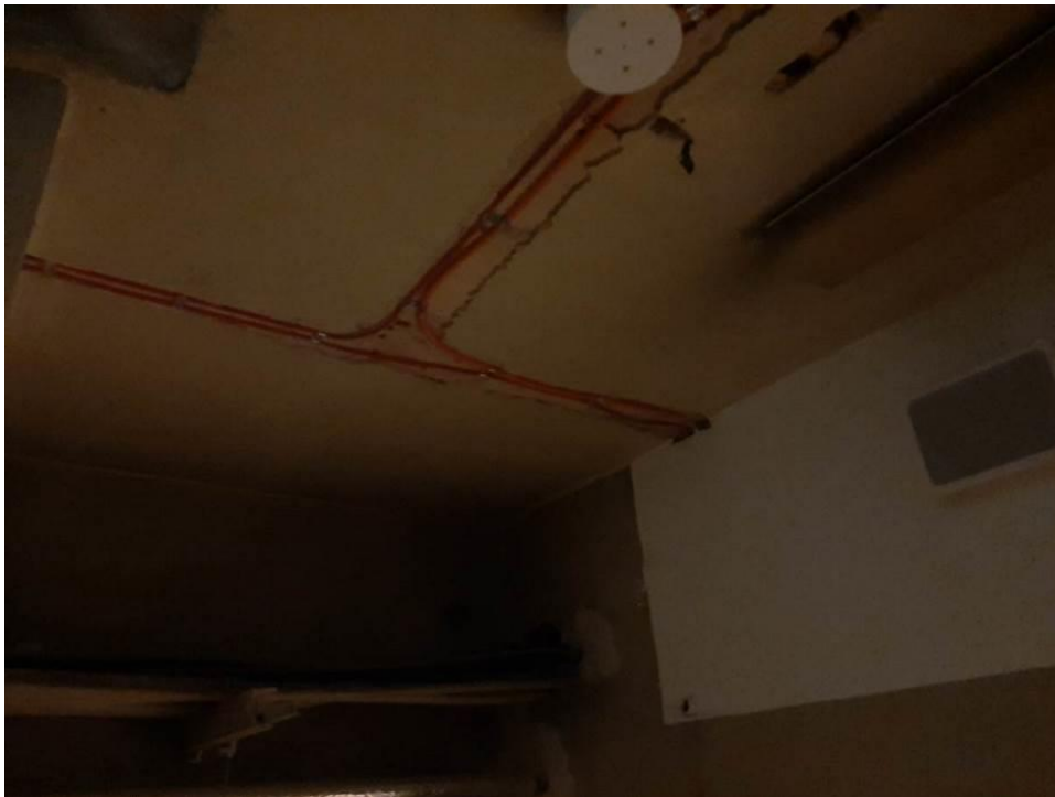
Fot. III.292. System oddymiania. Klatka g. Niedokończona instalacja. Brak odpowiednich przepustów kablowych.
