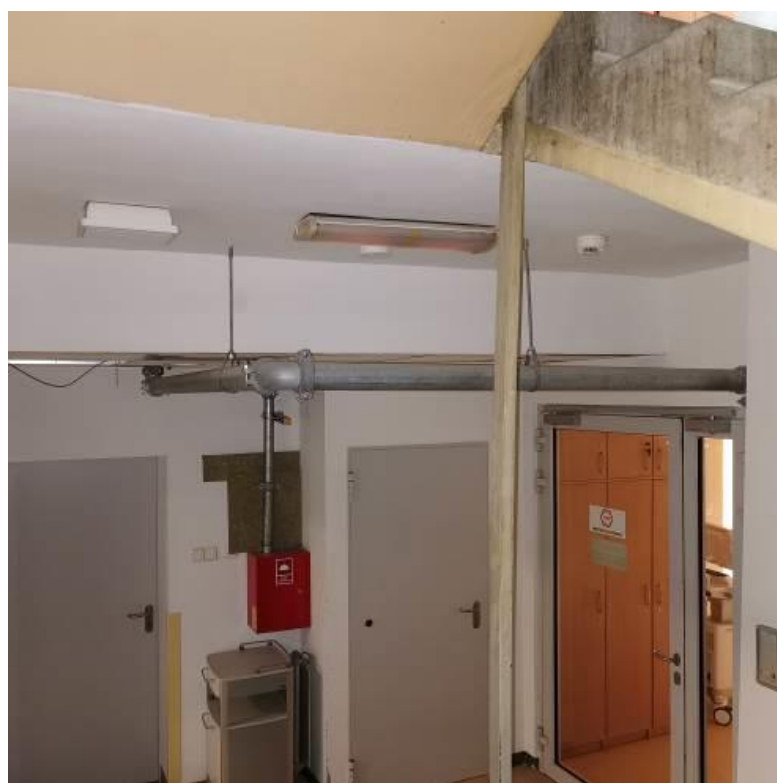
Fot. nr I.18. Instalacja hydrantowa stanowiąca utrudnienie użytkowe pomieszczenia. BUD.B
