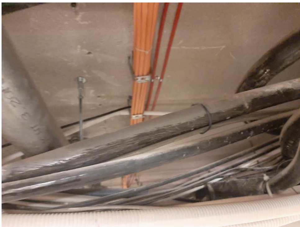
Fot.III.39. Stan techniczny instalacji systemów przeciwpożarowych piwnicy budynku „B” Nieprawidłowe prowadzenie kabli sygnalizacyjnych (czerwone) i zasilających (pomarańczowe) – skrzyżowanie z inną instalacją.
