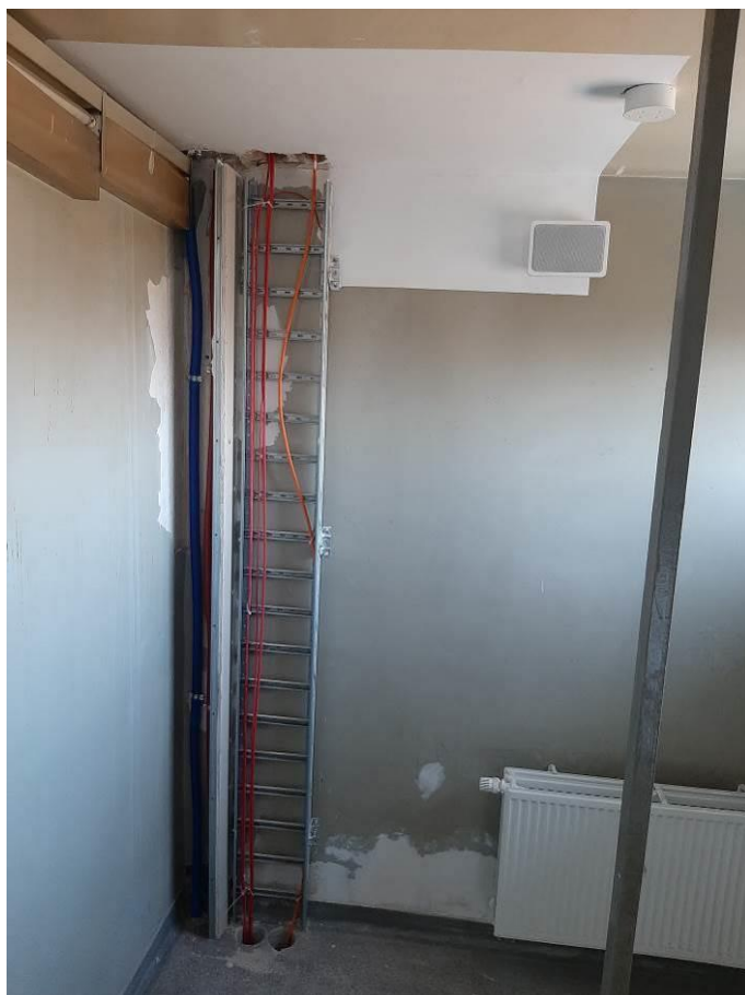
Fot. III.339. System oddymiania. Klatka d. Niedokończona instalacja. Brak odpowiednich przepustów kablowych.
