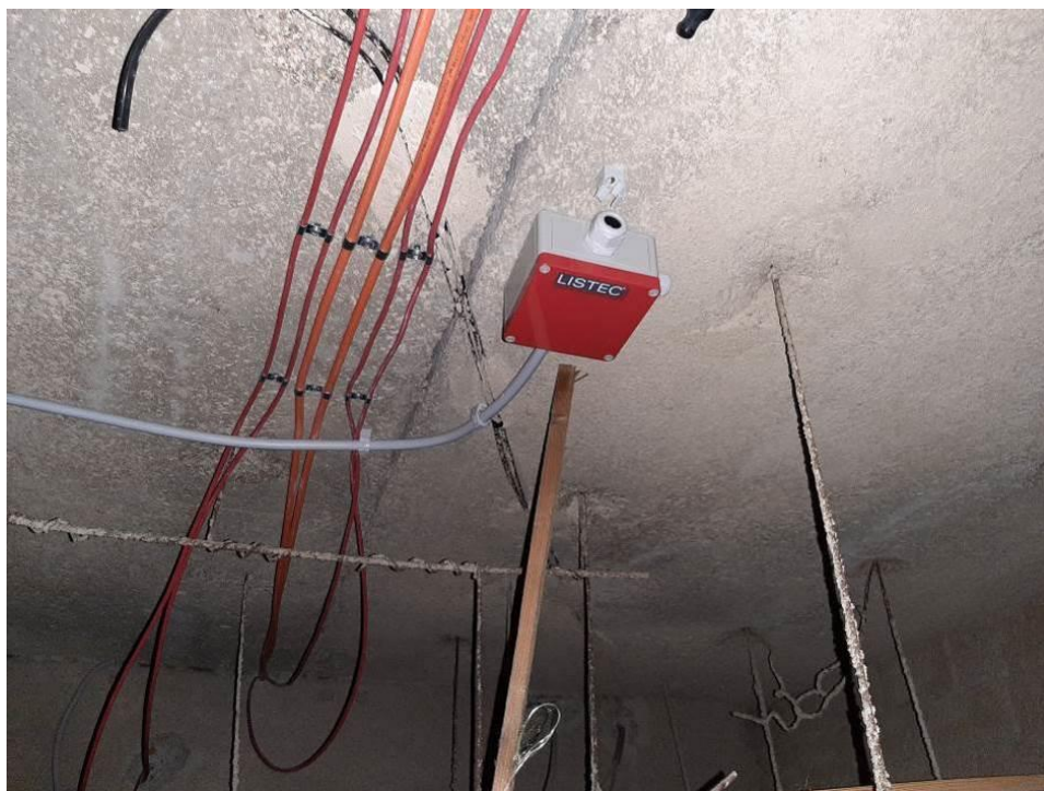
Fot. III.233. System detekcji ciepła LISTEC. Budynek „B” parter. Brak uchwytów kablowych.
