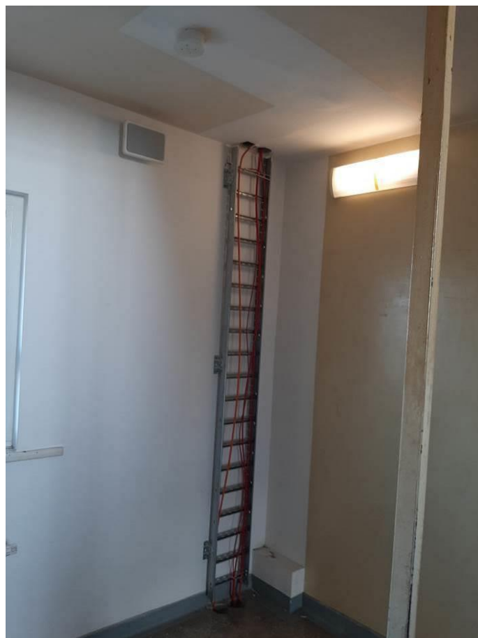
Fot.III.316. System oddymiania. Klatka c. Niedokończona instalacja. Brak odpowiednich przepustów kablowych.
