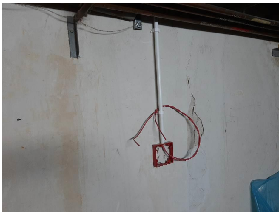
Fot.III.134. Stan techniczny instalacji systemów przeciwpożarowych piwnicy budynku „C” Brak zamontowanego urządzenia końcowego.
