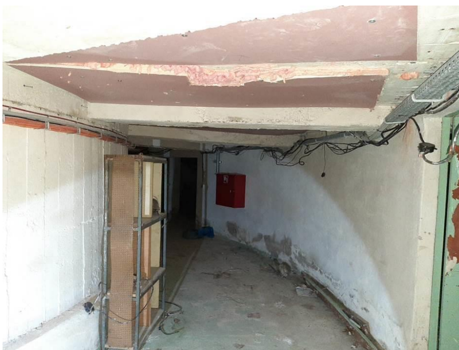
Fot.III.204. Stan techniczny instalacji systemów przeciwpożarowych piwnicy rotundy Prawidłowe prowadzenie instalacji. Brak wyposażenia systemu SSP.
