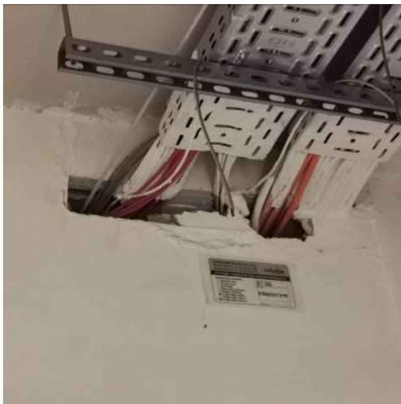
Fot. nr I.15. Brak prawidłowego wykonania zabezpieczeń przejść instalacyjnych przez ścianę. BUD.B
