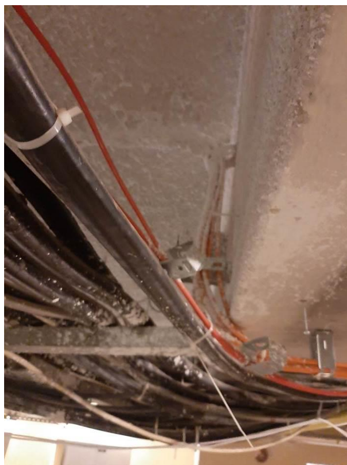
Fot. III.82. Stan techniczny instalacji systemów przeciwpożarowych piwnicy budynku „C” Nieprawidłowe prowadzenie kabli sygnalizacyjnych (czerwone) – nieprzykręcone uchwyty.
