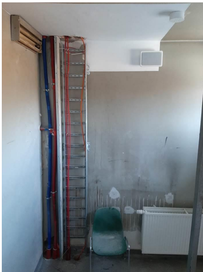
Fot. III.346. System oddymiania. Klatka d. Niedokończona instalacja. Brak odpowiednich przepustów kablowych.
