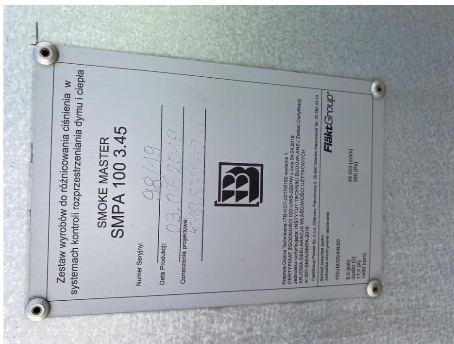
Fot. II.2. Dach budynku ŁóŹkowego C - Tabliczka znamionowa systemu oddymiania – brak dokumentacji powykonawczej. Nie wykonano symulacji. Nie wiadomo czy urzdzenia zamontowane s wystarczajce.
