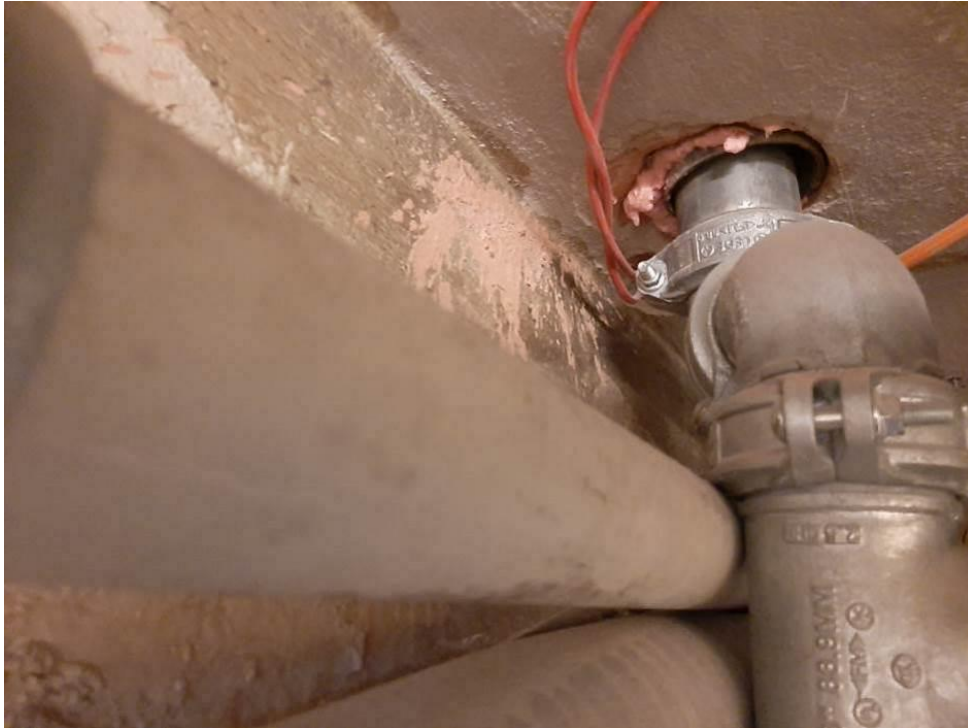
Fot. III.113. Stan techniczny instalacji systemów przeciwpożarowych piwnicy budynku „C” Nieprawidłowe prowadzenie kabli – brak uchwytów, brak odpowiedniego przepustu kablowego.
