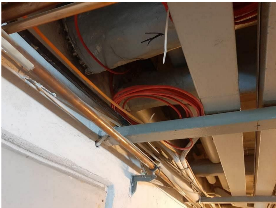
Fot. III.7. Stan techniczny instalacji systemów przeciwpożarowych piwnicy budynku „B” Nieprawidłowe prowadzenie kabli zasilających (pomarańczowe) – brak uchwytów. Nieprawidłowe prowadzenie kabli sygnalizacyjnych (czerwone) – brak uchwytów.
