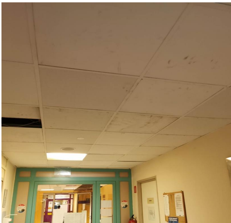
Fot. nr I.113. Ubytki sufitu powodujące swobodną migrację zanieczyszczonego powietrza pomiędzy pomieszczeniami. Brak zamontowanej stolarki drzwiowej – elementu ochrony przeciwpożarowej. BUD.D.
