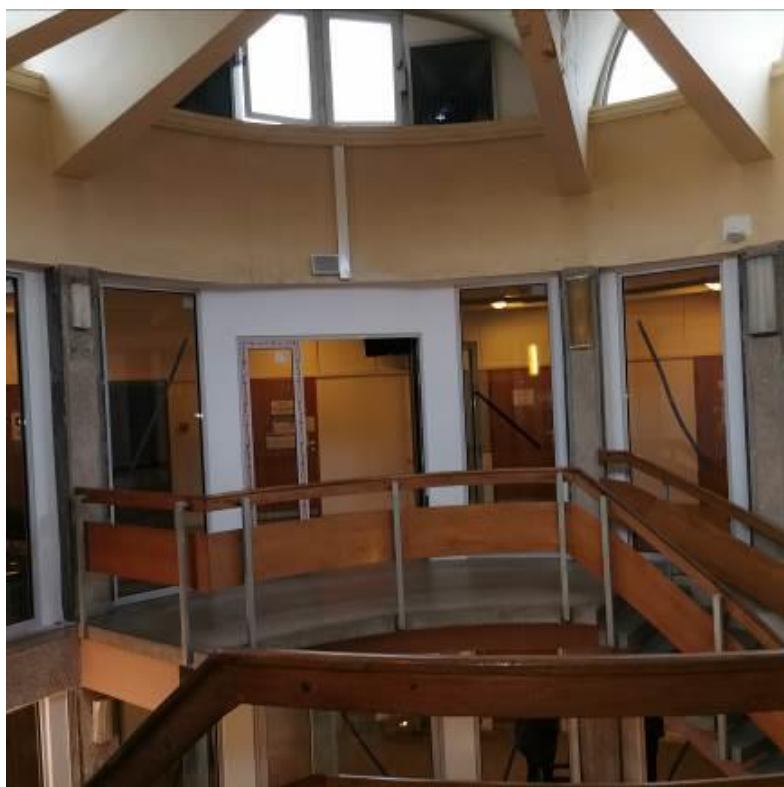
Fot. nr I.54. Brak usunięcia łatwopalnych elementów balustrad schodów wewnętrznych. BUD.A.
