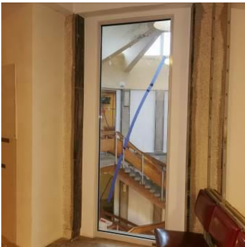
Fot. nr I.43.Brak wykonania robót budowlanych wykończeniowych. BUD.C.
