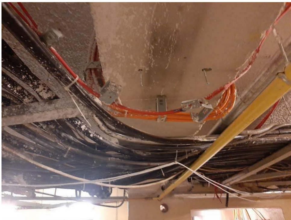
Fot. III.83. Stan techniczny instalacji systemów przeciwpożarowych piwnicy budynku „C” Nieprawidłowe prowadzenie kabli sygnalizacyjnych (czerwone) – nieprzykręcone uchwyty.
