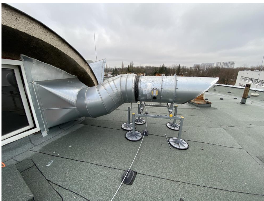
Fot. II.8. Dach Rotundy budynek A - Niepodłączone wentylatory oddymiające. Na rotundzie wentylacja pożarowa Również niepodłączona do zasilania. Brak weryfikacji poprawności działania.
