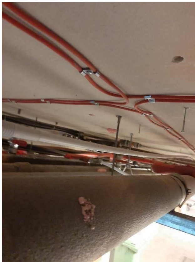
Fot. III.139. Stan techniczny instalacji systemów przeciwpożarowych piwnicy budynku „C” Poprawne ułożenie instalacji.
