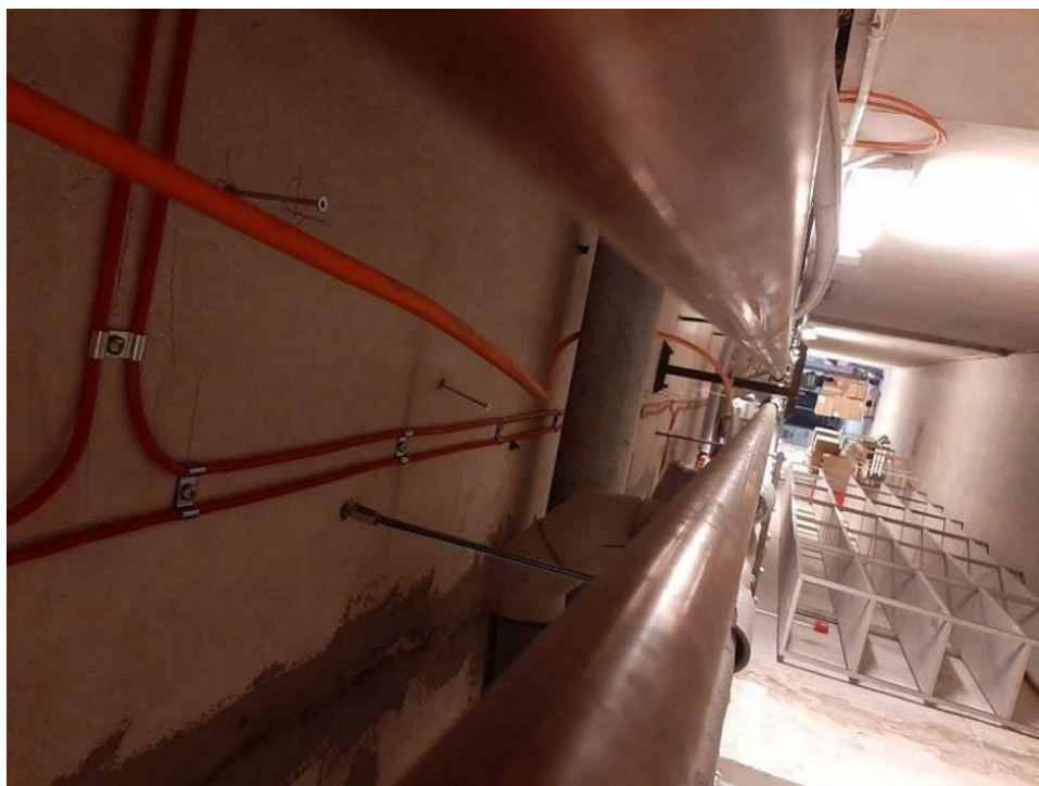
Fot. III.165. Stan techniczny instalacji systemów przeciwpożarowych piwnicy budynku „C” Nieprawidłowe prowadzenie kabli – brak uchwytów.
