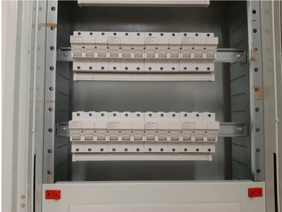
Fot. III.396. Pomieszczenie techniczne. Szafa rozdzielnic elektrycznej. Brak okablowania szafy.
