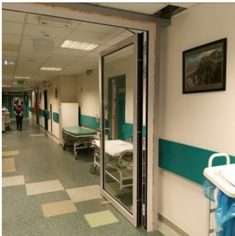
Fot. nr I.23. Wbudowane drzwi pożarowe. Brak realizowania robót wykończeniowych. BUD.C.
