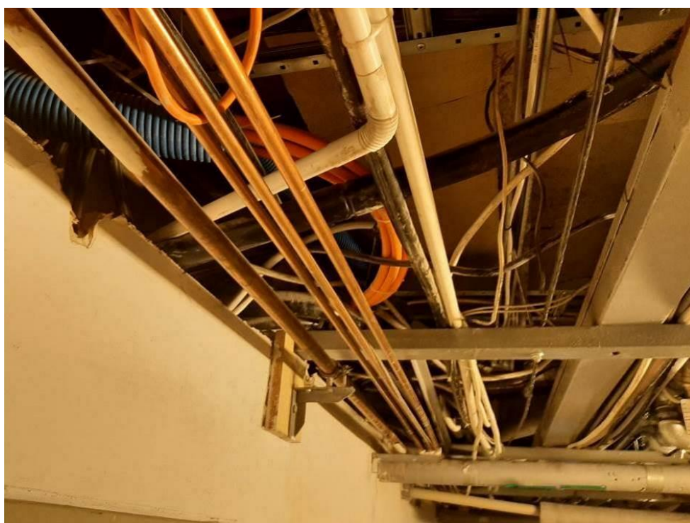
Fot. III.12. Stan techniczny instalacji systemów przeciwpożarowych piwnicy budynku „B” Nieprawidłowe prowadzenie kabli zasilających (pomarańczowe) – brak uchwytyów.
