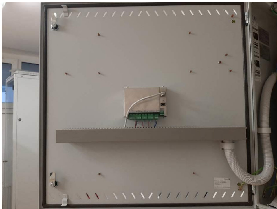
Fot. III.385. Pomieszczenie techniczne. Szafa systemu centralnej baterii.
