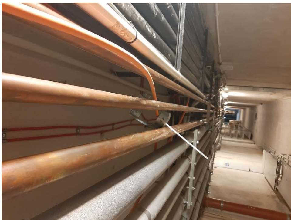
Fot. III.154. Stan techniczny instalacji systemów przeciwpożarowych piwnicy budynku „C” Nieprawidłowe prowadzenie kabli – brak uchwytów.
