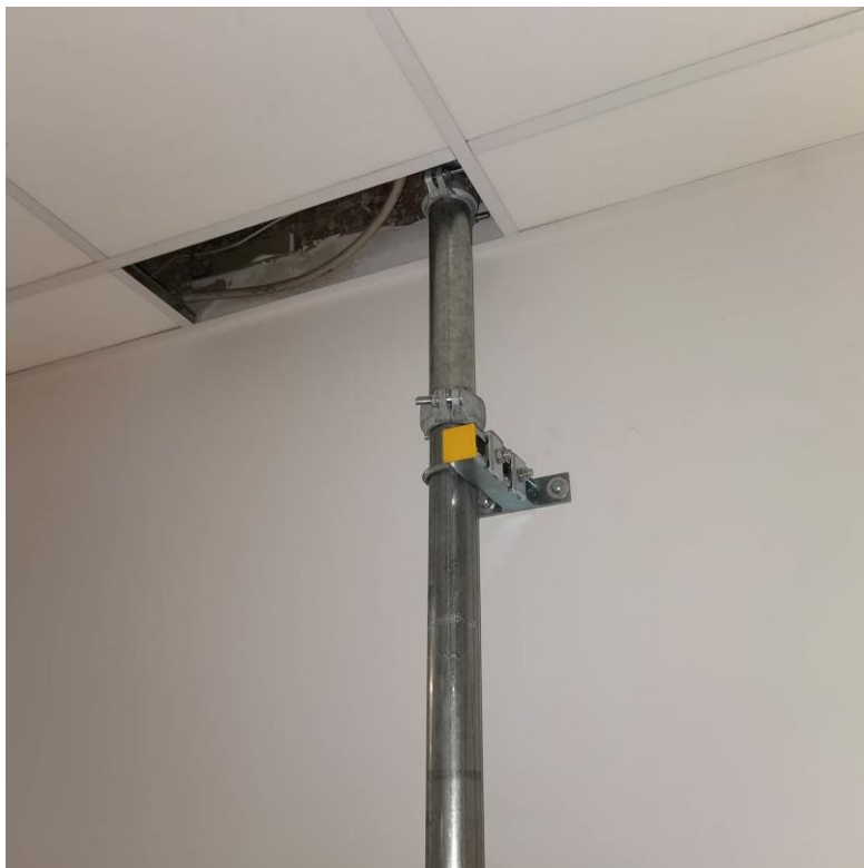
Fot. nr I.75. Brak zabudowy instalacji hydrantowej powoduje trudności w utrzymaniu warunków higienicznych. BUD.C.
