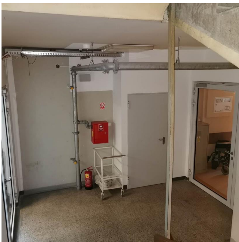
Fot. nr I.64. Brak zabudowy instalacji hydrantowej. BUD. B.
