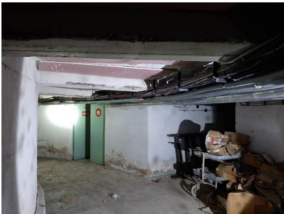
Fot. III.205. Stan techniczny instalacji systemów przeciwpożarowych piwnicy rotundy Brak wyposażenia systemu SSP.
