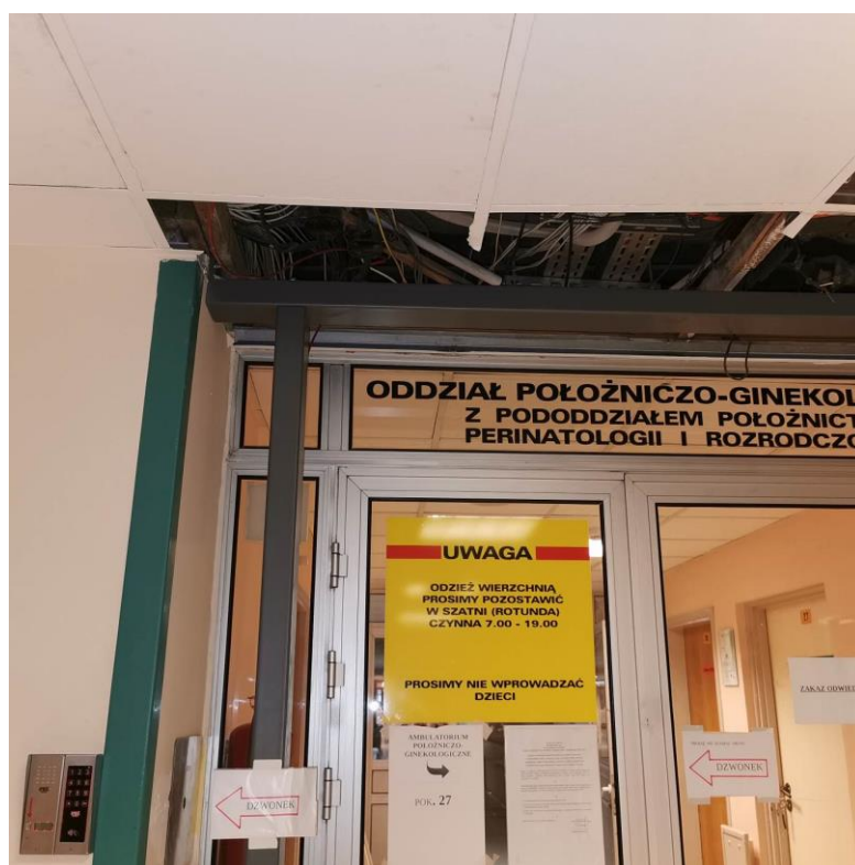
Fot. nr I.88. Ubytki sufitu powodujące swobodną migrację zanieczyszczonego powietrza pomiędzy pomieszczeniami. Brak zamontowanej stolarki drzwiowej – elementu ochrony przeciwpożarowej. BUD.B.
