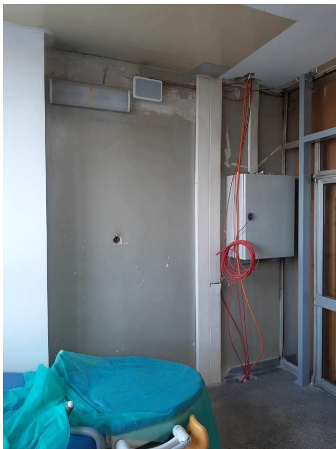
Fot. III.301. System oddymiania. Klatka a. Niedokończona instalacja. Brak odpowiednich przepustów kablowych.
