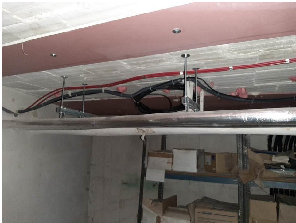
Fot. III.207. Stan techniczny instalacji systemów przeciwpożarowych piwnicy rotundy Brak stosownego przepustu kablowego. Prawidłowe prowadzenie instalacji. Brak wyposażenia systemu SSP.
