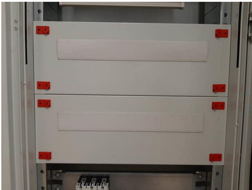
Fot.III.397. Pomieszczenie techniczne. Szafa rozdzielnic elektrycznej. Brak okablowania szafy.
