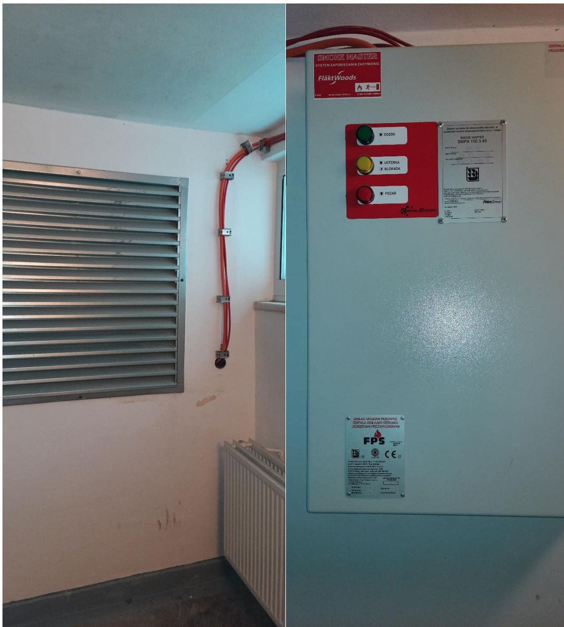
Fot. 26,27. Instalacja zapobiegania przed zadymieniem na klatkach schodowych w budynku wysokim C – w trakcie realizacji.
