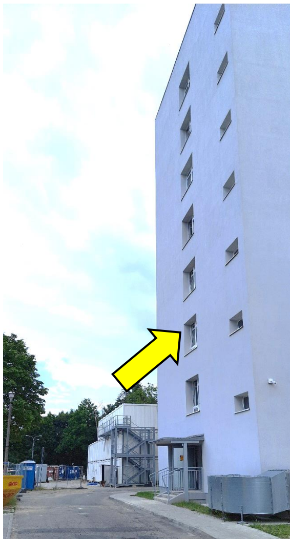
Fot. 29. Zbliżenie ściany budynku C (z klatką D) do drogi pożarowej – zgodnie z ekspertyzą [E1]. W związku z tym nie ma konieczności wykonywania okien w odporności ogniowej dla klatki schodowej.
