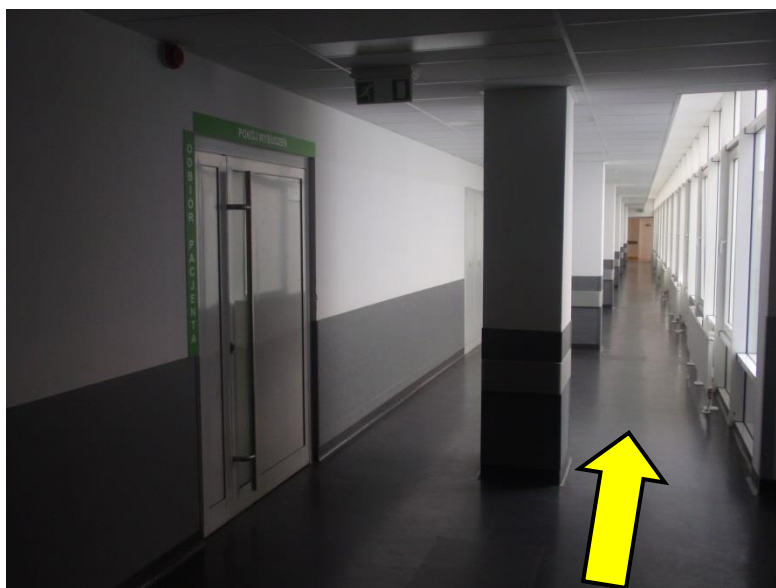
Fot. 16. Zawężenie dróg ewakuacyjnych z uwagi na występujące słupy.
