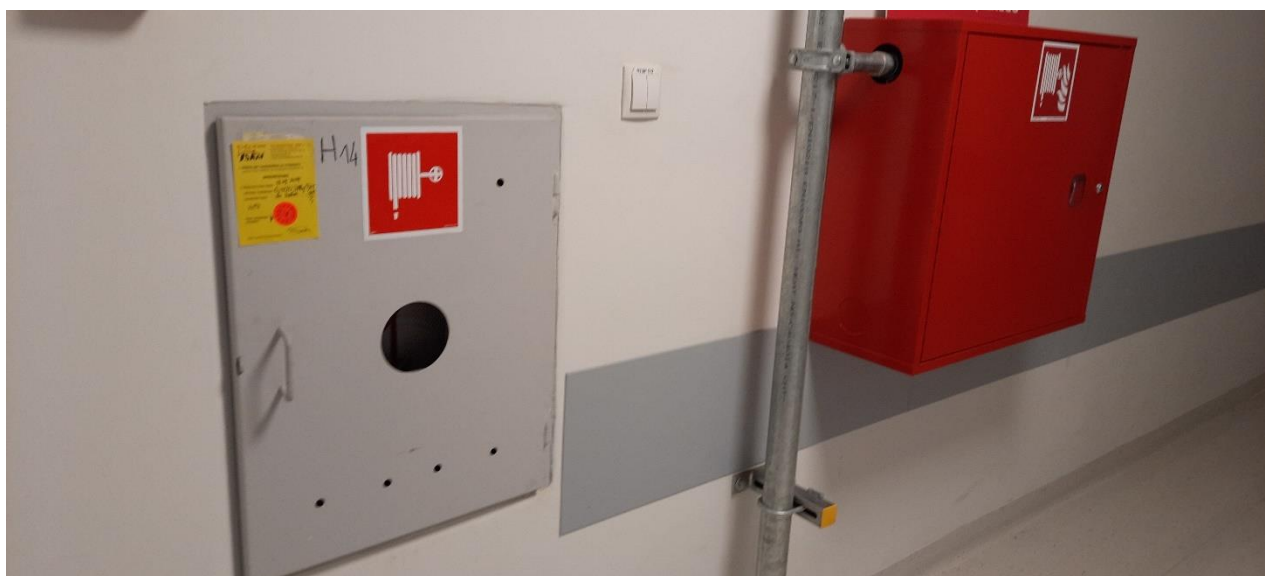
Fot. 24. Hydranty DN 52 istniejące – do usunięcia, po oddaniu do użytku instalacji DN 25 (w trakcie realizacji).
