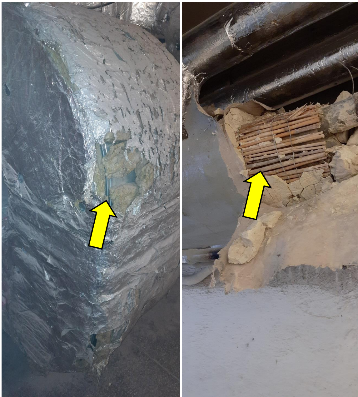
Fot. 20,21 Do uzupełnienia ubytki w izolacji instalacji.
