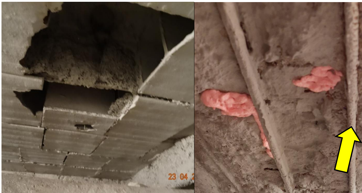
Fot. 9,10. Stropy Ackermana – elementy do naprawy (ubytki w pustakach, odsłonięte zbrojenie).
