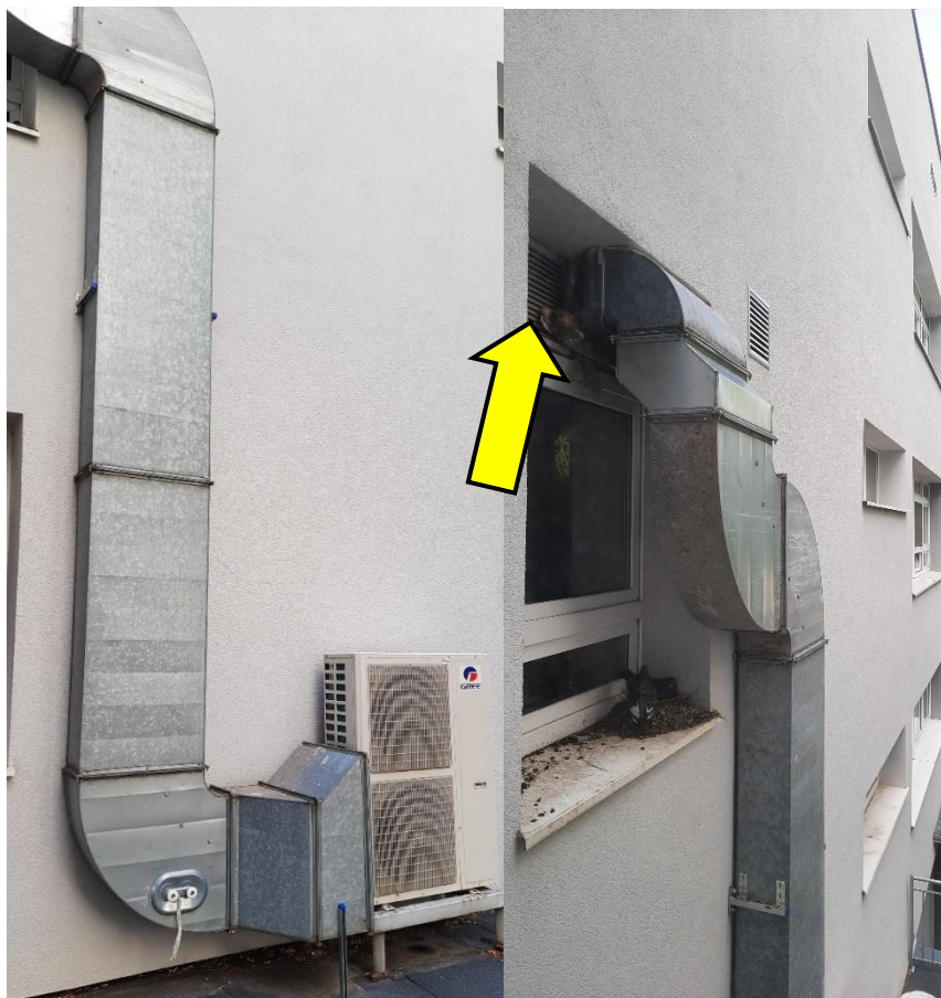
Fot. 18,19. Kanał wentylacyjny poprowadzony do klatki schodowej z centralą klimatyzacji – do obudowania w przestrzeni klatki schodowej. Kanał wprowadzony w przestrzeń sufitu podwieszanego.
