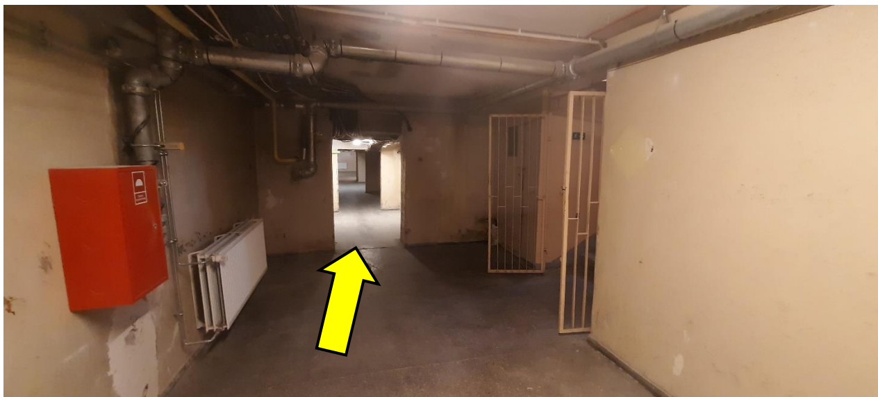
Fot. 13. Granica stref pożarowych w piwnicy – pomiędzy łącznikiem IV a budynkiem wysokim. Możliwość wykonania drzwi w otworze drzwiowym o wysokości 1,7 m – brak prowadzenia ewakuacji przez te drzwi.
