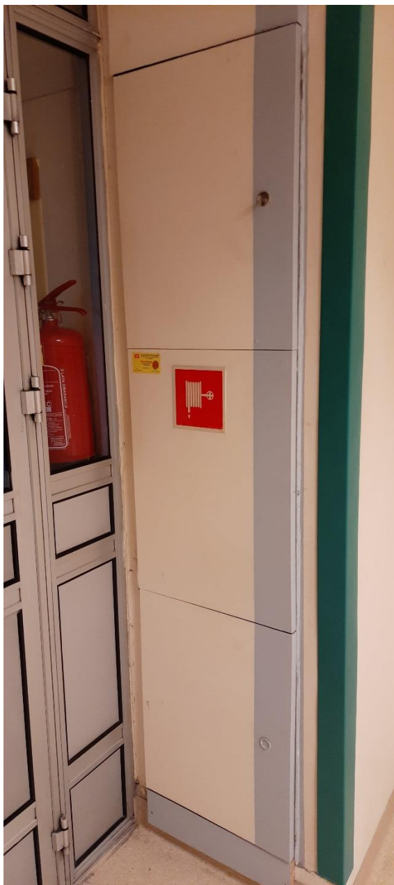
Fot. 23. Zabudowy pionów technicznych z hydrantami DN 52 będą do usunięcia w momencie oddania do użytku instalacji z hydrantami DN 25.
