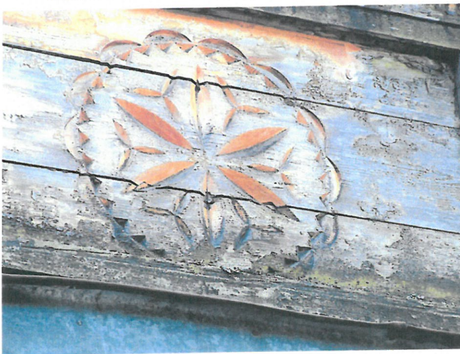
50. Zakopane, ul.Nowotarska 59, willa "Stara Polana", elewacja zachodnia, tzw.wygląd z balkonem, fragment balustrady. Widoczna korozja biologiczna drewna i resztki lakierów bezbarwnych.
