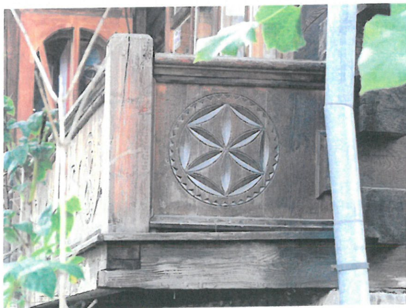
18. Zakopane, ul.Nowotarska 59, willa "Stara Polana", elewacja wschodnia, chodnik północny. Widoczne rozluźnienie konstrukcji objawiające się rozsunięciem elementów składowych.
