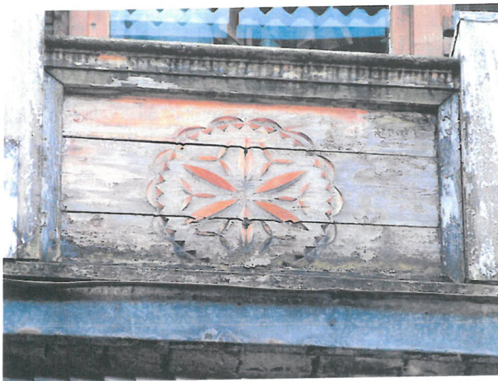
49. Zakopane, ul.Nowotarska 59, willa "Stara Polana", elewacja zachodnia, tzw.wygląd z balkonem. Widoczne rozległe zniszczenia elementów drewnianych balustrady balkonu.
