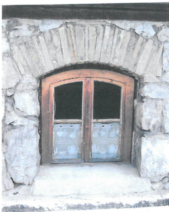
65. Zakopane, ul. Nowotarska 59, willa "Stara Polana", elewacja południowa. Zabrudzenie wątków kamiennych, lokalne wykruszenie spoin.
