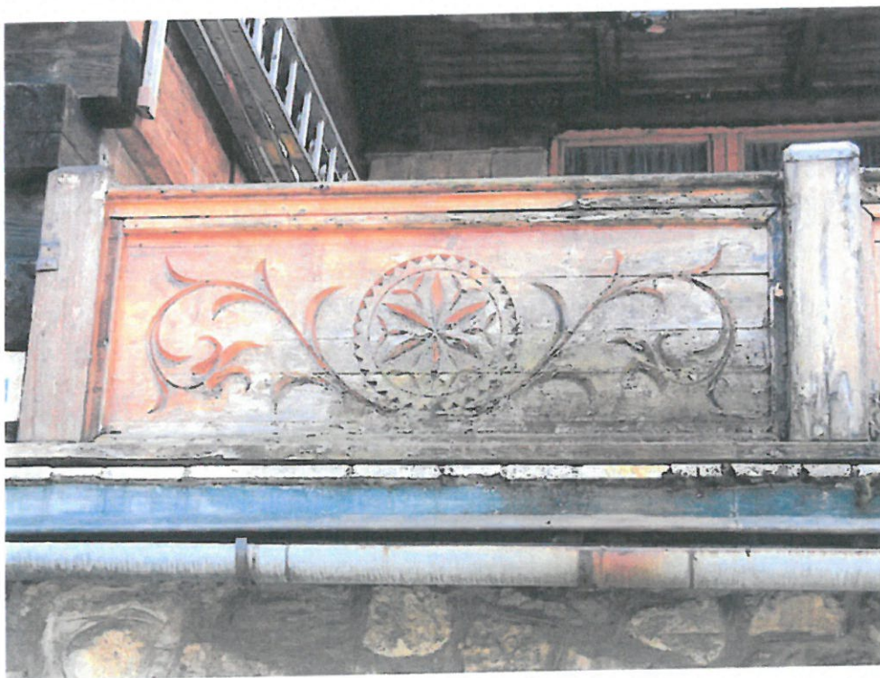
26. Zakopane, ul.Nowotarska 59, willa "Stara Polana", elewacja północna. Widoczny zły stan zachowania balustrady tarasu. Drewno zaatakowane przez mikroorganizmy, obróbki blacharskie zdegradowane..
