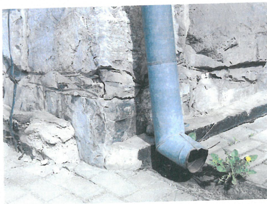
70. Zakopane, ul. Nowotarska 59, willa "Stara Polana", narożnik elewacji południowej i wschodniej. Wykruszenia spoinowania i zapraw w rejonie rury spustowej.
