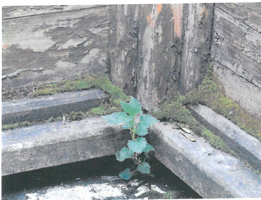
42. Zakopane, ul.Nowotarska 59, willa "Stara Polana", balustrada tarasu przy elewacji północnej, widok od strony wewnętrznej. Widoczne skupiska mchów porastające zawilgocone, pociemniałe i pokryte resztkami lakieru drewno.
