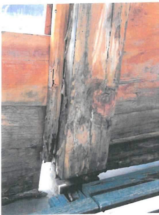
62. Zakopane, ul.Nowotarska 59, willa "Stara Polana" elewacja południowa, strona północna balustrady balkonu. Bardzo zły stan zachowania drewna słupka i ramy balustrady.
