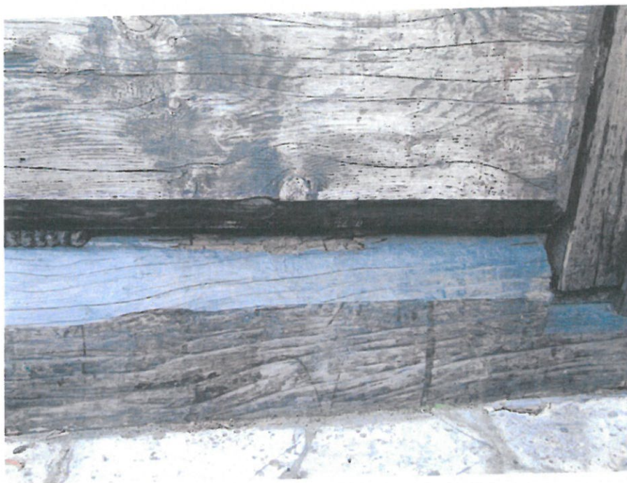
37. Zakopane, ul.Nowotarska 59, willa "Stara Polana", elewacja zachodnia. Widoczne braki w mszeniu.
