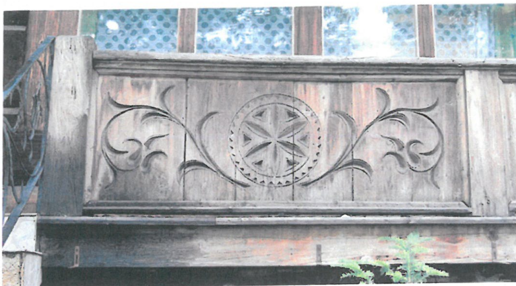
13. Zakopane, ul.Nowotarska 59, willa "Stara Polana", elewacja wschodnia, tzw.chodnik północny. Widoczne rozległe strefy zawilgocone, drewno zaplamione, deski balustrady spękanne.
