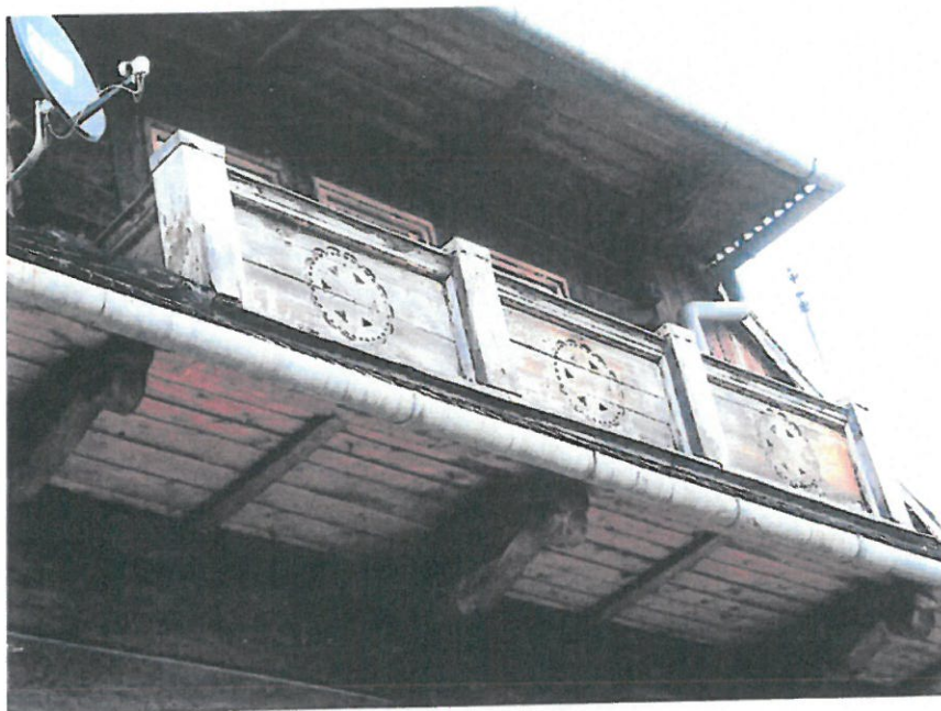
57. Zakopane, ul.Nowotarska 59, willa "Stara Polana", elewacja południowa. Widoczny zły stan zachowania balustrady balkonu.
