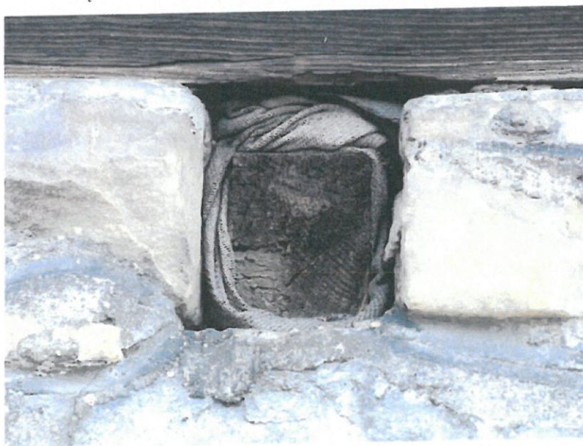
66. Zakopane, ul. Nowotarska 59, willa "Stara Polana", elewacja południowa. Wadliwe technologicznie wypełnienia łączń kamienia z drewnem.
