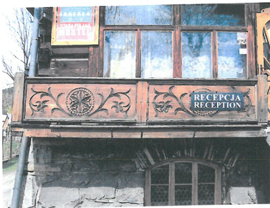
6. Zakopane, ul. Nowotarska 59, willa "Stara Polana", elewacja wschodnia, tzw. chodnik południowy. Ubytki obróbek blacharskich.
