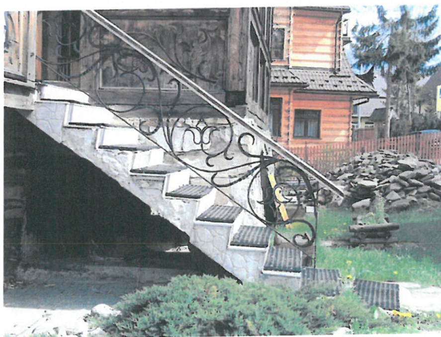
14. Zakopane, ul.Nowotarska 59, willa "Stara Polana" elewacja wschodnia, wtórne schody południowe. Zniszczona ceramiczna okładzina schodów.
