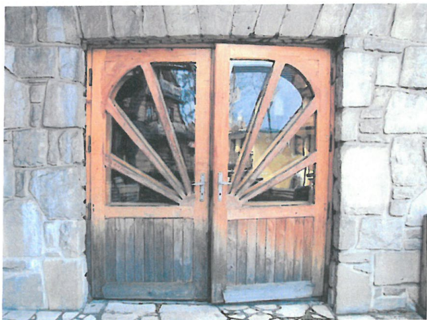
46. Zakopane, ul.Nowotarska 59, willa "Stara Polana", część dobudowana, elewacja zachodnia, drzwi wejściowe na taras. Widoczna degradacja drewna w dolnych częściach skrzydeł.
