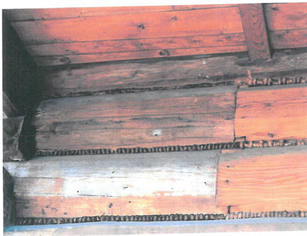
38. Zakopane, ul.Nowotarska 59, willa "Stara Polana", elewacja zachodnia. Widoczne uzupełnienia belek.
