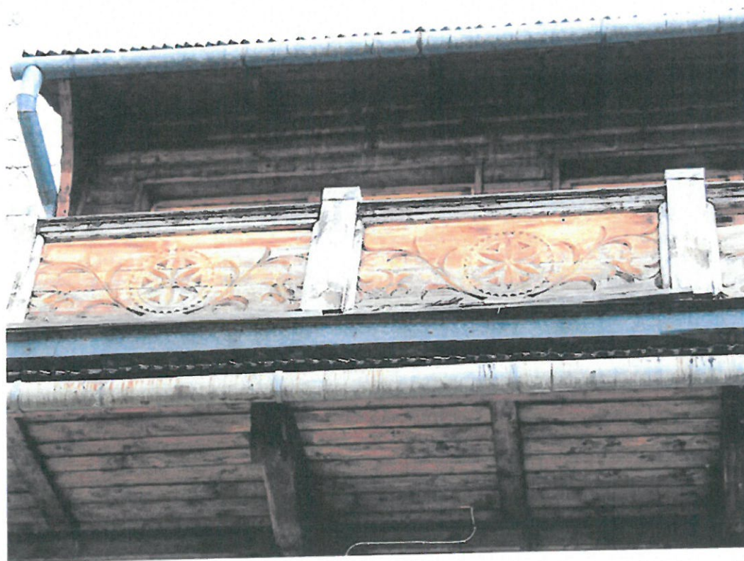
58. Zakopane, ul.Nowotarska 59, willa "Stara Polana", elewacja południowa. Widoczny zły stan zachowania balustrady balkonu.
