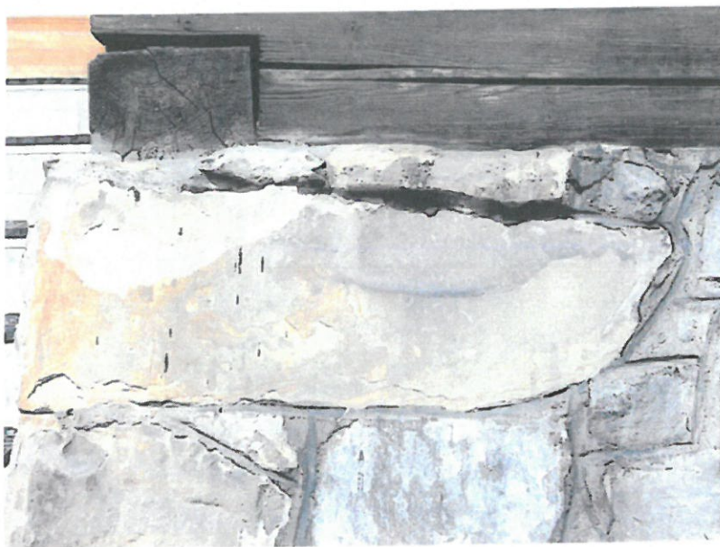
17. Zakopane, ul.Nowotarska 59, willa "Stara Polana" elewacja wschodnia. Rozwarstwiony i złuszczony cios w cokole.
