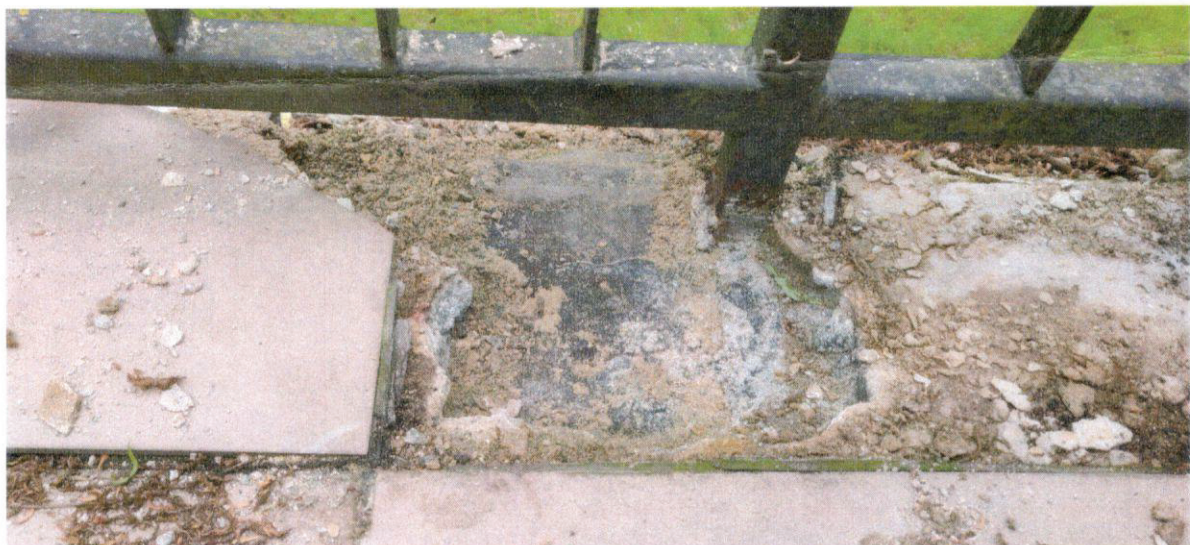
Fot. 3. Odspojenia płytek i uszkodzenia obróbek blacharskich oraz znaczne zawilgocenia posadzek; oznaki korozji balustrady stalowej
