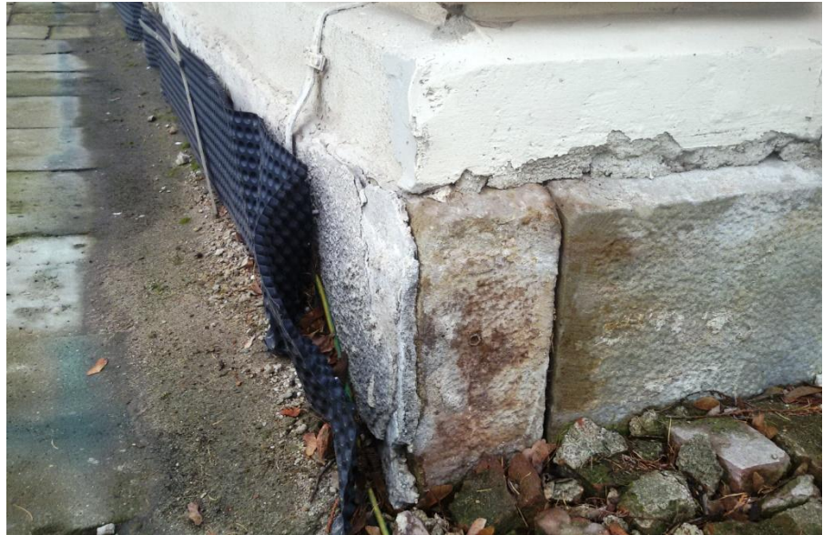
Fot.4. Naroże z okładziną z piaskowca – strona południowo – wschodnia. Bloki kamienia groszkowane z charakterystycznym „szlakiem krakowskim”.
