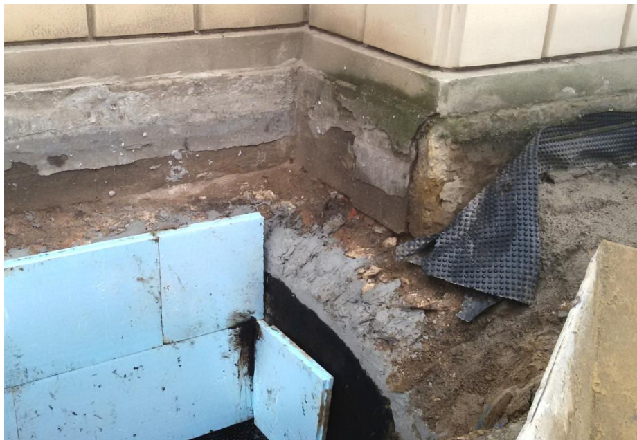
Fot.3. Fragment wykopu przy elewacji południowej budynku z widoczną okładziną cokołową z piaskowca.
