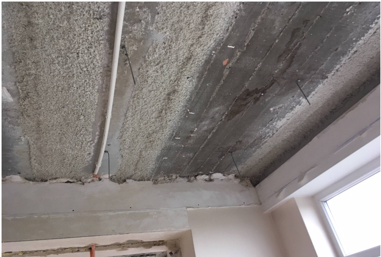
Widok stropu żelbetowego - „nadlewki” przy ścianie podłużnej
