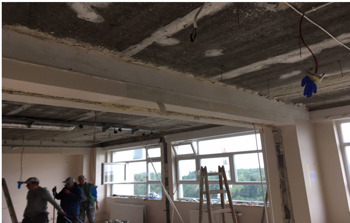
Widok ramy poprzecznej nośnej – rozstaw ram co 7,2m
