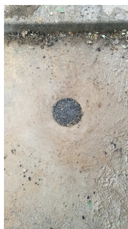
Fot. 2. Otwór nr 1 wypełniony masą bitumiczną po zakończeniu badań
