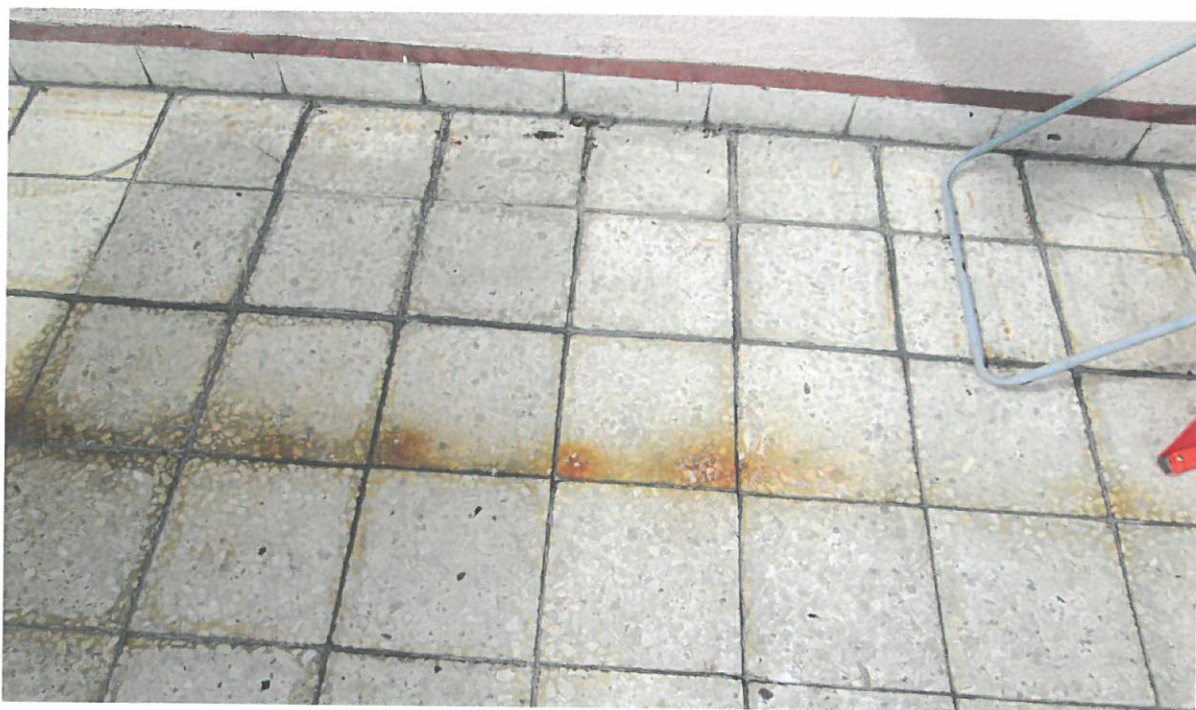
Fot.8 Widoczne ślady zacieków na tarasie w strefie pod rynnowej (stare zacieki).
