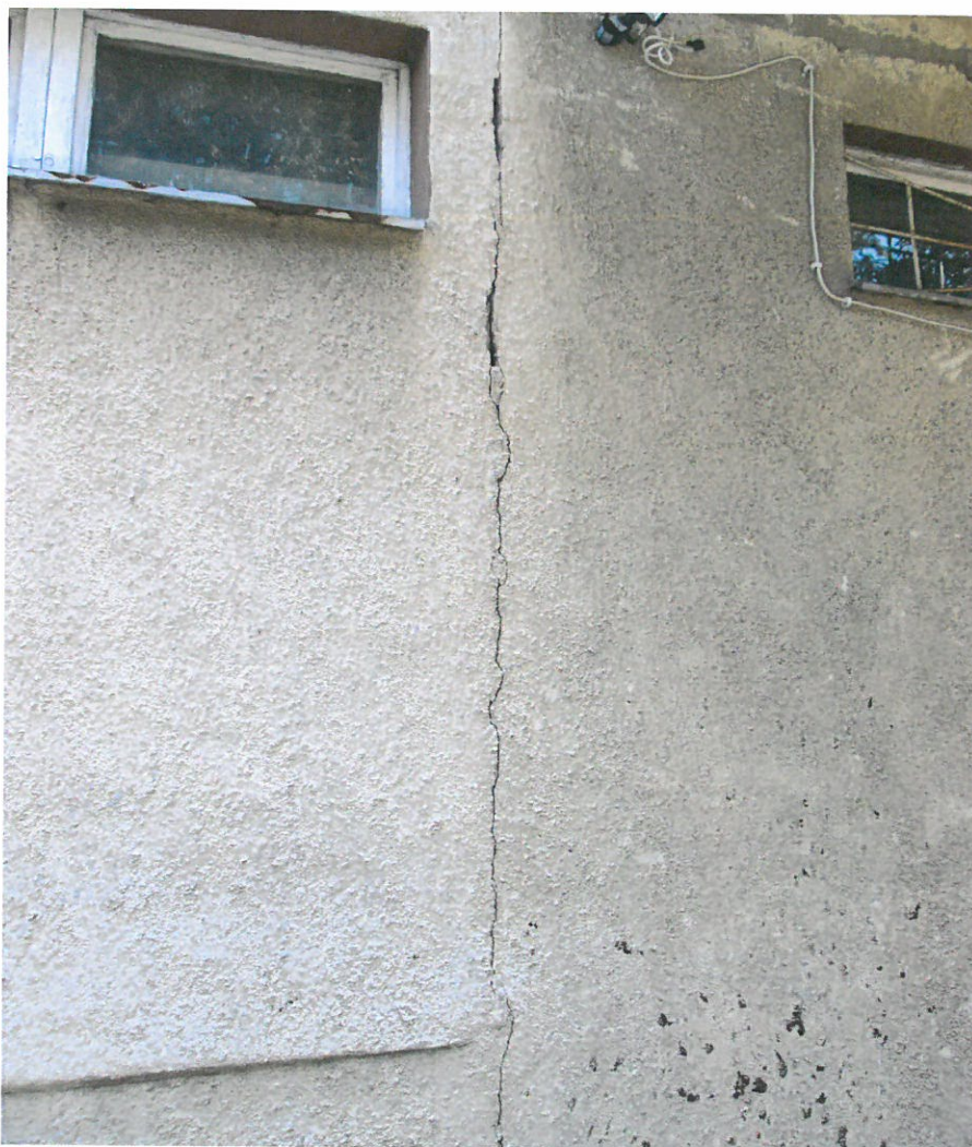
Fot. 2. Fragment elewacji od strony potoku –widoczna rysa pionowa
