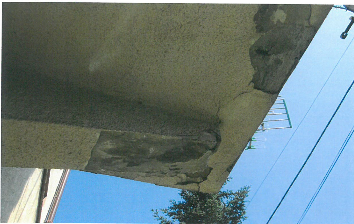
Fot.3 Fragment balkonu od strony elewacji frontowej – widoczne odpryski tynków
