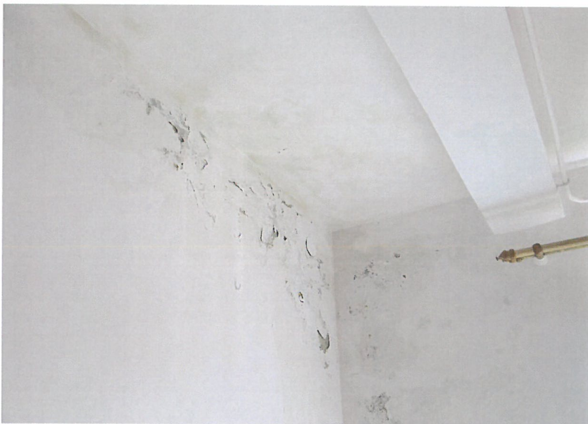
Fot.6 Narożnik wewnętrzny z zaciekami i odpryskami w części sufitu i ścian w narożu
