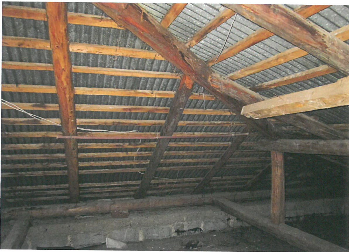
Fot.10 Więżba dachowa –widok fragmentu w części krokwi narożnej
