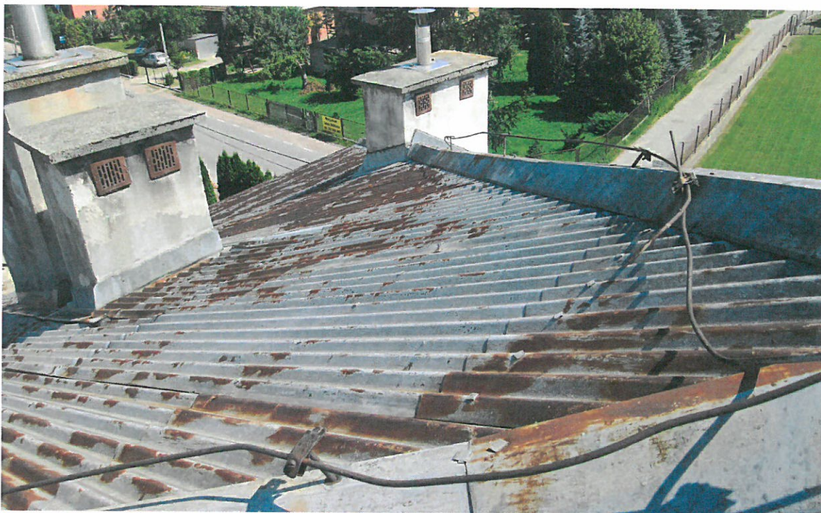
Fot.11/12 Połąc dachu – korozja powierzchniowa pokrycia dachowego
