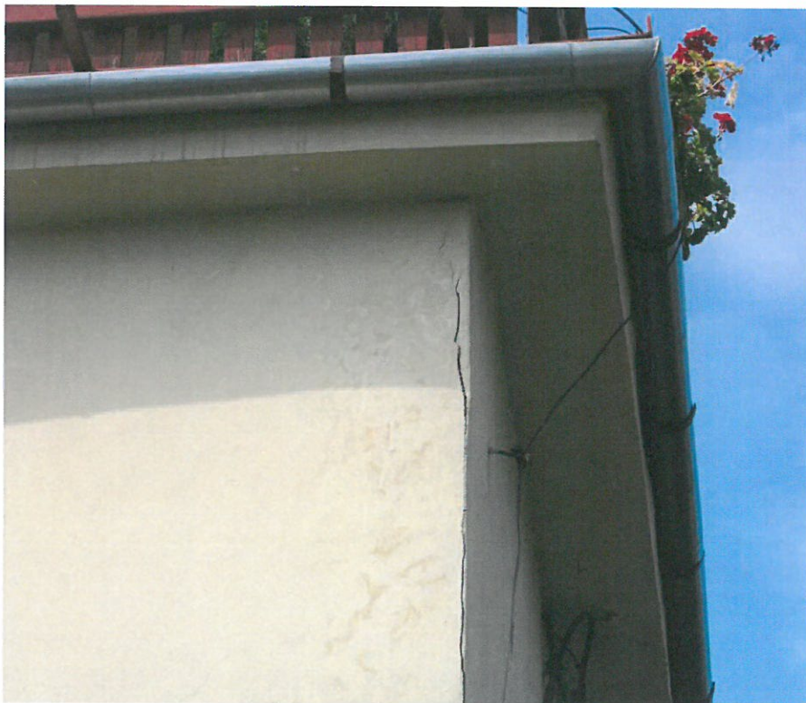
Fot.5 Narożnik południowo-wschodni (gzyms) – widoczne zacieki i odspojenia tynku
