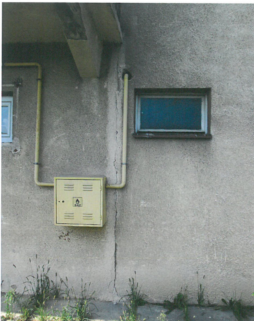
Fot. 3. Fragment elewacji frontowej –widoczna rysa pionowa
