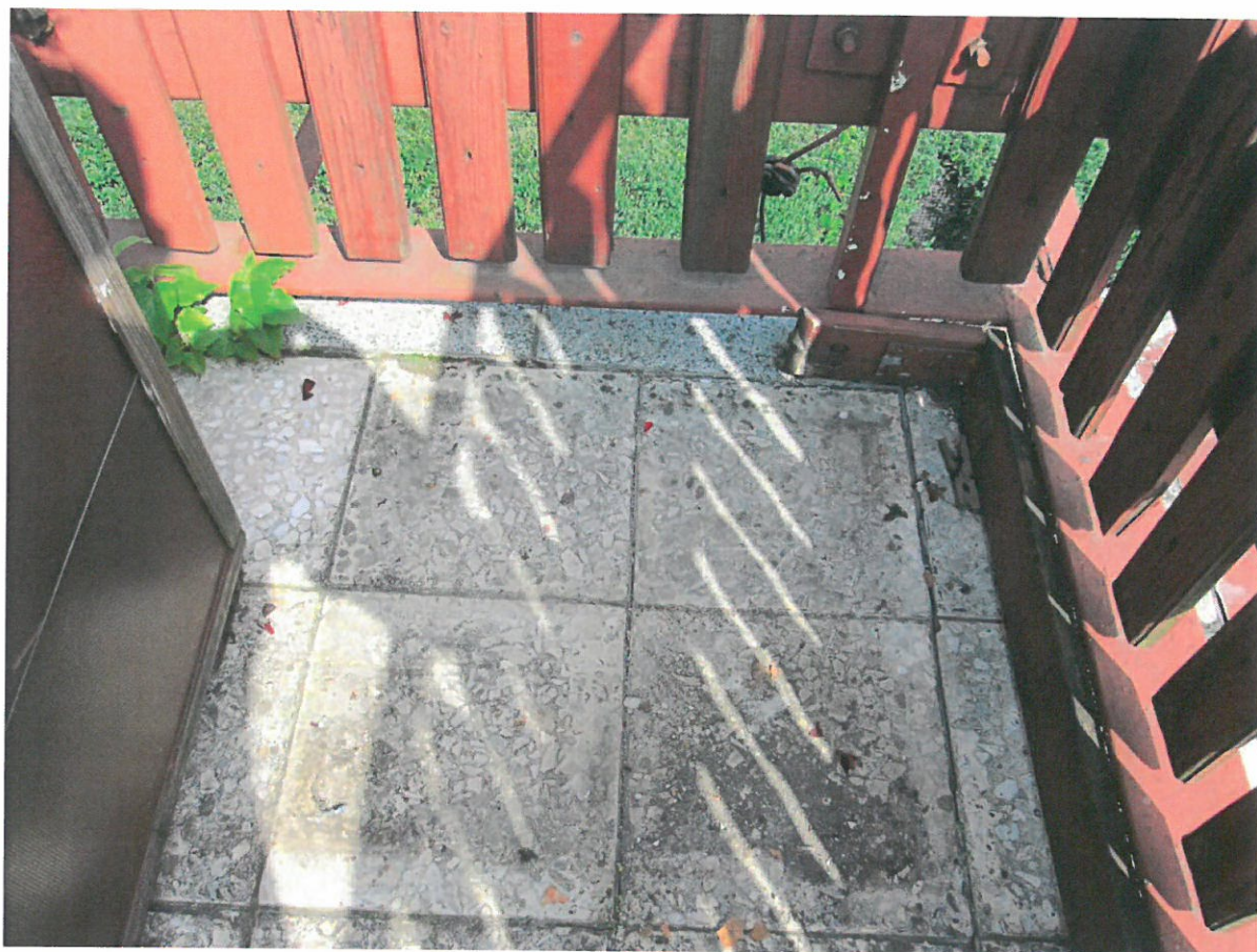
Fot.7 Widok narożnika tarasu z góry – widoczne nieszczelności –rozwarstwienia spoin
