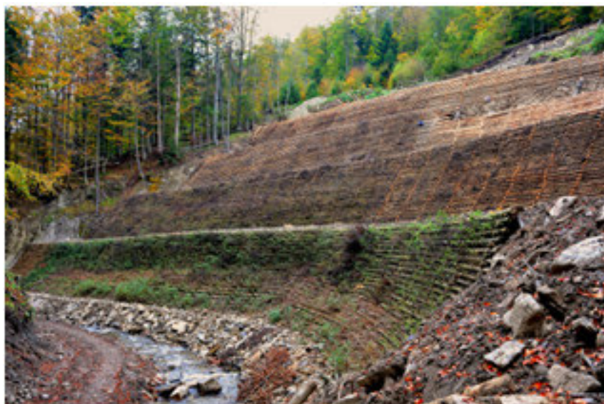
Kaszycyca z pędami wierzby zabezpieczająca osuwisko pod drogą podcinaną przez ciek – pędy rozpoczęły wegetację jeszcze przed zakończeniem budowy. Nadleśnictwo Stuposiany. Źródło: Archiwum CKPS.
