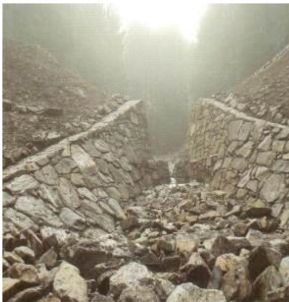
Przeławka szczelinowa na suchym zbiorniku w I-ctwie Jawornica (fot. N-ctwo Międzyłesie)
