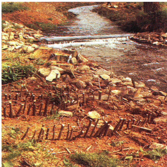
Płotek ze zrzezy wierzbowych tuż po wykonaniu (Begemann i Schiechl 1999)
