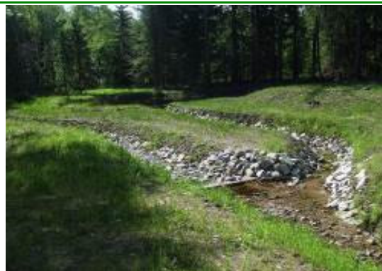
Podział wody na cieku głównym – dolot do zbiorników bocznych w N-ctwie Szklarska Poręba. Zróżło: Archiwum CKPŚ.
