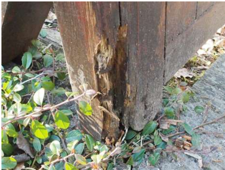
Fot. 14. Widok konstrukcji słupka balustrady : - znaczne ubytki materiału drewnianego. - widoczne zacieki i wykwyty na konstrukcji drewnianej
