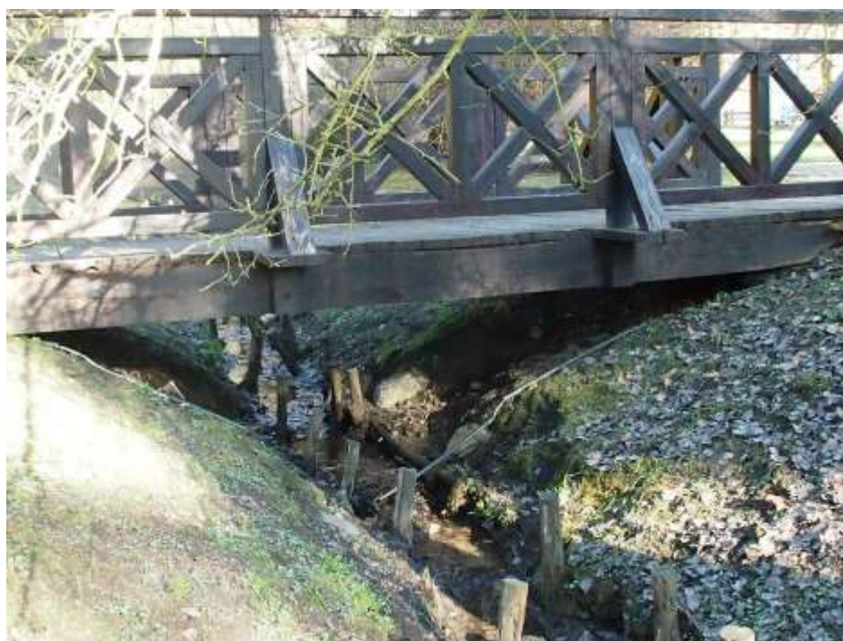
Fot. 4. Widok boczny od strony niskiej wody: - ubytki zasypki na stożkach skarpowych. - konstrukcja balustrady niezgodna z wymogami W.T. ( dla ruchu pieszo – rowerowego h_{\min} = 120 \text{ cm} )
