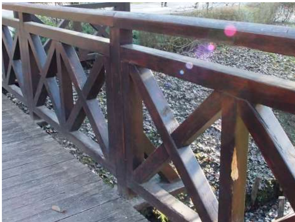
Fot. 6. Balustrada drewniana: - lokalne ubytki materiału, ślady korozji. - konstrukcja balustrady niezgodna z wymogami Warunków Technicznych
