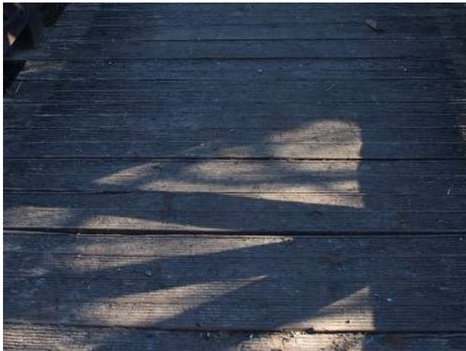
Fot. 5. Nawierzchnia na obiekcie : - nawierzchnie stanowi dyłina drewniana, - widoczne lokalne uszkodzone elementy drewniane .
