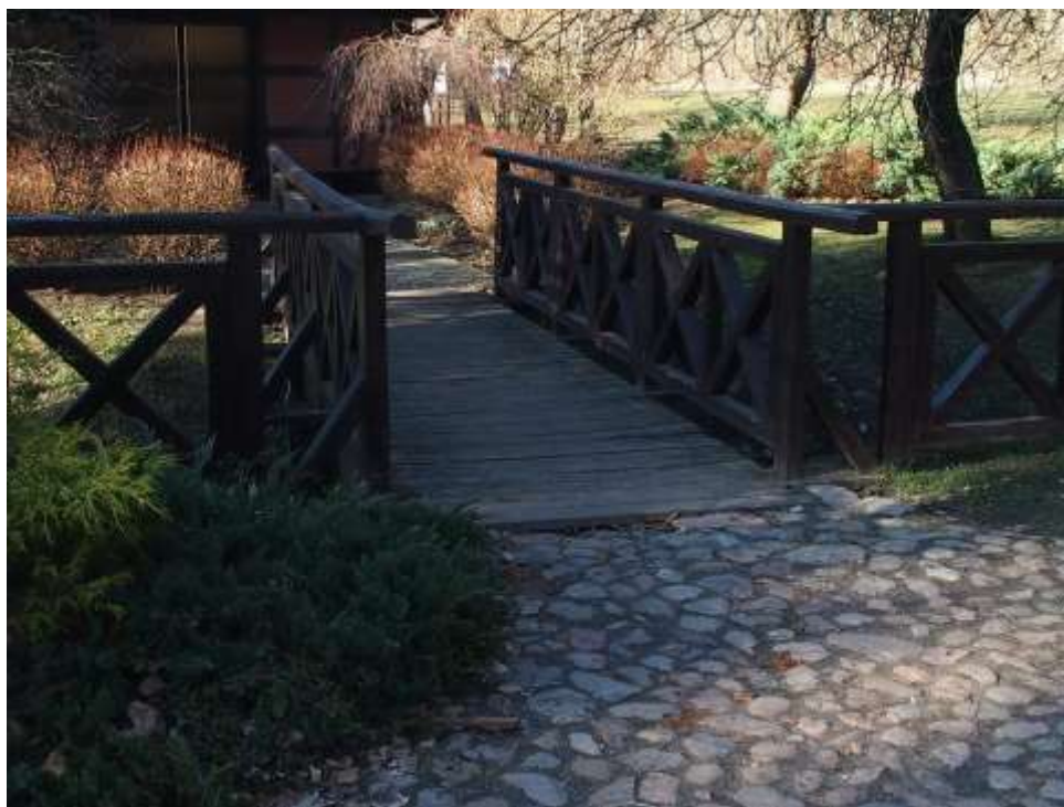
Fot. 2. Widok dojścia do obiektu od strony parkingu : - nawierzchnia z kostki nieregularnej . - widoczne zaniżenie nawierzchni, nierówności nawierzchni na dojściu do obiektu.
