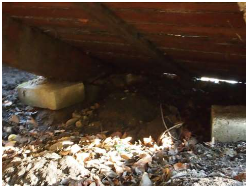
Fot. 8. Stan przyczółków z kostki betonowej:
