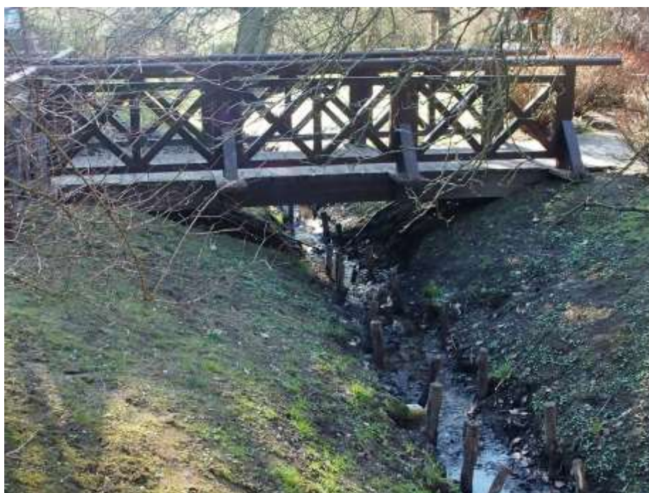
Fot. 3. Widok boczny obiektu od strony wysokiej wody: - ubytki zasypki na stożkach skarpowych. - brak umocnienia koryta cieku płótkiem faszynowym.
