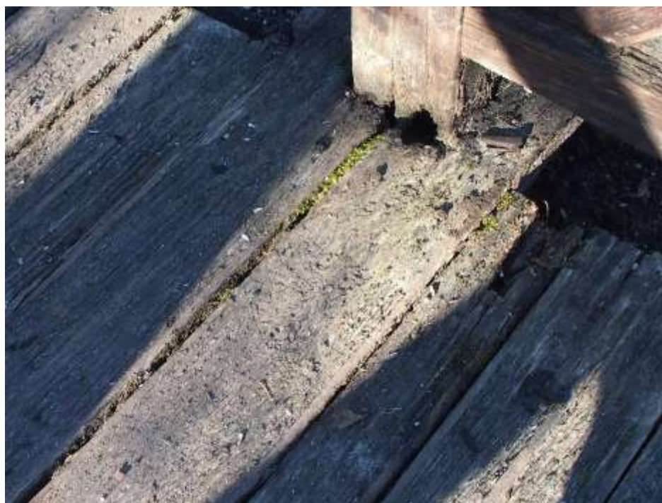
Fot. 15. Widok połączenia słupka balustrady do konstrukcji pomostu : - znaczne ubytki materiału drewnianego na połączeniu elementów.
