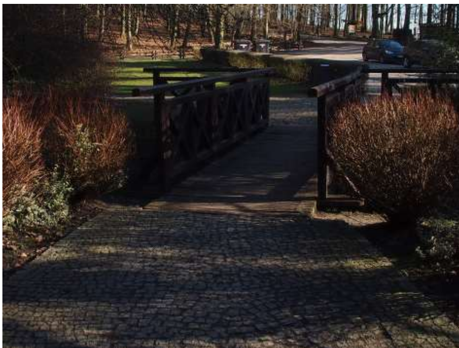
Fot. 1. Widok dojścia do obiektu od strony Punktu Informacyjnego: - nawierzchnia z kostki kamiennej, - miejscowe lokalne deformacje w nawierzchni
