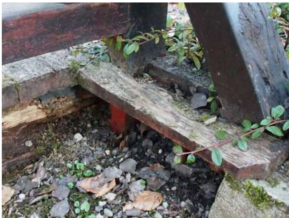
Fot. 10. Konstrukcja drewniana mocująca słupki balustrady:
