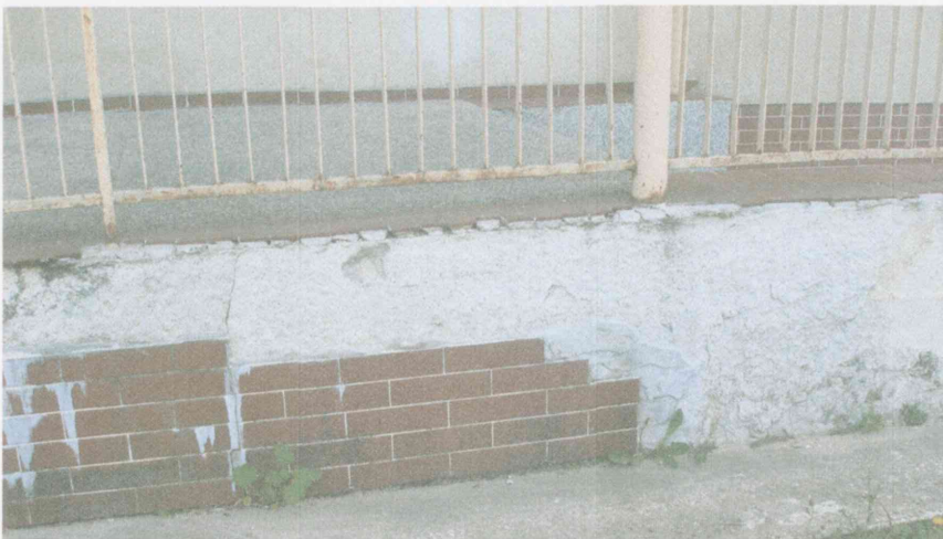
Uszkodzenia cokołu.
