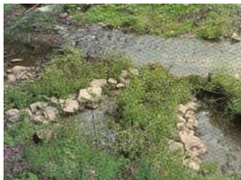
Schemat żywych ostróg pośrednich (Begemann i Schiechl 1999)
