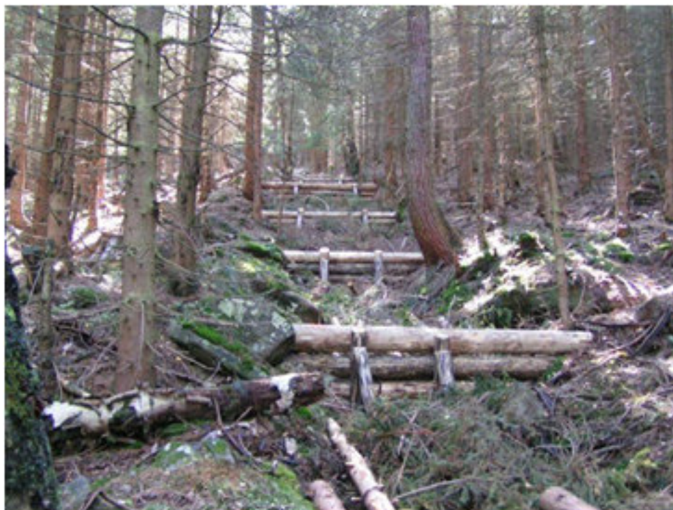
Przegrody drewniane wypełnione gałęziówką na szlakach zrywkowych
