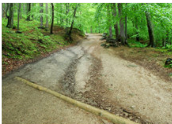
Wodospust z pojedynczego okrągłaka
