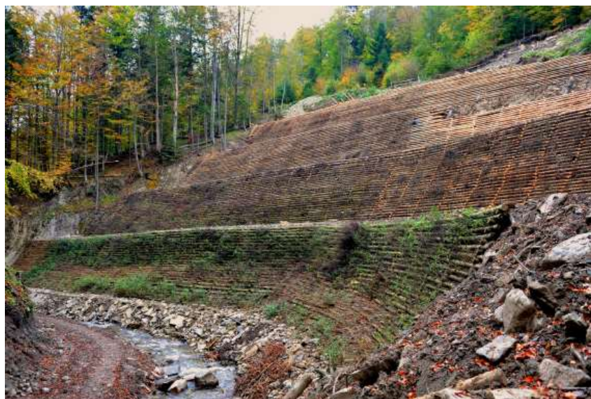
Kaszyca z pędami wierzby zabezpieczająca osuwisko pod drogą podcinaną przez ciek – pędy rozpoczęły wegetację jeszcze przed zakończeniem budowy. Nadleśnictwo Stuposiany. Źródło: Archiwum CKPŚ.
