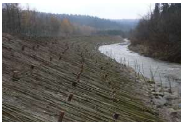
Brzegosłon wierzbowy na potoku Mucznie wykonany w 2014 r. w ramach MRG1 (fot. P.Schetyński, www.twojebieszczady.net )
