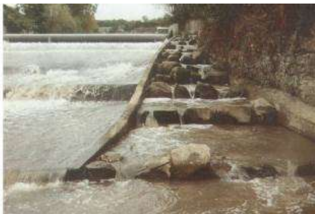
Przeławka kaskadowa przy budowli hydrotechnicznej. (Jelonek 2008)
