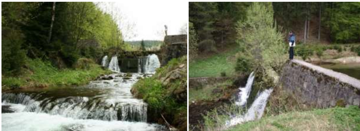
Bardzo stara zaniedbana zaporę kwalifikujące się do rozebrania – Nadleśnictwo Łądek Zdrój. Na decyzje o rozbiórce zapory powinny mieć wpływ nie tylko stan obiektu, ale jego funkcje i dysfunkcje gospodarczo – przyrodnicze w otoczeniu. Źródło: Archiwum CKPŚ.
