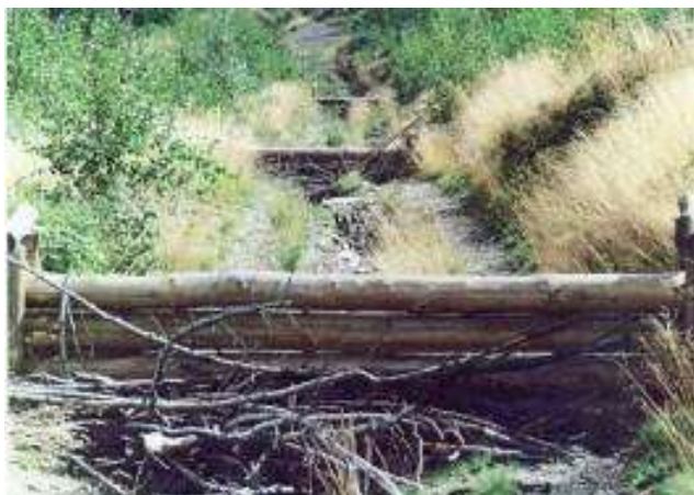
Typowa zabudowa szlaków zrywkowych z wykorzystaniem belek drewnianych
