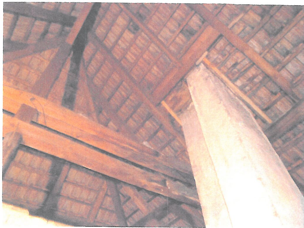
15 – belka rozporowa, kleszcze uszkodzone
