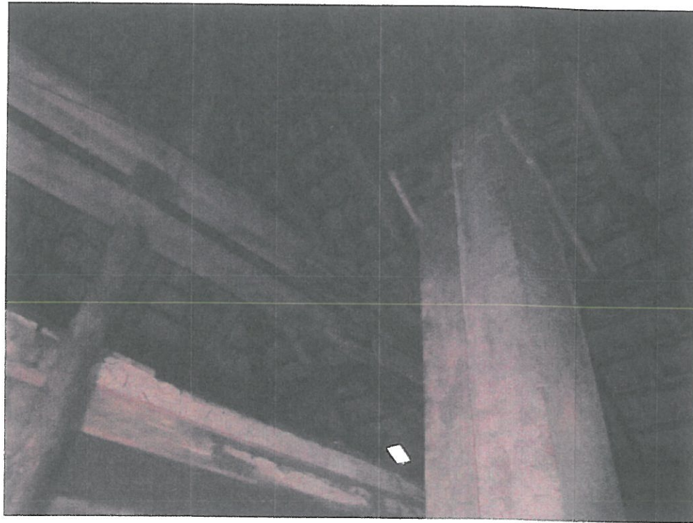
16 – dodatkowe podparcie pod słupem górnym płatwi kalenicowej
