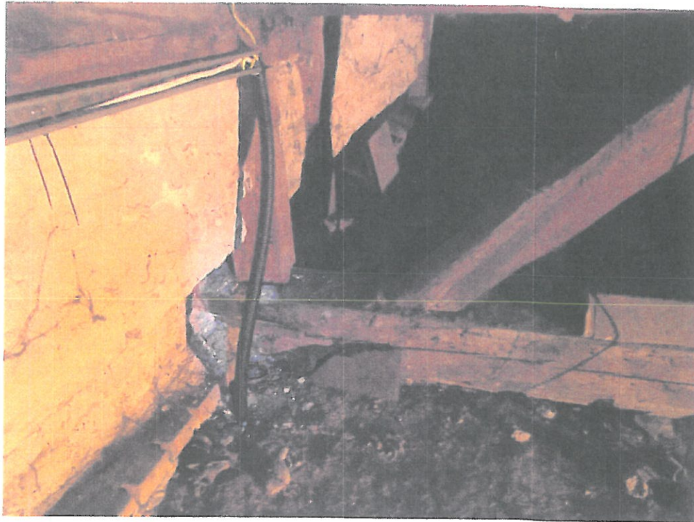
8 – poluzowany węzeł tramu i słupka przy ścianie
