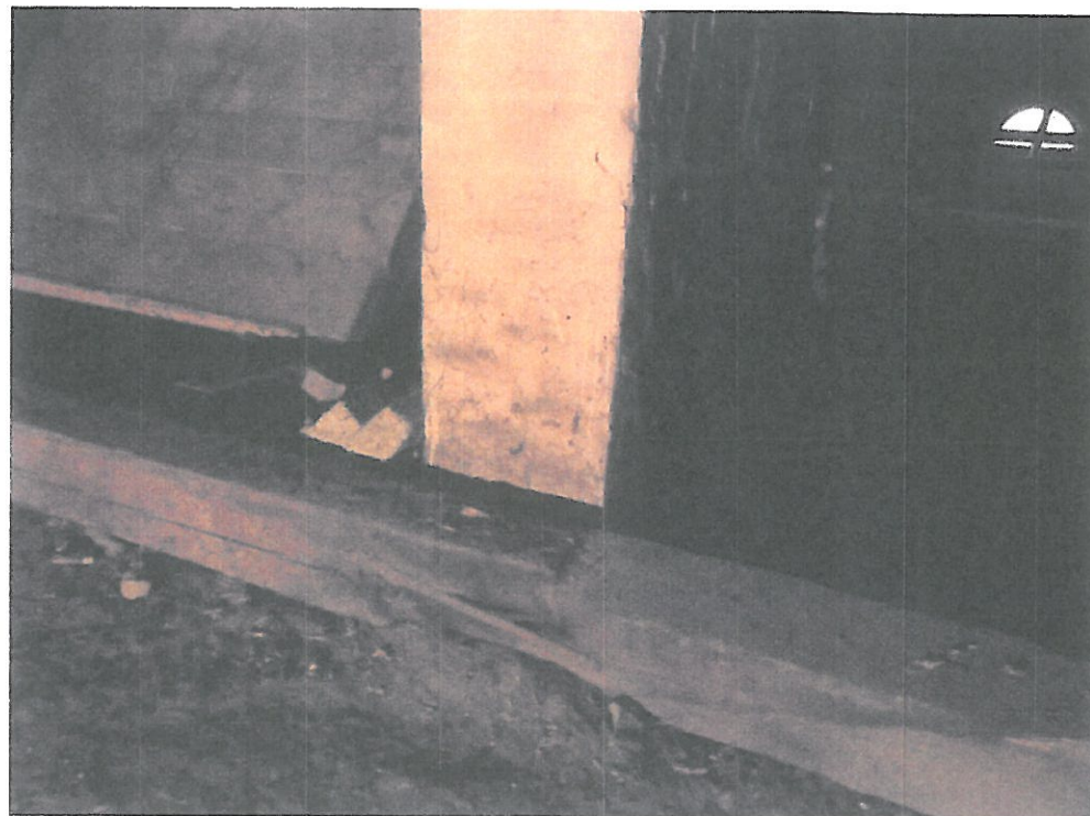
⑦ uszkodzenie i wychylenie z pionu tramu
