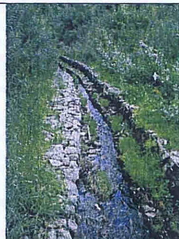
Kosze kamienno-siatkowe zaciśnięte przez jęzor osuwiska w korycie p. Zakrzowiec (wysokość dz. nr 307)
